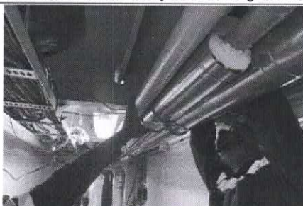
Mantenimiento tubería de succión y descarga del compresor de aire acondicionado
