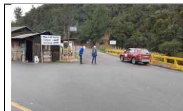
VÍA CÓDIGO 5505 SECTOR CRUCE SARAVENA RECORRIDO TÉCNICO PERSONAL DE INTERVENTORIA REALIZANDO LA ACTIVIDAD DE AUSCULTACIÓN DEL PAVIMENTO EN LA VÍA RUTA 5505 PR62+0550 SITIO DE DESVÍO HACIA SARAVENA
