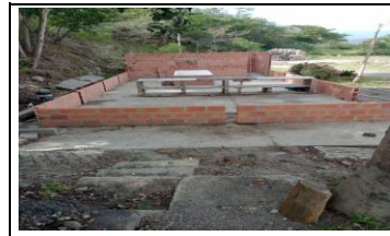
VÍA CÓDIGO 5504 SECTOR VEREDA EL SAUCITO EL CONTRATISTA AVANZA CON LA EJECUCIÓN DEL PROCESO DE CONSTRUCCIÓN DEL LABORATORIO EN LA FINCA VEGA SECA DEL MUNICIPIO DE ENCISO SANTANDER EN LA VÍA RUTA 5504 PR14+0700
