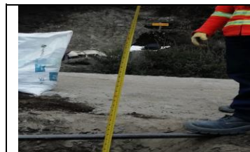
VÍA CÓDIGO 5504 SECTOR PARAMO ALMORZADERO PERSONAL DEL CONTRATISTA ISLA SANTANDER EJECUTA LA ACTIVIDAD DE MEDICIÓN DE PROFUNDIDAD DEL SONDEO EN LA VÍA RUTA 5504 PR87+0600 SECTOR PARAMO DEL ALMORZADERO
