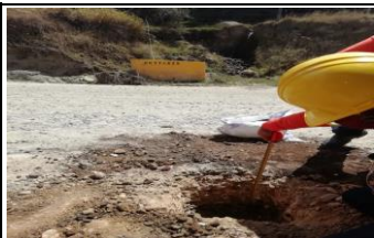
VÍA CÓDIGO 5504 SECTOR PARAMO ALMORZADERO PERSONAL DEL CONTRATISTA ISLA SANTANDER EJECUTA EL PROCESO DE PERFORACIÓN DEL SUELO CON EL FIN DE OBTENER CBR EN LA VÍA RUTA 5504 PR77+0628 SECTOR PARAMO DEL ALMORZADERO
