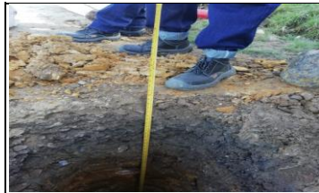
VÍA CÓDIGO 5504 SECTOR PARAMO ALMORZADERO PERSONAL DEL CONTRATISTA ISLA SANTANDER EJECUTA LA ACTIVIDAD DE MEDICIÓN DE PROFUNDIDAD DEL SONDEO EN LA VÍA RUTA 5504 PR77+0628 SECTOR PARAMO DEL ALMORZADERO
