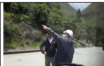
VÍA CÓDIGO 5503 SECTOR DEL MUNICIPIO DE SUSACON RECORRIDO TÉCNICO CONJUNTO PERSONAL TÉCNICO DEL CONTRATISTA E INTERVENTORIA INTERVENTORIA EN EL SITIO CRÍTICO DE LA RUTA 5503 PR81+0400, OBSERVANDO EL TALUD SUPERIOR
