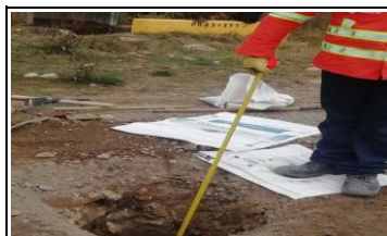
VÍA CÓDIGO 5504 SECTOR PARAMO ALMORZADERO PERSONAL DEL CONTRATISTA ISLA SANTANDER EJECUTA LA ACTIVIDAD DE MEDICIÓN DE PROFUNDIDAD DEL SONDEO EN LA VÍA RUTA 5504 PR83+0577 SECTOR PARAMO DEL ALMORZADERO
