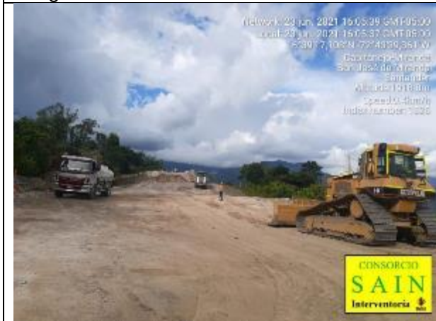
Conformación de Terraplén del 28
