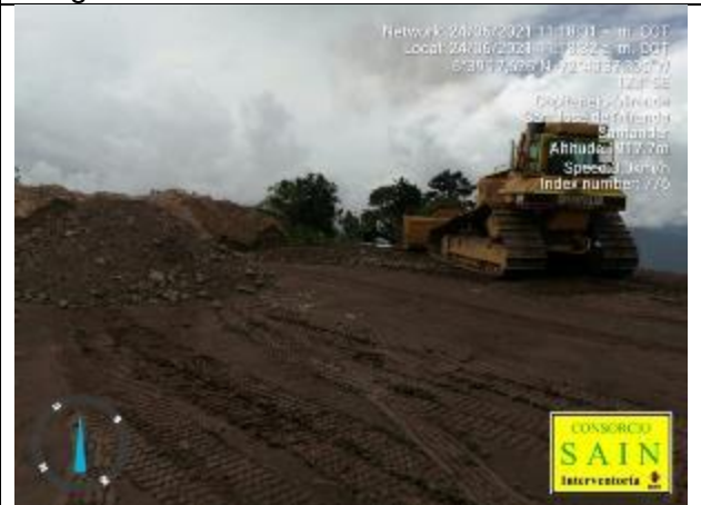
Conformación de material de Terraplén del 28
