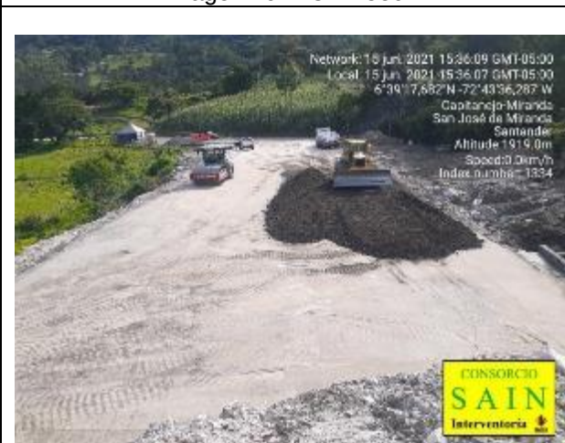
Conformación de material terraplén del 28.
