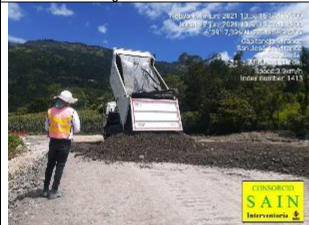
Conformación de material de terraplén del 28.
