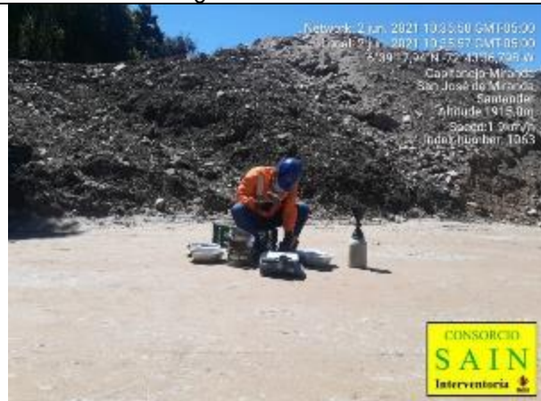
Toma de densidades en el terraplén del 28
