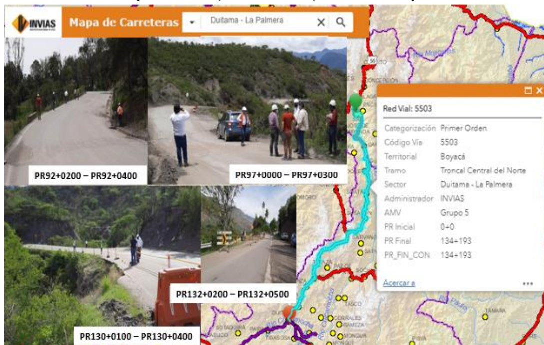
Imagen 6. Estado inicial de la Ruta 5503.
