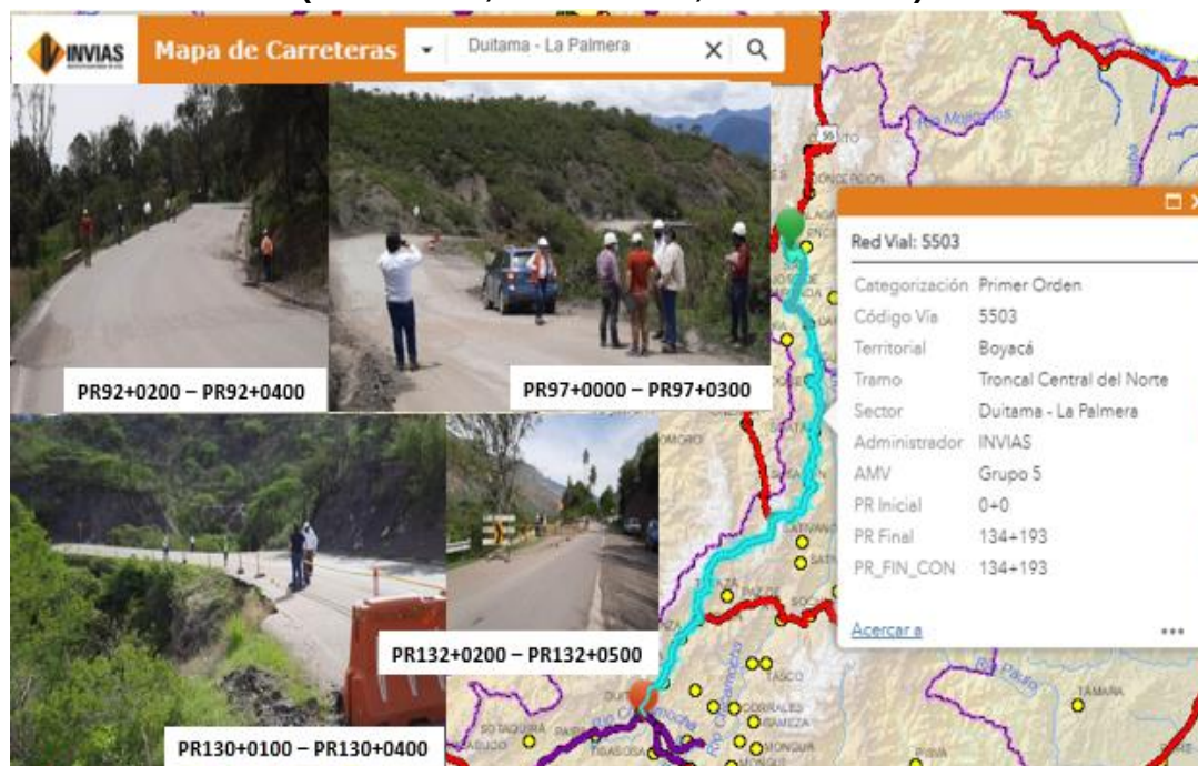
Imagen 6. Estado inicial de la Ruta 5503.
