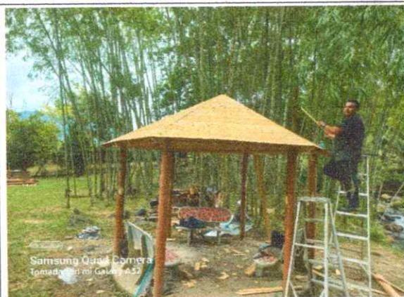
IMAGEN 25. Proceso de restauración de Kiosco, parque lineal San Antonio.
