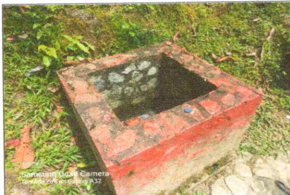
IMAGEN 42. Estado actual puntos ecológicos en concreto ciclópeo, ubicados en parque lineal San Antonio.
