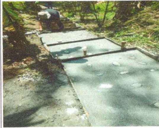
IMAGEN 6. Vaciado en concreto ciclópeo para escalas, en parque lineal Dosquebradas.
