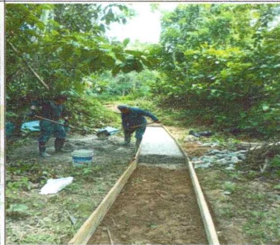
IMAGEN 16. Vaciado concreto ciclópeo, parque lineal Puerto Garza.
