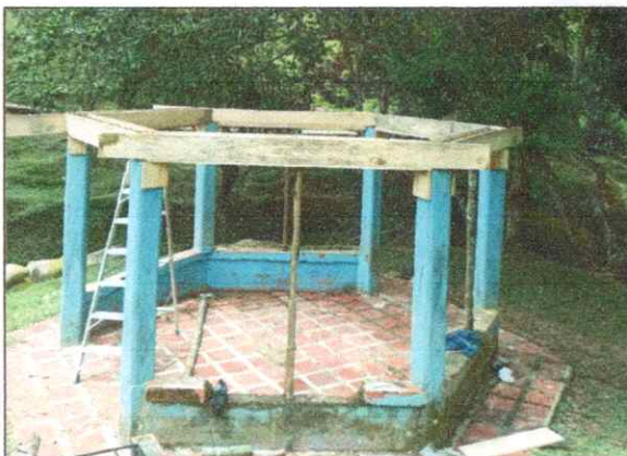
IMAGEN 9. Vaciado de vigas, parque lineal Canoas.
