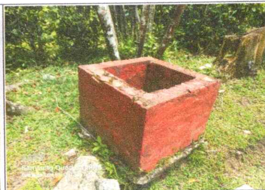
IMAGEN 43. Estado actual puntos ecológicos en concreto ciclópeo, ubicados en parque lineal San Antonio.
