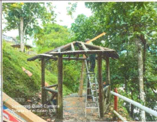
IMAGEN 26. Proceso de restauración de Kiosco, parque lineal San Antonio.
