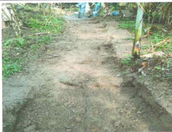
IMAGEN 5. Trazado para construcción de escalas, parque lineal Dosquebradas.
