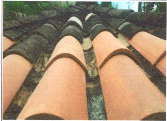
IMAGEN 32. Restauración completa de cubierta en teja de barro, parque lineal San Antonio.
