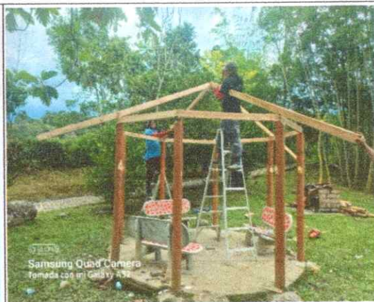
IMAGEN 24. Proceso de restauración de Kiosco, parque lineal San Antonio.
