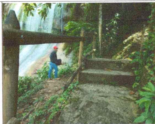
IMAGEN 36. Estado actual de cerca en madera inmunizada, Parque lineal San Antonio.
