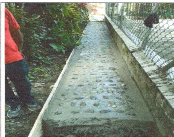
IMAGEN 13. Vaciado de concreto ciclópeo para sendero, parque lineal Puerto Garza.
