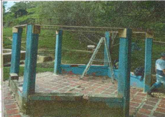
IMAGEN 8. Construcción de formaletas para vigas de amarre, parque lineal canoas.
