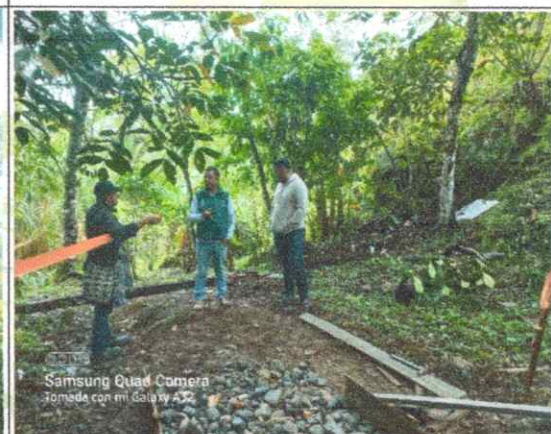
IMAGEN 19. Visita técnica interventoría.
