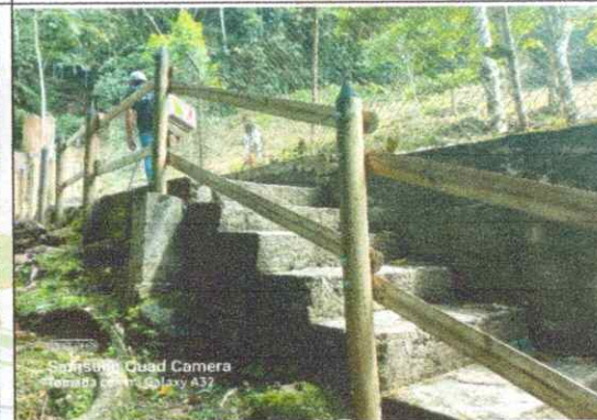
IMAGEN 37. Restauración de cerca en madera inmunizada, Parque lineal San Antonio.
