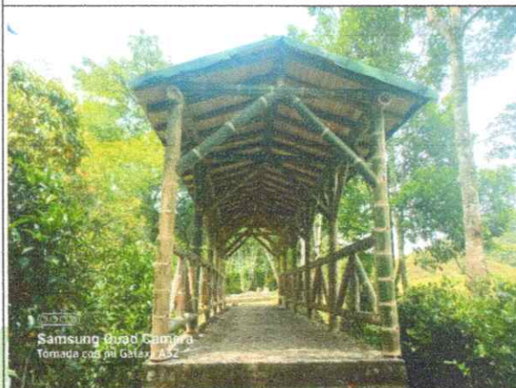
IMAGEN 19. Construcción de cubierta – Kiosco sobre puente existente, parque lineal San Antonio.
