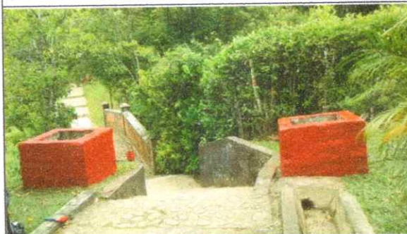
IMAGEN 44. Restauración puntos ecológicos en concreto ciclópeo, ubicados en parque lineal San Antonio.
