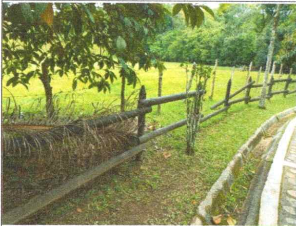
IMAGEN 33. Estado actual de cercas en madera inmunizada, parque lineal San Antonio.
