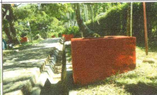
IMAGEN 45. Restauración puntos ecológicos en concreto ciclópeo, ubicados en parque lineal San Antonio.
