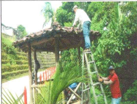
IMAGEN 28. Proceso de restauración de Kiosco, parque lineal San Antonio.
