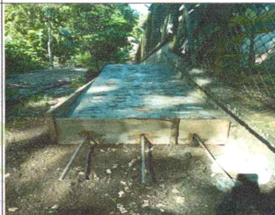
IMAGEN 12. Vaciado de concreto ciclópeo para sendero, parque lineal Puerto Garza.
