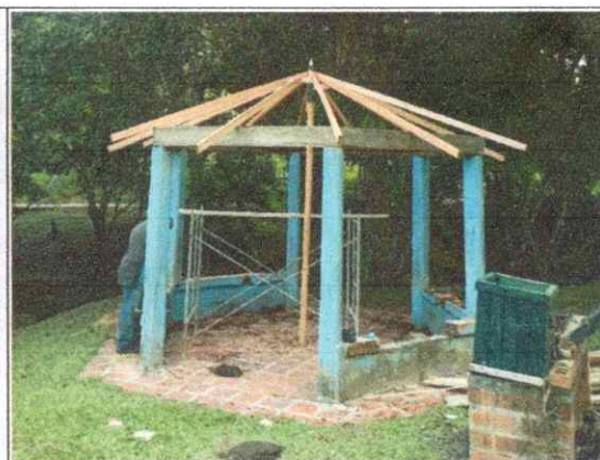
IMAGEN 10. Instalación de largueros para cubierta, parque lineal Canoas.
