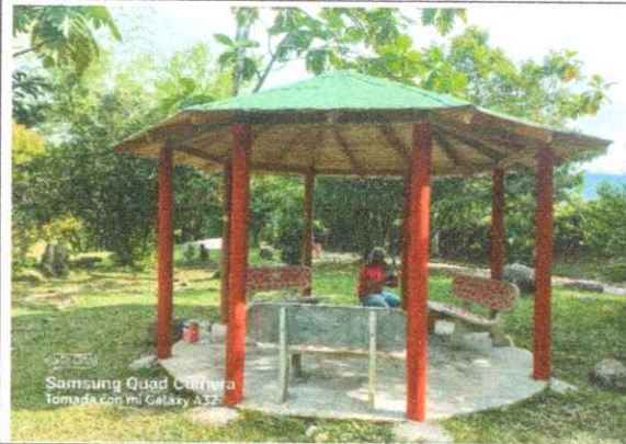
IMAGEN 31. Terminación de kioscos, parque lineal San Antonio.
