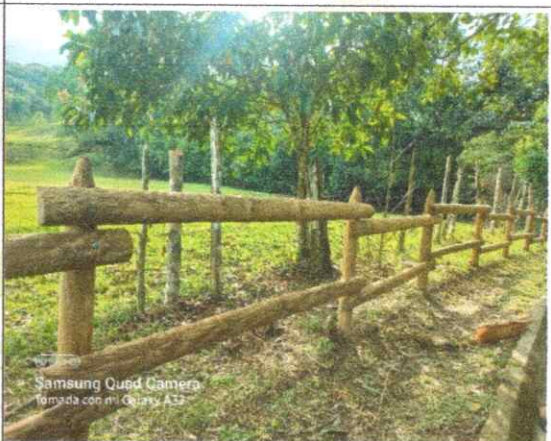
IMAGEN 34. Restauración de cerca en madera inmunizada, Parque lineal San Antonio.
