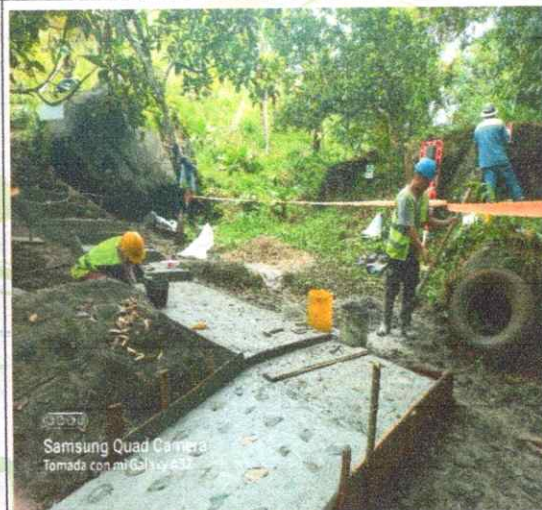
IMAGEN 4. Vaciado en concreto ciclópeo en parque lineal Dosquebradas.
