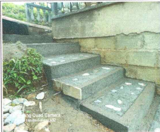
IMAGEN 2. Vaciado de escalas en concreto, parque lineal Dosquebradas.
