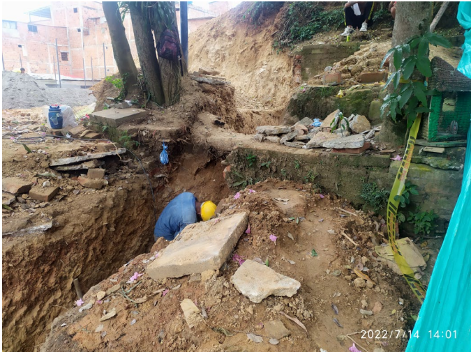
Vista de profundidades de excavaciones en zona pendientes para tubería PVC para Alumbrado Público.
