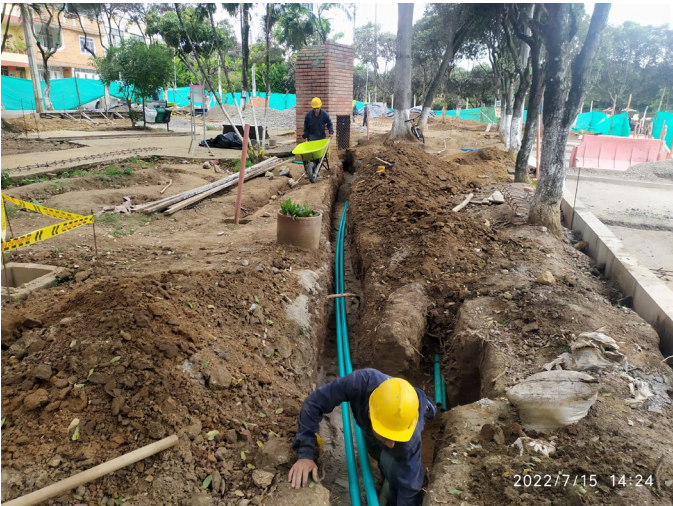
Excavación y tendido de banco de ductos 2 x 1 1 / 2 “PVC.
