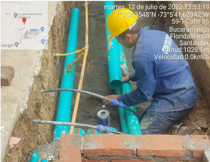
Banco de Ductos de Tubería PVC en andén de la kra 60.
