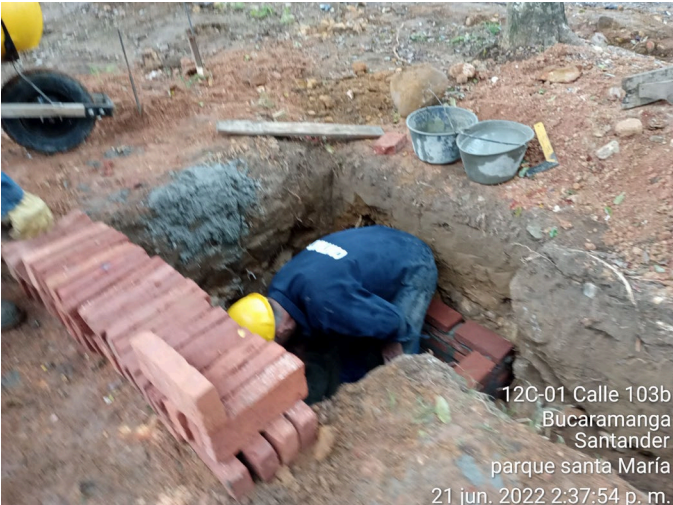
Excavación y construcción de caja de inspección 40x40x70 cm RS3-001
