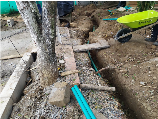
Excavación para A.P de 90cm de profundidad y tendido de tubería PVC de 2x1 ½ “.
