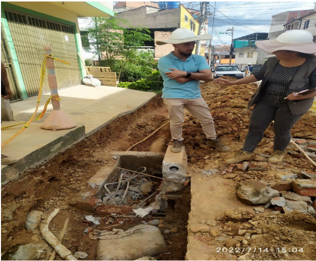
Banco de ductos PVC en tuberías de 6 x 4" para comunicaciones , 3 x 3" para Baja Tensión y 3 x 1 ½ "para Alumbrado Público.
