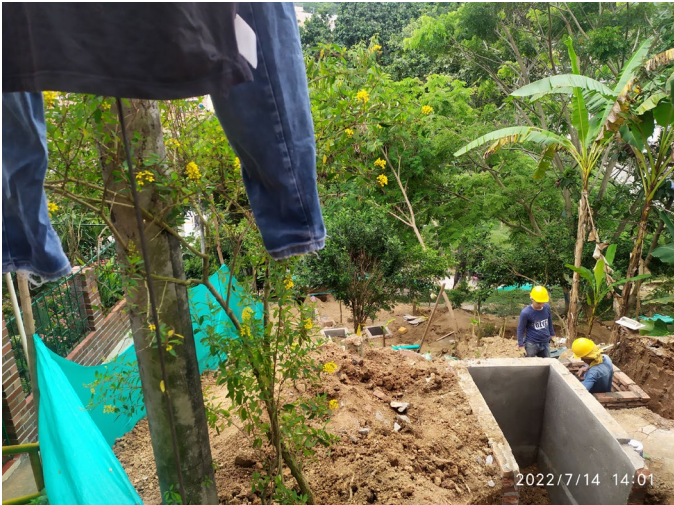
Vista de cajas de inspección en zona inclinada.
