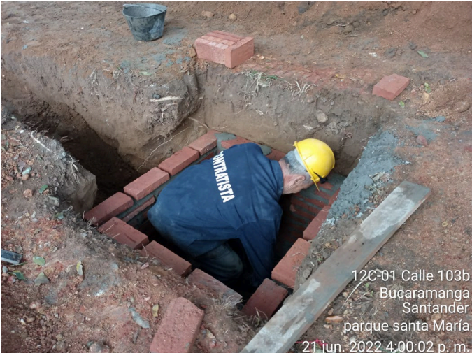
Construcción de caja de Inspección RS3-001.
