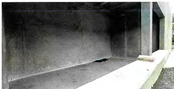
Interior del Armerillo 2
