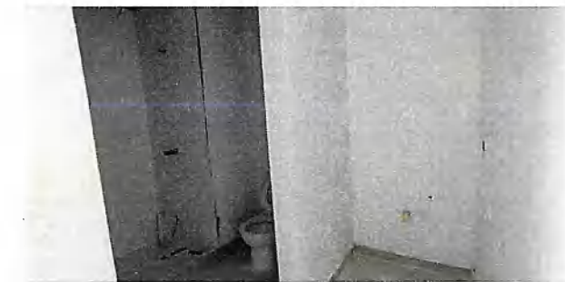
Baños habitación 7 E3 - Piso 1
