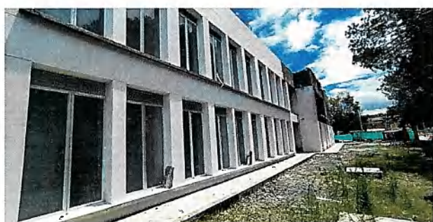
Fachada Oriente Alojamiento E3
