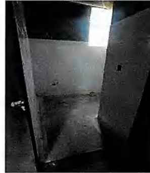
Baño mujeres Casino - Piso 1
