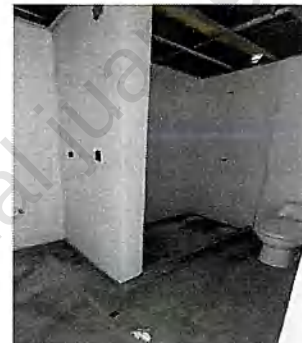
Baños habitación 1 E1 - Piso 2
