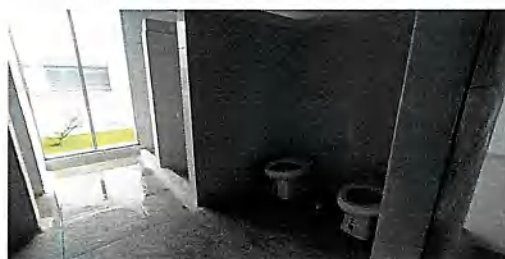
Baños habitación 5 E1 - Piso 2
