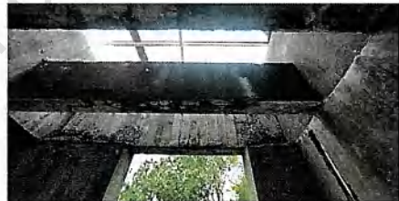
Cubierta balcón Suite E3 - Piso 1
