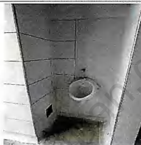
Baños habitación 5 E1 - Piso 1
