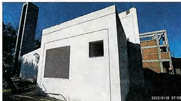
Fachada Lateral Izquierda
