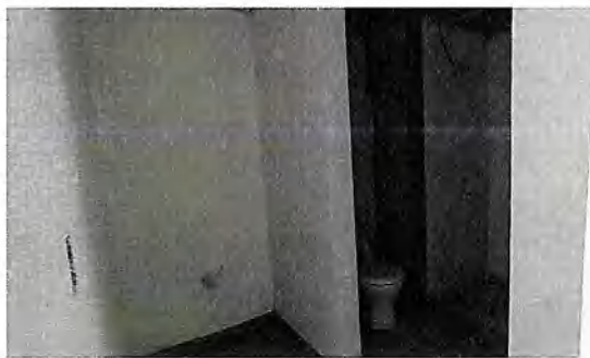
Baños habitación 7 E3 - Piso 2
