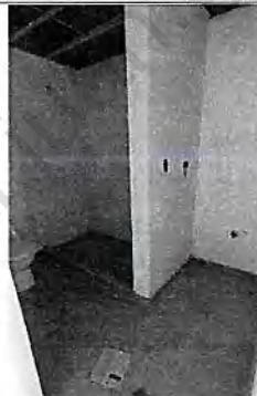
Baños habitación 2 E1 - Piso 2
