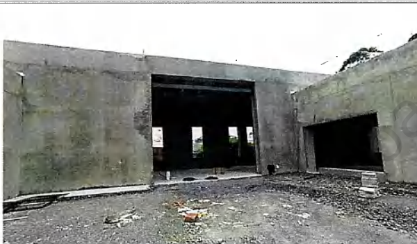
Ingreso a la bodega
