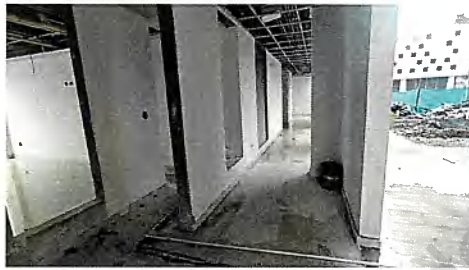
Espacios de circulación primer piso E1
