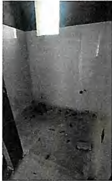
Baño hombres casino - Piso 2
