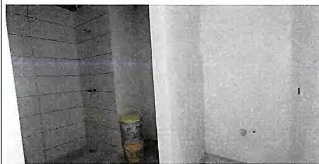
Baños habitación 1 E3 - Piso 1
