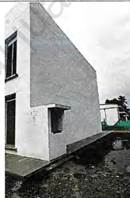
Fachada Sur (hacia las canchas) Alojamiento E1
