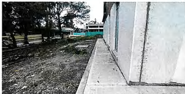
Andén fachada oriental - Alojamiento E3
