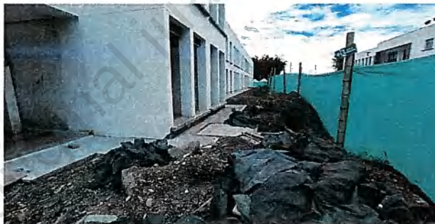
Andén fachada occidental - Alojamiento E1
