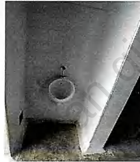
Baños habitación 3 E1 - Piso 1
