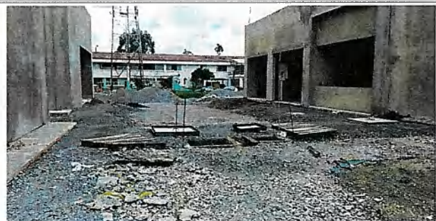
Vía entres celdas y subestación.
