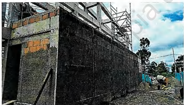
Fachada área de Camerinos
