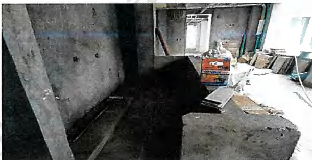
Área de cocina - Piso 1
