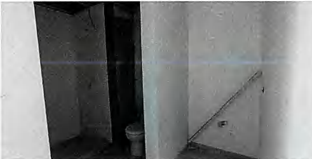
Baños habitación 4 E3 - Piso 2
