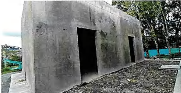
Fachadas espacio para celdas.
