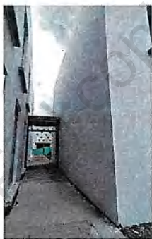
Fachada Occidente Alojamiento E2
