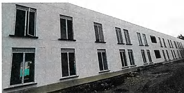
Fachada Oriente Alojamiento E1
