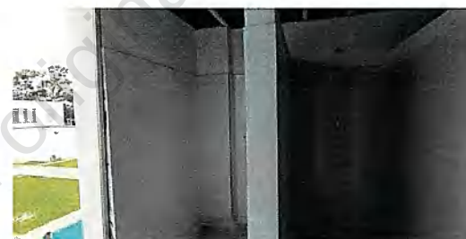
Duchas habitación 5 E1 - Piso 2
