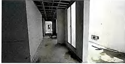
Espacios de circulación alojamiento E3 (Ingreso)
