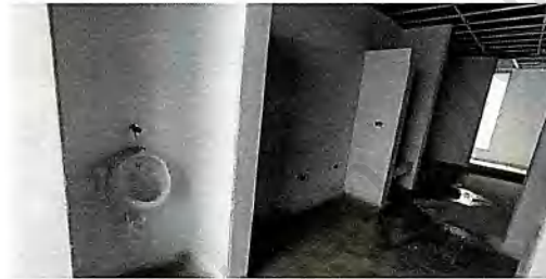
Baños habitación 9 E1 - Piso 1
