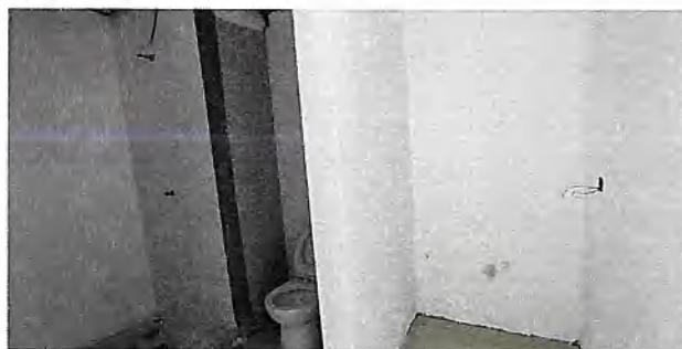
Baños habitación 1 E3 - Piso 2
