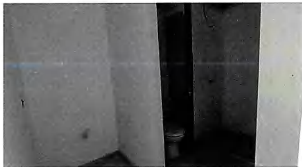
Baños habitación 2 E3 - Piso 2
