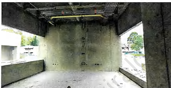
Interior del espacio
