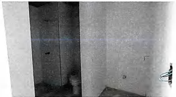
Baños habitación 3 E3 - Piso 1
