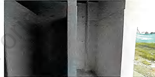
Duchas habitación 9 E1 - Piso 1
