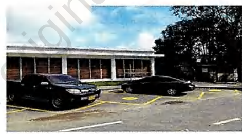
Bahía de parqueo Edificio Bienestar.
