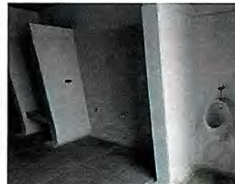
Baños habitación 5 E1 - Piso 2
