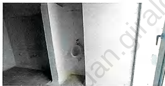
Baños habitación 3 E1 - Piso 2
