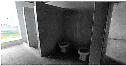
Baños habitación 8 E1 - Piso 1
