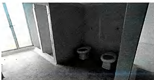
Baños habitación 7 E1 - Piso 2
