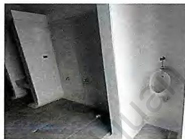
Baños habitación 7 E1 - Piso 2
