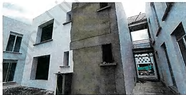
Fachada Sur Alojamiento E2
