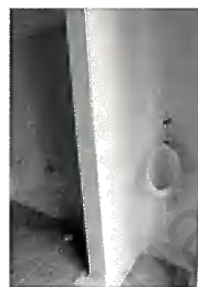
Baños habitación 9 E1 - Piso 2
