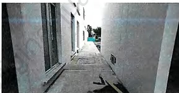
Andén fachada occidental - Alojamiento E3
