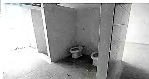
Baños habitación 3 E1 - Piso 2
