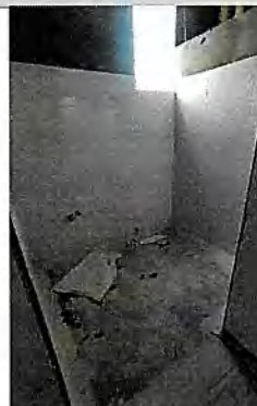
Baño mujeres casino - Piso 2
