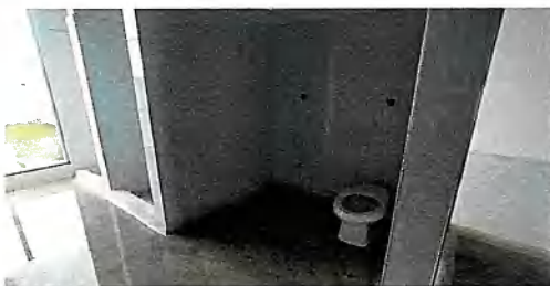
Baños habitación 9 E1 - Piso 2
