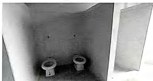
Baños habitación 5 E1 - Piso 1
