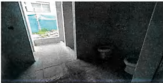
Baños habitación 6 E1 - Piso 1
