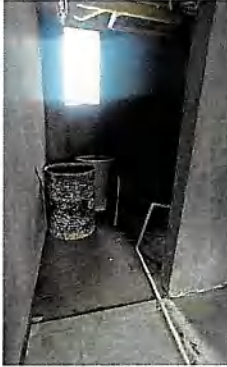
Baño hombres Casino - Piso 1
