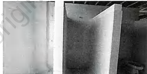
Duchas habitación 8 E1 - Piso 1
