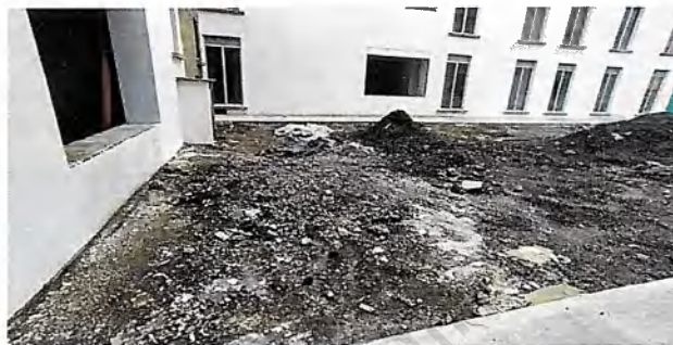
Andén fachada sur - Alojamiento E2
