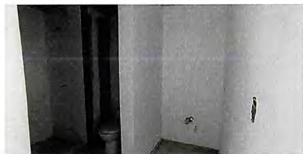
Baños habitación 8 E3 - Piso 2
