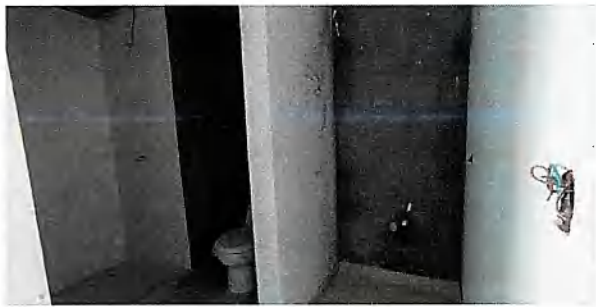
Baños habitación 6 E3 - Piso 2
