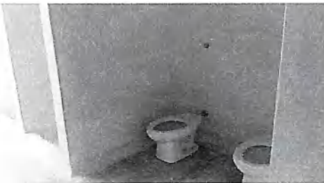
Baños habitación 10 E1 - Piso 1
