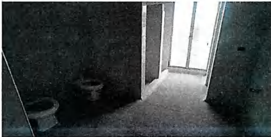
Baños habitación 4 E1 - Piso 2
