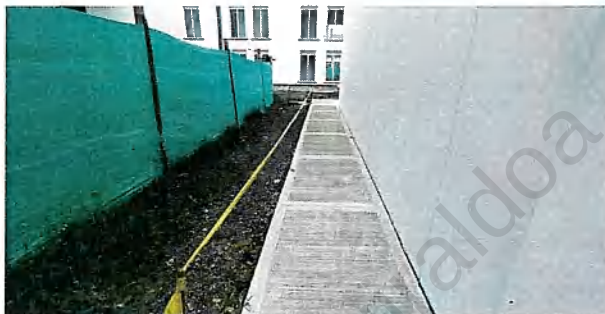
Andén fachada sur - Alojamiento E3
