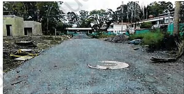
Estado de la vía de acceso al bloque 5
