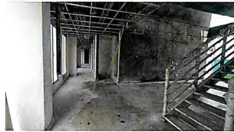
Espacios de circulación primer piso E1
