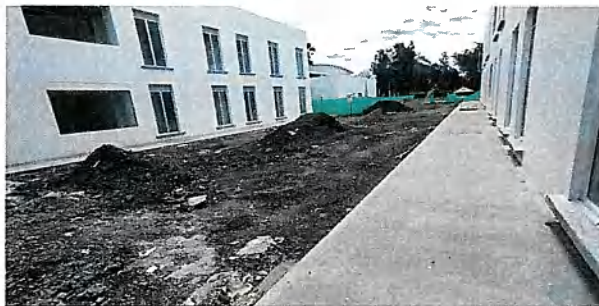
Andén fachada oriental - Alojamiento E1
