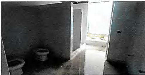
Baños habitación 9 E1 - Piso 1
