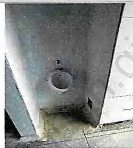
Baños habitación 3 E1 -Piso 1
