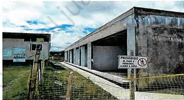
Fachada Lateral Izquierda
