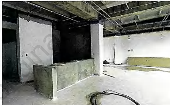
Área de cocina - piso 2
