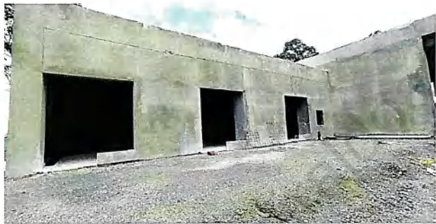
Fachada espacios almacen intendencia
