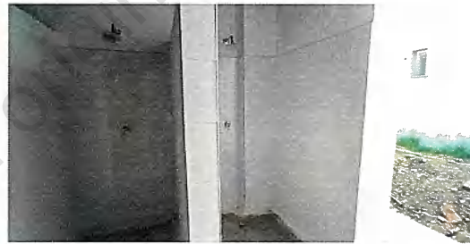
Duchas habitación 3 E1-Piso 1
