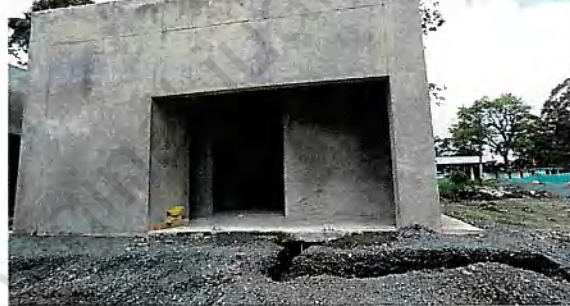
Fachadas espacios para unidad técnica de basuras.
