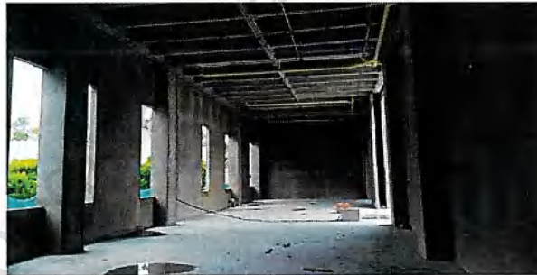
Interior de la bodega
