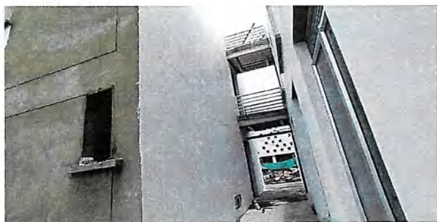
Fachada Oriente Alojamiento E2
