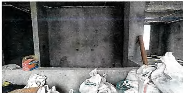
Área de cocina - Piso 1
