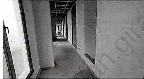
Espacios de circulación primer piso E1
