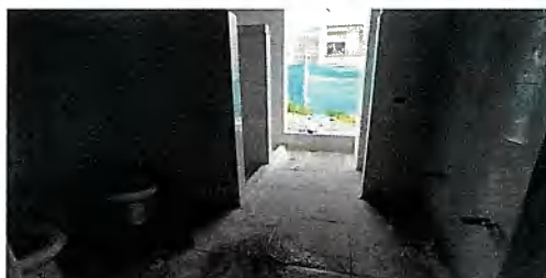
Baños habitación 7 E1 - Piso 1
