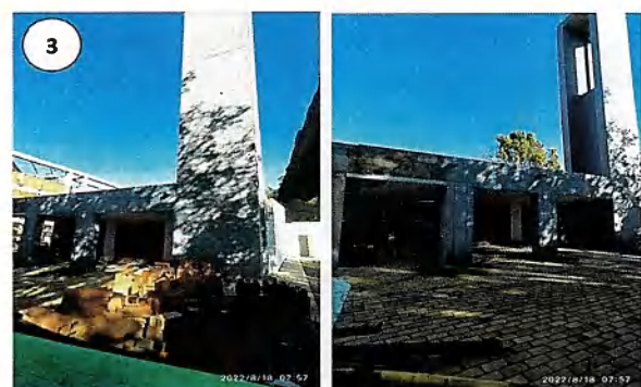
Fachada Principal - Campanario
