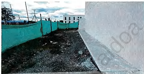
Andén fachada sur - Alojamiento E1
