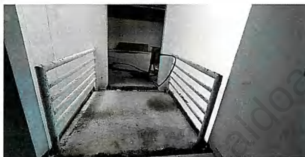
Acceso al casino desde el Alojamiento E3
