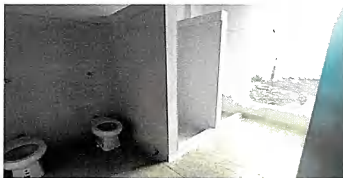
Baños habitación 3 E1 - Piso 1
