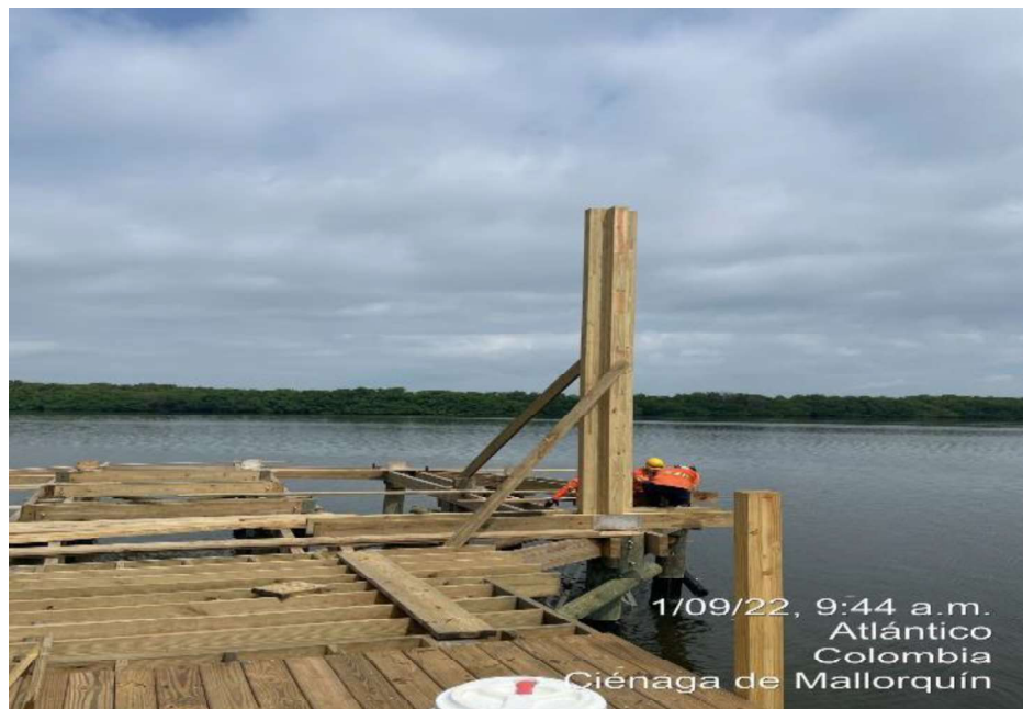
Imagen 12: Instalación de columnas módulo 2.
