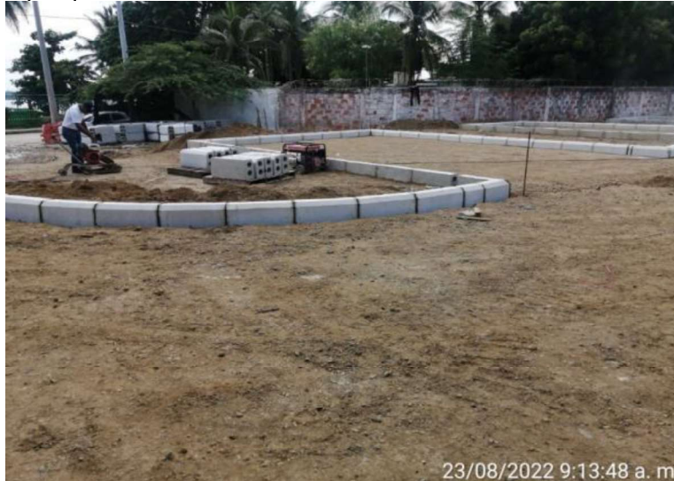
Instalación de bordillo.
