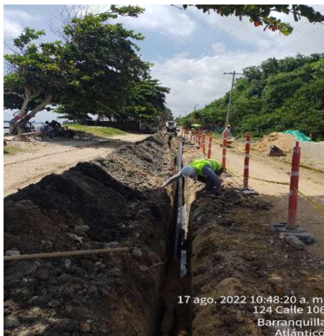
Imagen 29: Instalación tubería PEAD.
