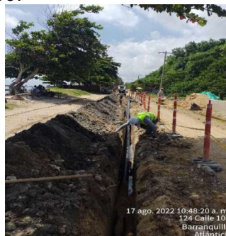
Instalación tubería PEAD.
