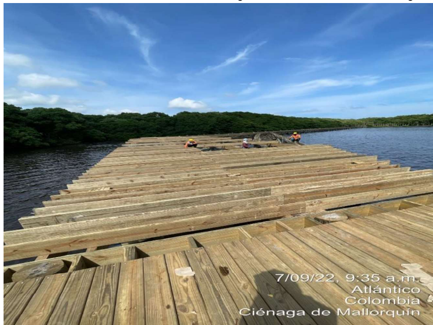
Imagen 16: Instalación de deck.
