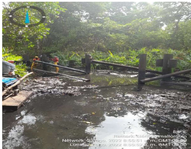
Imagen 7: Instalación de riostras módulo 23.
