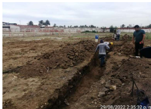
Instalación tubería de alcantarillado
