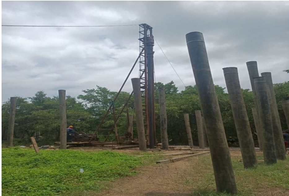
Imagen 13: Hincado de pilotes modulo 40.
