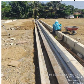
Concreto de 4.000 PSI
