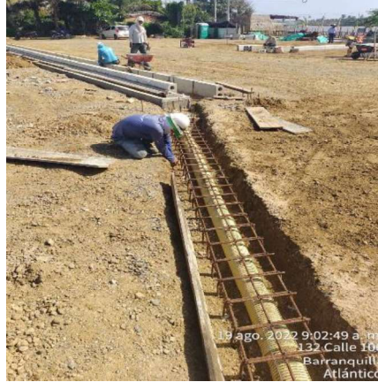
Colocación acero de refuerzo
