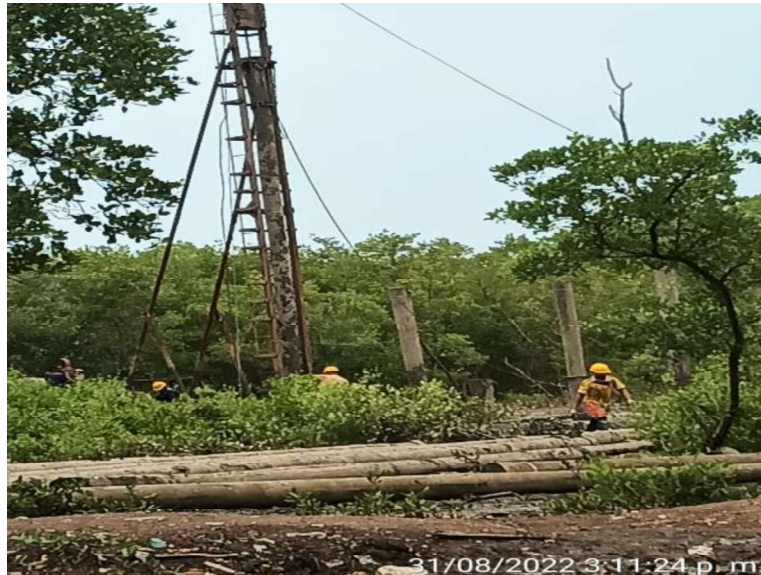
Instalación de pilotes modulo 40.
