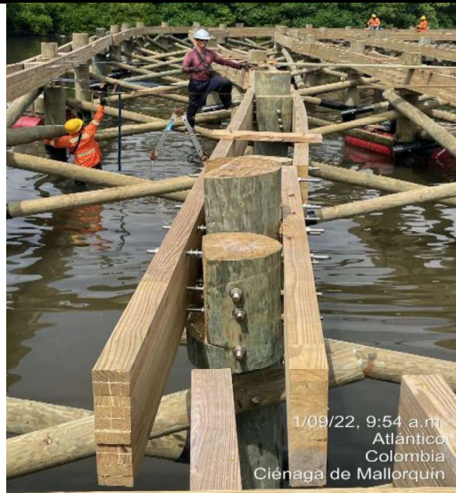
Instalación de vigas laminadas módulo 8.
