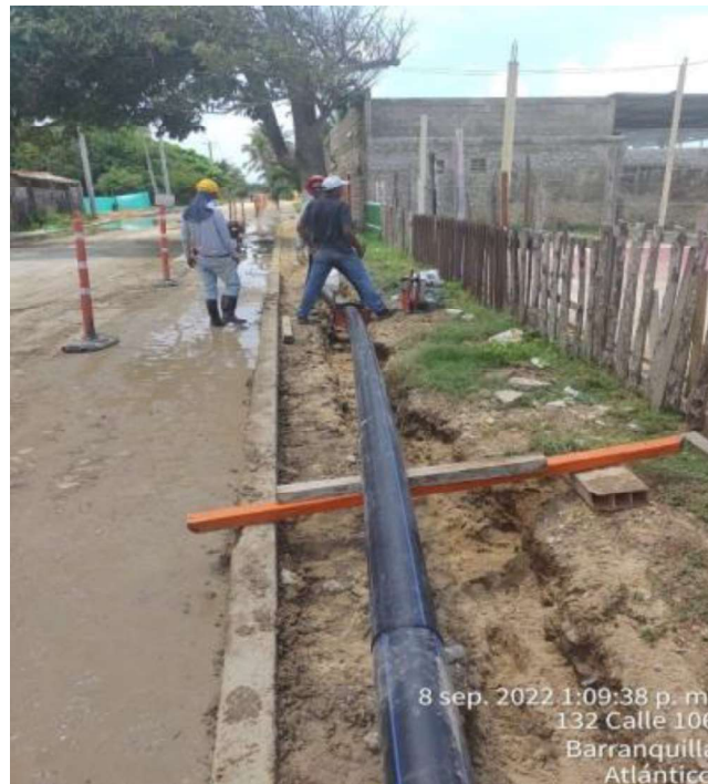
Imagen 37: Instalación de tubería PEAD
