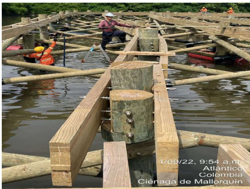
Imagen 11: Instalación de vigas laminadas módulo 8.
