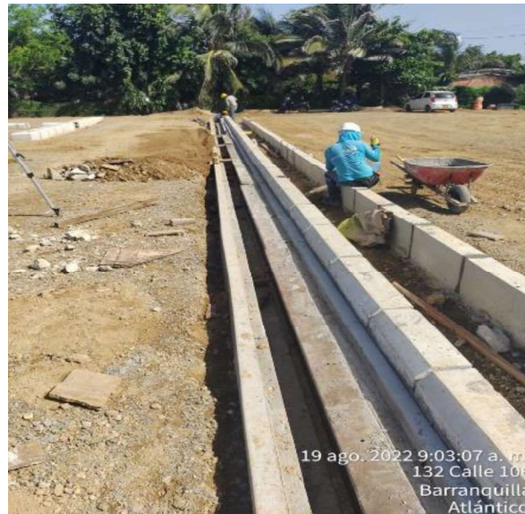
Imagen 31: concreto de 4.000 PSI
