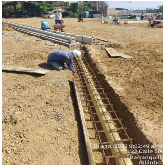
Imagen 32: Colocación acero de refuerzo
