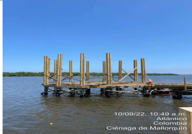
Instalación de columnas modulo 2.
