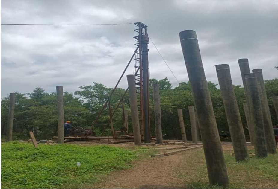
Hincado de pilotes modulo 40.
