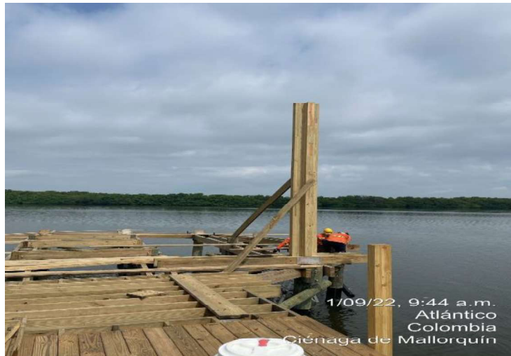
Instalación de columnas módulo 2.
