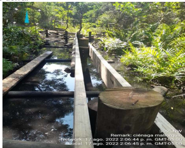
Instalación vigas laminadas modulo 20.
