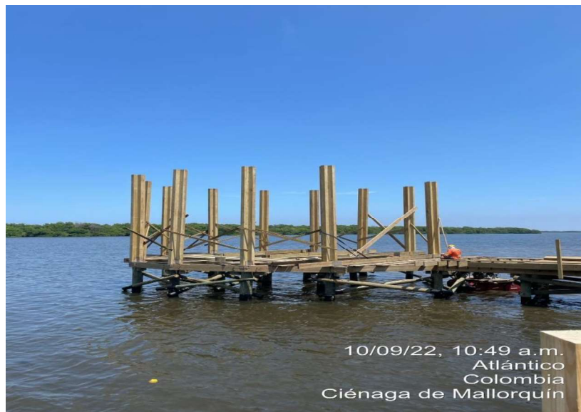
Imagen 14: Instalación de columnas modulo 2.
