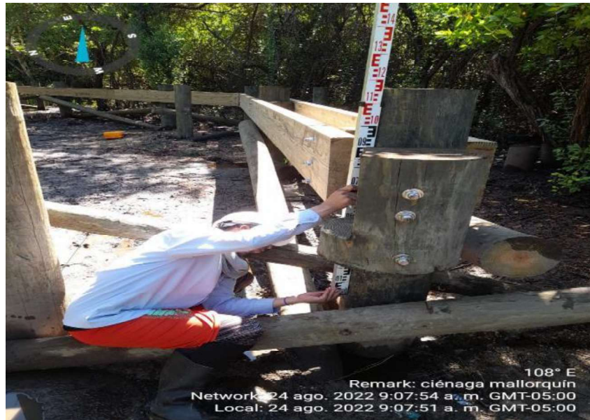
Imagen 6: Instalación de vigas laminadas módulo 23.
