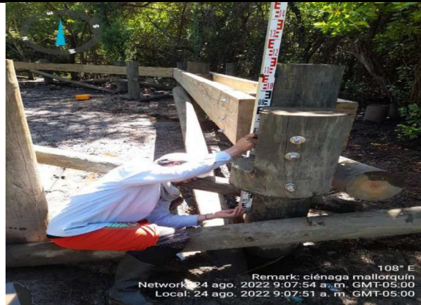
Instalación de vigas laminadas módulo 23.
