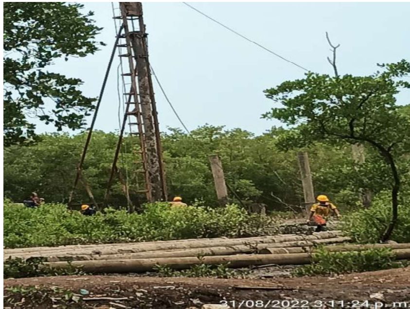
Imagen 10: Instalación de pilotes modulo 40.
