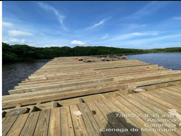
Instalación de deck.
