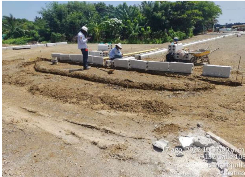
Imagen 30: Instalación bordillo.
