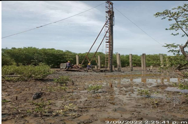
Hincado frente de tierra.
