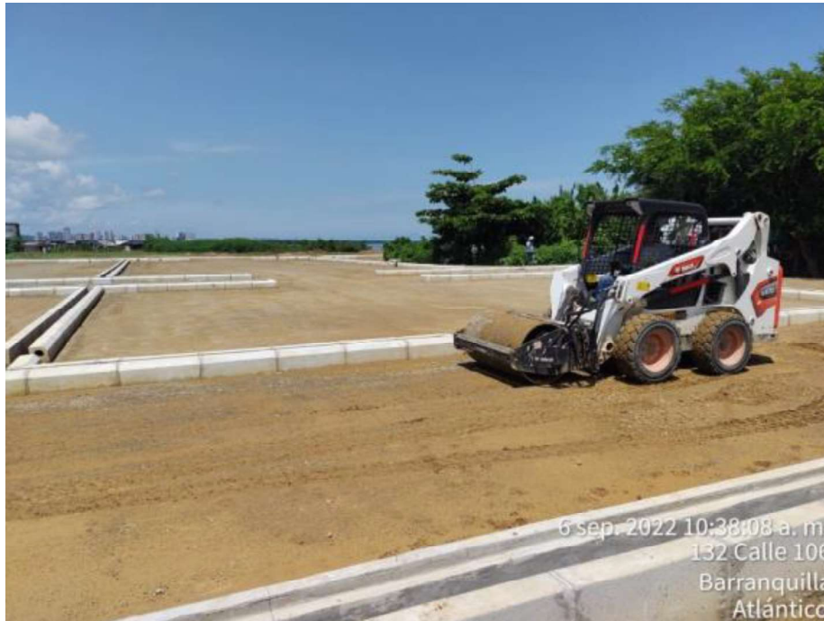
Recompactación de base granular
