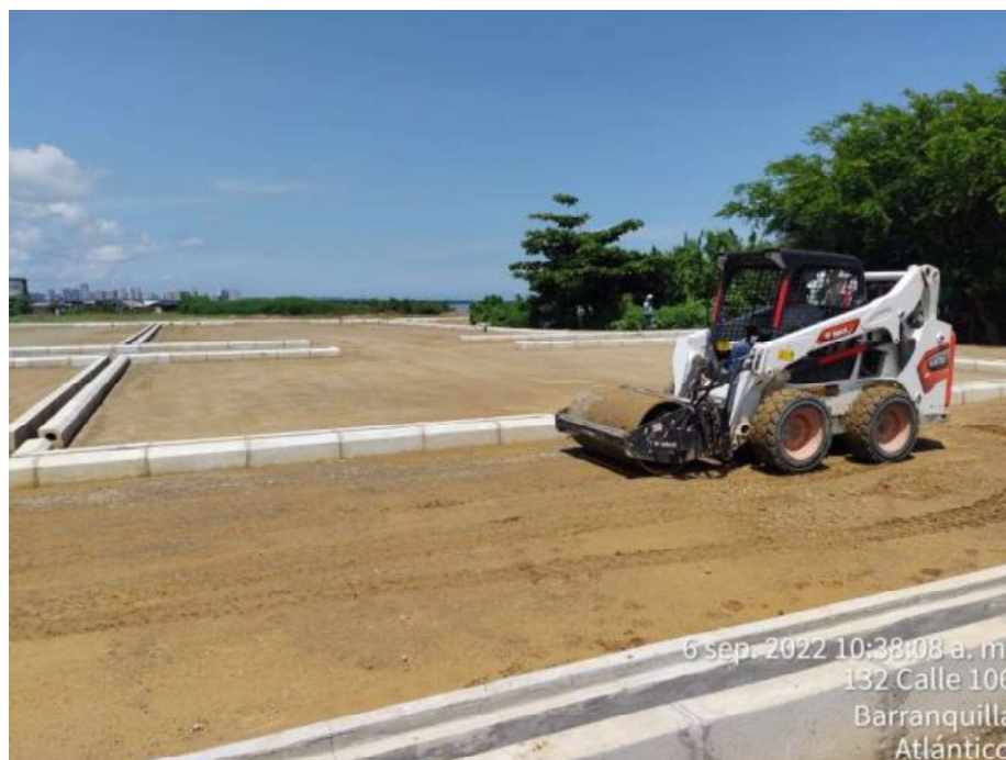
Imagen 38: recompactación de base granular
