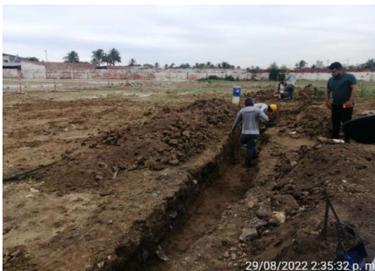
Imagen 36: Instalación tubería de alcantarillado
