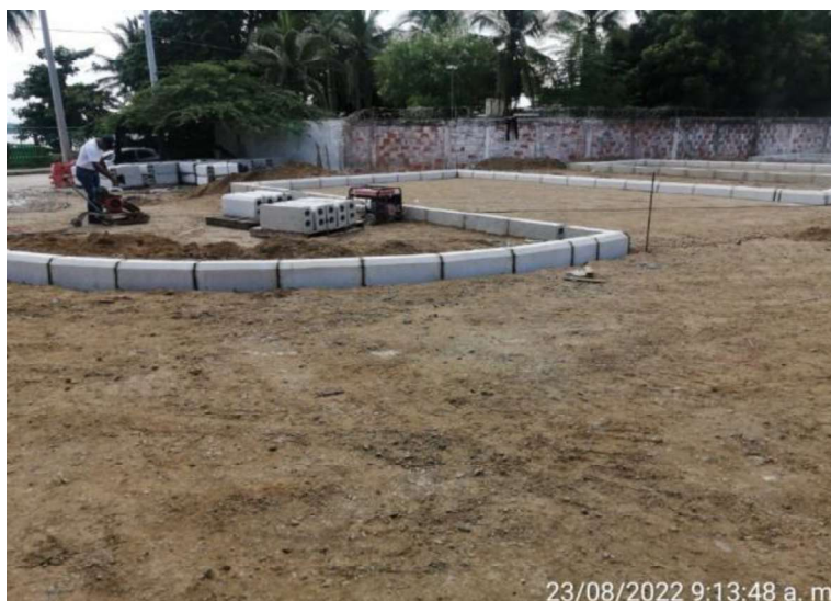
Imagen 34: instalación de bordillo.
