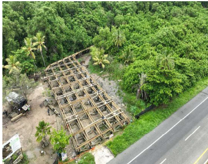
Imagen 5: Instalación de vigas laminadas Estación III.
