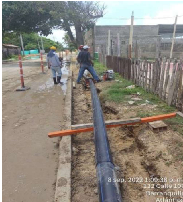
Instalación de tubería PEAD
