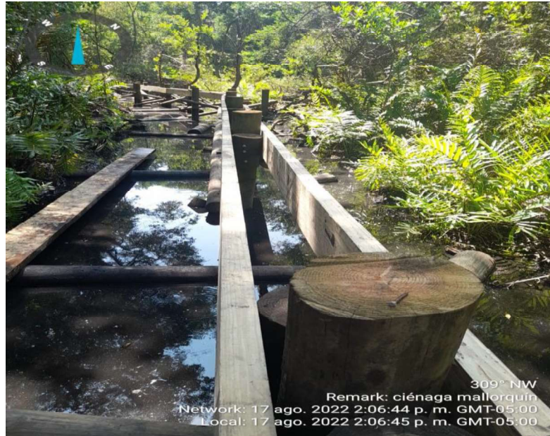
Imagen 3: instalación vigas laminadas modulo 20.
