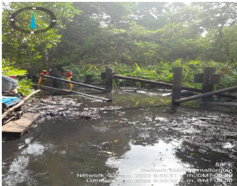
Instalación de riostras módulo 23.
