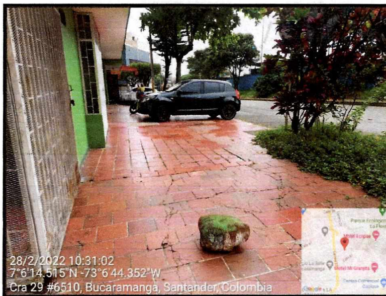
Vista General del sector
