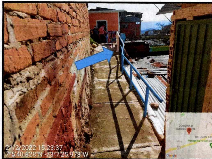
Vista General del sector
