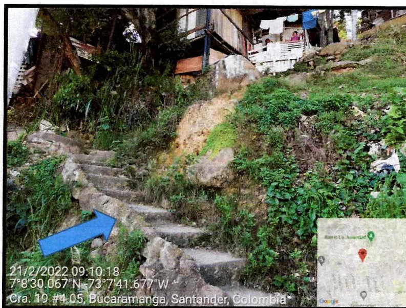
Mejoramiento de escaleras con instalación de pasamanos
