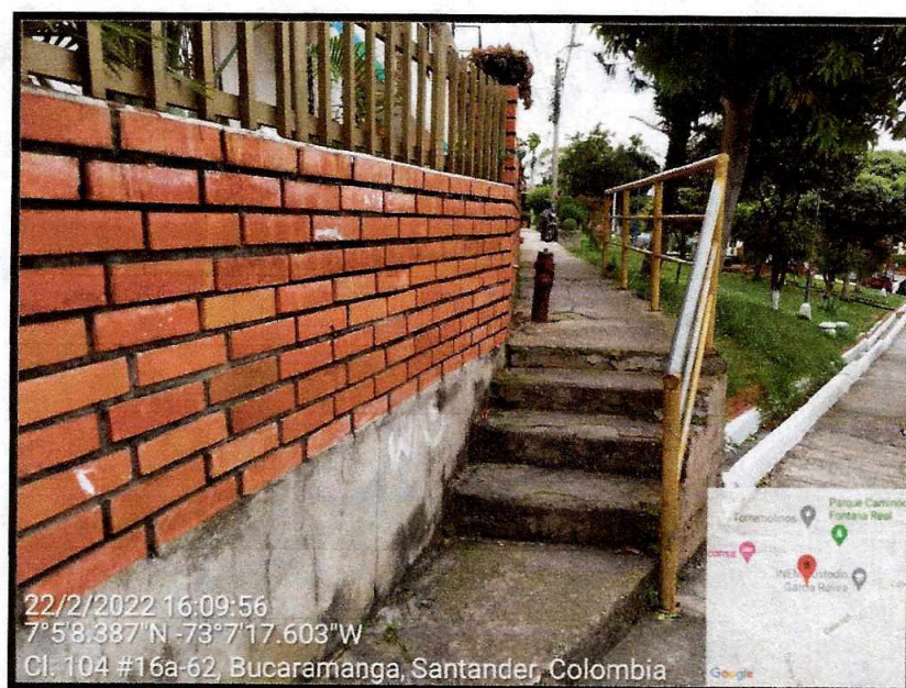
Vista General del sector
