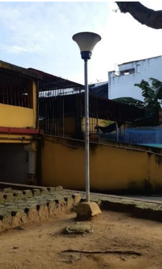
Fotografía 6. Estado actual de la infraestructura, urbanización los Naranjos.
