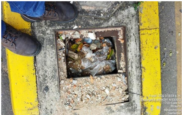
Fotografía 27. Estado actual de la infraestructura, Fuente: elaboración propia.
