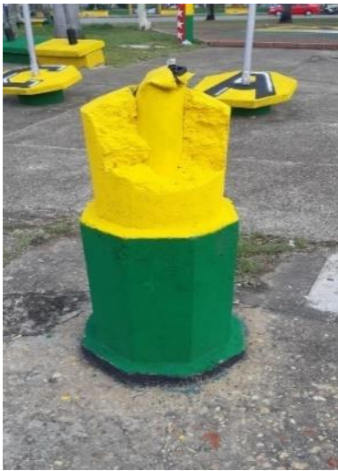
Fotografía 20. Estado actual Glorieta Estadio intervención. Fuente: elaboración propia.
