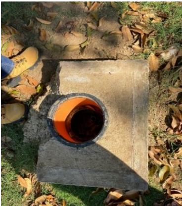
Fotografía 13. Estado actual Glorieta San Francisco intervención. Fuente: elaboración propia.
