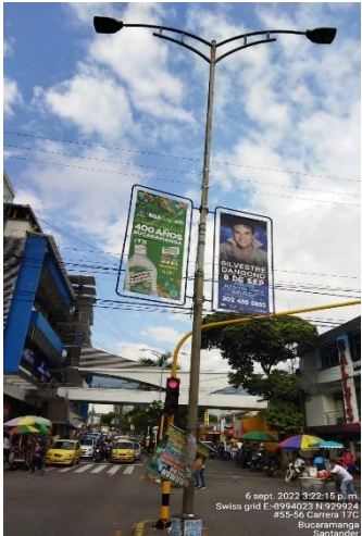
Fotografía 28. Estado actual de la infraestructura, Fuente: elaboración propia.
