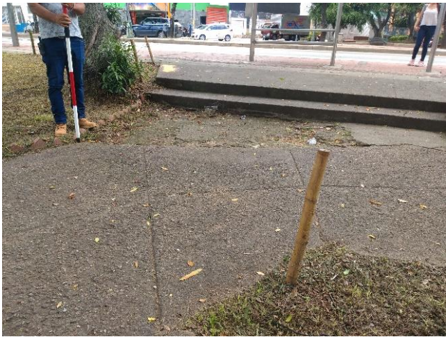
Fotografía 38. Estado actual para intervención. Fuente: elaboración propia.
