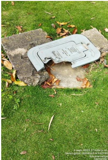
Fotografía 30. Estado actual de la infraestructura, Fuente: elaboración propia.
