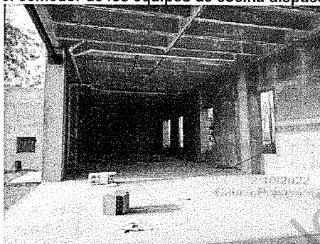
Estado general del bloque 5
