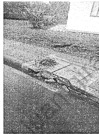
Con la maniobra el contratista daño una caja de inspección. Se solicitó su restitución.
