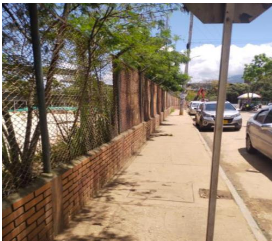
Fotografía 1: Estado actual Cerramiento y Espacio Público Sobre la Carrera 30. (Fuente propia)
