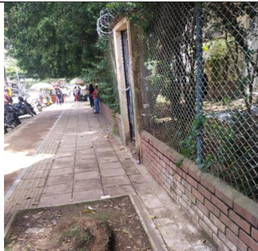
Fotografía 2: Estado actual Cerramiento y Espacio Público Sobre la Calle 10 (Fuente propia)
