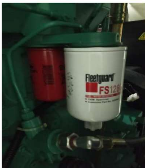
(Imagen3). Cambio filtro de combustible FS1280
