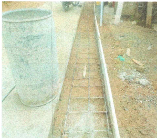
FIGURACION DE ACERO PARA CUNETAS
