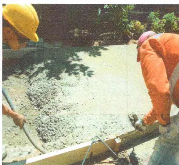
FUNDICION DE LOSAS
