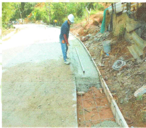
FUNDICION DE CUNETAS
