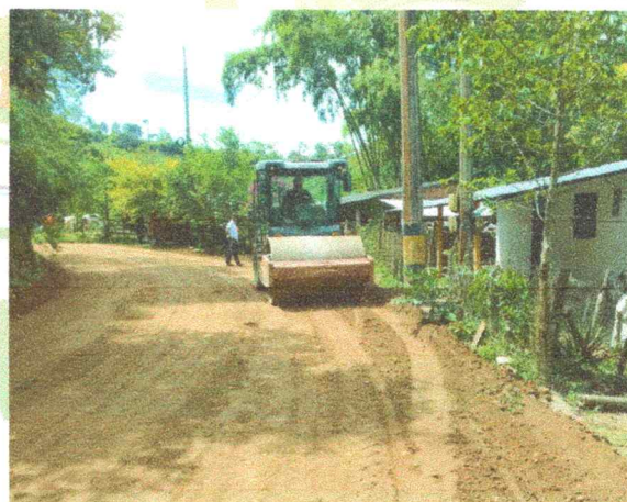
CONFORMACION DE CALZADA EXISTENTE
