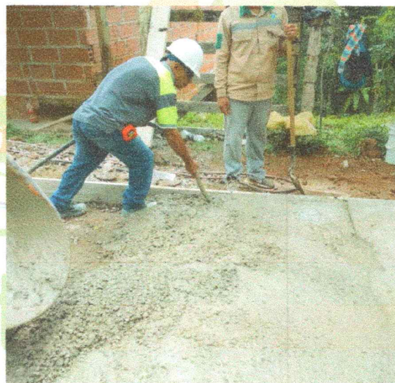
VIBRADO DE CONCRETO EN LOSAS
