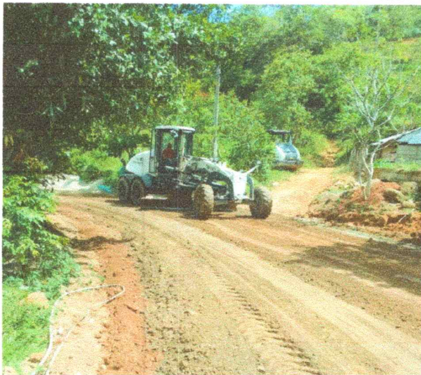
CONFORMACION DE CALZADA EXISTENTE
