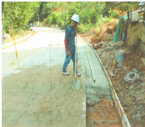
FUNDICION DE CUNETAS
