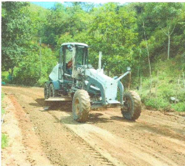
CONFORMACION DE CALZADA EXISTENTE
