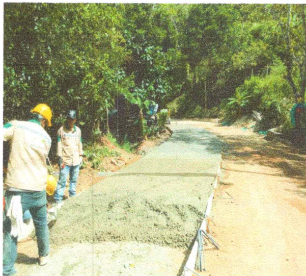
FUNDICION DE LOSAS
