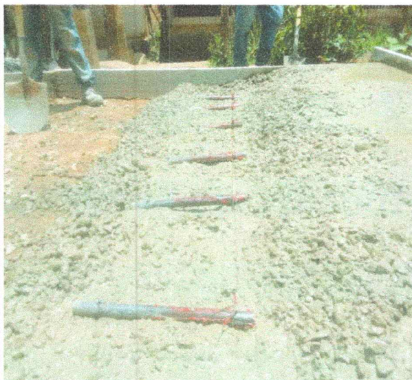
ACERO DE REFUERZO
