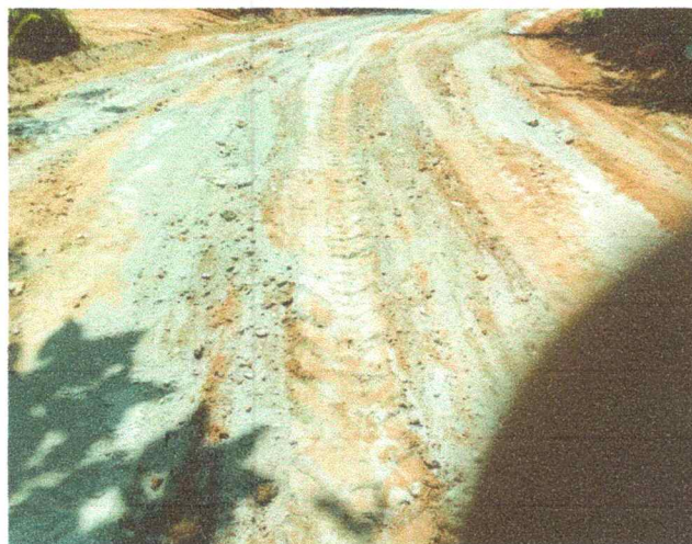
MEJORAMIENTO DE BASE INSTALADA
