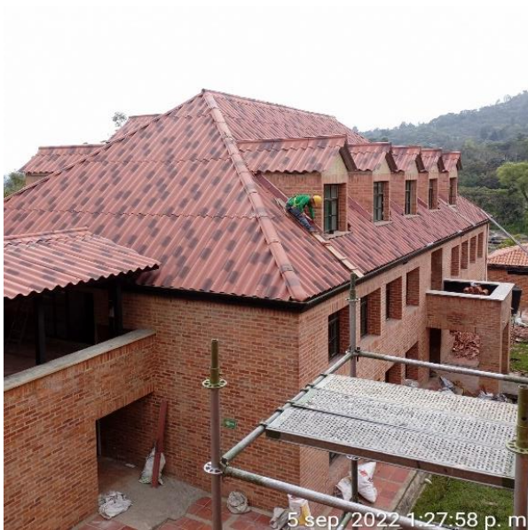
Instalación de flanches en palomeras bloque academico N°2 Vive Digital.
