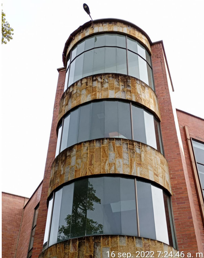
Estado final alfajia bloque administrativo zona acceso a de la terraza.
