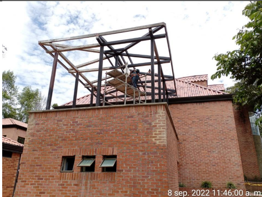
Imagen instalación de la estructura metálica, así como de la aplicación de capas de pintura en dicha estructura.
