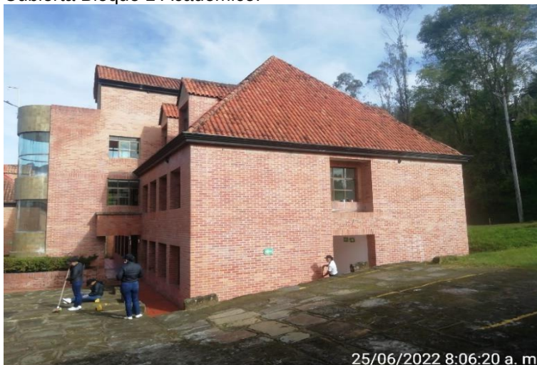
Estado inicial cubierta bloque academico N° 1
