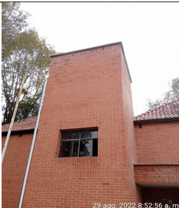
Estado final instalación alfajias en zona de tanques y zona de acceso al casino de suboficiales.
