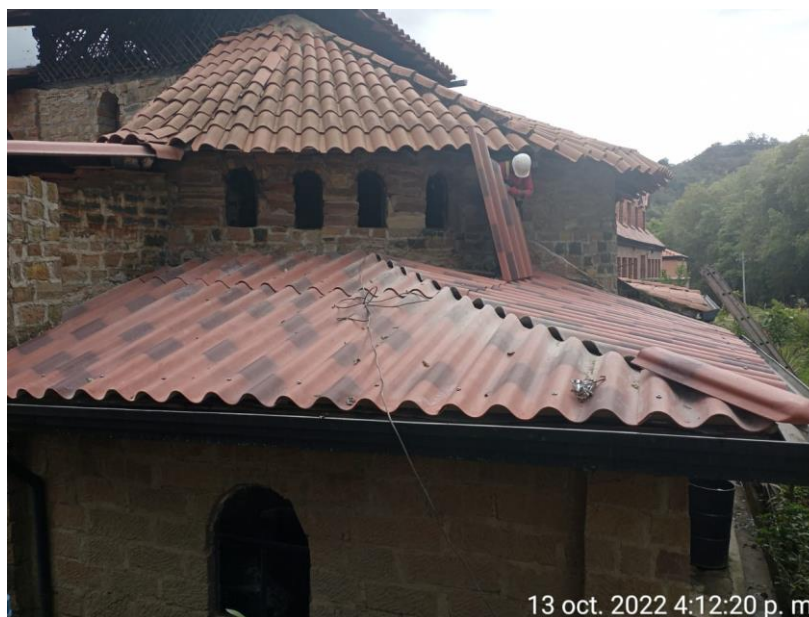
Instalación de limatesas tipo barroca en la cubierta posterior de la capilla
