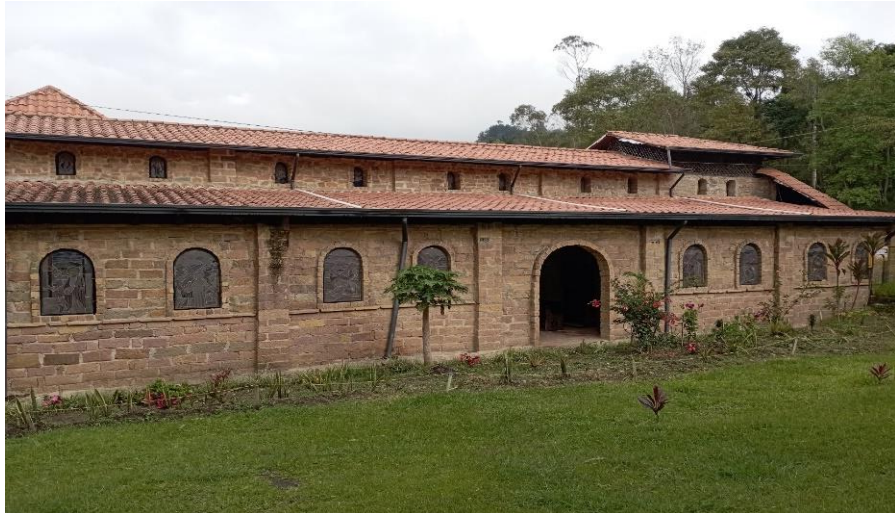
Estado inicial de la capilla, antes de su intervención.
