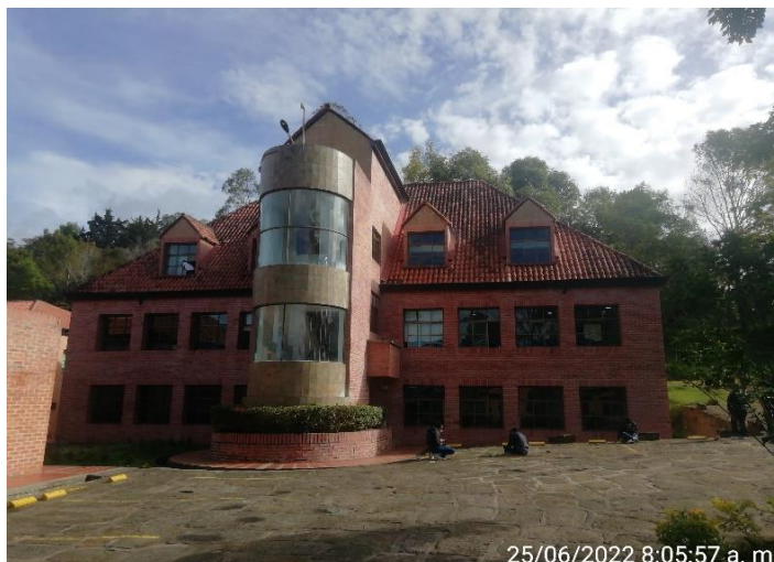
Estado inicial punto fijo bloque academino N°1.
