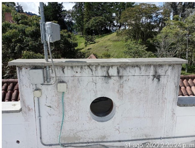
Estado final alfajia con sus respectivas dilataciones, bloque administrativo zona frontal al acceso de la terraza.
