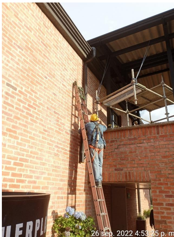
Instalación de bajantes en estructura metalica N° 2.
