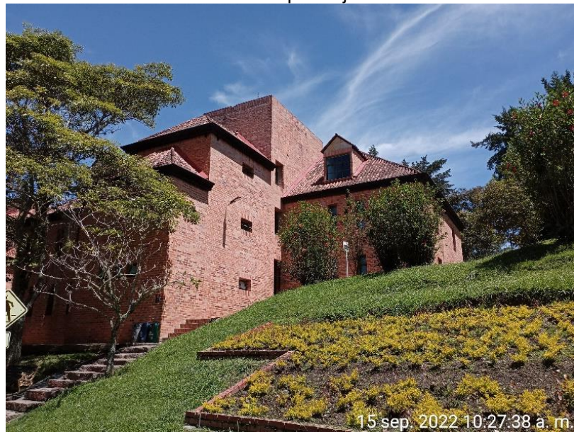
Estado inicial bloque alojamientos A
