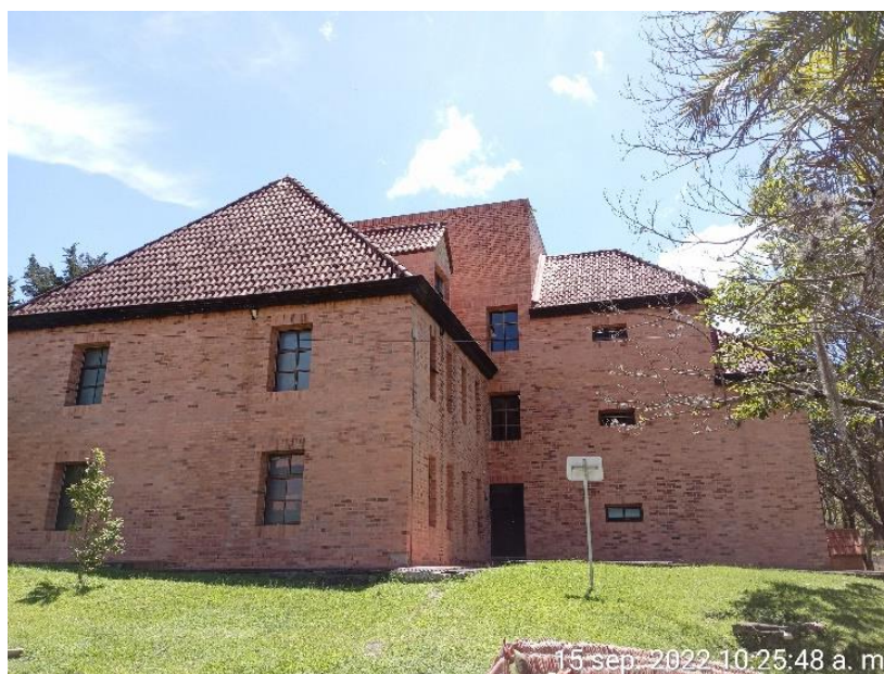
Estado inicial bloque alojamientos B
