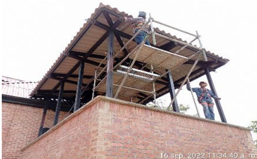
Inicio de la instalación de la canaleta perimetral de la estructura metalica del Baño N° 2.
