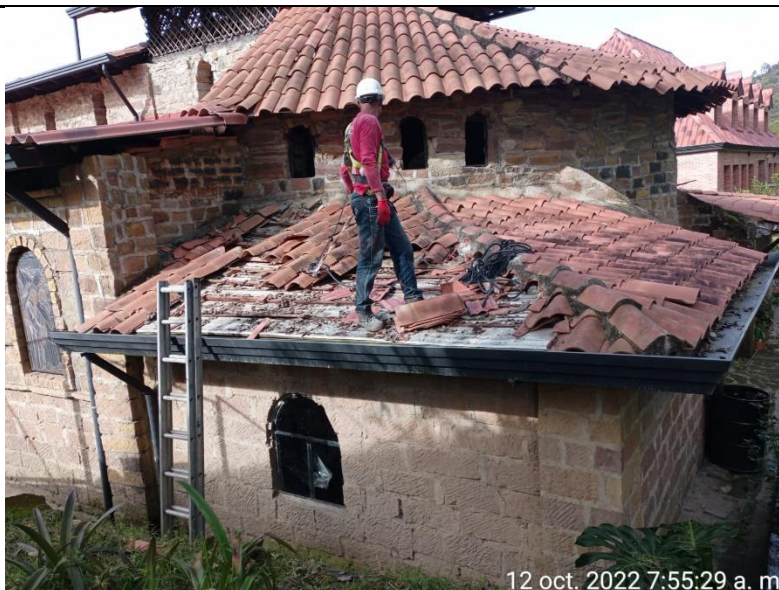
Desmonte teja de barro, en la cubierta de la parte posterior de la capilla
