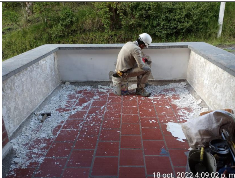
Desmonte de estuco plástico tradicional y pintura.
