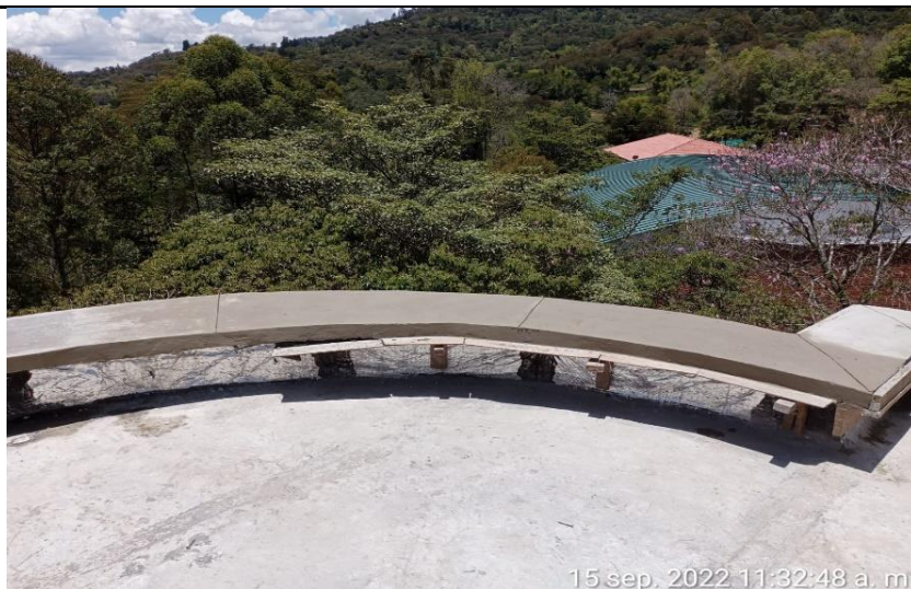
Estado final alfajia bloque administrativo zona acceso a de la terraza, con su respectivas dilataciones.
