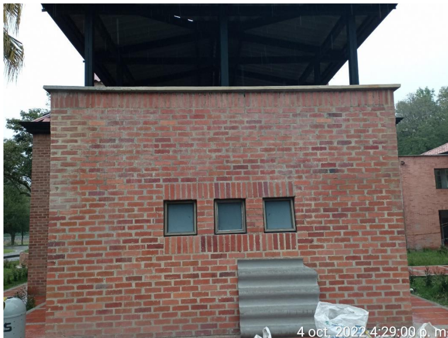
Estrado final de la instalación de vidrios esmerilados en el baño N° 1.
