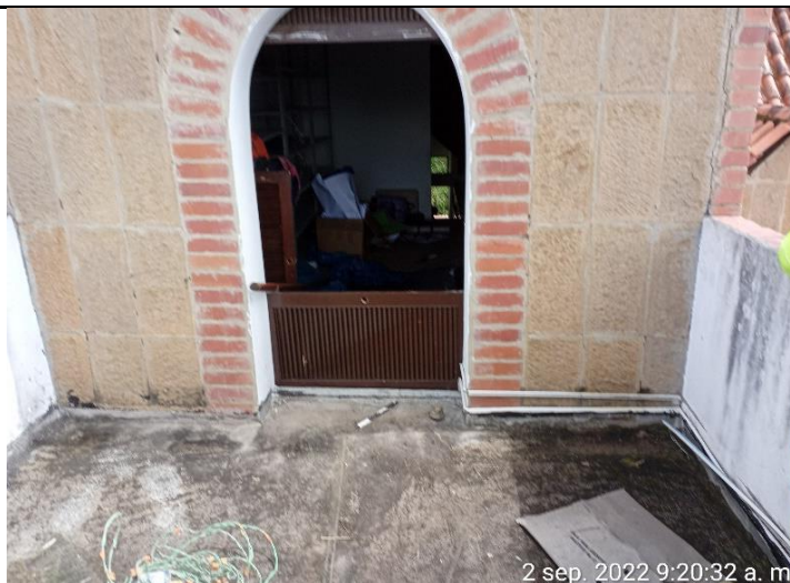
Estado inicial punto fijo bloque academino N°1
