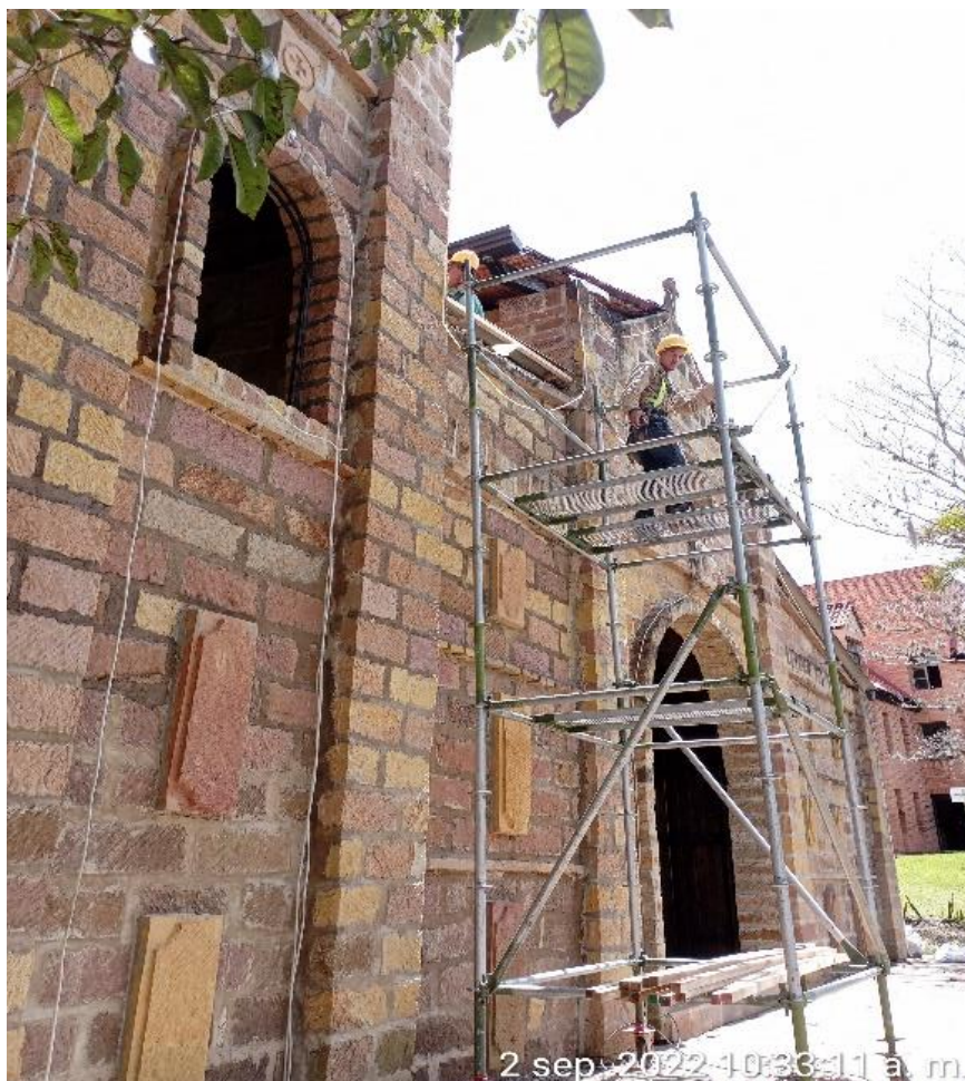
Instalación listones de madera frontales parte frontal de la capilla.
