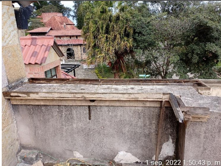
Formaleta y fundición en alfajías en punto fijo bloque academino N°2
