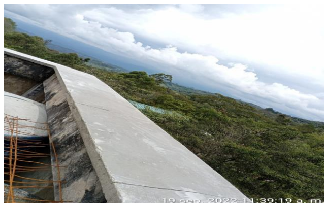
Instalación de formaleta con su malla electro soldada en alfajias en el bloque alojamientos A
