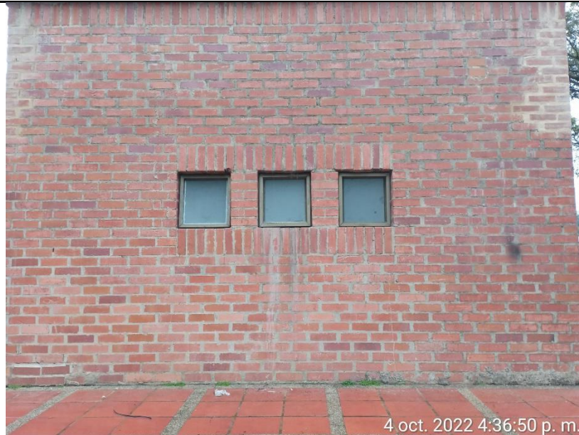
Estado final instalación vidrios esmerilados baño N° 2.
