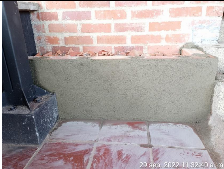
Pañete en silla zona estructura metalica del baño 2.
