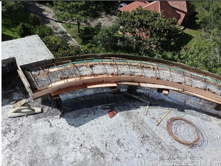
Formaleta de las alfajia, con su respectiva malla electrosoldada y puntos de anclaje a la placa en el punto de acceso de la terraza en el bloque administrativo.
