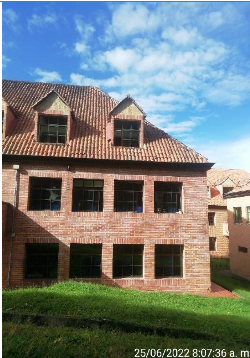
Estado inicial cubierta bloque academico N° 1
