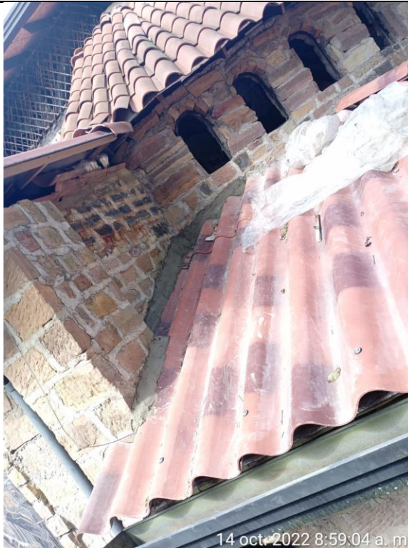
Instalación de media caña en la cubierta parte posterior de la capilla.
