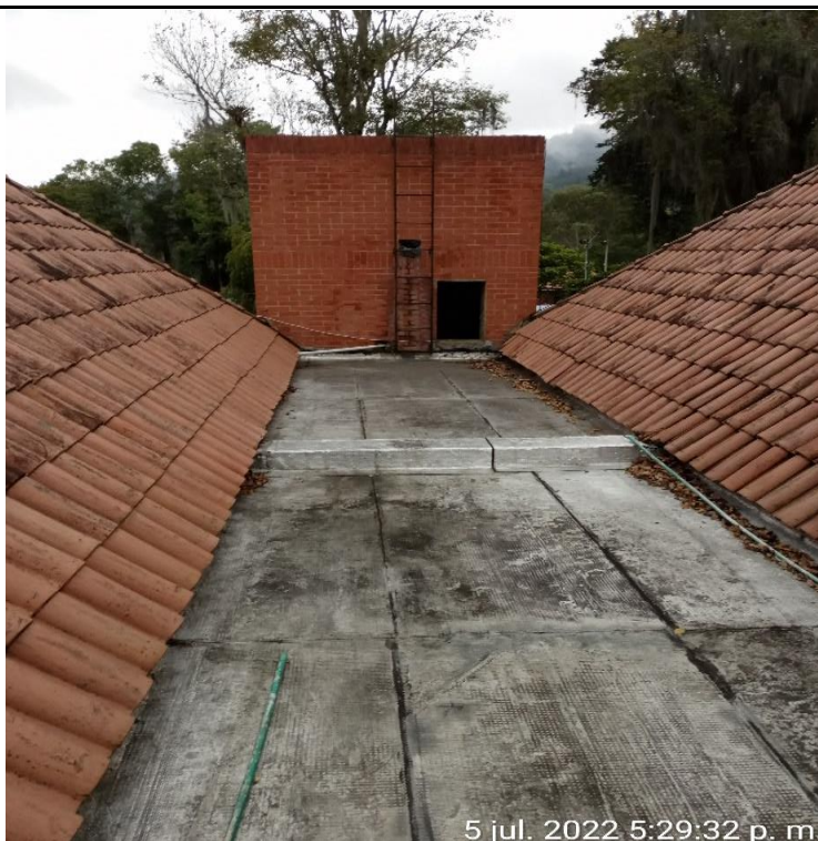
Estado inicial zona de tanques de almacenamiento, en casino de suboficiales.
