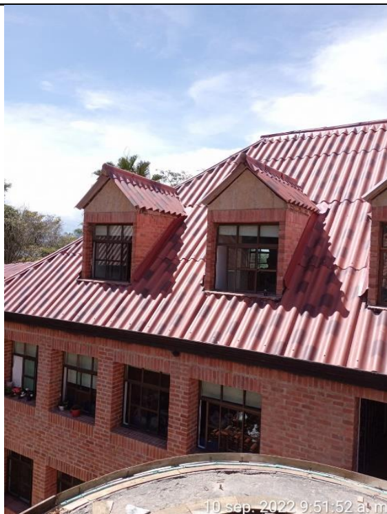
Instalación de flanches en palomeras de la cubierta del bloque academico N° 1
