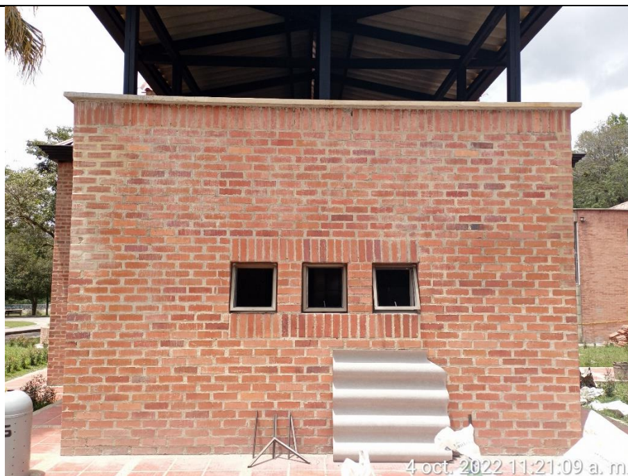
Desmonte de vidrios esmerilados del baño N° 1 para su cambio.
