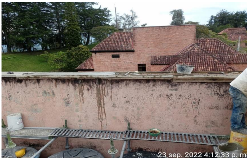
Instalación formaleta alfajia en el bloque alojamientos B
