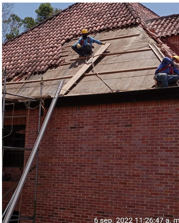
Instalación listones en madera, en la cubierta bloque academico N° 1
