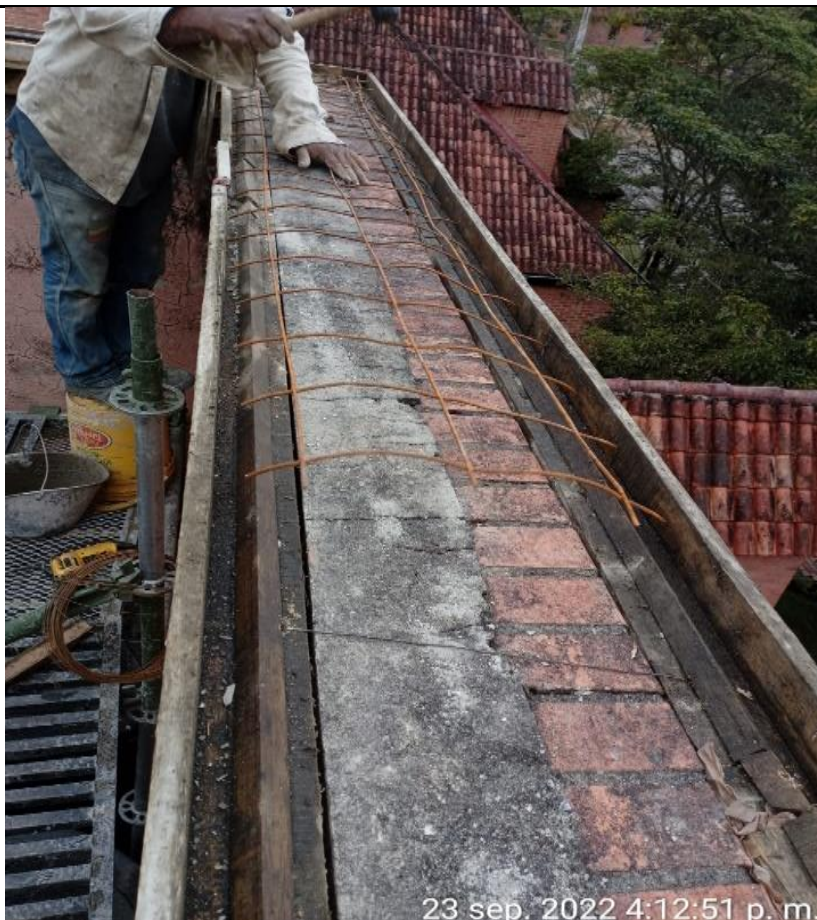
Instalación formaleta y malla electro soldada en el bloque alojamientos B
