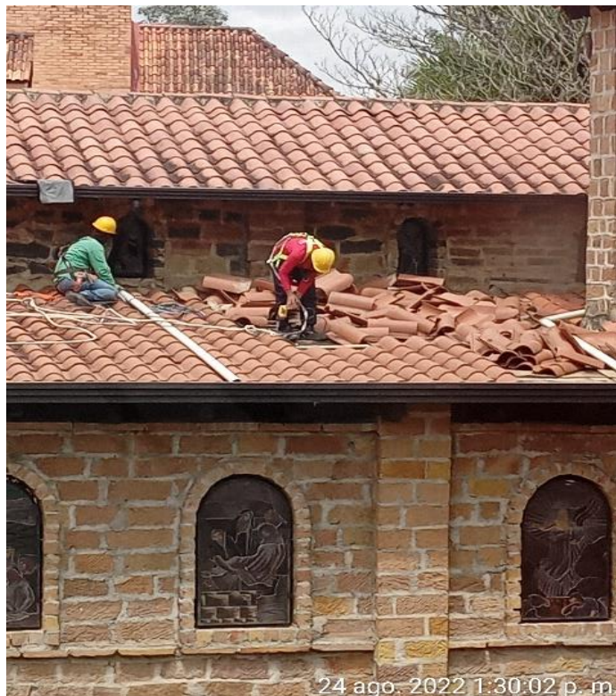
Inicio desmonte teja de barro y desmonte de bajantes de aguas lluvias en la cubierta de la capilla.
