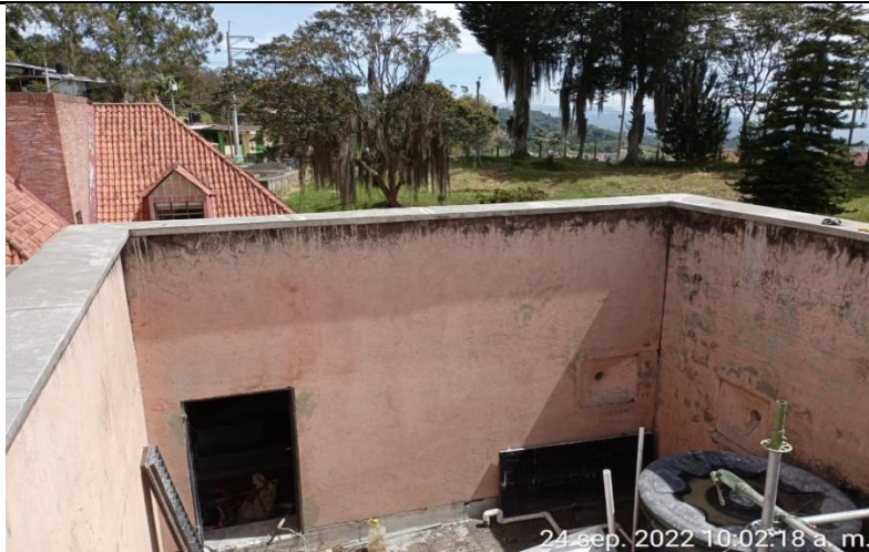
Estado final alfajia con sus dilataciones en el bloque alojamientos B
