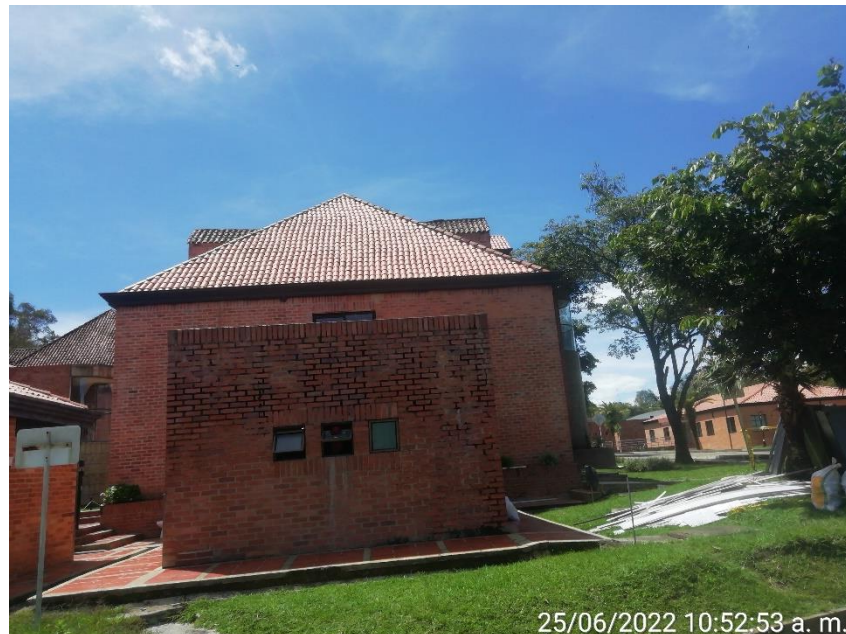
Imagen estado anterior a la intervención en la cubierta del Baño N° 2.
