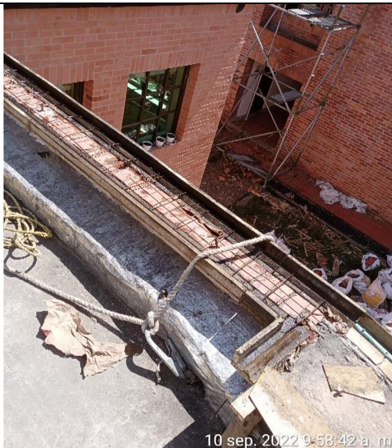
Instalación formaleta con su respectiva malla electrosoldada y anclajes con varilla en alfajía en punto fijo Área académica
