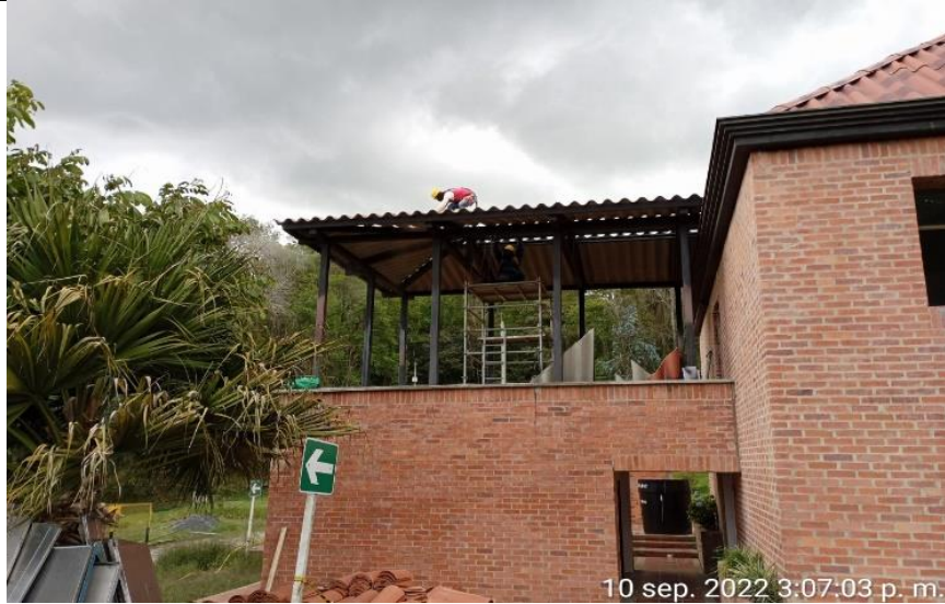
Imagen correspondiente a la instalación de limatesas en la teja española N° 8 en la estructura metalica del baño N° 2.
