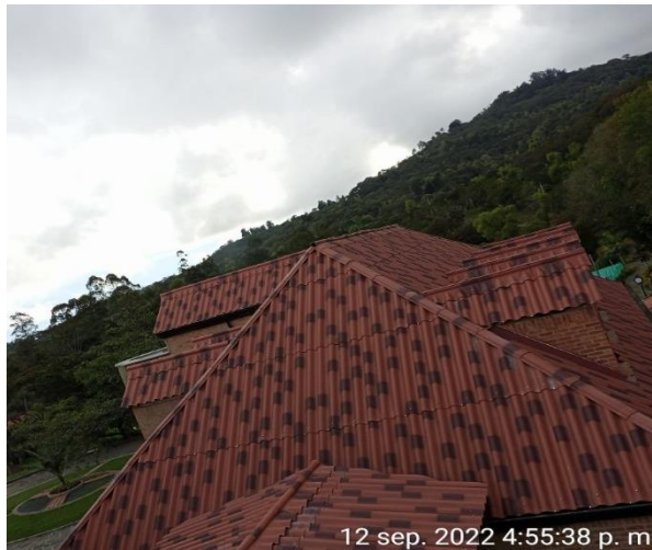
Instalación de limatesas y caballetes en bloque academico N°2 Vive Digital.
