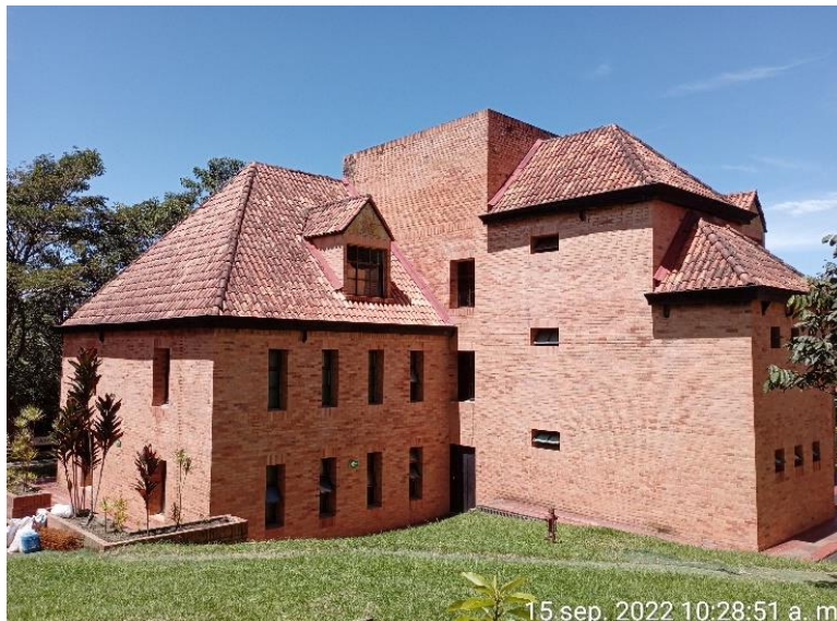
Estado inicial bloque alojamientos B
