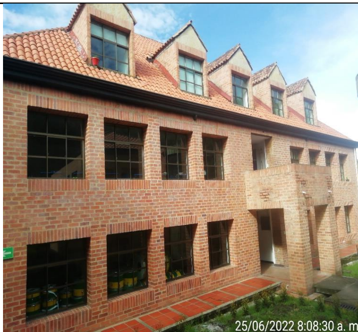
Imagen correspondiente al estado inicial de la cubierta, parte posterior del bloque academico N° 2 Vive Digital.
