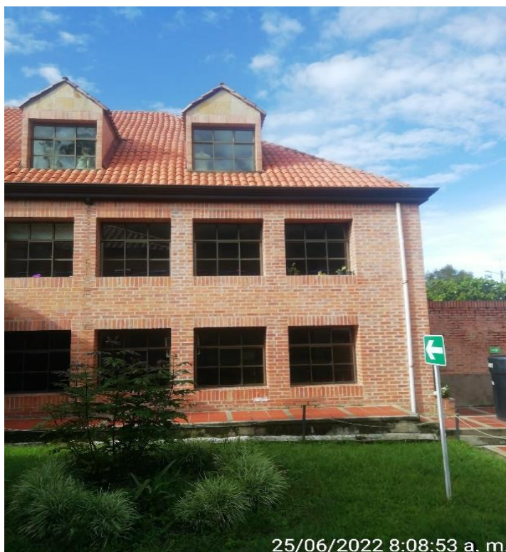
Imagen correspondiente al estado inicial de la cubierta del bloque academico N° 2 Vive Digital.
