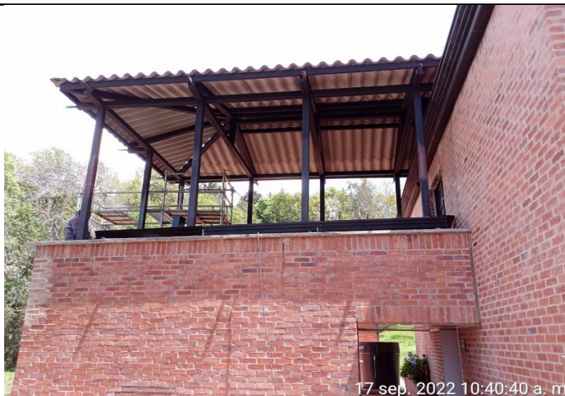
Finalización de la instalación de la canaleta perimetral de la estructura metalica del Baño N° 2.
