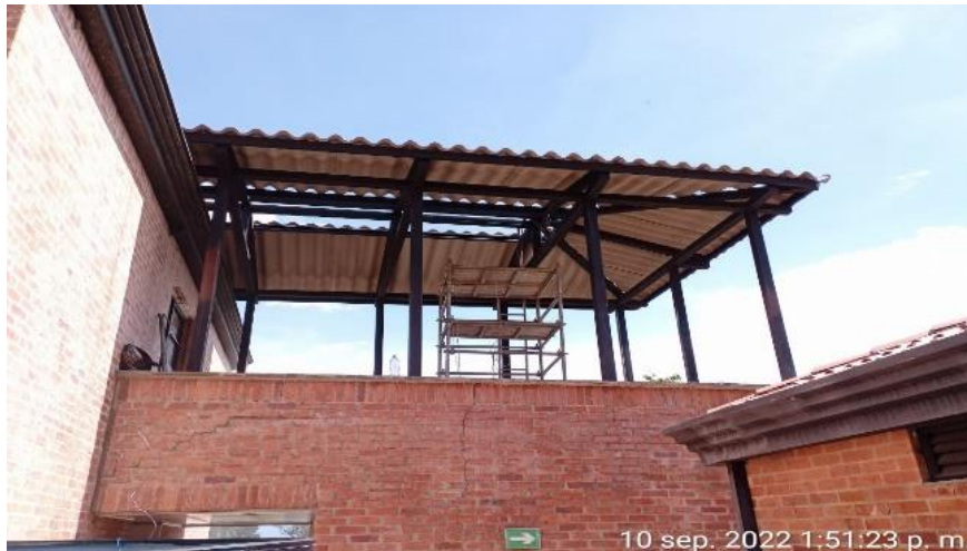
Imagen correspondiente a la instalación de teja española N° 8 en la estructura metálica del baño N° 2.
