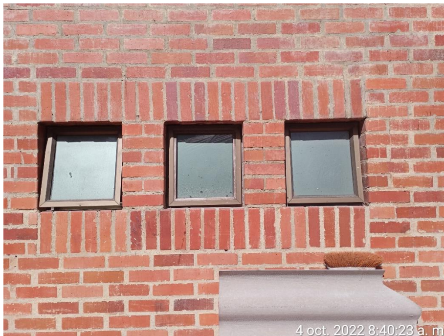
Estado previo de los vidrios esmerilados del baño N° 1
