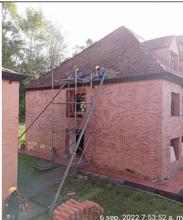
Desmante teja de barro de la cubierta bloque academico N° 1
