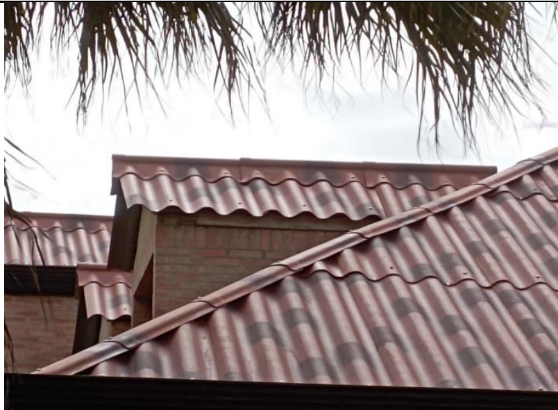
Instalación de caballetes en palomeras bloque academico N°2 Vive Digital.
