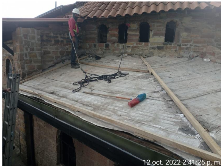
Instalación de listones en madera en la cubierta posterior de la capilla
