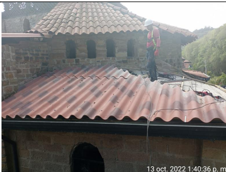
Instalación de teja española tipo barroca N° 8 en la cubierta posterior de la capilla
