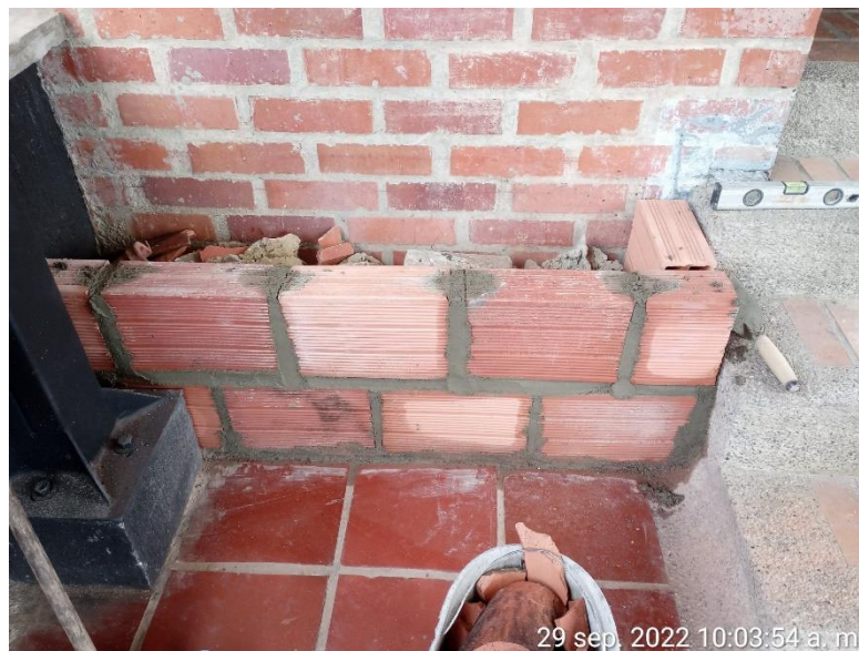
Fundición de silla en la zona de la estructura metalica baño 2
