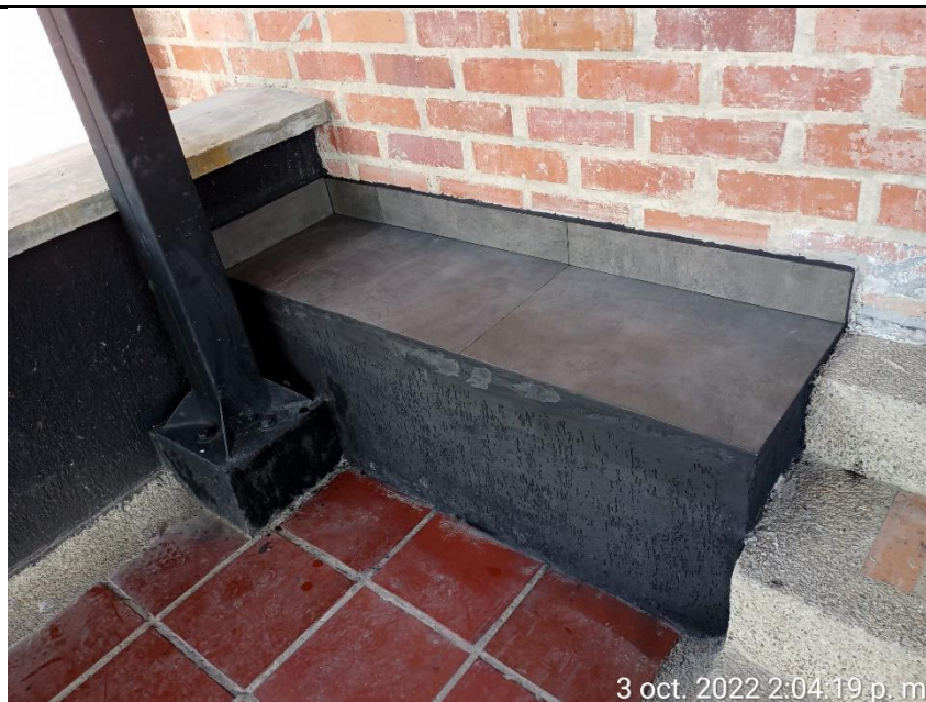
Aplicación boquilla en silla, zona estructura metalica N° 2.
