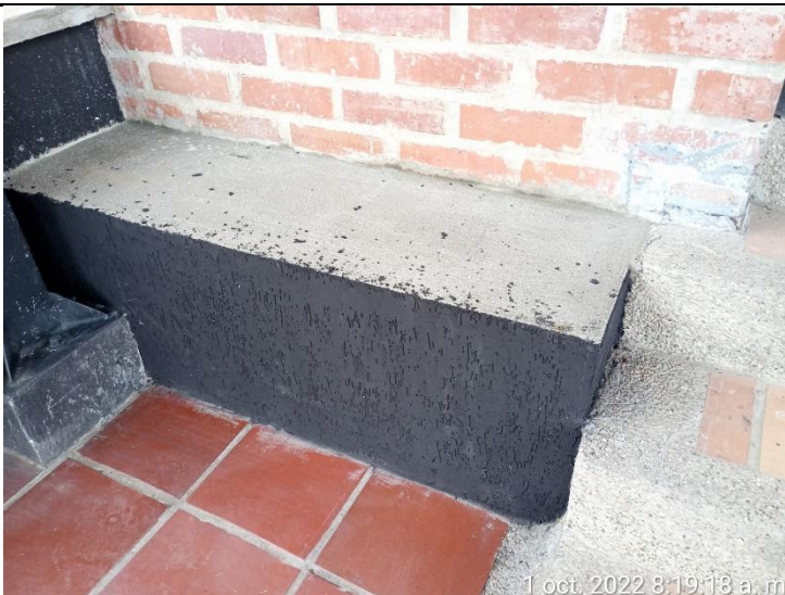
Aplicación de graniplast en silla, zona estructura metalica del baño N° 2.
