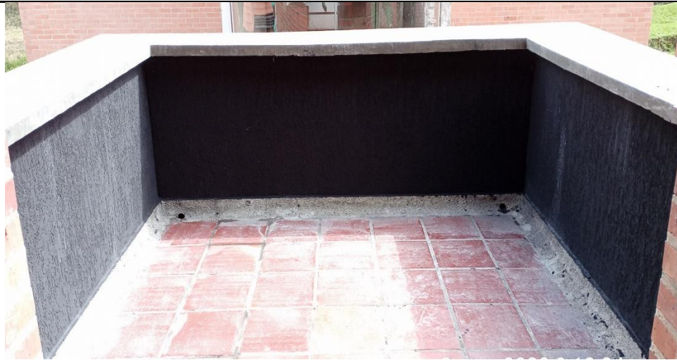
Estado final aplicación graniplast en antepecho balcon bloque academico N° 1
