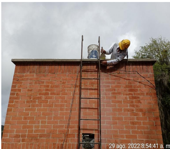
Pulido de alfajias casino de suboficiales, zona tanques de reserva.
