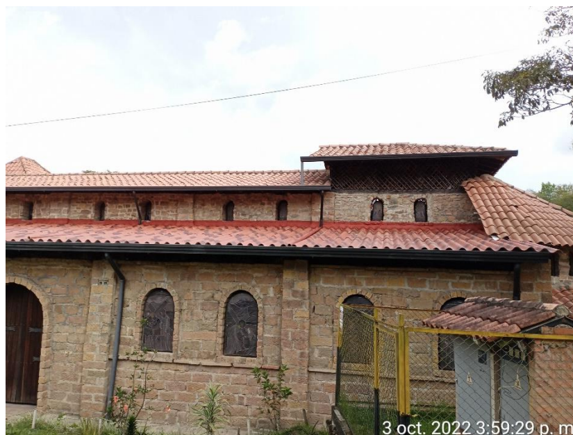
Estado final instalación teja española N° 8, así como de la instalación y pintura de los bajantes en cada una de las alas derecha e izquierda de la capilla.
