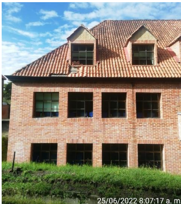
Estado inicial cubierta bloque academico N° 1
