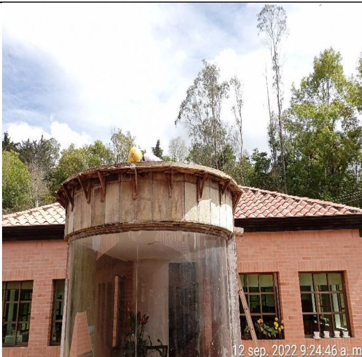
Instalación formaleta en alfajía en punto fijo Área académica
