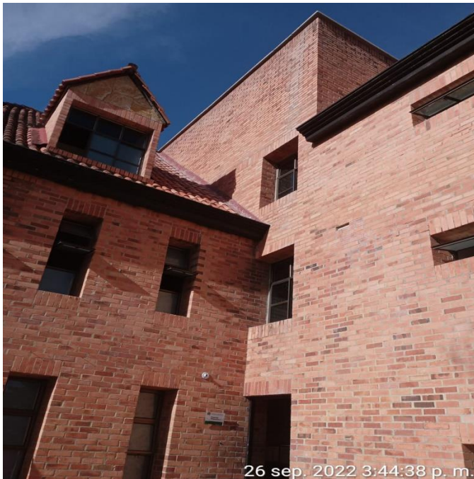
Estado final alfajia en el bloque alojamientos C
