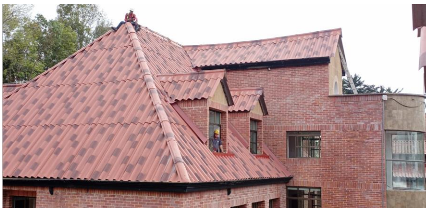
Estado final Instalación teja española N° 8, de caballete principal, caballete en palomeras, flanches en palomeras, alfajias con aplicación de bronco elastico y tela faltica en el bloque academico N° 1
