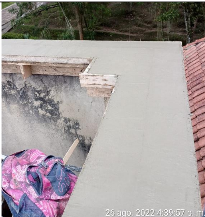
Fundido alfajias zona tanques de reserva en casino de suboficiales.
