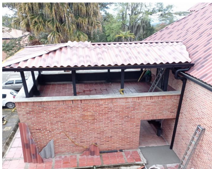
Estado final instalación de bajantes aguas lluvias, fundición de rampa de acceso baño N° 1.
