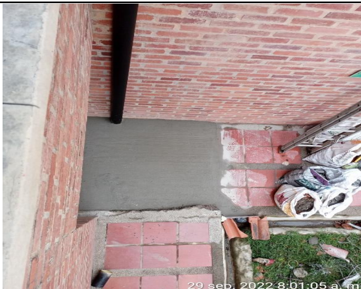
Fundición rampa de acceso baño N° 1.
