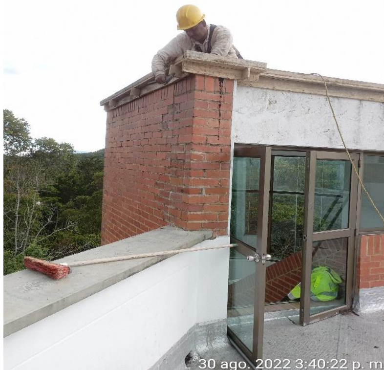
Instalación de formaletas en bloque administrativo, zona de acceso al punto a la terraza.
