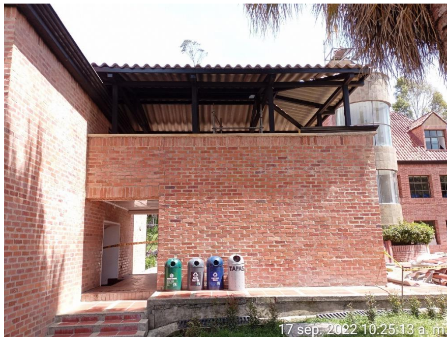
Estado previo estructura metalica N° 1.
