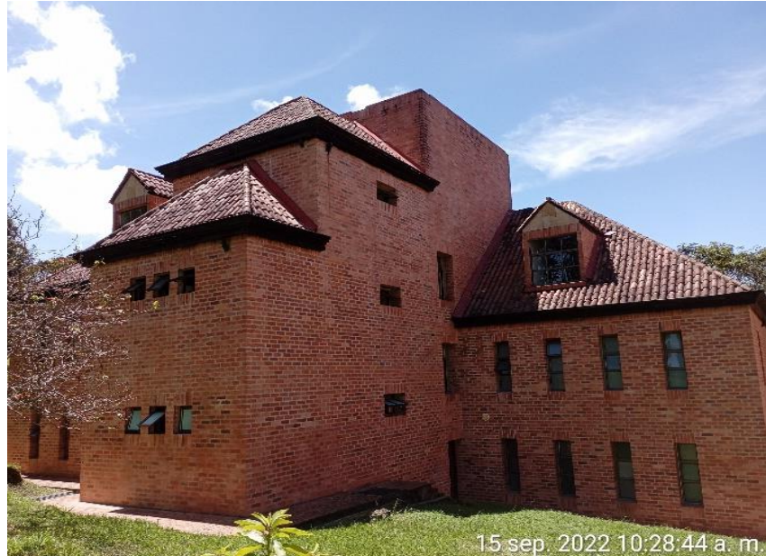
Estado inicial bloque alojamientos A
