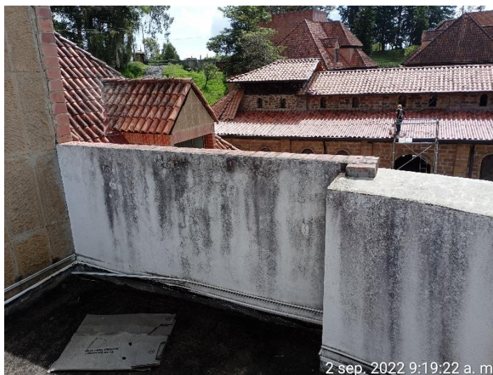
Estado inicial punto fijo bloque academino N°1
