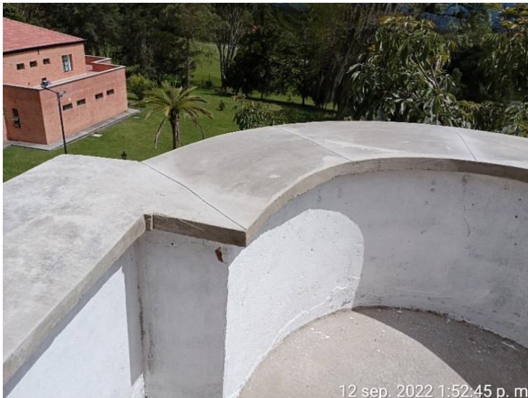
Dilataciones en alfajías y capa de pintura en antepecho, en el punto fijo bloque academino N°2
