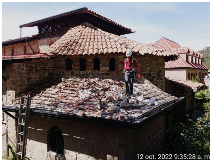
Desmonte listones de madera podridos en la cubierta posterior de la capilla
