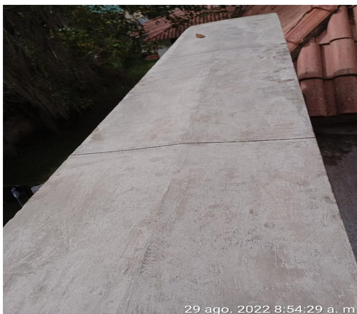
Instalación de alfajias en casino de suboficiales.
