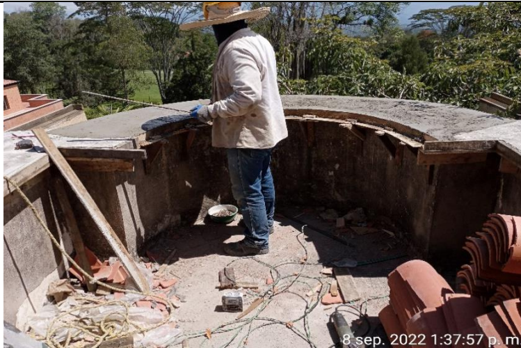
Formaleta y fundición en alfajias en punto fijo bloque academino N°2
