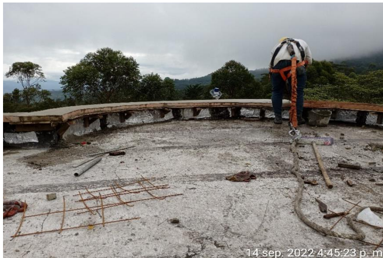
Funidición y formaleta de las alfajias en el punto de acceso de la terraza en el bloque administrativo.
