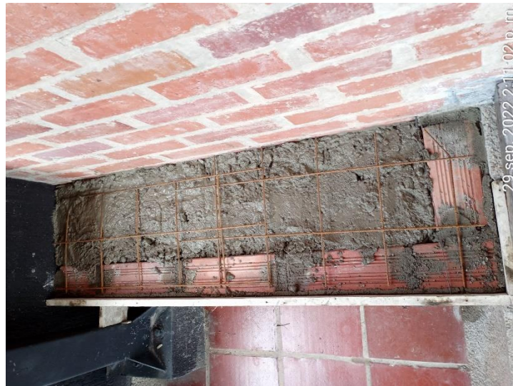
Instalación de malla electrosoldada en silla, zona estructura metalica del baño 2
