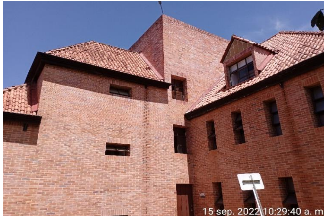
Estado inicial alfajia en el bloque alojamientos C
