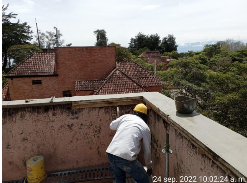
Desenfofrado de formaleta alfajia en el bloque alojamientos B
