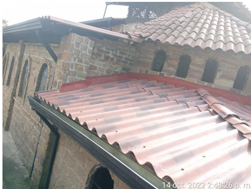
Aplicación de bronco repelente con instalación de tela faltica en la cubierta parte posterior de la capilla.
