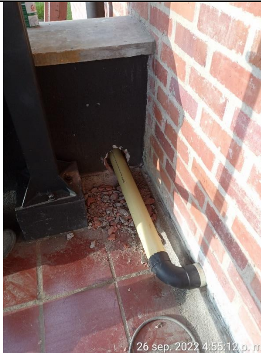
Instalación de tubería pvc aguas lluvias
