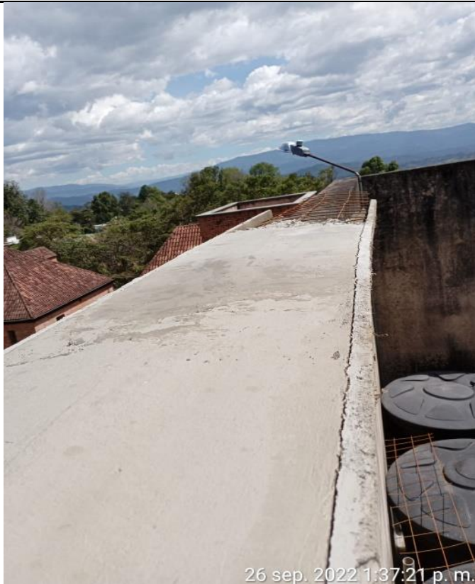
Instalación de formaleta alfajia, con malla electro soldada en el bloque alojamientos C
