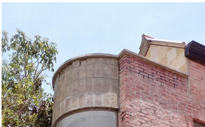
Estado final punto fijo bloque academino N°2
