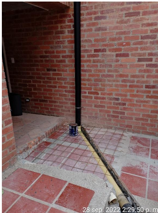
Instalación de bajantes y malla electrosoldada, para fundición rampa acceso baño N° 1
