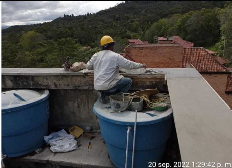
Instalación de formaleta y fundición de alfajias en el bloque alojamientos A
