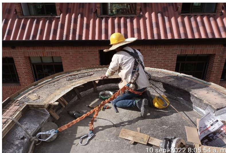
Instalación formaleta en alfajía en punto fijo Área académica
