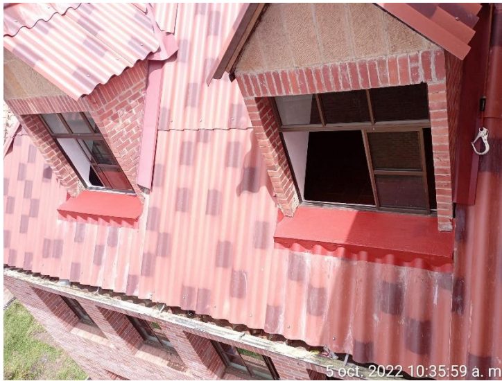
Instalación de alfajias en palomeras con tela faltica y aplicación de bronco elastico.
