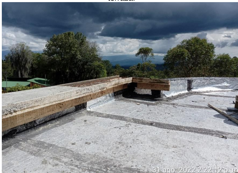
Funidición y formaleta de las alfajias en el punto de acceso de la terraza en el bloque administrativo.
