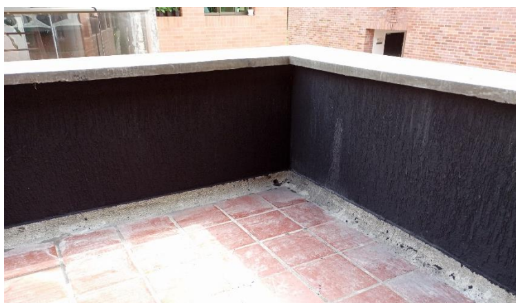
Aplicación graniplast en antepecho del balcon bloque academico N° 1
