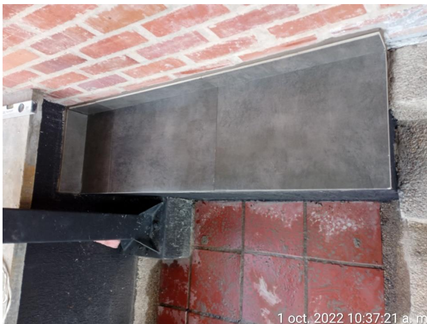
Instalación enchape silla, zona estructura metalica N° 2.
