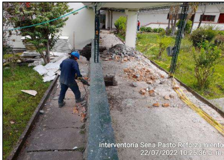
Demolición mecánica para zapatas
