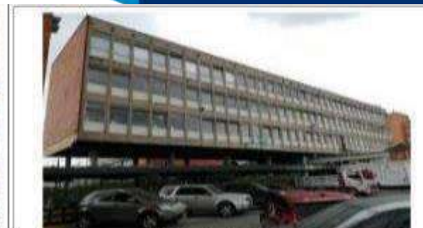
Fotografía 4. Parte de Fachada de la Torre Oriental
