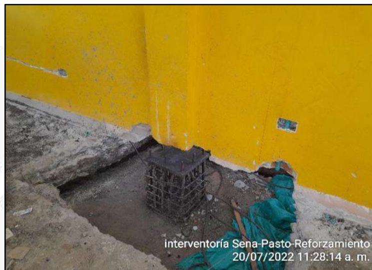
Instalación de pernos para anclaje de platina.
