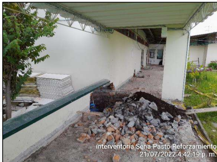
Excavación manual para zapatas
