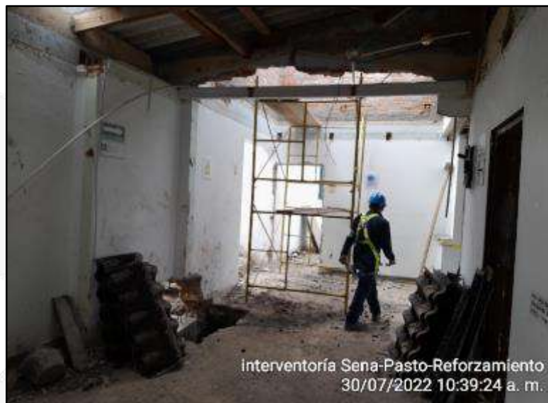
Desmante de cubierta (teja en fibrocemento).
