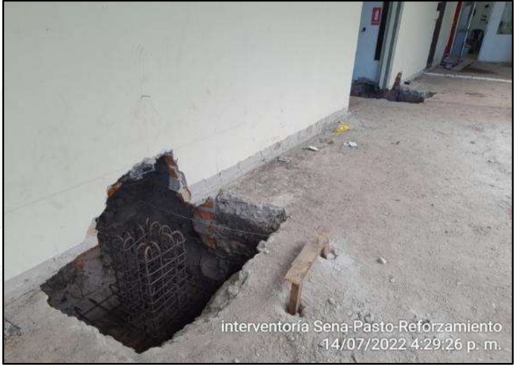
Armado de acero para pedestales..
