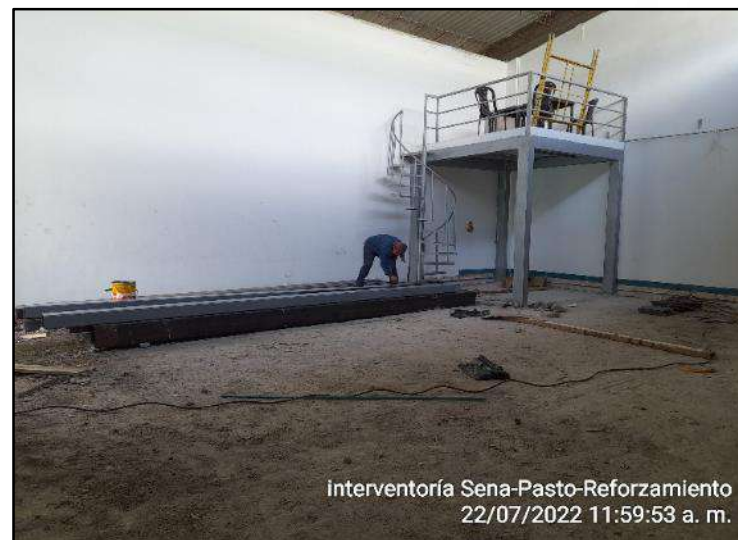
Aplicación de Pintura anticorrosiva.
