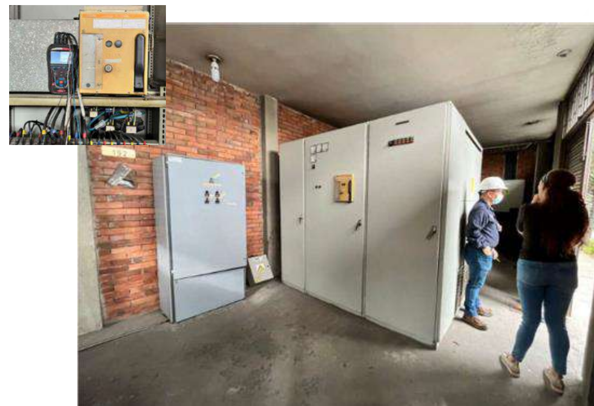
Maniobra de retiro equipo de medición Subestación eléctrica Torre Oriental
