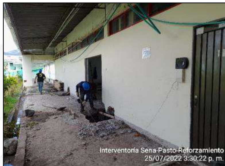
Concreto 3000 psi para zapatas
