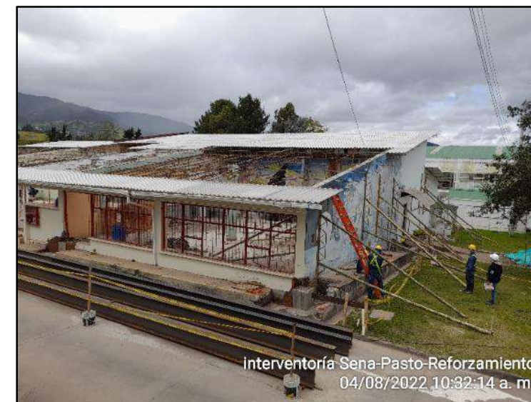
Desmonte de cubierta (teja de fibrocemento)
