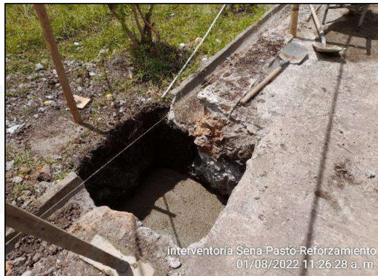
Demolición mecánica para zapatas
