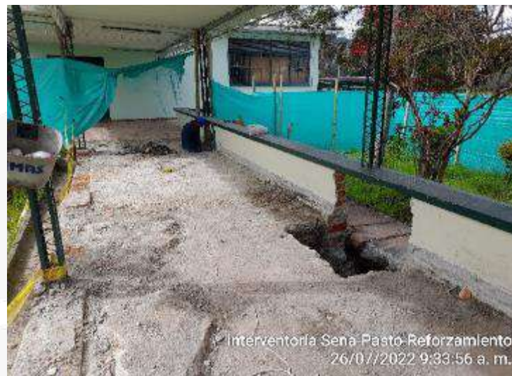
Demolición mecánica para zapatas
