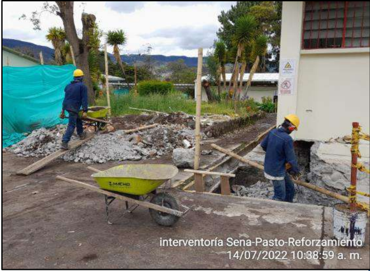
Demolición mecánica de concreto existente.
