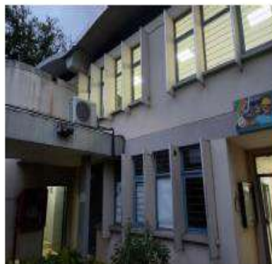
Ilustración 16 | Registro fotográfico - Vigas de cubierta Bloque 01 - Fuente: Propia
