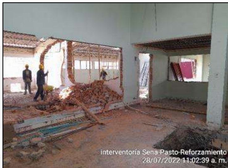
Demolición de muros internos
