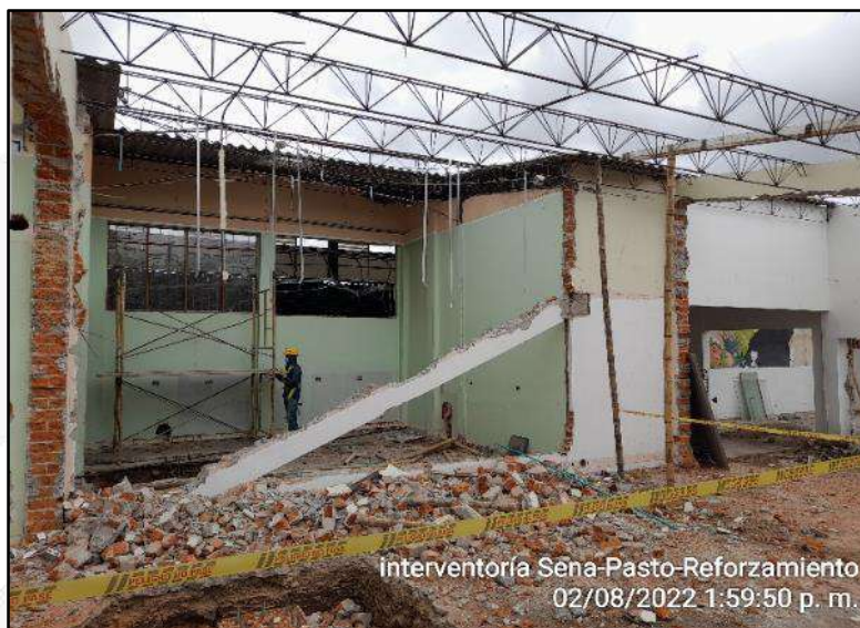
Demolición de muros internos
