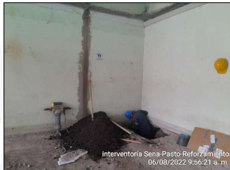
Excavación manual para zapatas
