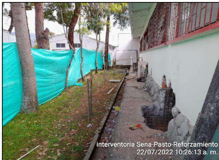
Solado de limpieza e instalación de acero para zapata y pedestal
