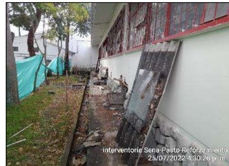
Concreto 3000 psi para zapatas
