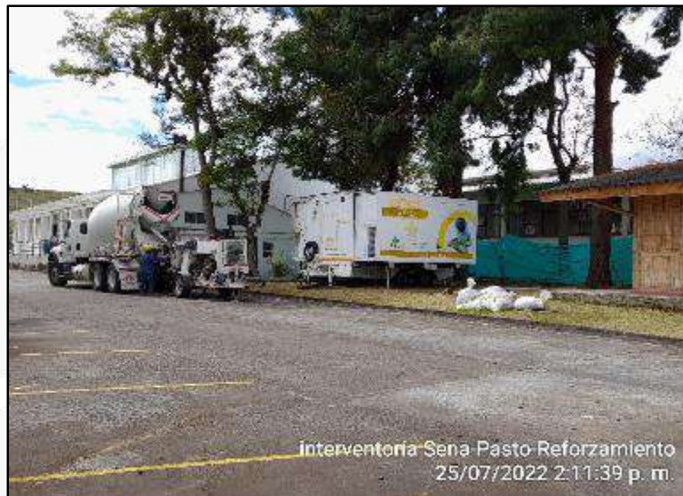
Concreto 3000 psi para zapatas
