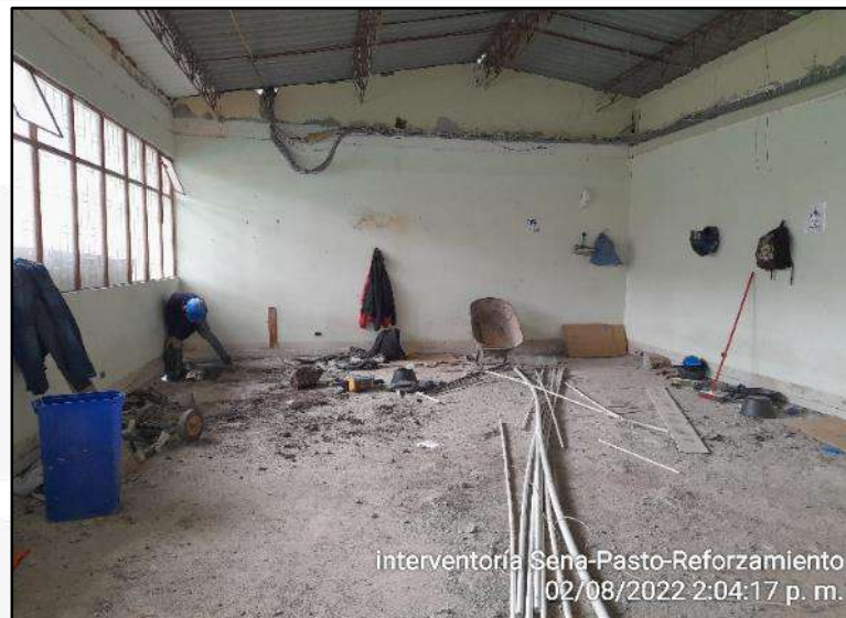
Demolición mecánica para zapatas
