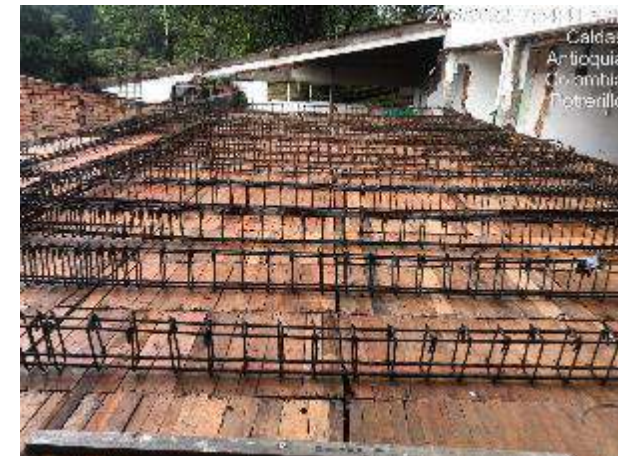
Actividades de desmontes, demoliciones. – Figurado y armado de acero de refuerzo para vigas zarpas. – Armado de aceros losa de entrepiso
