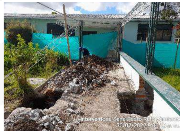
Excavación manual para zapatas
