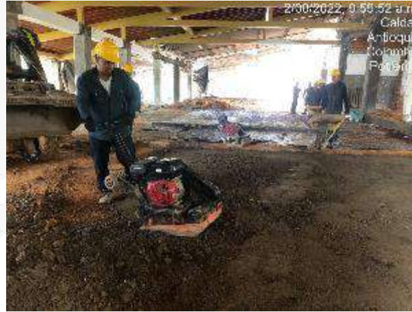
Acopios de materiales – Realización de llenos compactados y nivelación sector biblioteca, cocina y comedor edificio central
