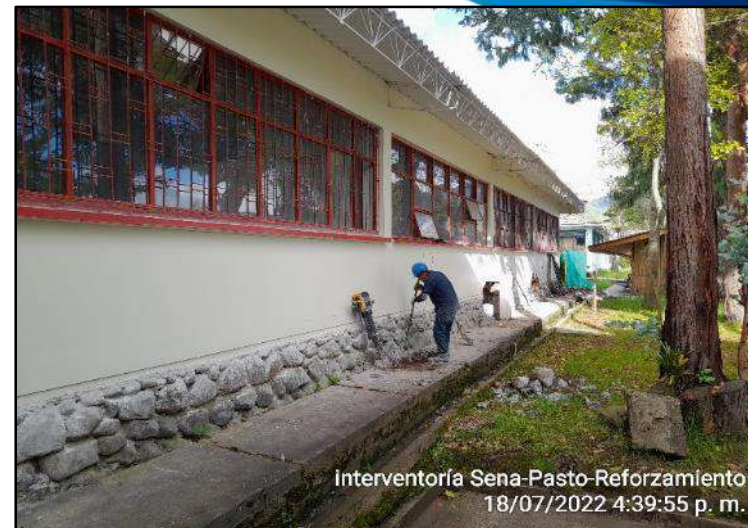
Demolición mecánica para zapatas
