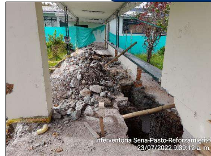
Demolición mecánica para zapatas
