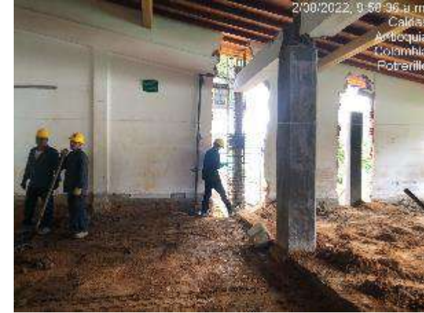
Acopios de materiales – Realización de llenos compactados y nivelación sector biblioteca, cocina y comedor edificio central
