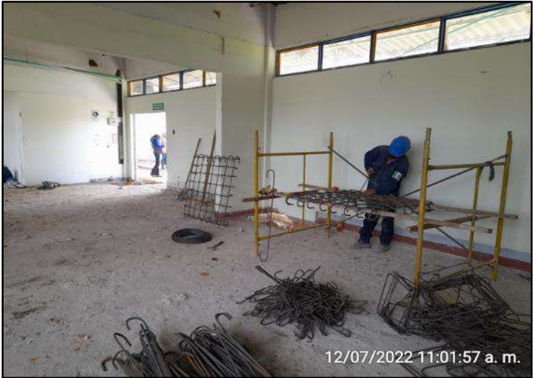
Armado de acero para pedestales..
