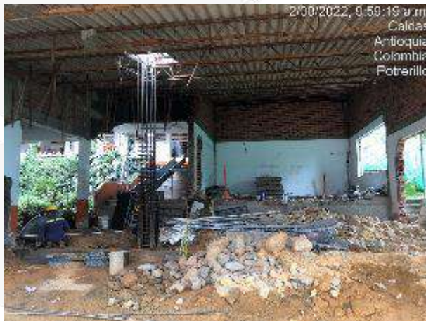
Actividades de desmontes, demoliciones. – Figurado y armado de acero de refuerzo para vigas zarpas. – Armado de aceros losa de entrepiso
