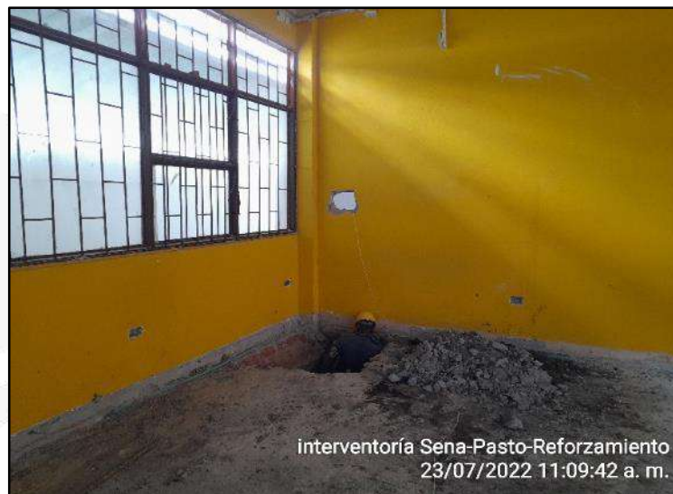
Demolición mecánica de concreto existente.
