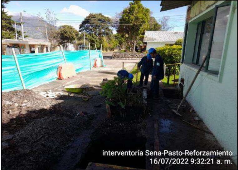
Excavación para zapatas
