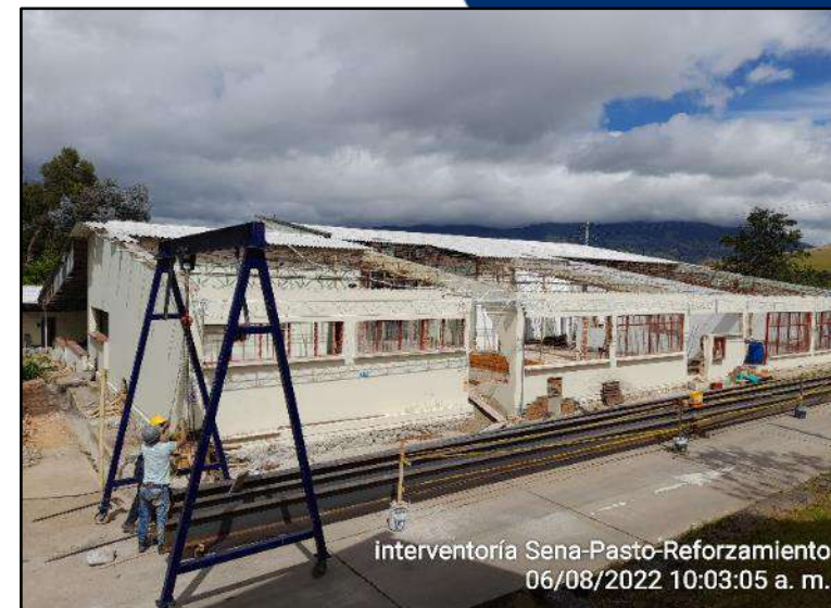
Demolicion manual muros divisorios.
