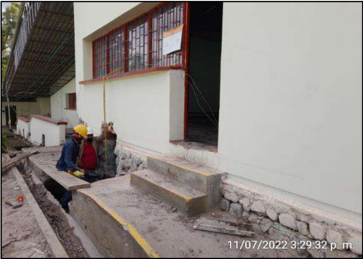
Demolición mecánica de concreto existente..
