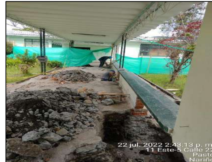
Excavación manual para zapatas
