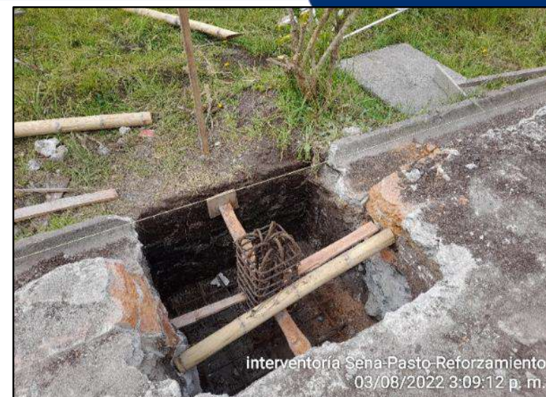
Armado acero para zapata y pedestal.
