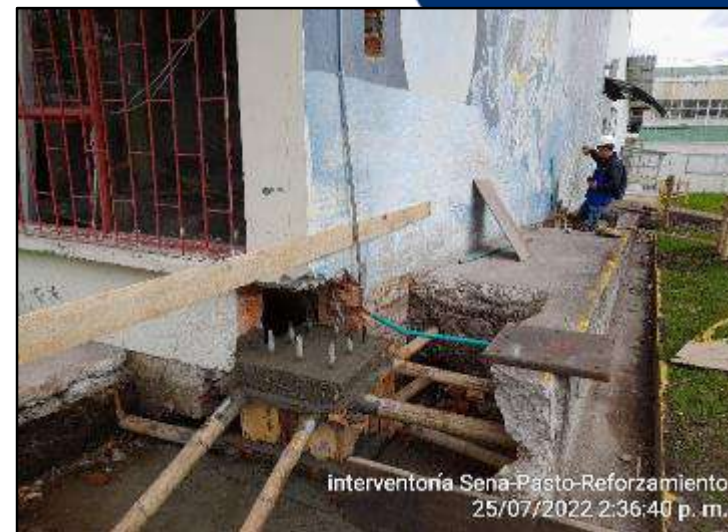
Concreto 3000 psi para pedestales
