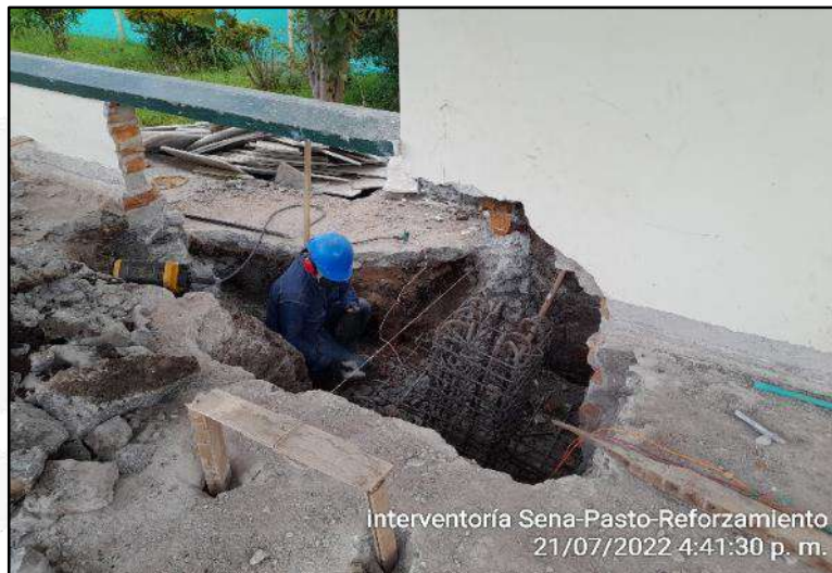
Armado de acero para pedestales..
