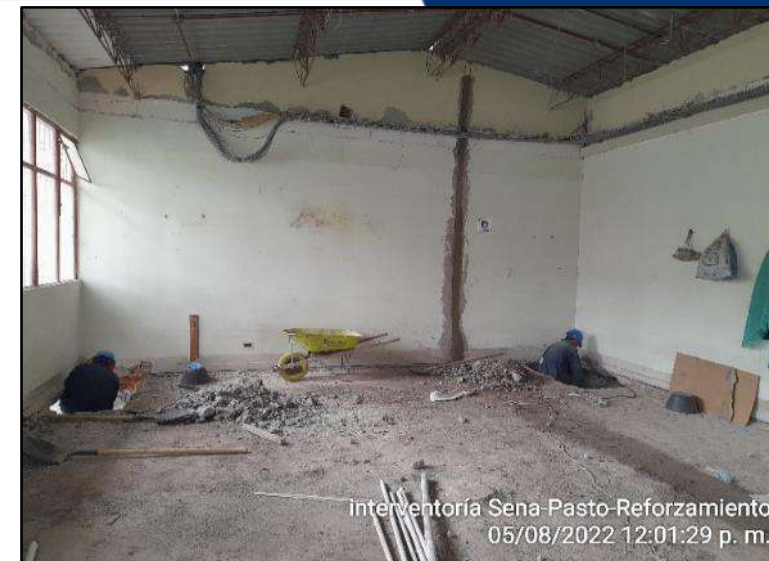
Demolición mecánica para zapatas
