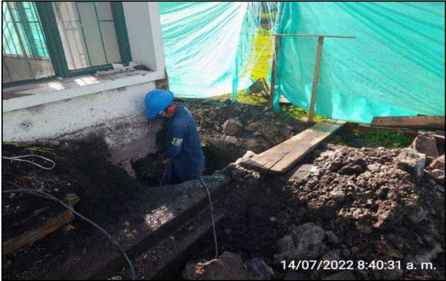
Demolición mecánica de concreto en zapatas.
