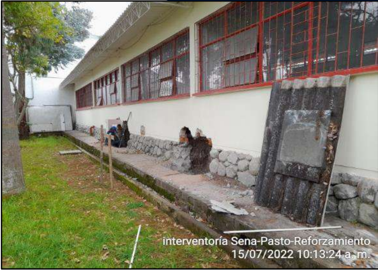
Demolición mecánica para zapatas
