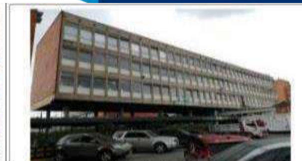
Fotografía 4. Parte de Fachada de la Torre Oriental
