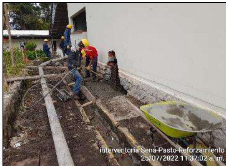
Concreto 3000 psi para zapatas
