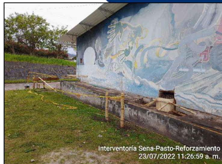
Instalación de pernos para anclaje de platina.
