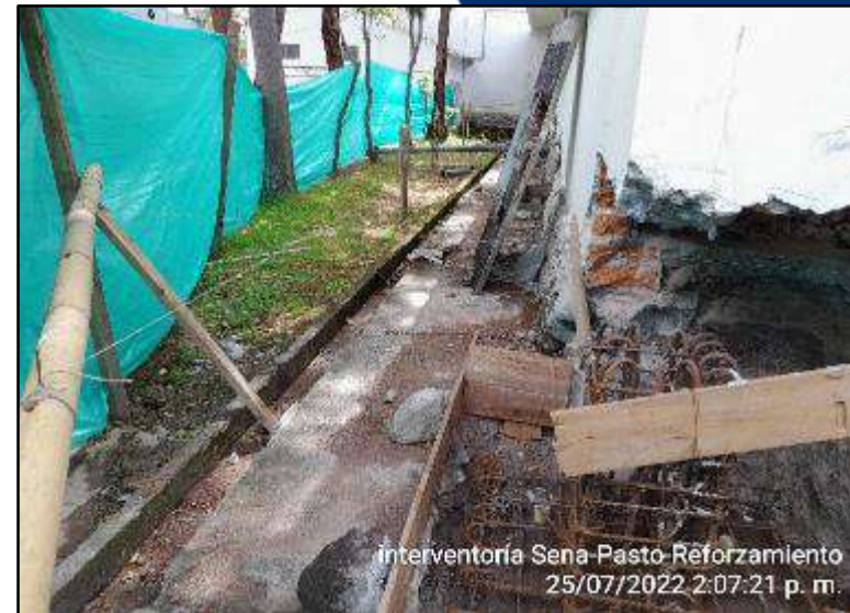
Armado de refuerzo para zapatas
