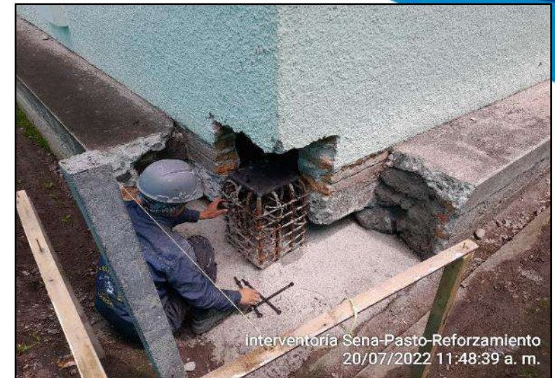
Instalación de pernos para anclaje de platina..
