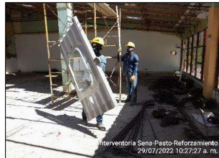
Desmonte de cubierta (teja de fibrocemento)
