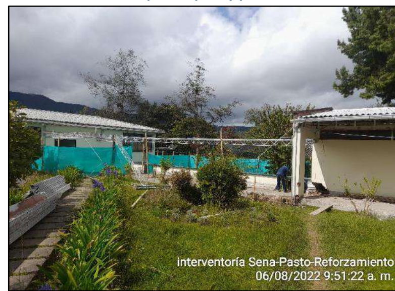
Desmonte de cubierta (canaleta fibrocemento).
