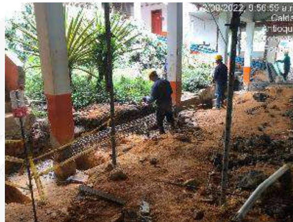
Actividades de desmontes, demoliciones. – Figurado y armado de acero de refuerzo para vigas zarpas. – Armado de aceros losa de entrepiso
