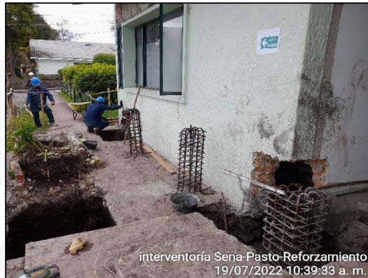
Instalación de acero para zapatas y pedestales.
