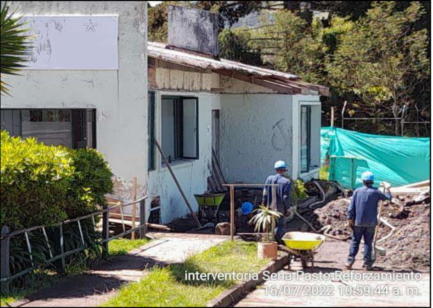
Solado de limpieza para zapatas
