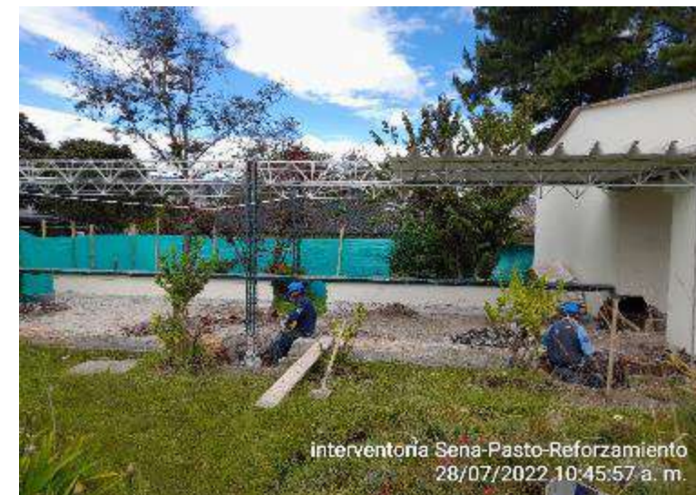
Demolición mecánica para zapatas
