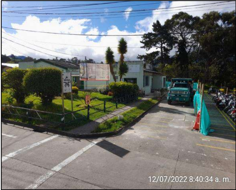
Desalojo de escombros.
