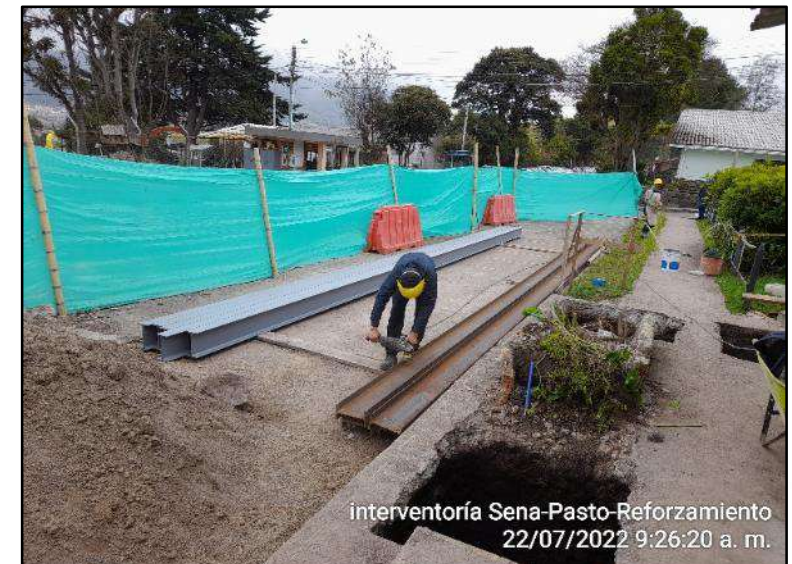
Aplicación de Pintura anticorrosiva.
