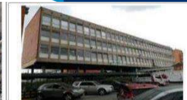
Fotografía 4. Parte de Fachada de la Torre Oriental
