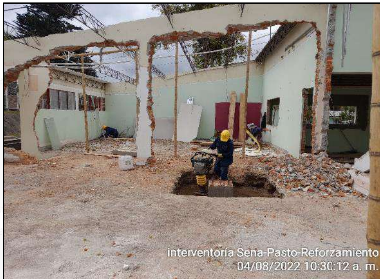
Compactación mecánica para llenos en cimentación.
