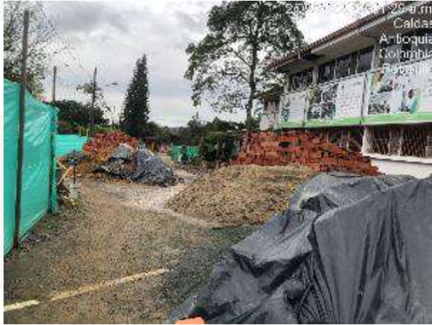
Acopios de materiales – Realización de llenos compactados y nivelación sector biblioteca, cocina y comedor edificio central
