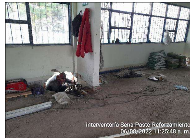
Instalación de pernos para platinas
