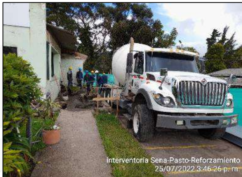
Concreto 3000 psi para zapatas
