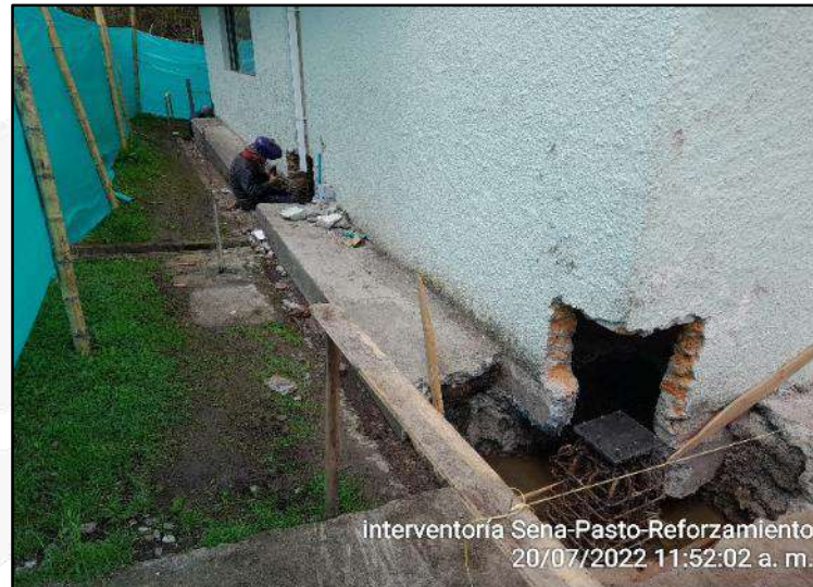
Instalación de pernos para anclaje de platina.
