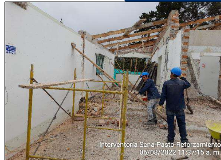
Demolicion manual muros divisorios.
