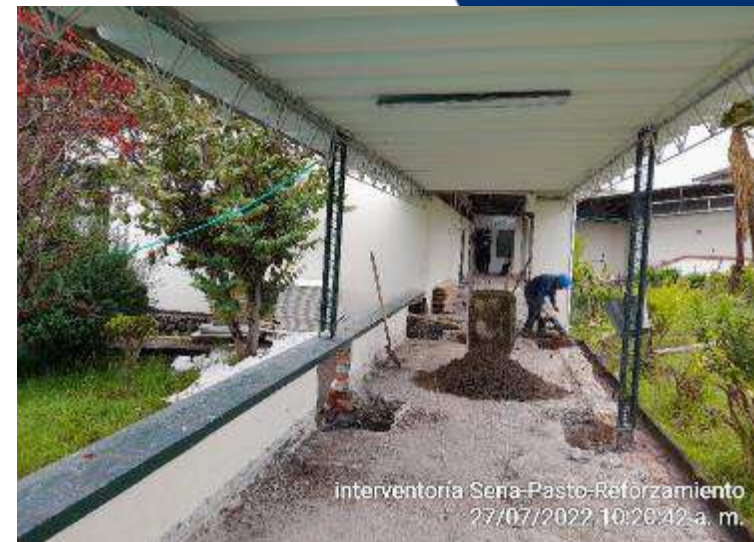
Demolición mecánica para zapatas
