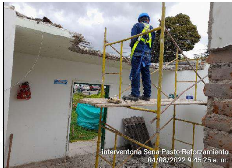
Demolicion manual losa de entrepiso.
