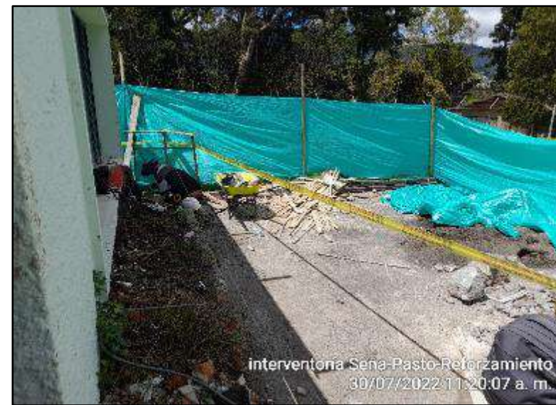
Instalación de pernos para anclaje de platina
