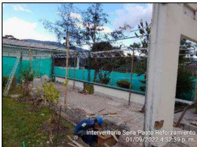
Suministro, fabricación y montaje de estructura autoportante (Pernos)
