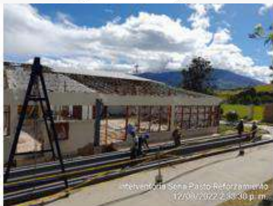
Soldadura de elementos para estructura metálica de cubierta.
