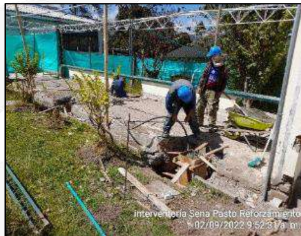
Suministro, concreto premezclado para pedestales (dados)
