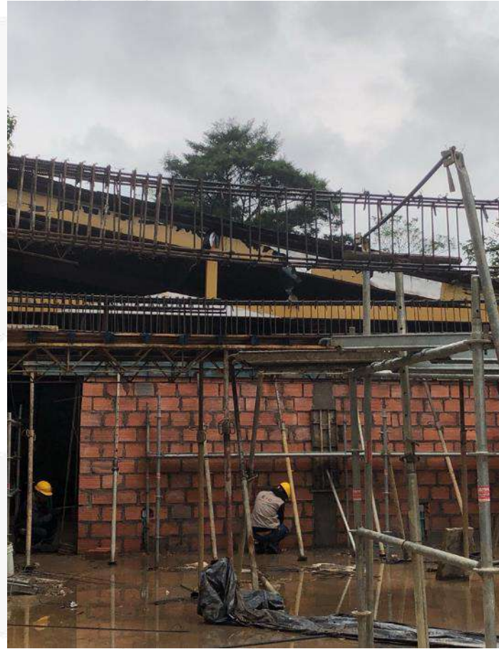
Elementos estructurales verticales, placas y mampostería edificio 16.
