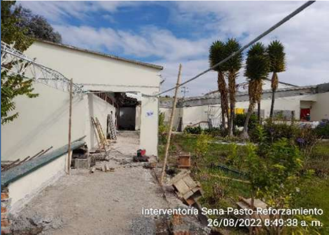
Suministro, fabricación y montaje de estructura autoportante (Platinas)
