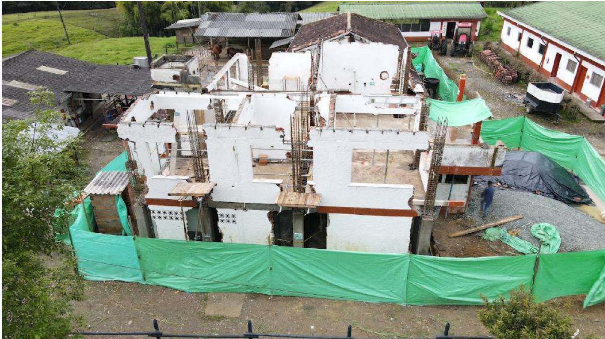
Vista aérea intervención de reforzamiento estructural edificio 66.1 y 66.2
