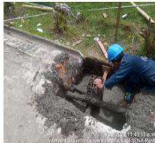
Concreto premezclado para pedestales
