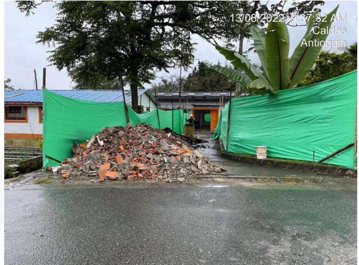
Estado general edificio 42.
