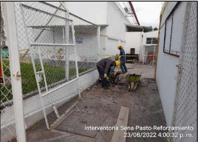
Demolición mecánica y excavación manual, para zapatas.
