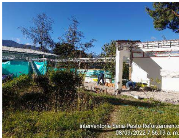
Relleno manual con recebo B-200. Incluye extendido Relleno manual con recebo B-200. Incluye extendido
