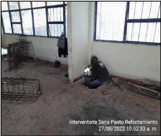
Suministro, fabricación y montaje de estructura autoportante (Platins)
