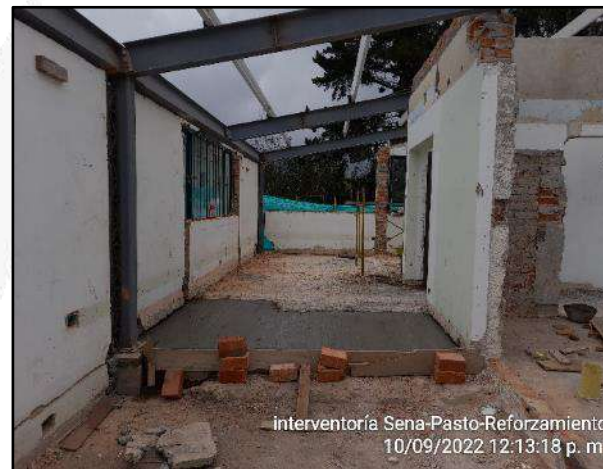
Concreto 3000 psi para losa de contrapiso.
