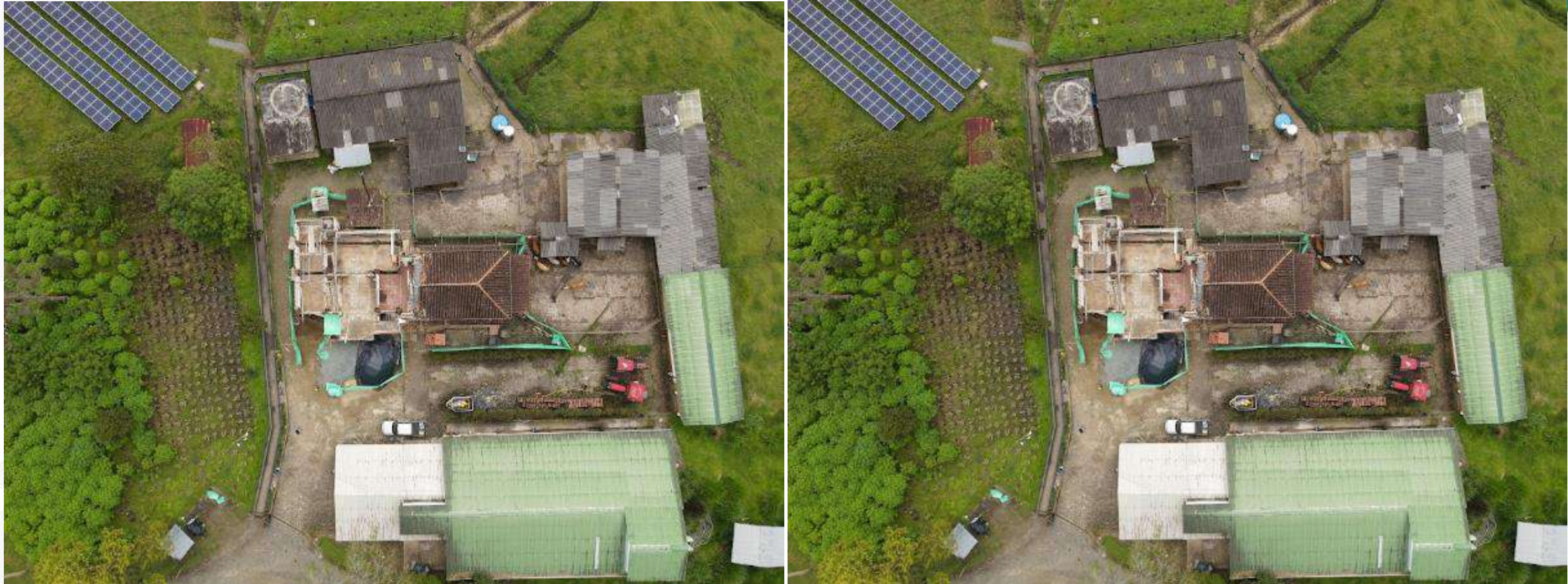
Vista aérea intervención de reforzamiento estructural edificio 66.1 y 66.2
