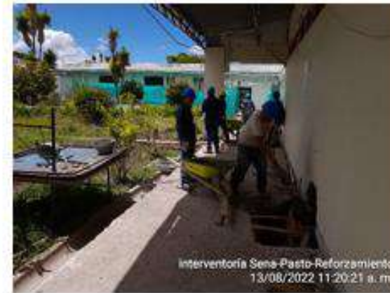
Concreto premezclado para pedestales
