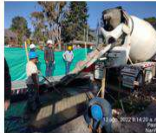
Concreto premezclado para pedestales
