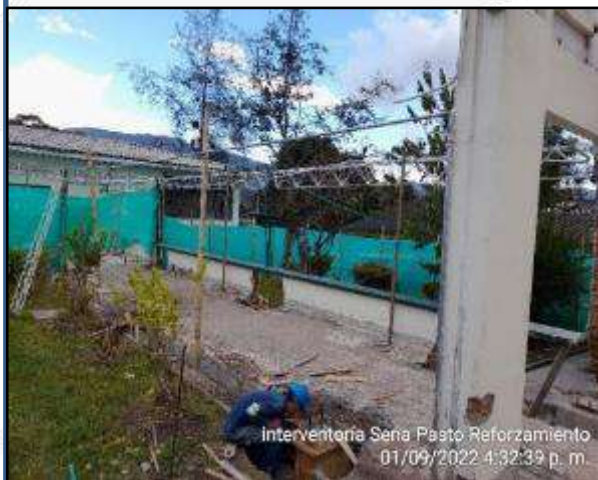
Suministro, fabricación y montaje de estructura autoportante (Pernos)
