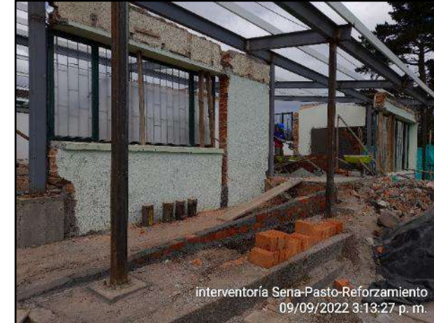
Montaje de estructura metálica para cubierta(vigas auxiliares IPE y correas PHR)
