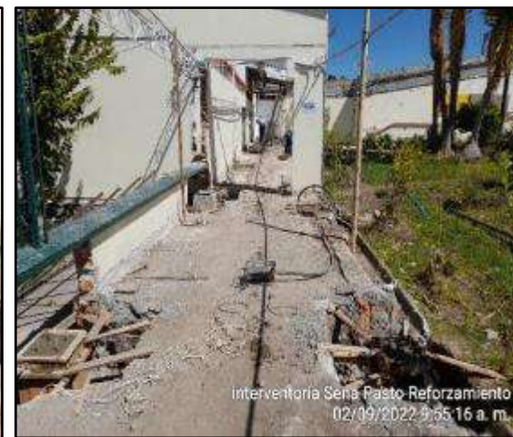
Suministro, concreto premezclado para pedestales (dados)
