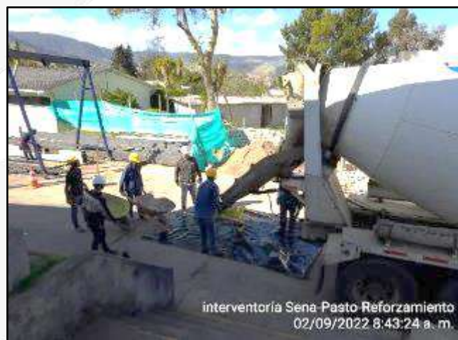
Suministro concreto premezclado para zapatas, pedestales y losa contrapiso.
