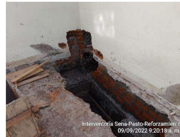
Relleno manual con recebo B-200.(elementos de confinamiento)
