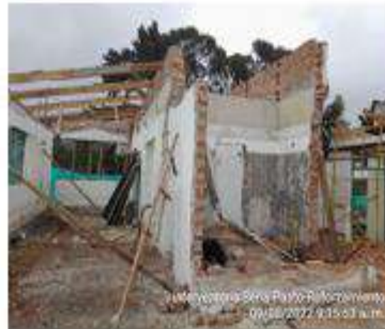
Demolición manual muros divisorios.
