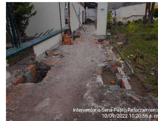
Relleno manual con recebo B-200. Incluye extendido
