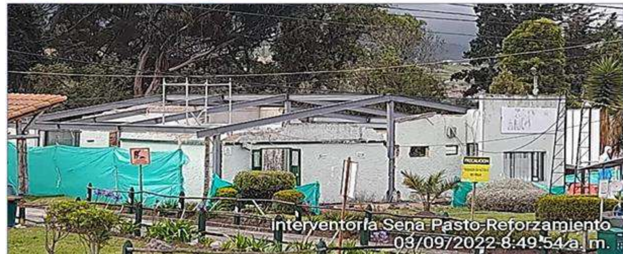
Estado de avance físico en el bloque a la fecha.
