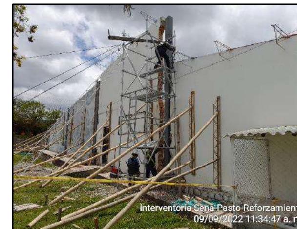
Montaje de estructura metálica para cubierta(columnas).
