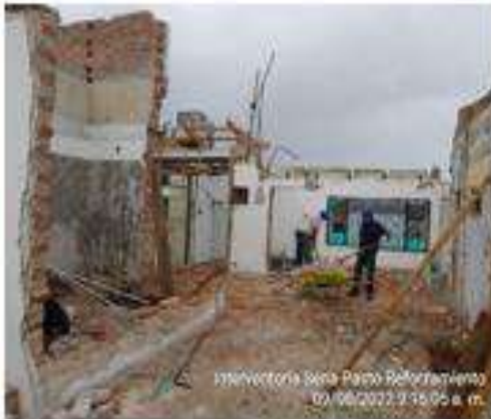
Demolición manual muros divisorios.
