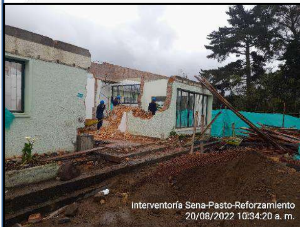
Demolición manual muros divisorios.
