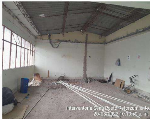
Demolición mecánica para zapatas
