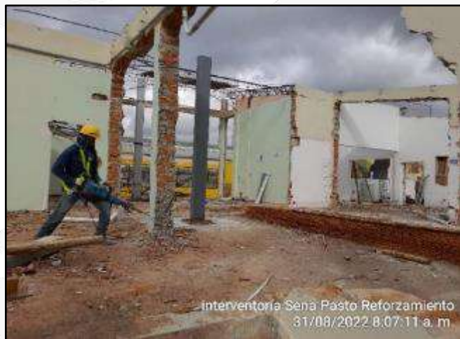
Demolición mecánica y excavación manual, para zapatas.
