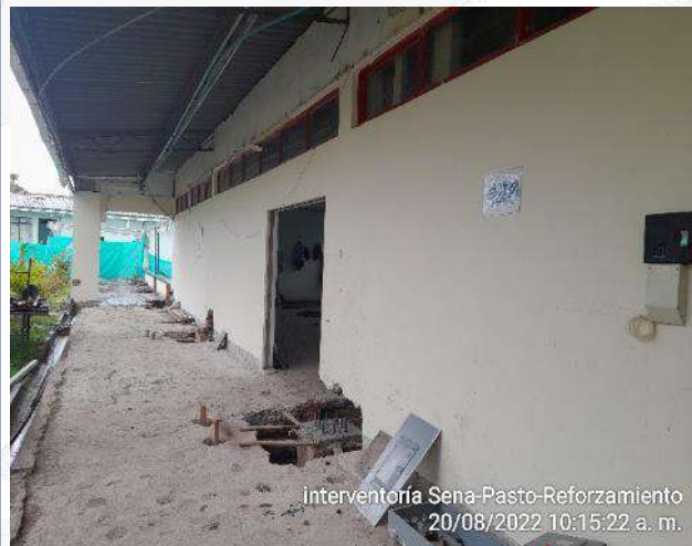
Limpieza de pernos para instalación de platinas.
