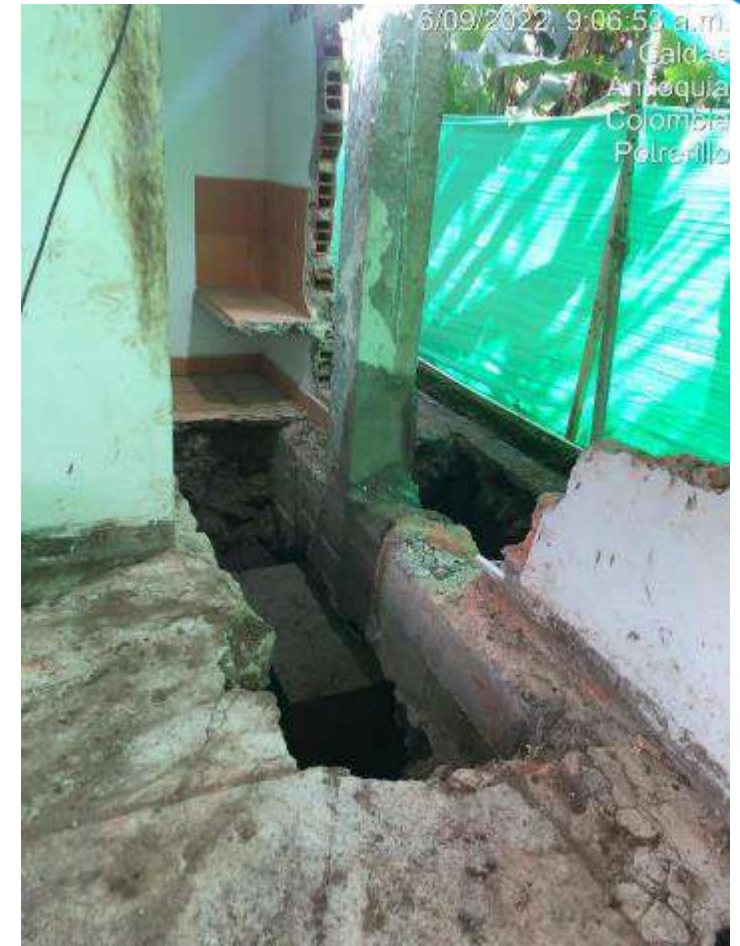
Vista general intervención de reforzamiento estructural edificio 42.
