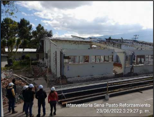
Desmante manual de tejas de fibrocemento de cubierta y correas.
