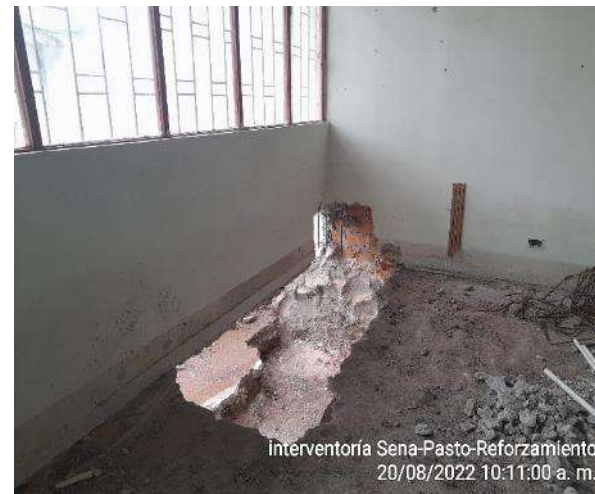
Demolición mecánica para zapatas
