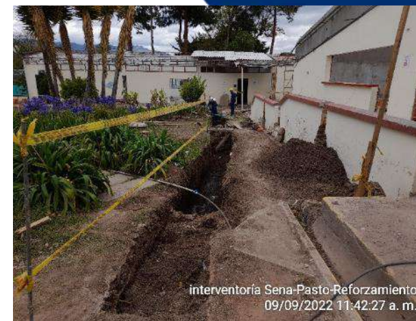
Excavación para Suministro e Instalación de Sistema puesta a Tierra,
