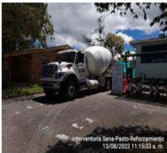
Concreto premezclado para pedestales
