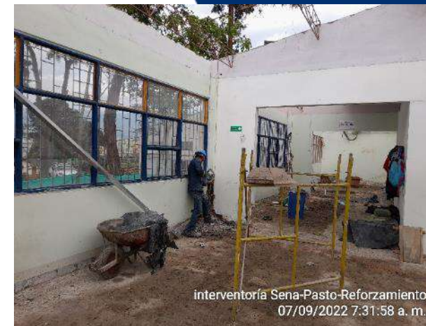
Demolición mecánica de concreto (columnas)
