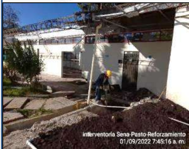
Suministro, fabricación y montaje de estructura autoportante (Pernos)
