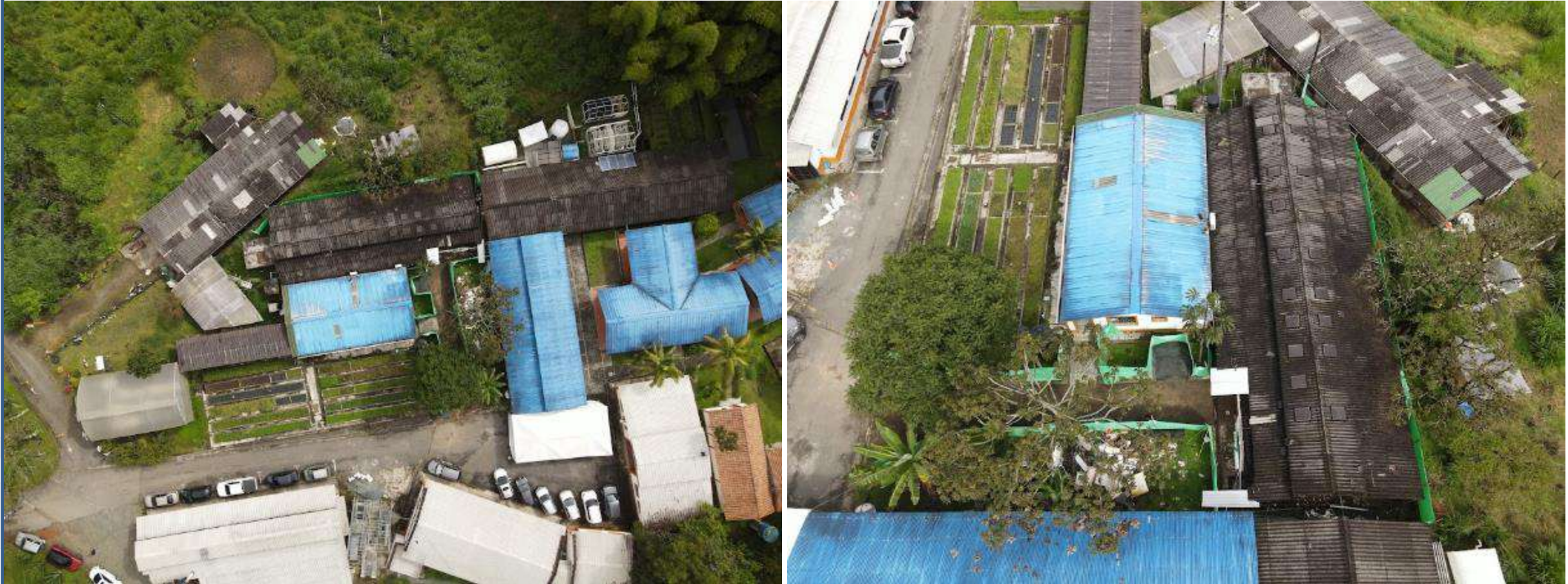
Vista general intervención de reforzamiento estructural edificio 42.
