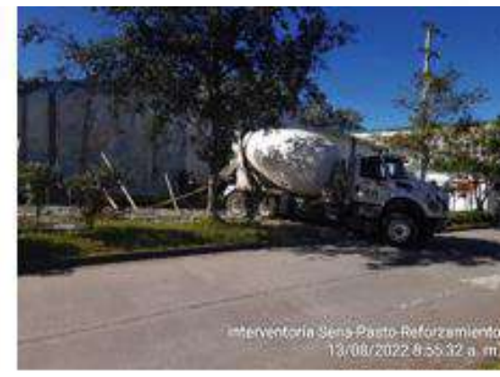
Concreto premezclado para pedestales
