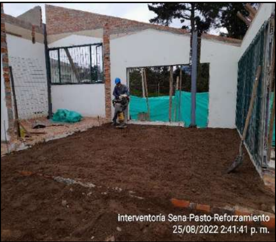
Nivelación con recebo y compactación mecánica.
