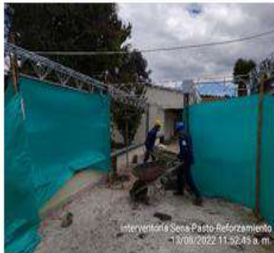
Concreto premezclado para pedestales
