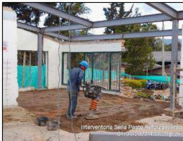
Nivelación con recebo y compactación mecánica..
