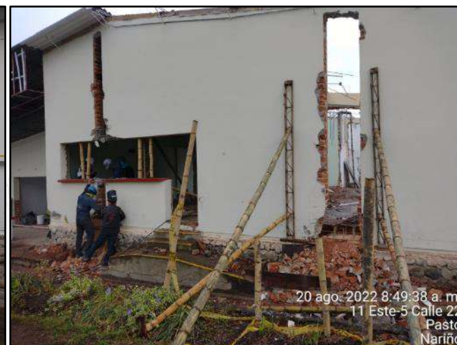
Instalación de platinas sobre pedestal
