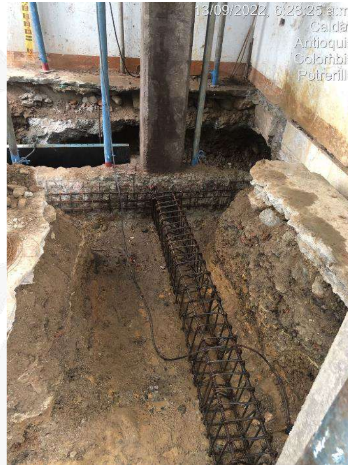
Vista general de la intervención de reforzamiento estructural edificio 66.1 y 66.2
