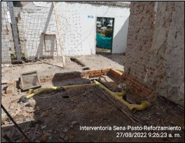
Demolición manual muros divisorios.
