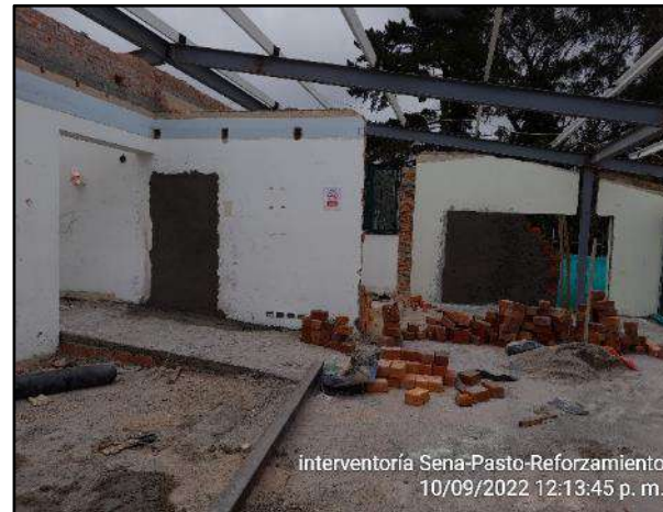
Mortero 1.3 para pañete en muros.
