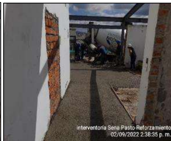
Concreto 3000 psi para losa de contrapiso
