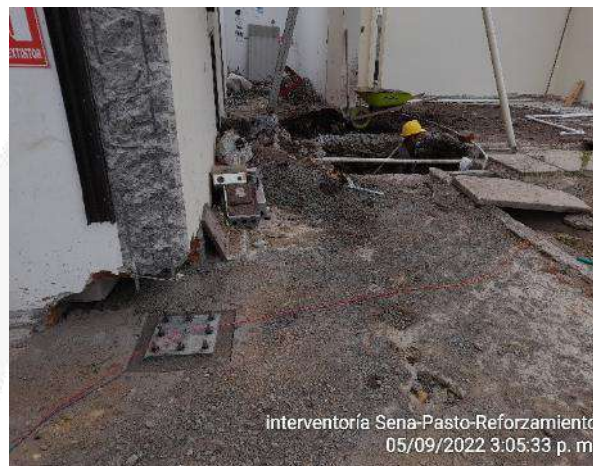
Elaboración de mortero de nivelación (Concrelisto). instalación de platinas
