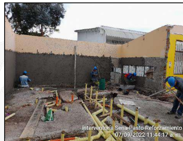
Mortero 1.3 para pañete en muros.
