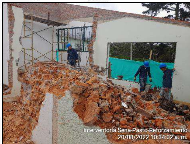
Demolición manual muros divisorios.
