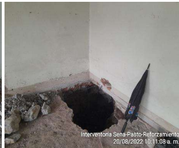
Excavación manual para zapatas.
