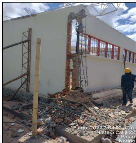
Demolición mecánica muro de fachada
