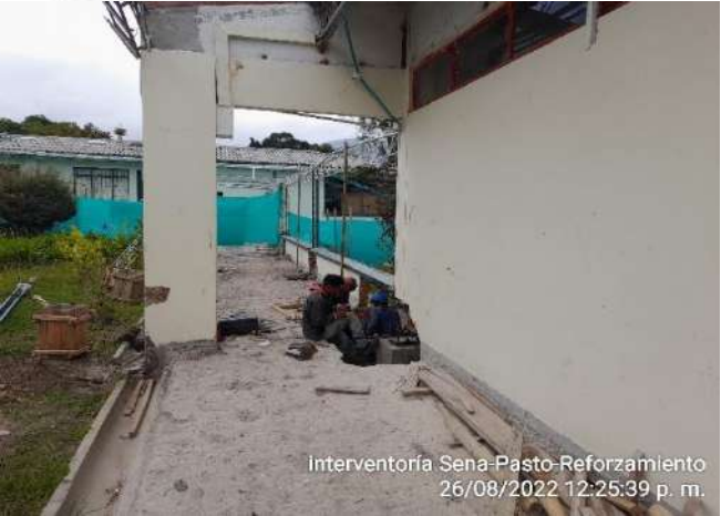
Suministro, fabricación y montaje de estructura autoportante (Pernos)
