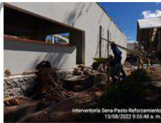
Concreto premezclado para pedestales
