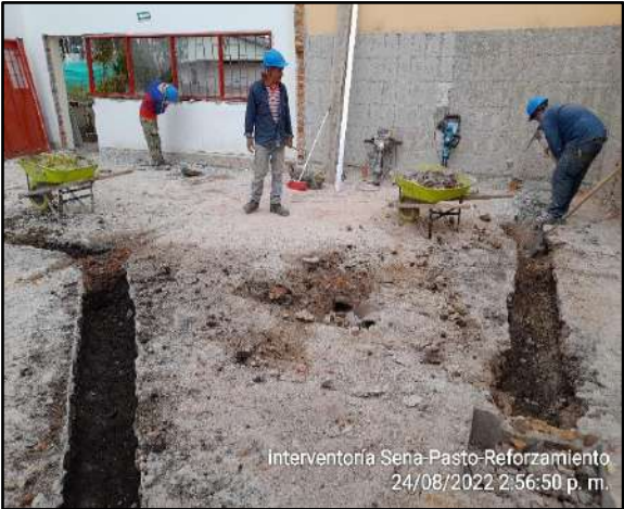
Excavación manual para red sanitaria.
