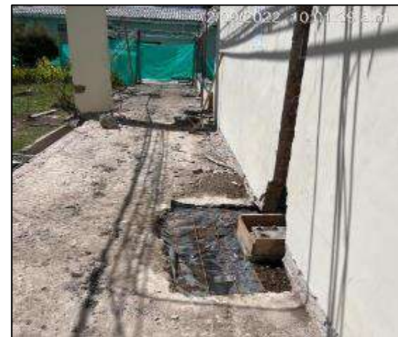
Suministro, concreto premezclado para pedestales (dados)
