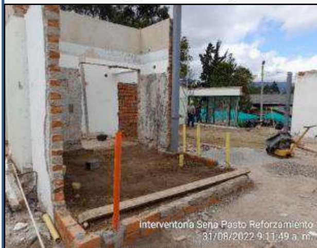
Instalación de tubería para red sanitaria.
