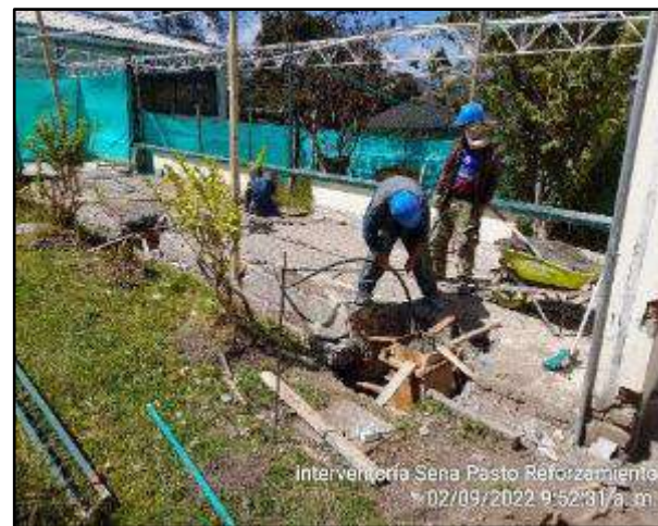
Suministro, concreto premezclado para pedestales (dados)
