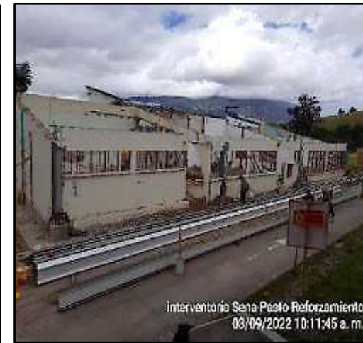
Suministro, fabricación y montaje de estructura autoportante
