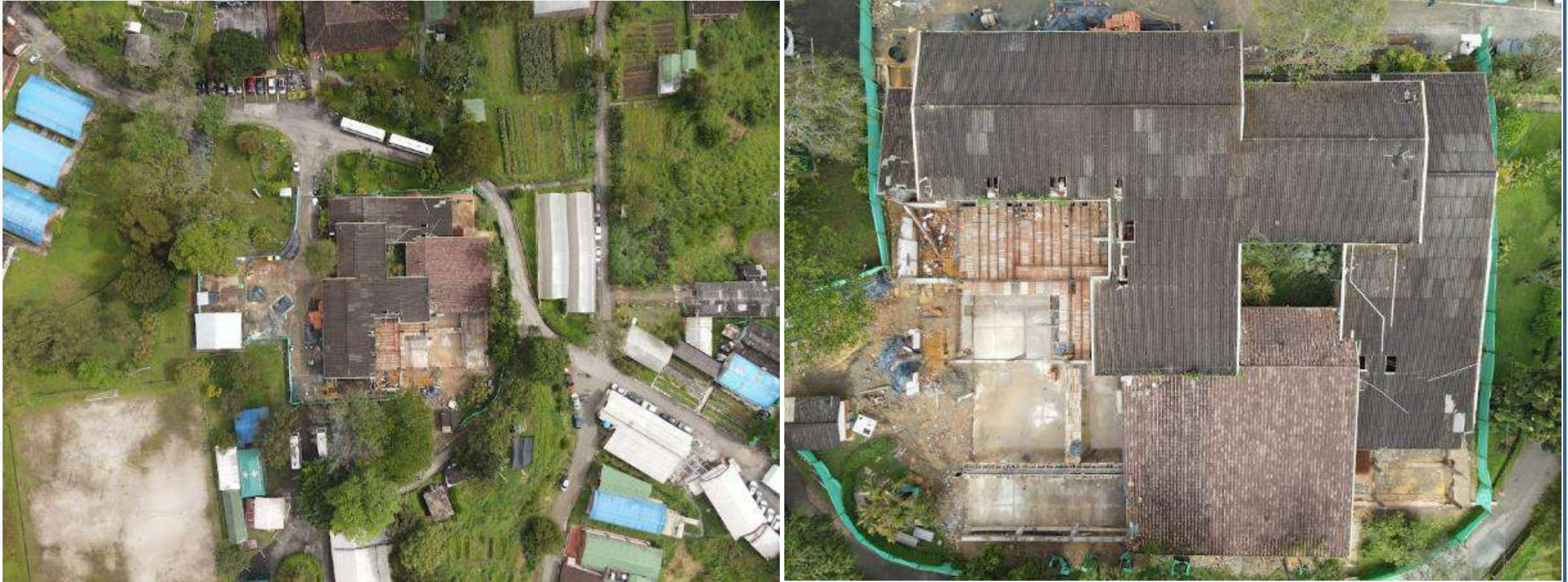
Vista general intervención de reforzamiento estructural edificio 16,1 y 16,2.
