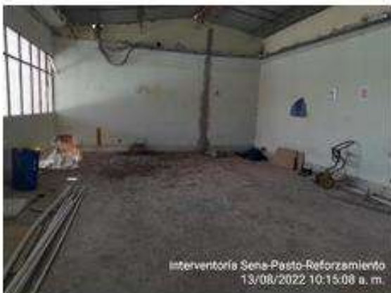
Demolición mecánica para zapatas
