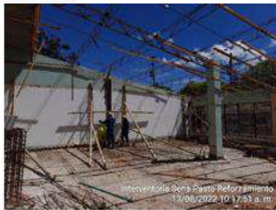
Montaje de columnas para estructura metálica
