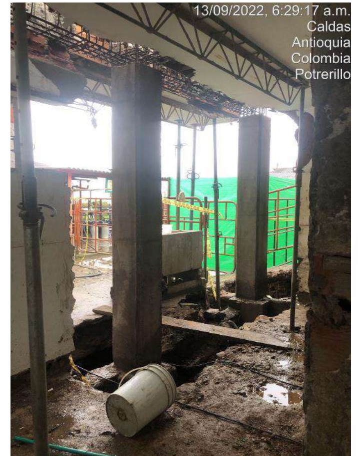
Vista general de intervención de reforzamiento estructural edificio 66.1 y 66.2
