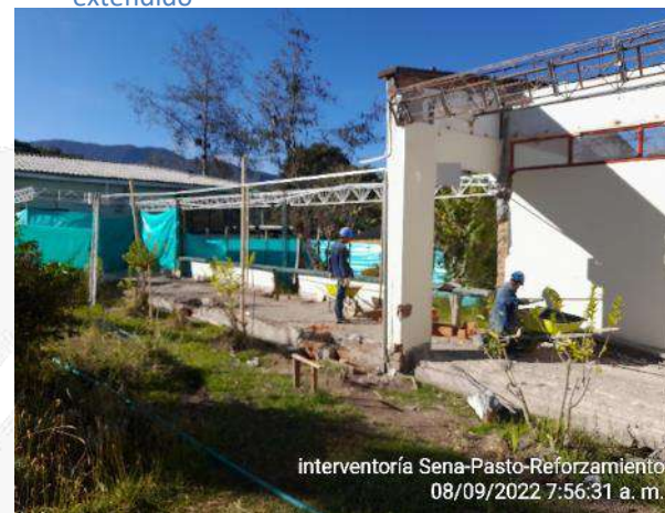
Relleno manual con recebo B-200. Incluye extendido Relleno manual con recebo B-200. Incluye extendido
