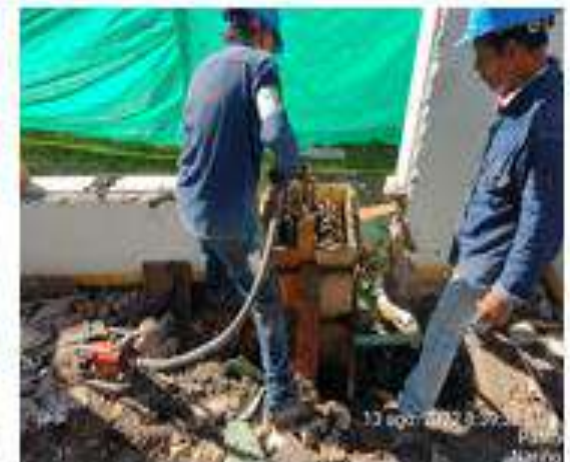
Concreto premezclado para pedestales
