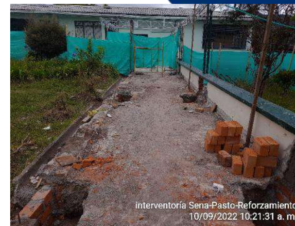
Relleno manual con recebo B-200. Incluye extendido
