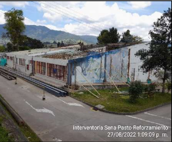
Suministro, fabricación y montaje de estructura autoportante
