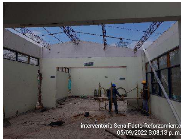
Demolición mecánica de muros en fachada.
