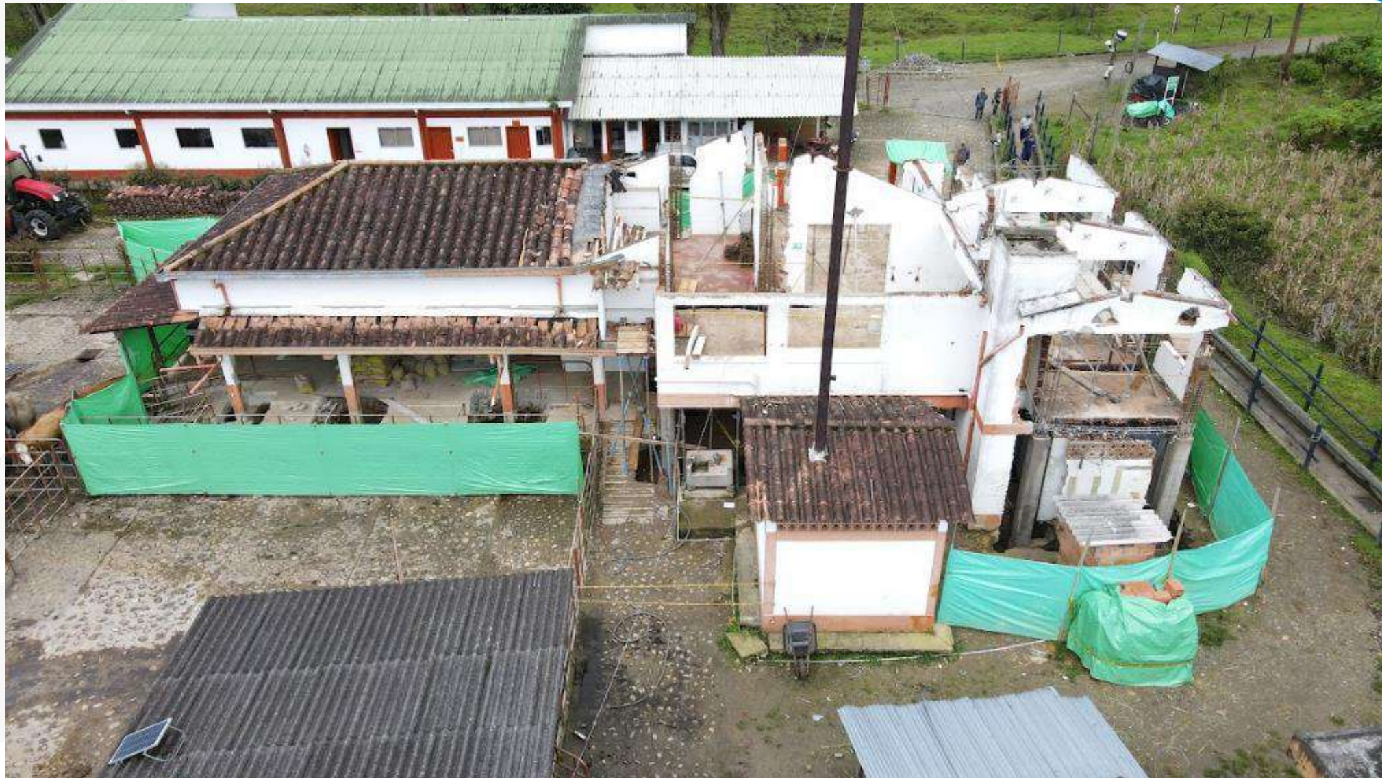
Vista aérea intervención de reforzamiento estructural edificio 66.1 y 66.2
