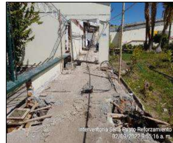
Suministro, concreto premezclado para pedestales (dados)
