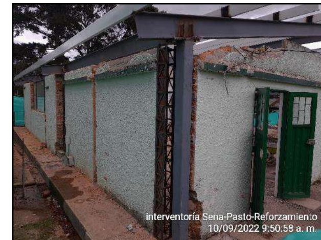
Montaje de estructura metálica autoportante.
