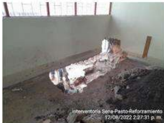
Demolición mecánica para zapatas
