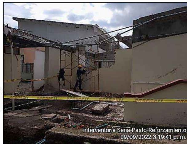
Demolición mecánica de muros en fachada.
