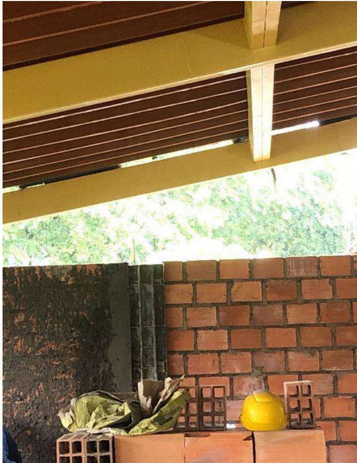
Elementos estructurales verticales, placas, mampostería y estructura metálica de cubierta edificio 16
