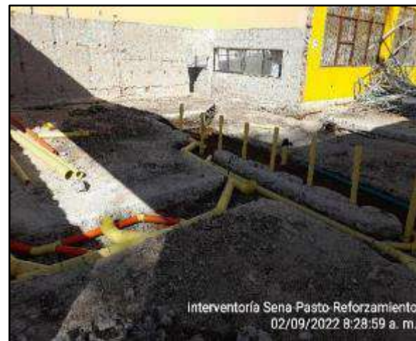
Excavación manual e instalación de tubería para red sanitaria.
