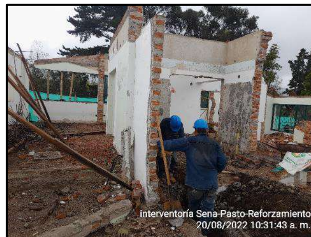
Demolición de cimentación existente
