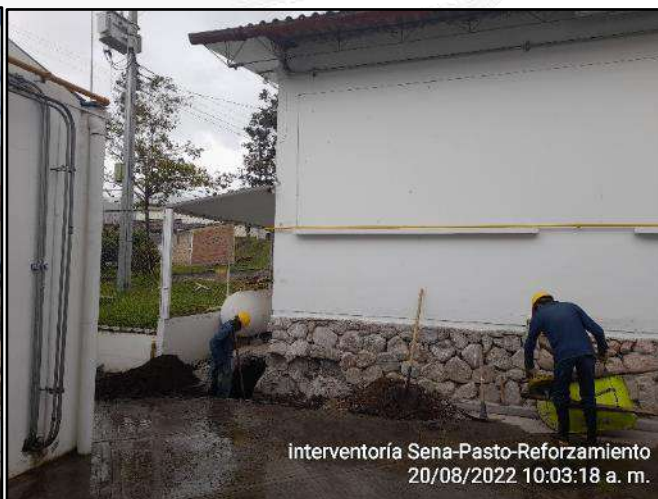
Excavación manual y acarreo de material sobrante
