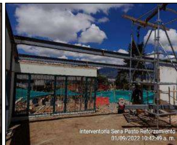
Montaje de estructura metálica autoportante.
