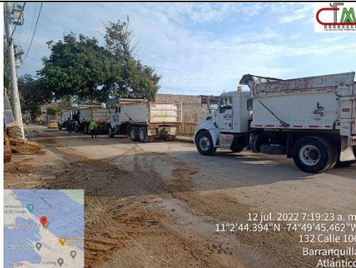
FOTO N° 13 ACTIVIDAD: Retiro de RCD LUGAR: Lote Edificio Administrativo FECHA: 12-07-2022
