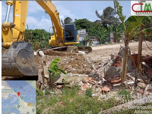
FOTO N° 17 ACTIVIDAD: Retiro de RCD LUGAR: Lote Edificio Administrativo FECHA: 14-07-2022
