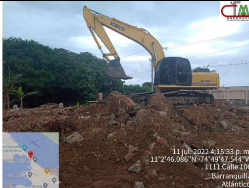
FOTO N° 15 ACTIVIDAD: Retiro de RCD LUGAR: Lote Edificio Administrativo FECHA: 11-07-2022
