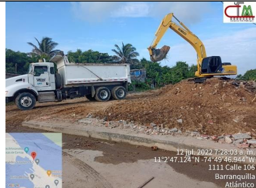
FOTO N° 14 ACTIVIDAD: Retiro de RCD LUGAR: Lote Edificio Administrativo FECHA: 12-07-2022
