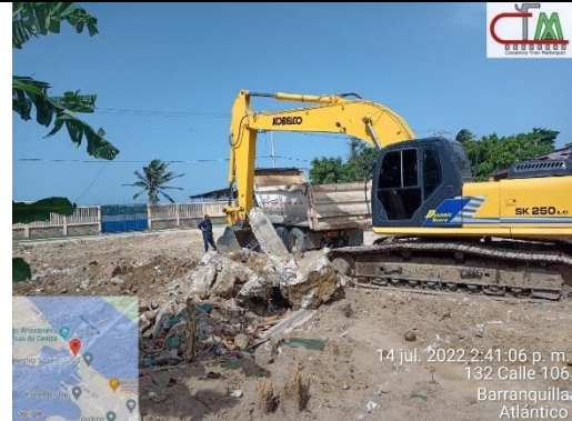
FOTO N° 16 ACTIVIDAD: Retiro de RCD LUGAR: Lote Edificio Administrativo FECHA: 14-07-2022
