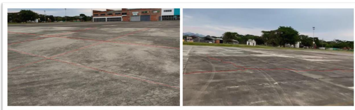
Ilustración 3 Estado actual Plataforma
