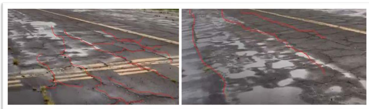
Ilustración 2 Estado actual Calle de Rodaje
