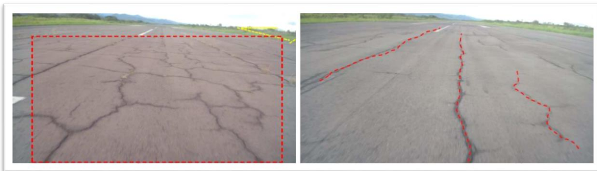
Ilustración 1 Estado actual Pista
