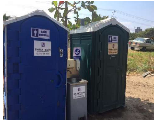
Frente de obra Tierra Firme
