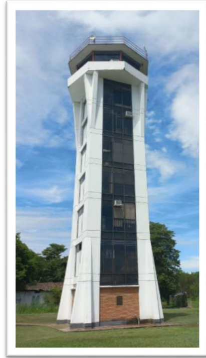
Ilustración 2. Torre de control
