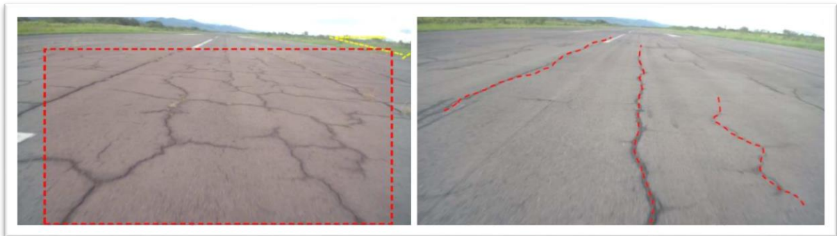
Ilustración 4 Estado actual Pista
