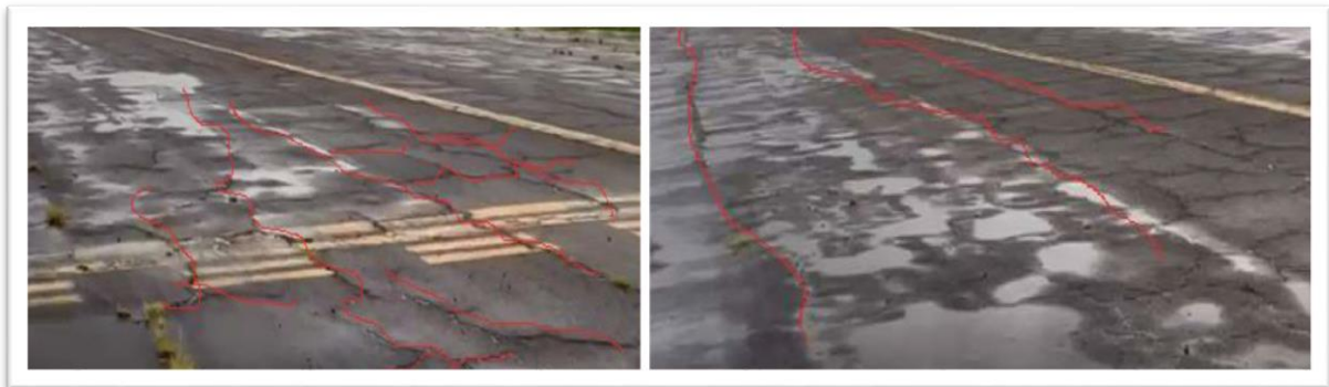
Ilustración 5 Estado actual Calle de Rodaje
