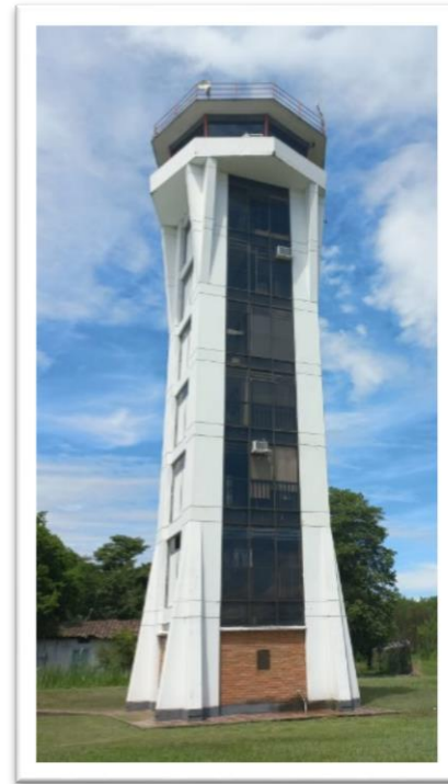
Ilustración 2. Torre de control
