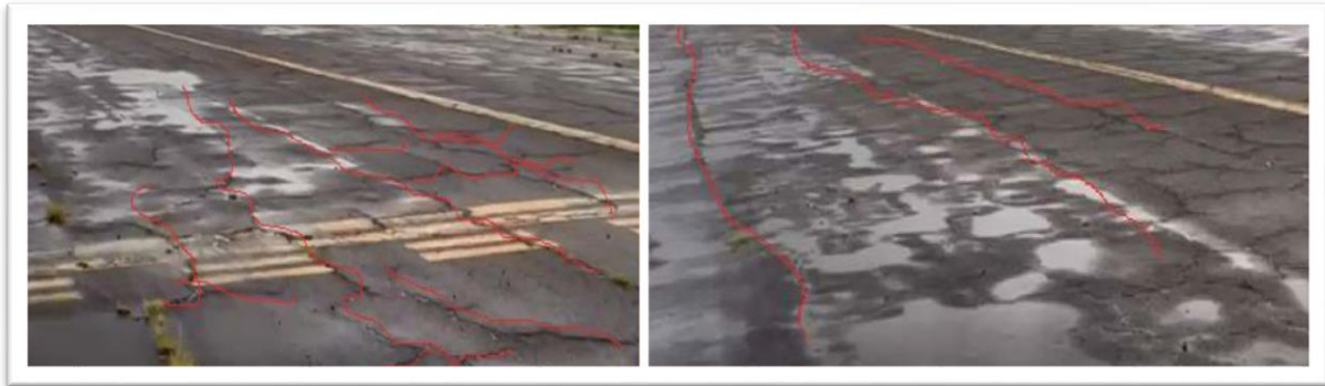
Ilustración 5 Estado actual Calle de Rodaje
