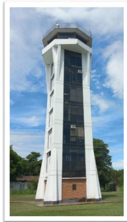
Ilustración 2. Torre de control
