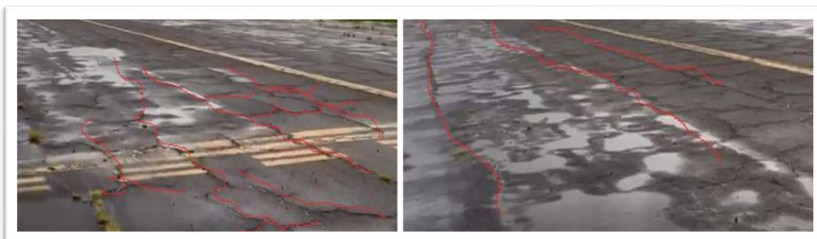
Ilustración 5 Estado actual Calle de Rodaje
