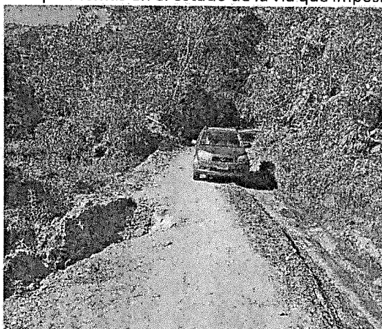
imagen 1 Pérdida de banca y pasos estrechos por deslizamientos
