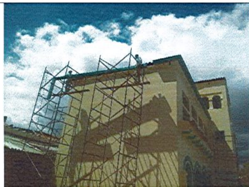
Instalación de canales y bajantes
