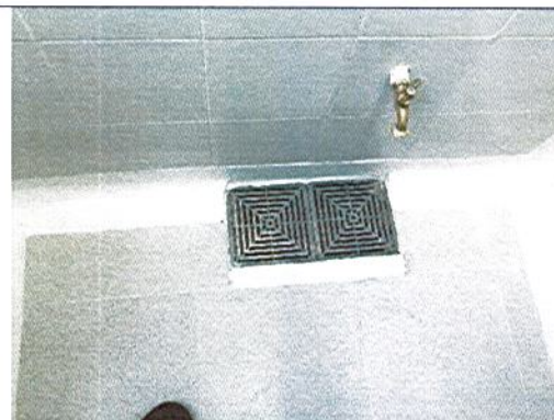
Terminado de piso, sifones y punto hidráulico.
