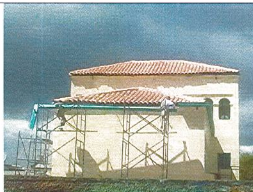
Instalación de canales y bajantes
