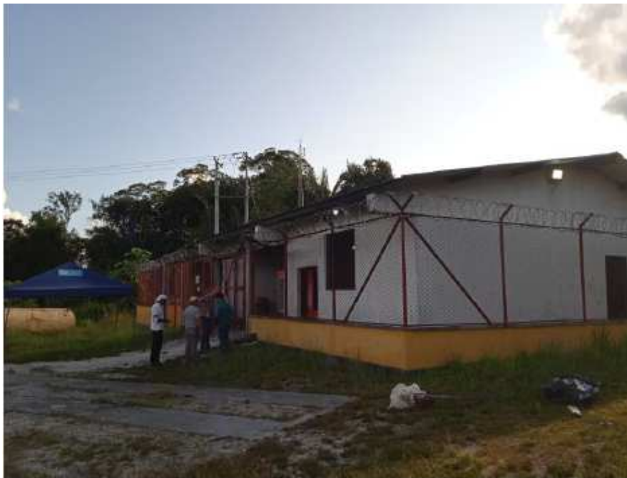
Ilustración 13. Central de Generación de Energía Eléctrica en Taraira Vaupés
