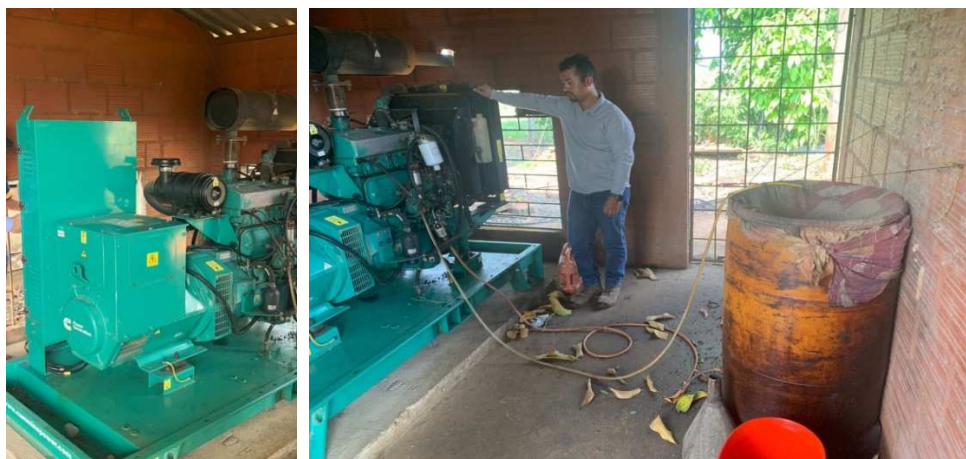
Ilustración 19. Trabajos de inspección – Central de generación Puerto Cachicamo.
