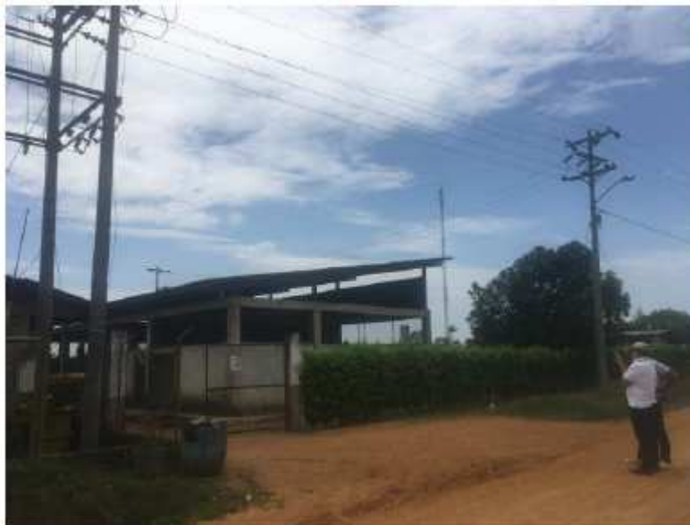
Ilustración 9. Central de Generación de Energía Eléctrica en Miraflores Guaviare
