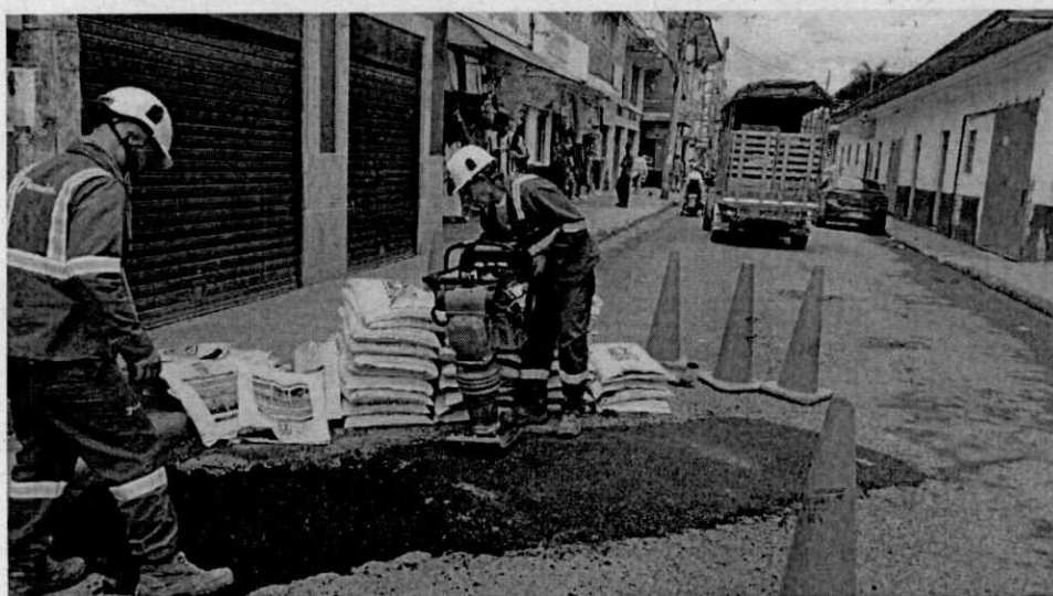
Figura 6. Reparaciones a la estructura de pavimento flexible mediante la construcción de una carpeta de rodadura en mezcla densa en caliente tipo INVIAS
