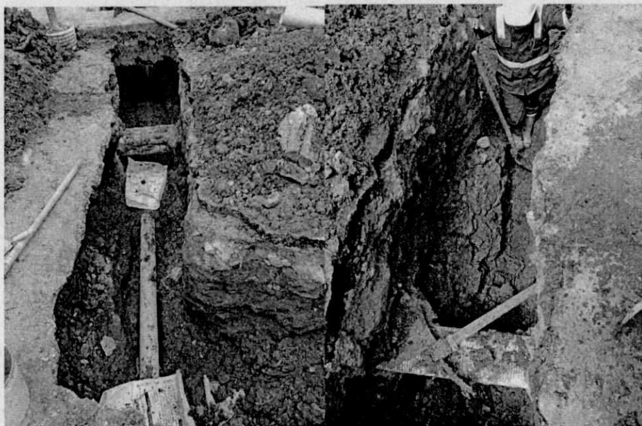
Figura 5. Corte de pavimento y reparación por instalación de acometida de alcantarillado
