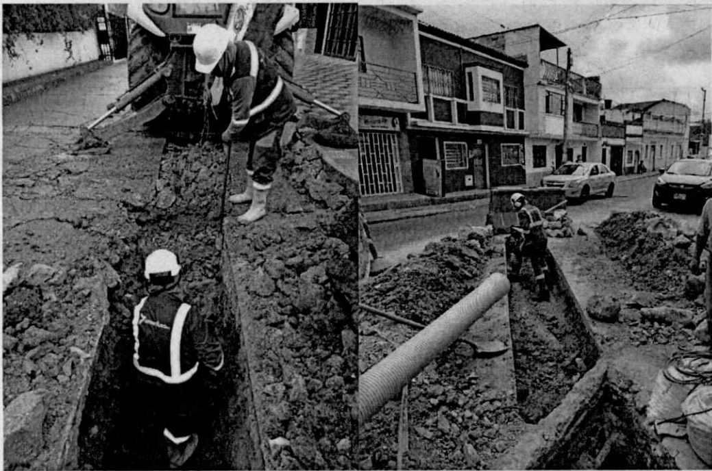
Figura 1. Corte de pavimento y reposiciones de la red de alcantarillado
