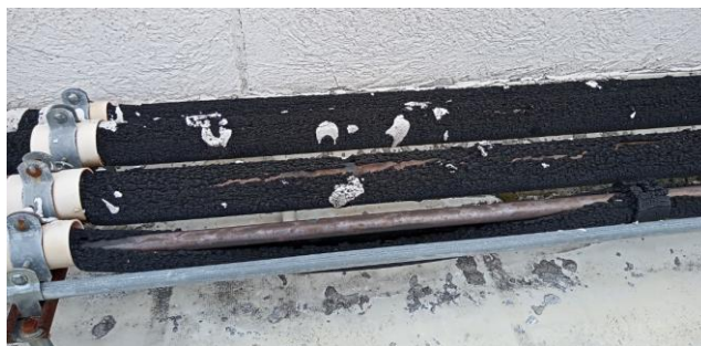
IMAGEN 3 AISLAMIENTO TÉRMICO DE TUBERÍA DE REFRIGERACIÓN
