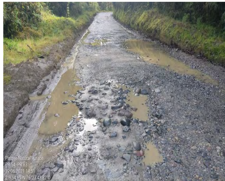
Foto 16 – PR 54 +000- PR 83 +300 ruta 2002: Estado del afirmado existente. Baches en general y pérdida de material granular
