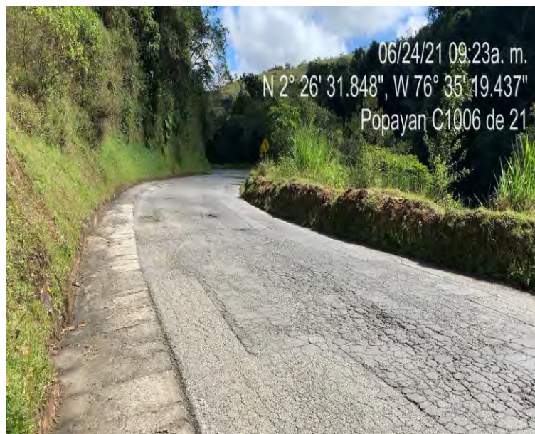
Foto 13 –PR25+600 Pavimento Flexible existente -Sector Coconuco
