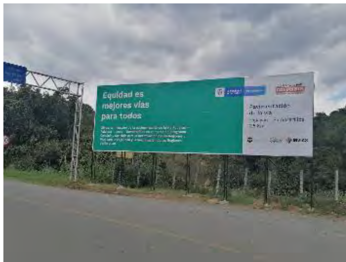
Foto 9 – Popayán: PR 1+200 del Proyecto- Instalación de Valla informativa del Contrato
