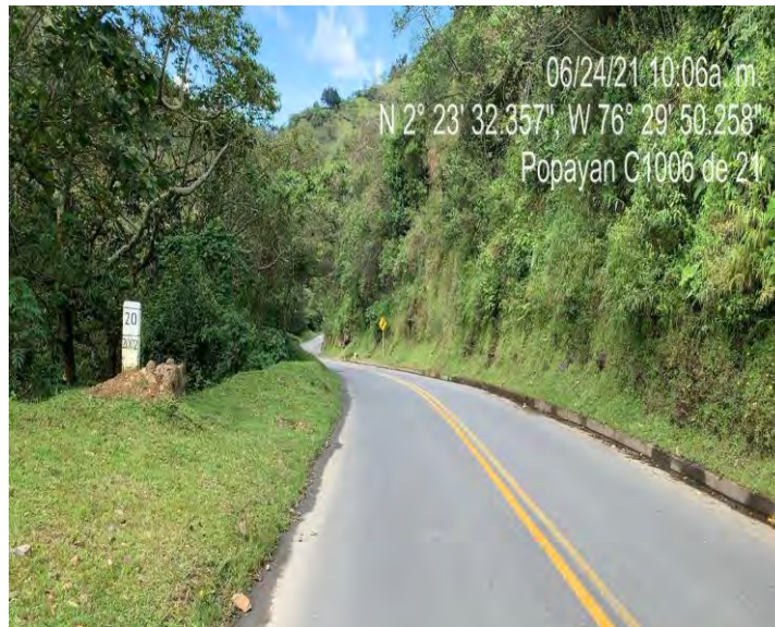
Foto 12 –PR20+000 Pavimento Flexible existente -Sector Coconuco
