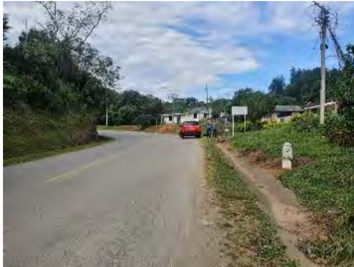
Foto 6 – Popayán: PR 0+000 del Proyecto- Instalación de Valla informativa del Contrato
