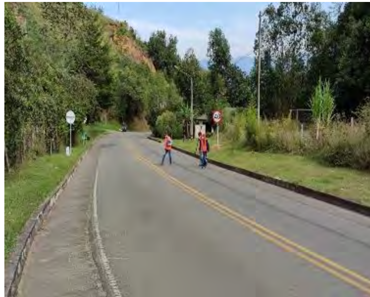
Foto 10 –PR2+000Labores de chequeo de topografía
