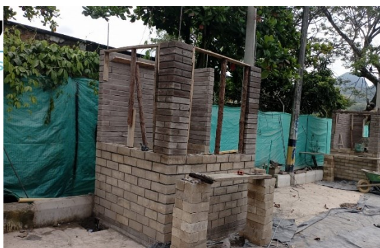
Figura 37. construcción de casetas
