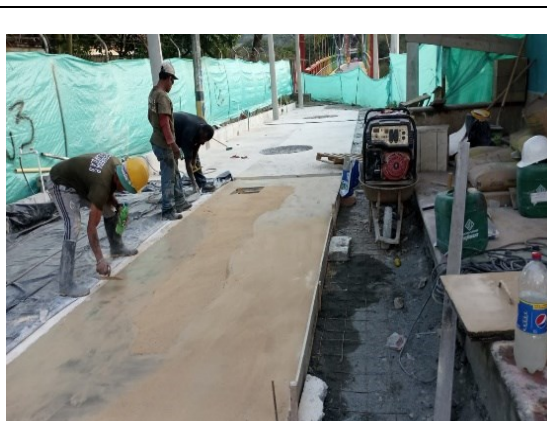
Figura 22. vaciado
