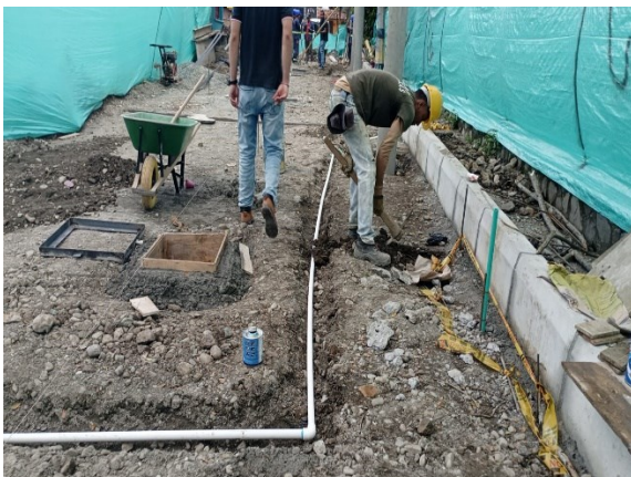
Figura 7. Instalación de red de abasto para casetas
