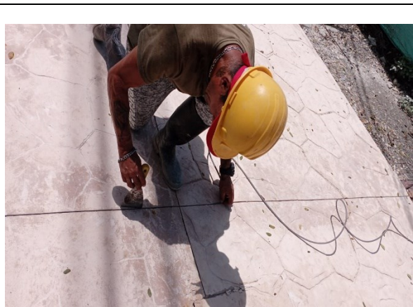
Figura 29. juntas de piso
