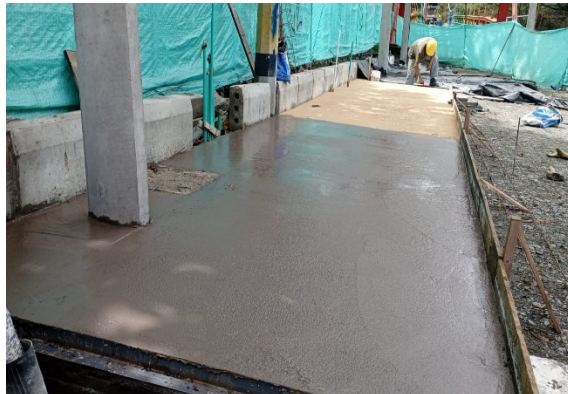
Figura 20. proceso de construcción piso
