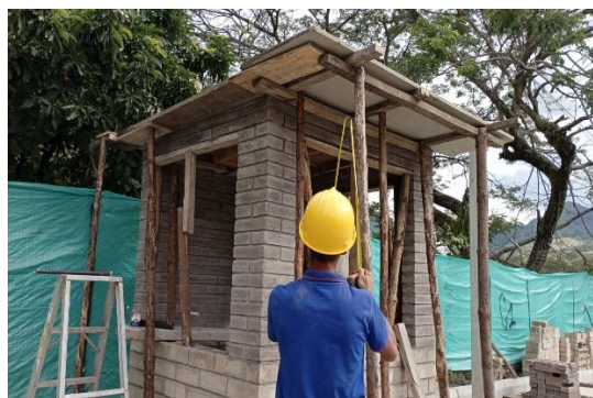
Figura 40. Formaleta losa-cubierta
