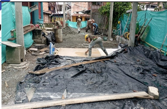
Figura 11. Acabado de piso y protección
