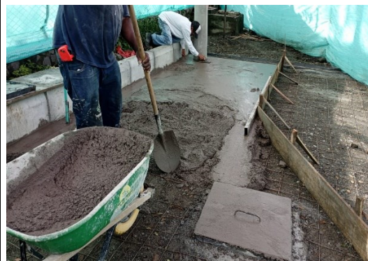
Figura 10. vaciado de concreto
