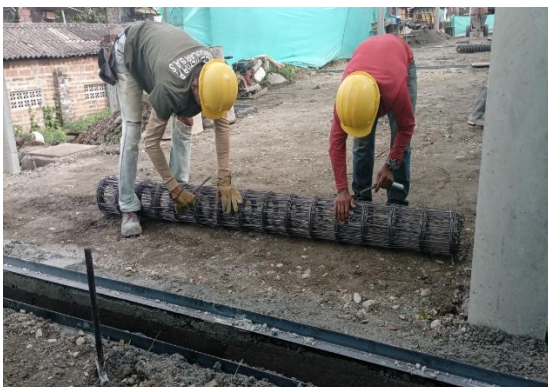
Figura 9. Instalación de malla electrosoldada
