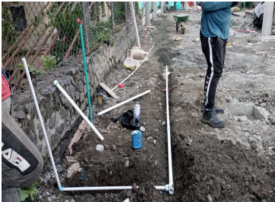
Figura 19. Instalación de redes
