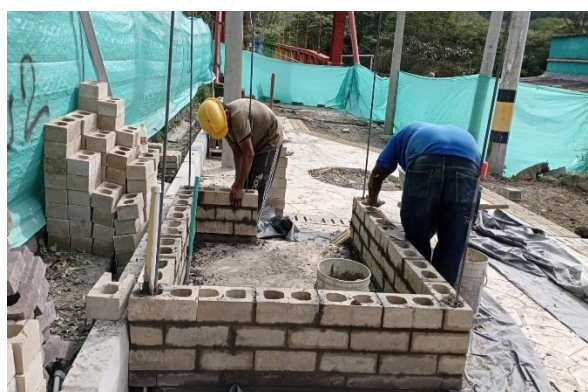
Figura 33. Construcción de casetas
