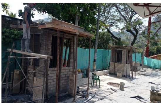
Figura 41. vaciado losa-cubierta
