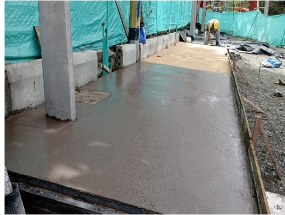
Figura 28. vaciado
