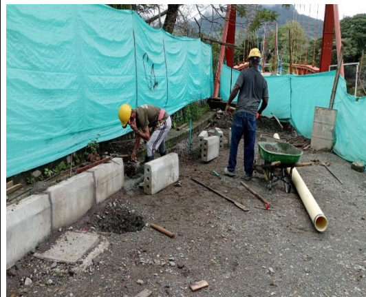
Figura 8. Instalación de bordillo
