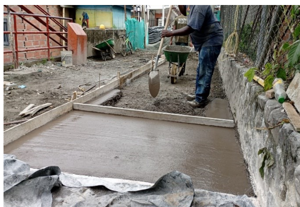
Figura 23. vaciado de concreto
