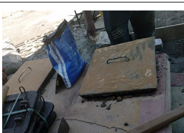
Figura 21. construcción de tapas
