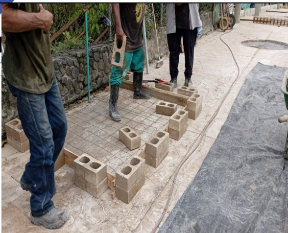
Figura 35. construcción de caseta
