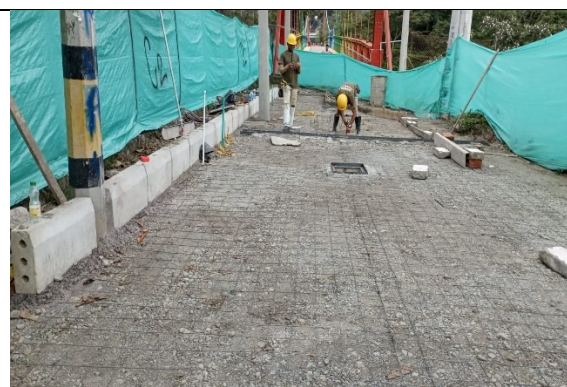
Figura 15. Instalación de malla
