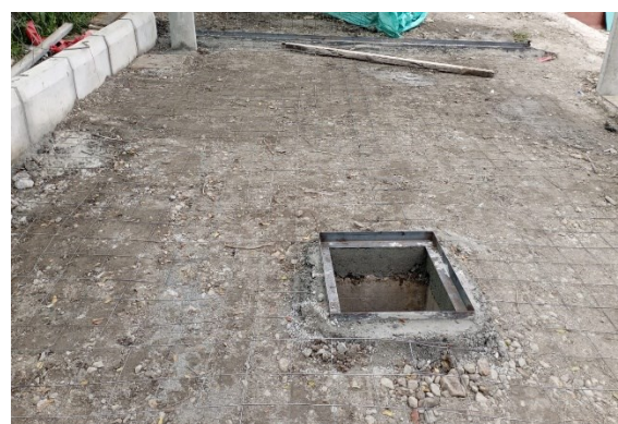
Figura 13. Construcción de cajas
