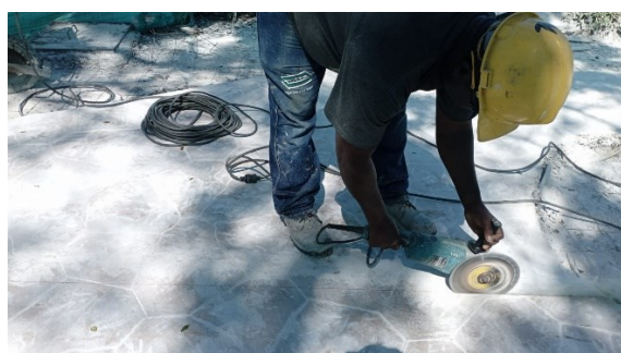
Figura 25. corte de concreto para juntas
