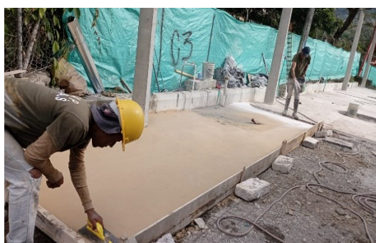
Figura 26. acabado de pisos
