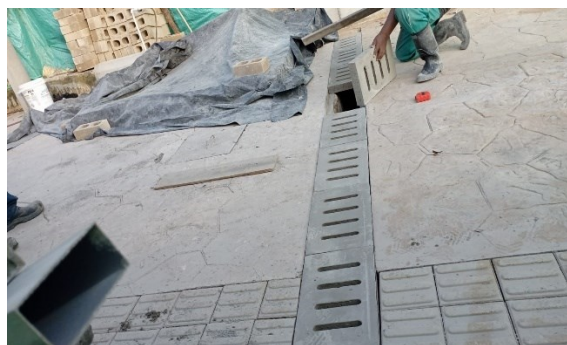
Figura 31. instalación de cárcamo
