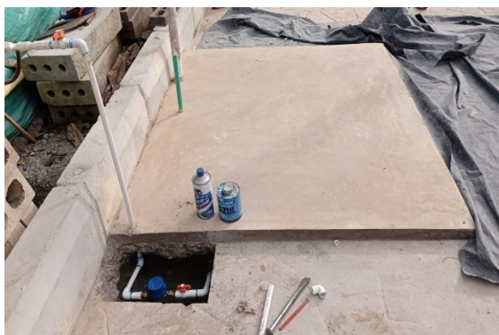
Figura 32. construcción de losa y redes
