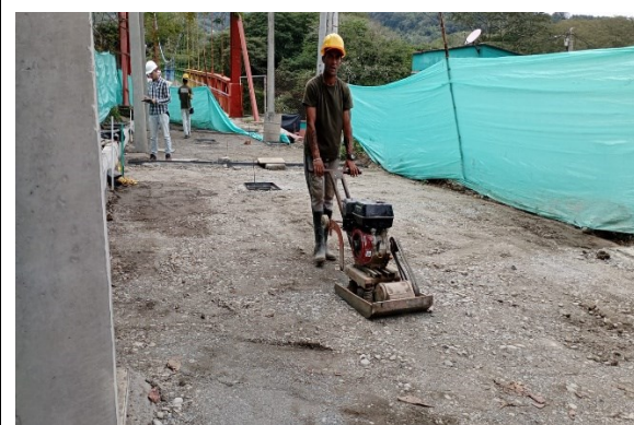
Figura 14. Compactación de material
