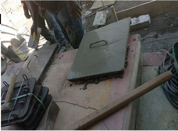
Figura 27. construcción de tapas
