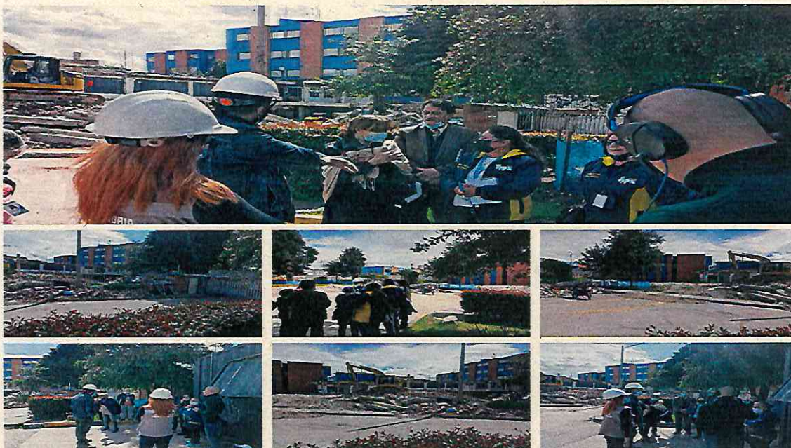
Registro fotográfico recorrido de veedores del proyecto y observación de la obra desde el perímetro. Proyecto Urgencias-Reordenamiento (vista áreas antiguo servicio de Urgencias y de Consulta Externa)
