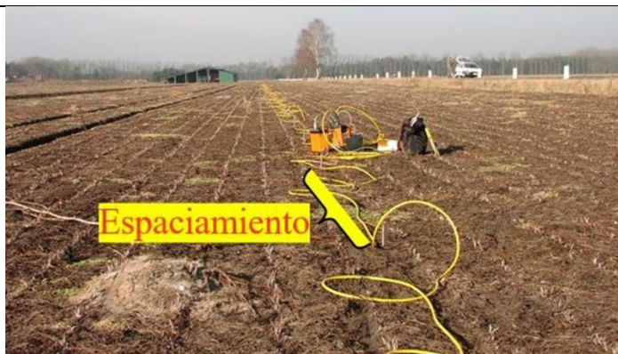
Figura 2. Tendido de cables y electrodos, espaciamiento entre electrodos.
