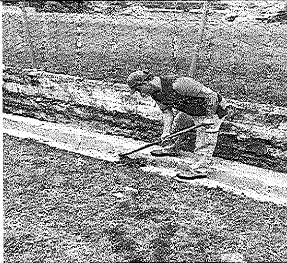
Mantenimiento de cunetas y zanjas
