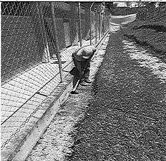
Mantenimiento de cunetas y zanjas
