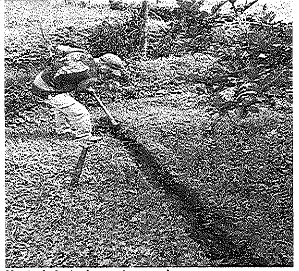
Mantenimiento de cunetas y zanjas
