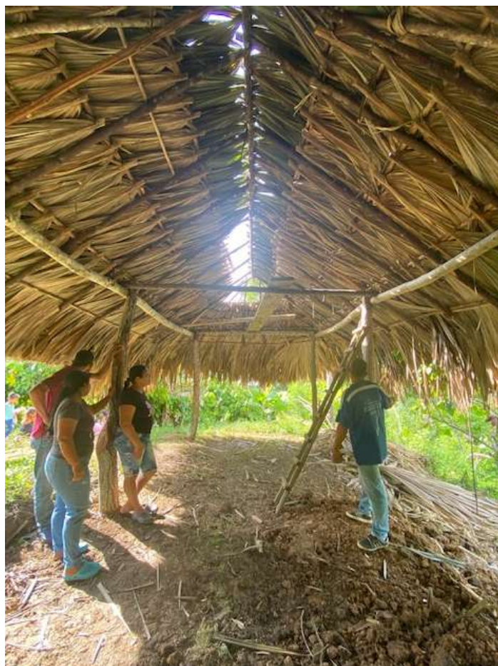
Instalaciones para aves ponedoras, utilizando recursos locales. Foto: Francy Gómez (2022).
