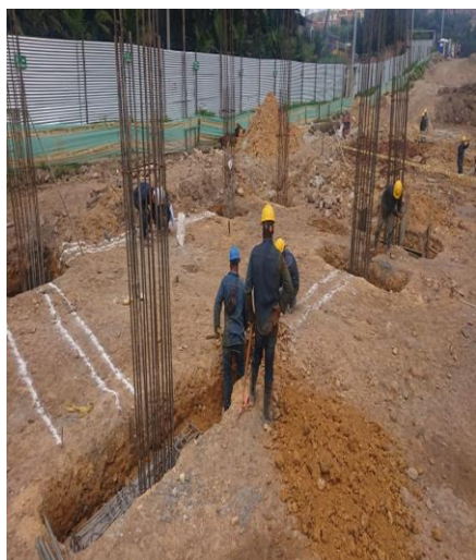
Bloque 2: Excavacion para dados y vigas
