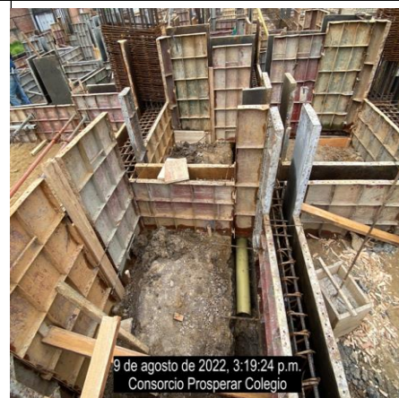
Bloque 4: Formaleta para vigas y viguetas de la zona n -0.07m bloque 4
