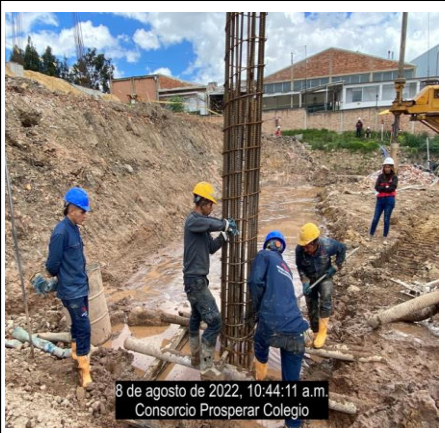
Bloque 4: Fundida y acero de pilote #100 d=60cm.
