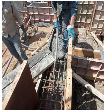
Bloque 4: Fundida de vigas y viguetas ejes (1,2)-(AC)
