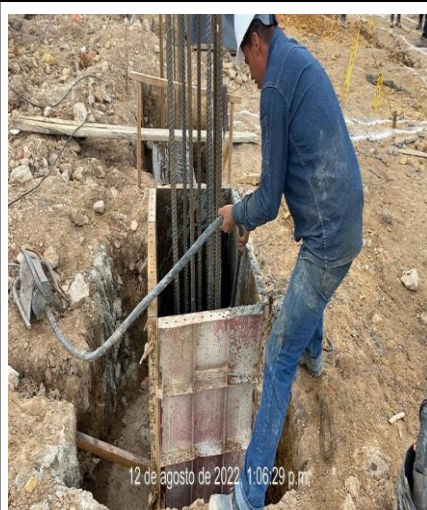
Bloque 2: Fundida para dados eje G-17 concreto de 3500 PSI
