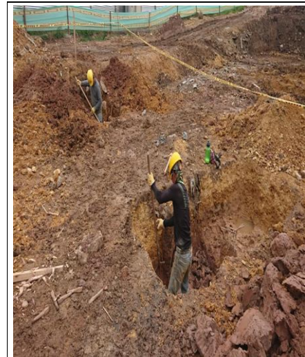
Bloque 2: Excavación manual dado eje 14-(h-i)
