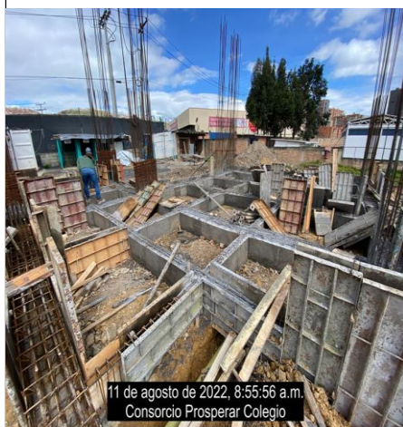
Bloque 4: Desencofre de vigas y viguetas nivel -0.07m ejes (1,2)-(AF).
