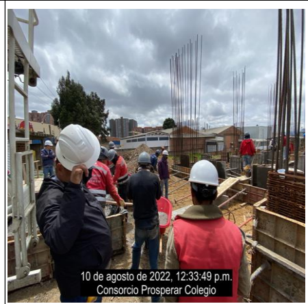
Bloque 4: Fundida de vigas y viguetas ejes (1,2)-(AC)
