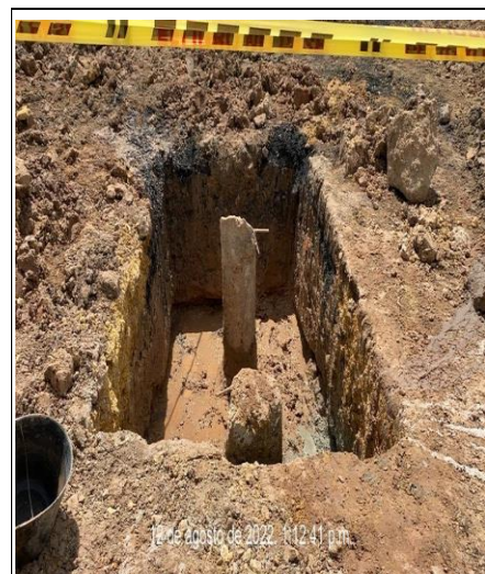
Bloque 2: Solado para dados eje G-17 concreto de 1500 PSI
