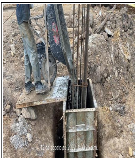
Bloque 2: Fundida para dados eje G-19 concreto de 3500 PSI
