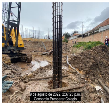
Bloque 4: Acero para Pilote 175 eje 12-C DIAMETRO 0,60 m nivel -7,07 m
