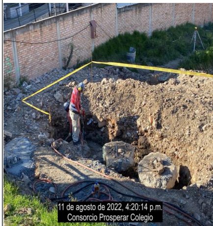
Bloque 4: Descabece de pilotes eje 8 nivel -3.54m
