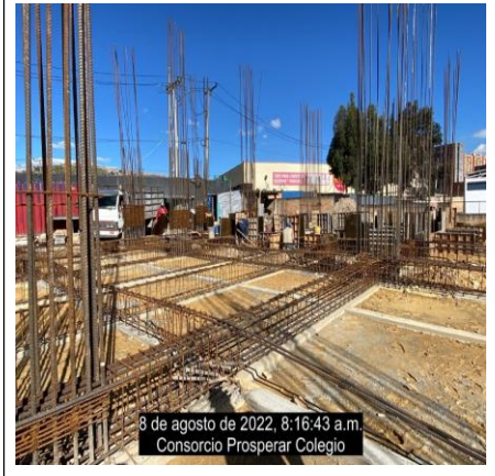
Bloque 4: Armado de Vigas y viguetas para bloque 4 nivel -0.07
