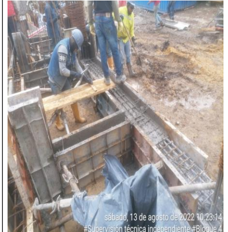
Bloque 4: Continuación fundida de vigas ejes (1,2) (CF).
