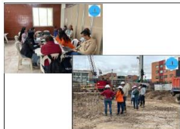
COMITÉ DE OBRA #17 Y RECORRIDO DE OBRA
