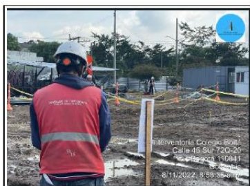
CHEQUEO DE TOPOGRAFIA PARA INICIO DE EXCAVACIÓN Y TRASLADO DE AMARRES O PUNTO FUJO TOPOGRÁFICO.
