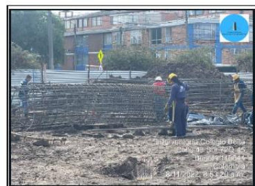
ARMADO DE CANASTILLA DE ACERO PARA PILOTES DE DIÁMETRO 1.50 MTS
