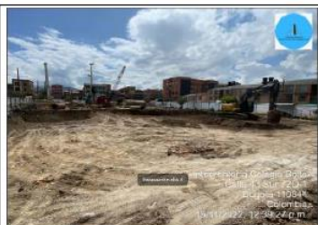
INICIO DE EXCAVACIÓN DE MATERIAL A CIELO ABIERTO PARA LLEGAR A NIVEL -4.85 MTS
