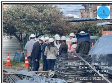
VISITA A OBRA POR PARTE DE SED Y ENTERRITORIO
