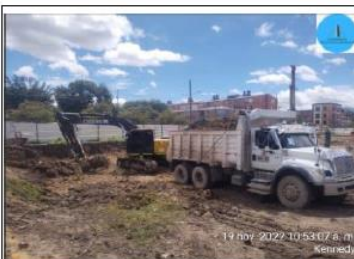
EXCAVACIÓN DE MATERIAL A CIELO ABIERTO PARA LLEGAR A NIVEL -4.85 MTS
