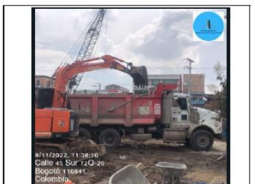
RETIRO DE MATERIAL PRODUCTO DE EXCAVACION DE PILOTES EDIFICIO A
