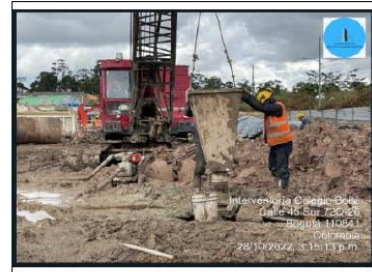
PERFORACIÓN Y FUNDIDA DE PILOTE DE 1.50 MT Pilote Semana 15 Eje 9A-A, Prof. 15 MT Edificio A SEGUN PLANO E-09
