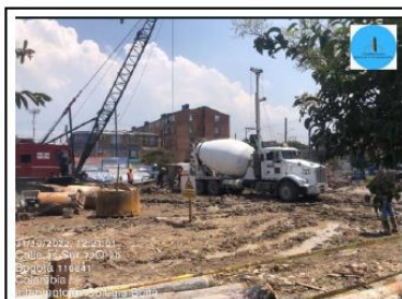
PERFORACIÓN Y FUNDIDA DE PILOTE DE 1.50 MT Pilote Semana 16 Eje 9A-A, Prof. 17.00 Edificio A SEGUN PLANO E-09
