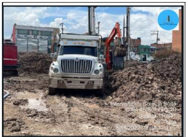
RETIRO DE MATERIAL DE PERFORACION.
