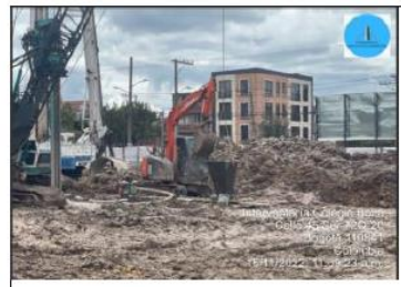
PERFORACIÓN Y FUNDIDA DE PILOTE DE 1.50 MT Pilote #40 Eje 6A-A, Prof. 17.00 Edificio A SEGÚN PLANO E-09
