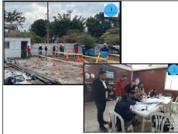
COMITÉ DE OBRA #14 Y RECORRIDO DE OBRA
