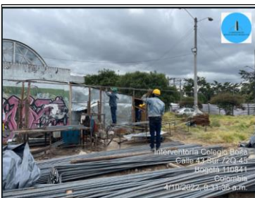
ADECUACIONES DE ZONA FIGURADO DE ACERO, CONSTRUCCIÓN DE RAMADA
