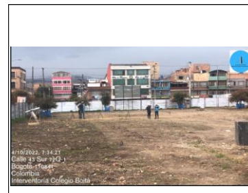
ADECUACIONES PARA ZONA DE FIGURADO CANASTAS DE PILOTE
