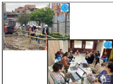
COMITÉ DE OBRA #16 Y RECORRIDO DE OBRA
