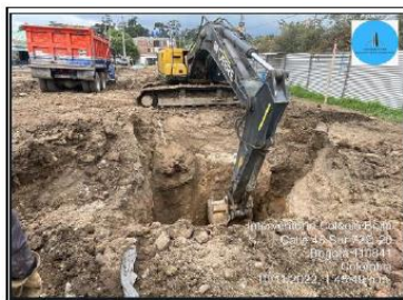
INICIO DE EXCAVACIÓN DE MATERIAL A CIELO ABIERTO PARA LLEGAR A NIVEL -4.85 MTS
