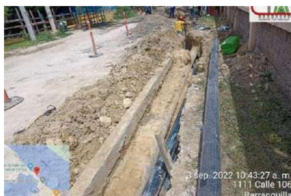
IMAGEN 18 Cimentación de arena para tubería PEAD 160mm LUGAR: Tajamar FECHA: septiembre-2022
