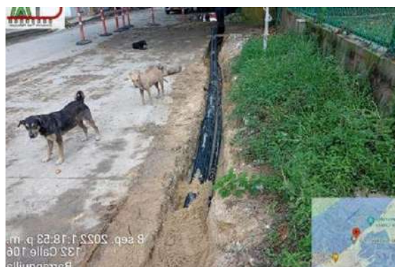
IMAGEN 19 Cimentación de arena para tubería PEAD 160mm LUGAR: Tajamar FECHA: septiembre-2022
