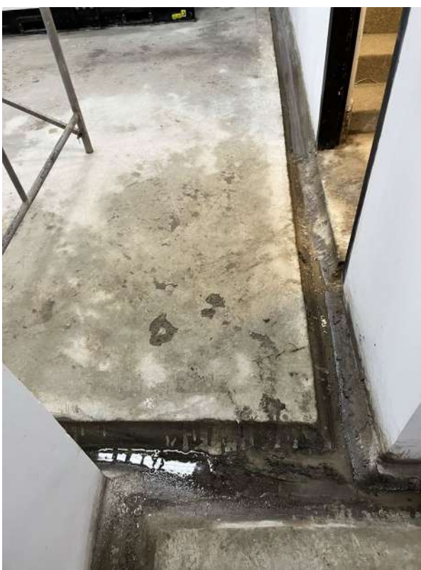
Cunetas perimetrales construidas en todo el sótano, para conducir el agua filtrada hacia los tanques.
