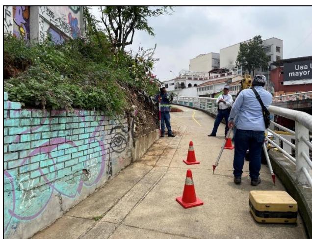
Levantamiento topográfico talud. Fuente: Comisión de topografía
