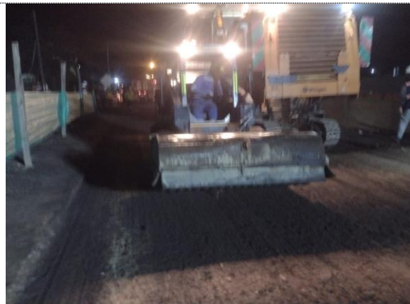
Limpieza de caja con barredora mecánica (25/10/22)
