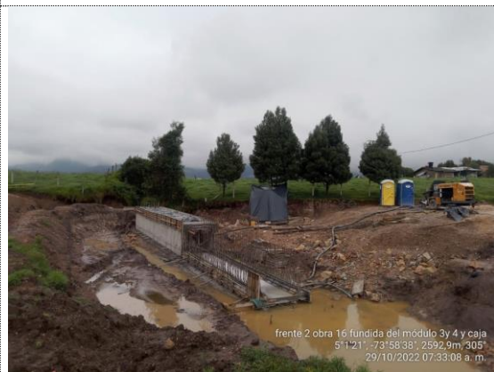
Obra No 16 Box culvert 1.5X1.5 K2+410 fundida de placa inferior módulos 3 y 4 (29/10/22)
