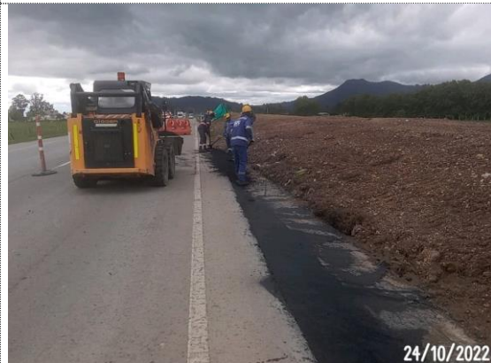
Retorno K5+300, K0+000 – K0+060 instalación MSC-25, espesor e=11cm (24/10/22)
