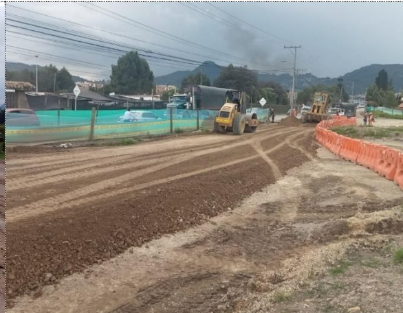
ADECUACIÓN DE TERRENO PARA DESVÍO PROVISIONAL Y MANTENIMIENTO DE CRUCE DE AVE COLOMBIANA
