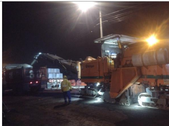
Fresado de carpeta asfáltica (25/10/22)
