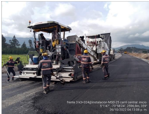
K3+324 - K3+490 INSTALACIÓN DE MSC-25 CARRIL CENTRAL, ESPESOR E=11CM.
