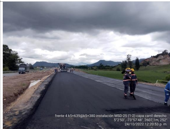
K5+380 – K5+645 instalación MSC-25 carril derecho, espesor e=11cm (24/10/22)
