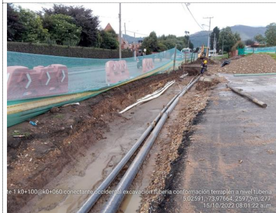
Conectante occidental instalación de terraplén en zona de redes de servicios públicos (15/10/22)
