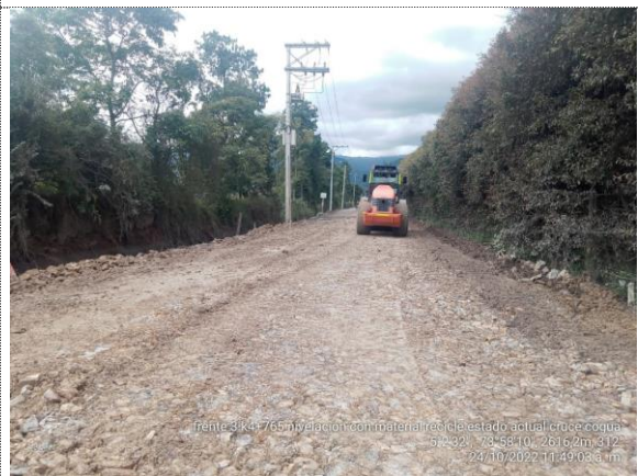
Nivelación de la vía con material reciclado (24/10/22)
