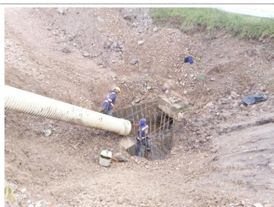
Obra No. 26 Box culvert 1x1 K3+568 fundida de placa inferior de caja arqueta (15/10/22)
