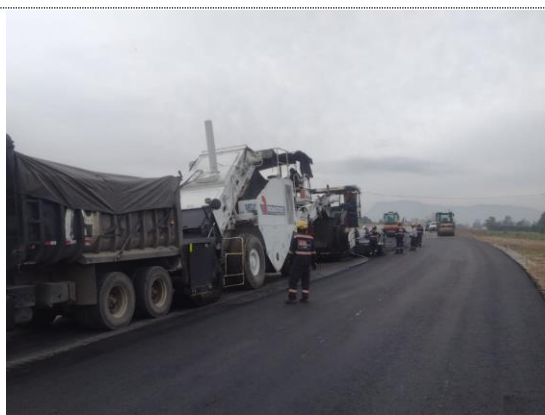
K5+230 – K5+380 instalación de 2da capa de MSC-25 carril derecho, espesor e=5cm (13/10/22)
