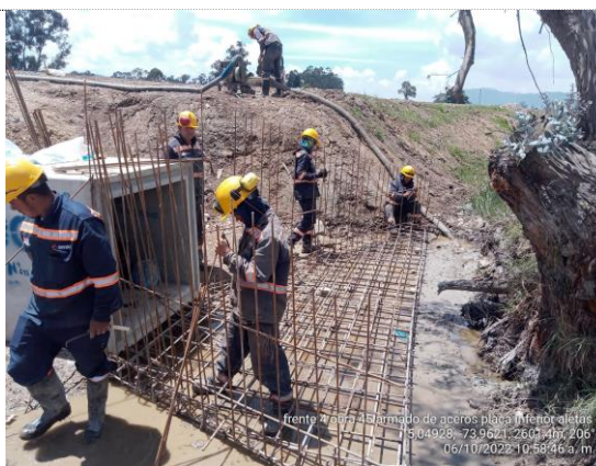
Obra No. 45 Box culvert 1X1 K5+894 armado de acero y encofrado placa inferior encole (06/10/22)
