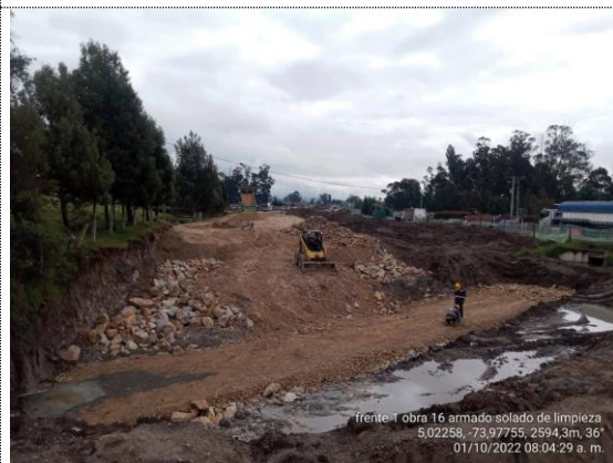
Obra No 16 Box culvert 1.5X1.5 K2+410 excavación e instalación de pedraplén (01/10/22)
