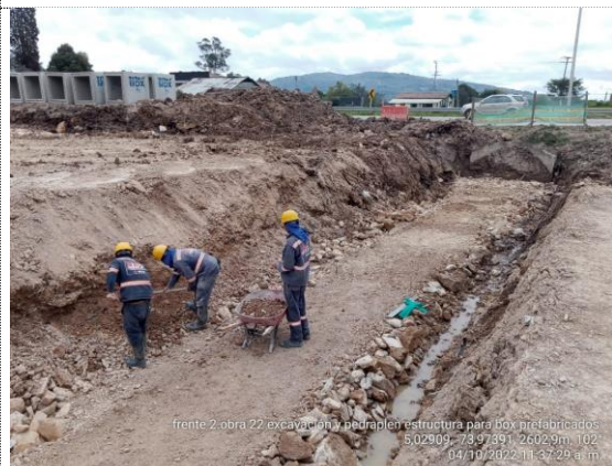
Obra No. 22 Box culvert 1x1 K3+220 excavación e instalación de pedraplén (04/10/22)
