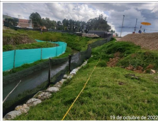
Glorieta Ave Colombiana replanteo de caisson en río Susagua (19/10/22)
