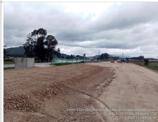
K3+640 – K3+680 instalación 9na capa de terraplén (12/10/22)
