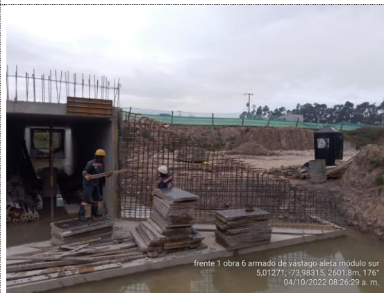
Obra No. 6 Pasaganado 3X3 K1+069 armado de acero aleta sur de encole (04/10/22)
