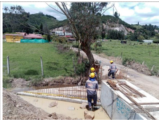
Obra No. 45 Box culvert 1X1 K5+894 armado de acero aletas de encofe (10/10/22)
