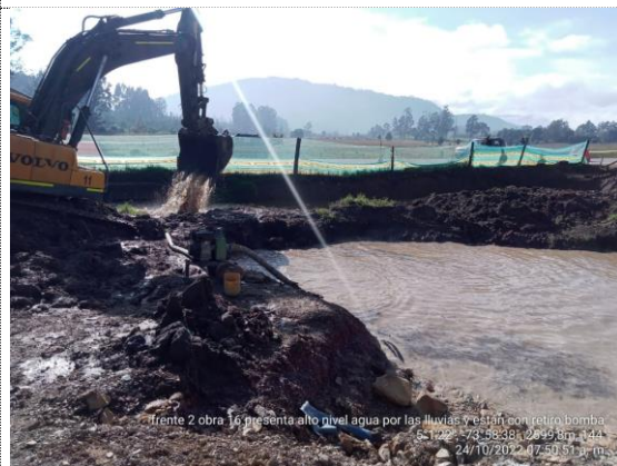
Obra No 16 Box culvert 1.5X1.5 K2+410 retiro de aguas empozadas por fuertes lluvias (24/10/22)
