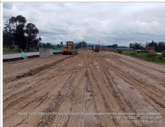
K3+590 – K3+700 escarificación de 4ta capa de terraplén por material saturado (26/10/22)
