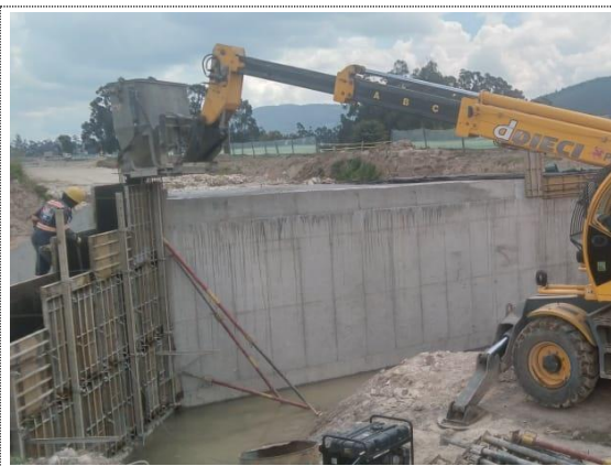
Obra No. 6 Pasaganado 3X3 K1+069 fundida de aleta sur de encole (04/10/22)
