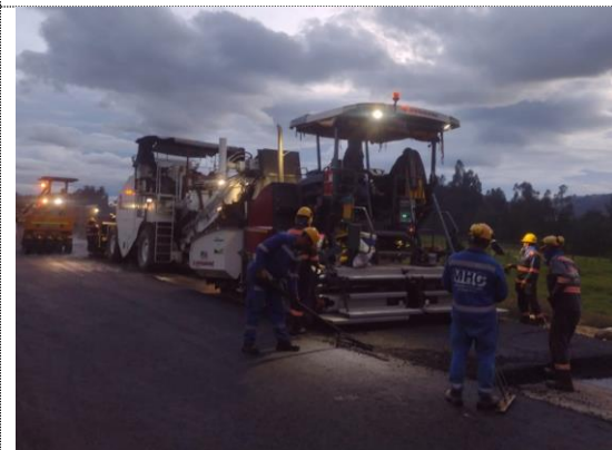
K3+400 – K3+488 instalación de MSC-25 carril izquierdo, espesor e=11cm (26/10/22)
