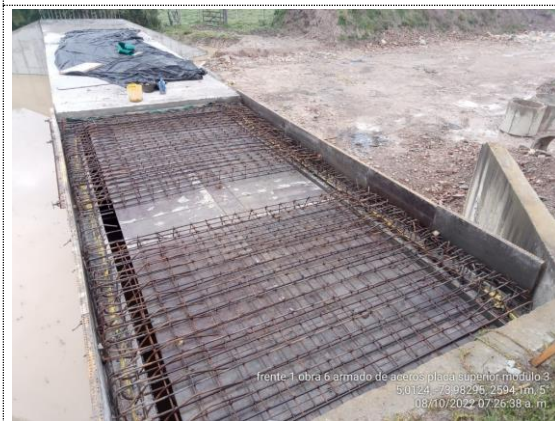
Obra No. 6 Pasaganado 3X3 K1+069 armado de acero y encofrado placa superior módulo 3 (08/10/22)
