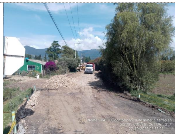
Conformación de vía (22/10/22)
