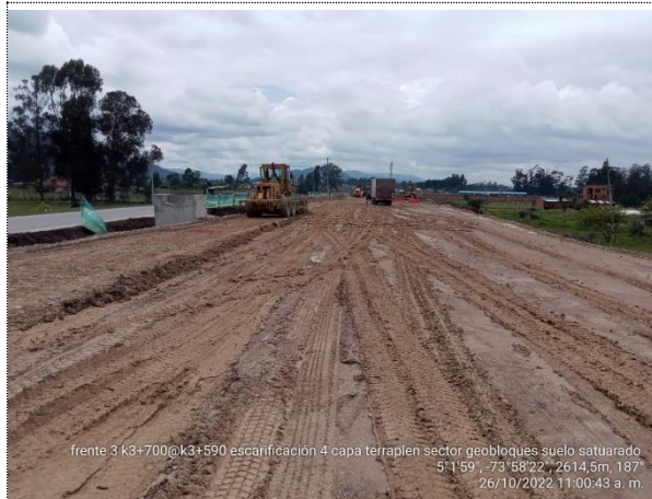
K3+590 - K3+700 ESCARIFICACIÓN DE 4TA CAPA DE TERRAPLÉN POR SUELO SATURADO
