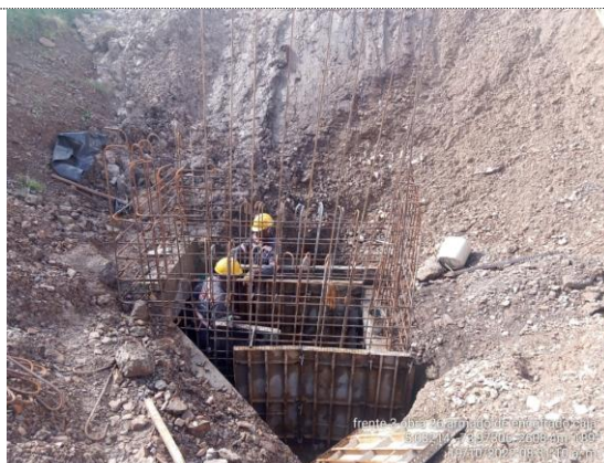
Obra No. 26 Box culvert 1x1 K3+568 armado de acero caja arqueta (19/10/22)
