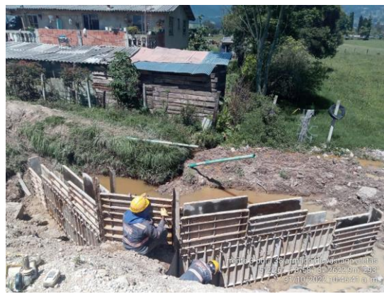
Obra No. 33 Box culvert 1x1 K4+564 armado de acero y encofrado aletas de encole (31/10/22)
