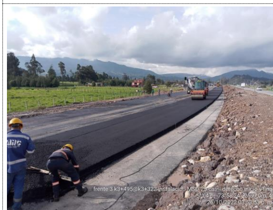
K3+322 – K3+490 instalación de MSC-25 carril derecho, espesor e=11cm (26/10/22)
