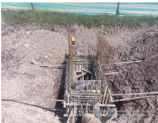
Obra No. 26 Box culvert 1x1 K3+568 fundida de caja arqueta, primera sección (21/10/22)
