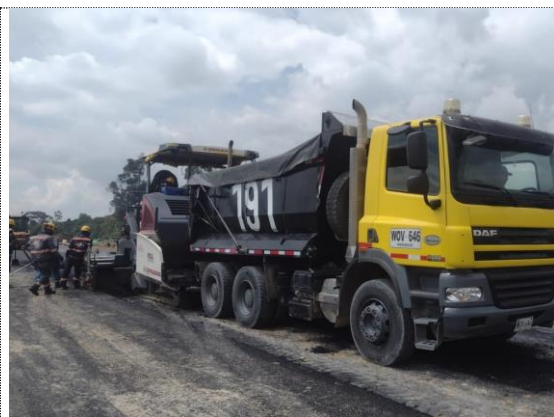
Conectante sur K0+380 – K0+410 instalación de BTA carril central e izquierdo (21/10/22)
