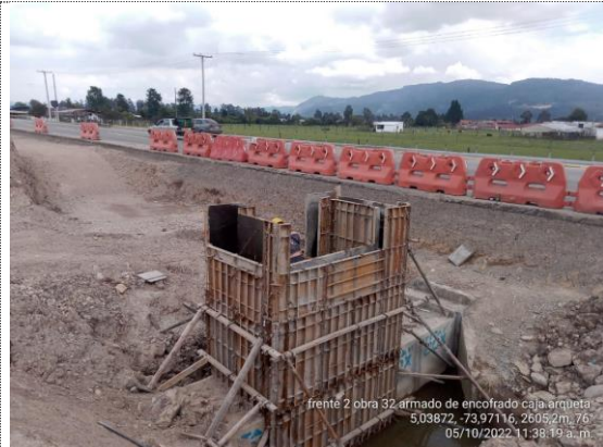
Obra No. 32 Box culvert 1x1 K4+354 armado de acero y encofrado caja arqueta (05/10/22)
