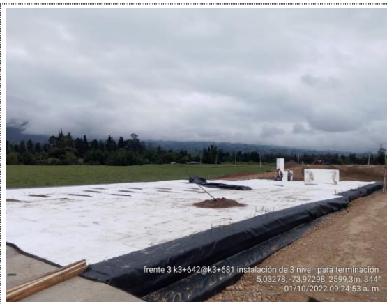
K3+642 – K3+680 instalación 3er capa de geobloques (última) (01/10/22)
