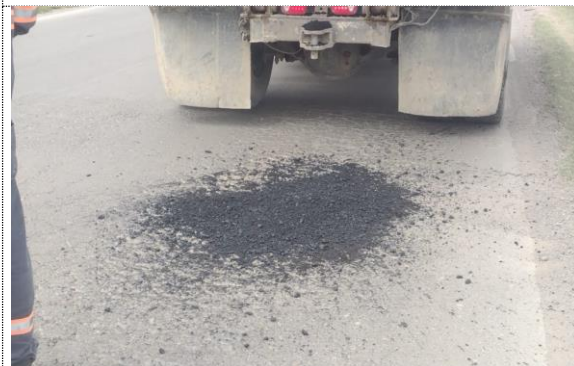
Tapahuecos PR1+0250 - PR2+0750 Y PR8+0600 - PR9+0300 (05/10/22)
