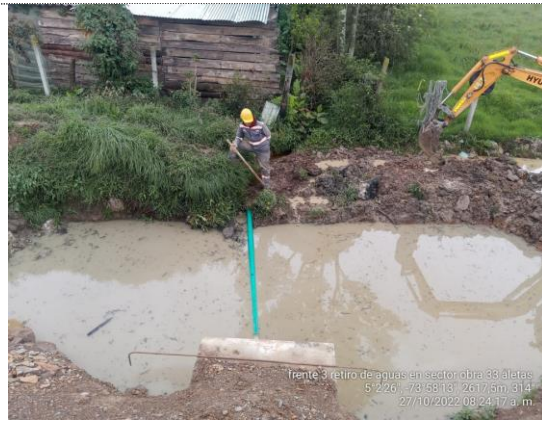
Obra No. 33 Box culvert 1x1 K4+564 retiro de aguas empozadas en encole (27/10/22)
