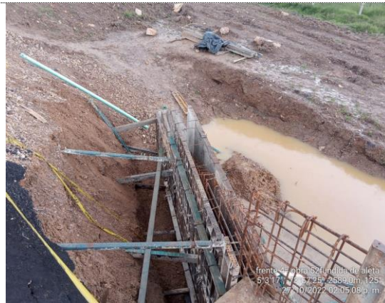
Obra No. 52 Box culvert 2x2 K6+720 fundida de aleta sur de encole (27/10/22)
