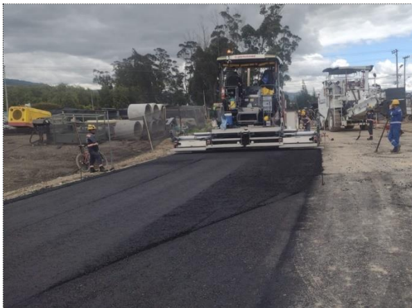
K0+030 - K0+228 INSTALACIÓN DE MSC-25 CARRIL IZQUIERDO, ESPESOR E=11CM
