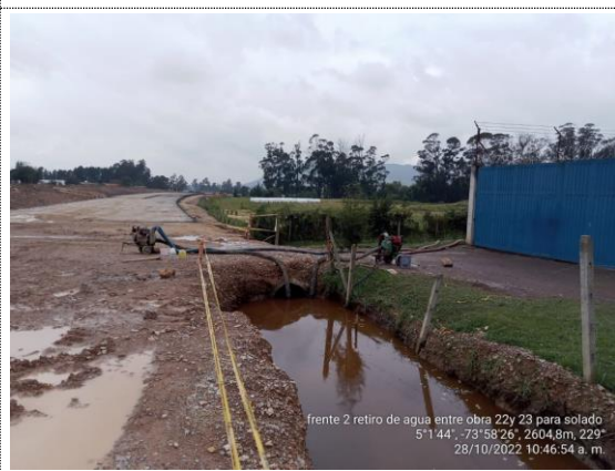
Conectante norte K0+050 – K0+130 retiro de aguas empozadas en canal longitudinal obra No 23 (28/10/22)
