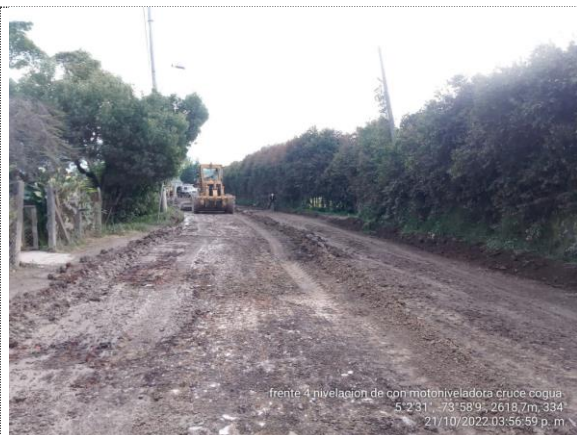
Escarificación y nivelación de vía (21/10/22)
