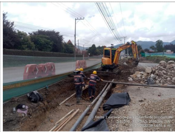
Conectante occidental excavación para estructura de vías en zona de redes de servicios públicos (11/10/22)
