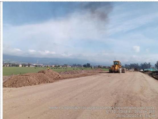
K2+050 – K2+130 escarificación 6ta capa de terraplén por suelo saturado (25/10/22)
