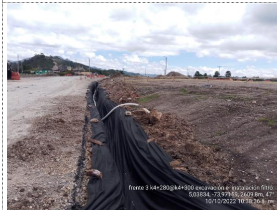
K4+280 – K4+300 excavación e instalación de filtro francés costado derecho (10/10/22)
