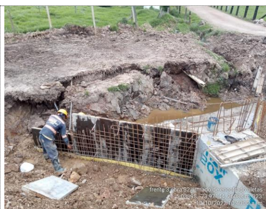
Obra No. 32 Box culvert 1x1 K4+354 armado de acero aletas de encole (10/10/22)
