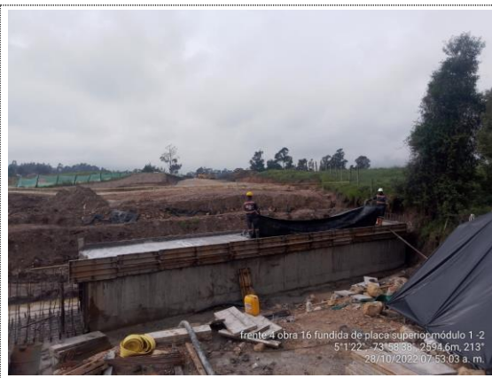
Obra No 16 Box culvert 1.5X1.5 K2+410 fundida de placa superior módulos 1 y 2 (28/10/22)
