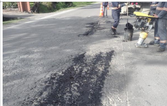
Tapahuecos PR1+0250 - PR2+0750 Y PR8+0600 - PR9+0300 (05/10/22)
