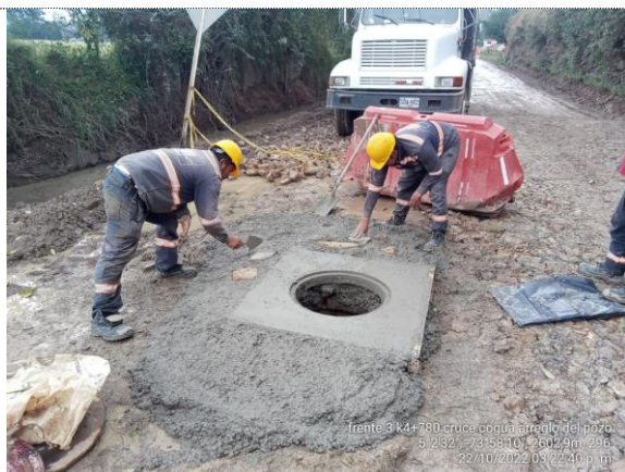
Conformación de vía (22/10/22)
