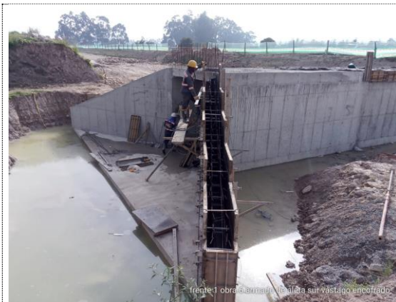
Obra No. 6 Pasaganado 3X3 K1+069 armado de acero aleta sur de encole (05/10/22)
