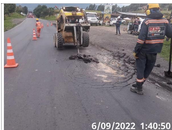
PR44+0300 retiro de carpeta asfáltica margen izquierda (06/09/22)
