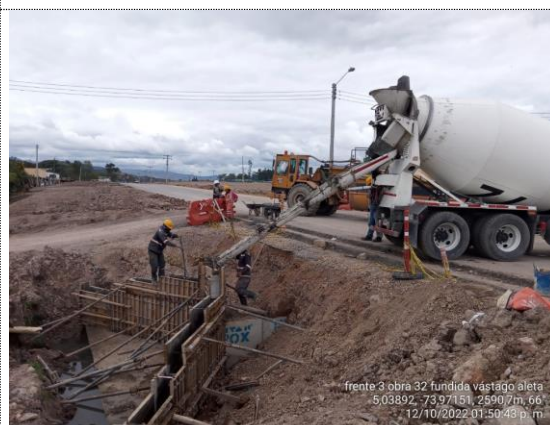
Obra No. 32 Box culvert 1x1 K4+354 fundida de aletas de encole (12/10/22)
