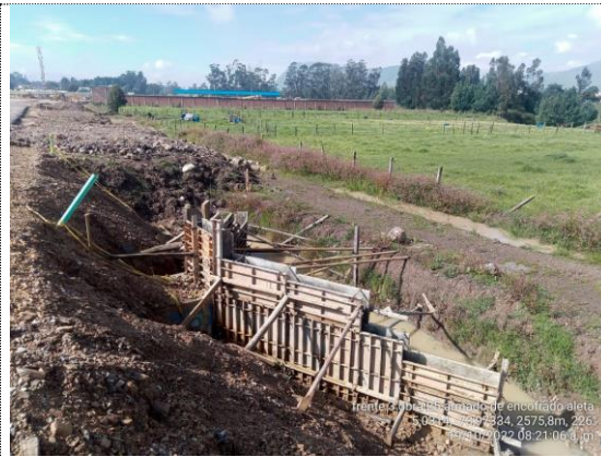
Obra No. 25 Box culvert 1x1 K3+476 armado de acero y encofrado aletas de encole (19/10/22)
