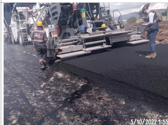
Conectante norte K0+140 – K0+340 instalación de MSC-25 carril derecho, espesor e=1cm (05/10/22)
