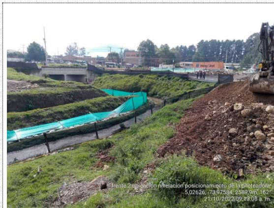
Glorieta Ave Colombiana nivelación de terreno para ubicación de piloteadora río Susagua (21/10/22)
