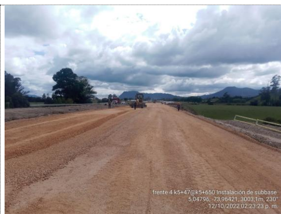
K5+470 – K5+640 instalación de geotextil y subbase granular (12/10/22)
