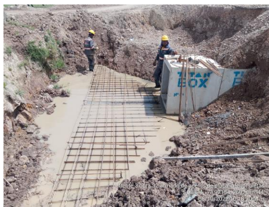
Obra No. 32 Box culvert 1x1 K4+354 armado de acero placa inferior encofe (06/10/22)
