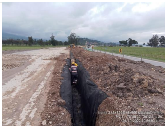
K3+820 – K3+900 excavación e instalación de filtro francés costado derecho (26/10/22)
