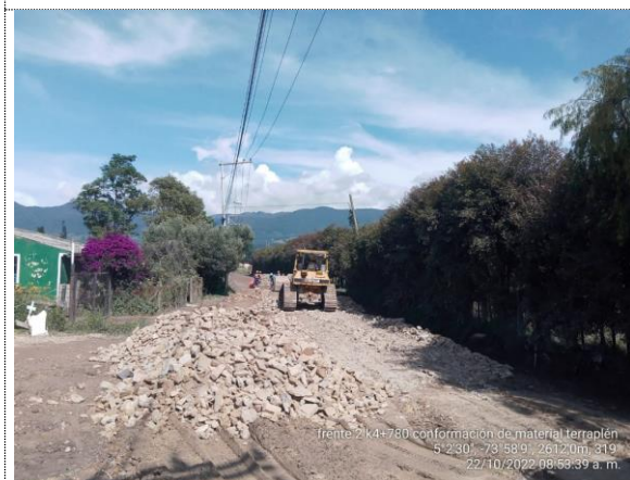
Conformación de vía (22/10/22)
