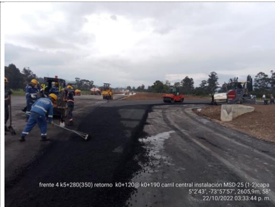
Retorno K5+300, K0+060 – K0+210 instalación MSC-25, espesor e=11cm (22/10/22)
