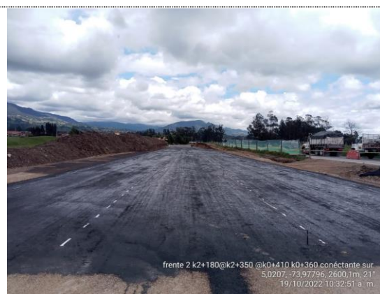
K2+180 – K2+350 instalación de emulsión asfáltica – imprimación (19/10/22)
