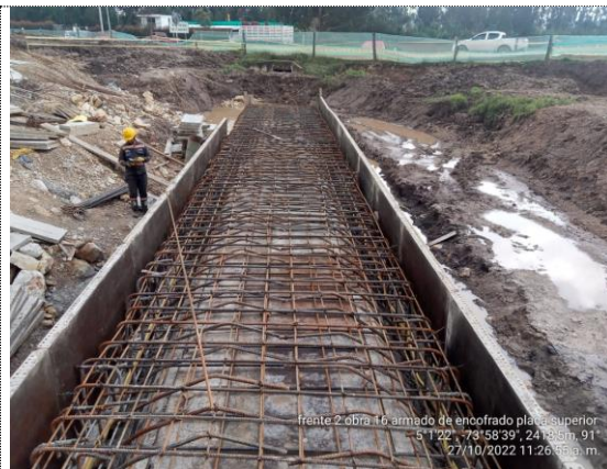
Obra No 16 Box culvert 1.5X1.5 K2+410 armado de acero y encofrado placa superior módulos 1 y 2 (27/10/22)
