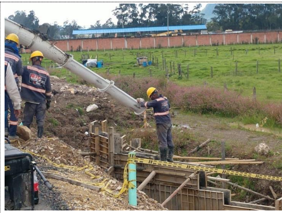
Obra No. 25 Box culvert 1x1 K3+476 fundida de aletas de encole (19/10/22)
