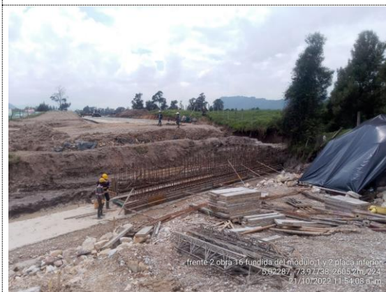
Obra No 16 Box culvert 1.5X1.5 K2+410 fundida de placa inferior módulos 1 y 2 (21/10/22)
