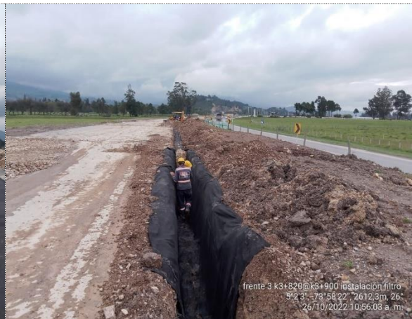
K3+820 - K3+900 EXCAVACIÓN E INSTALACIÓN DE FILTRO FRANCÉS COSTADO DERECHO
