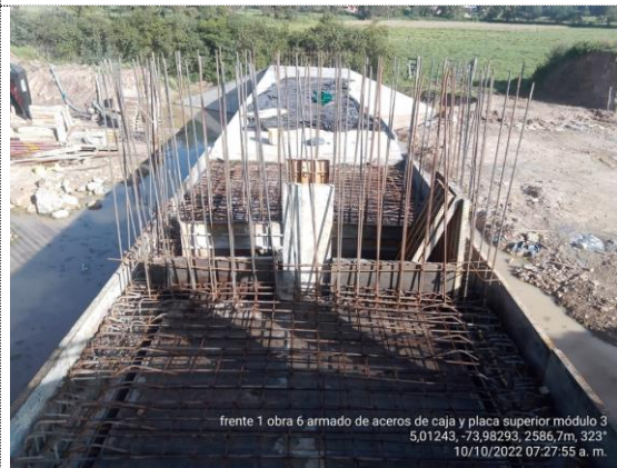
Obra No. 6 Pasaganado 3X3 K1+069 armado de acero y encofrado placa superior módulo 3 (10/10/22)
