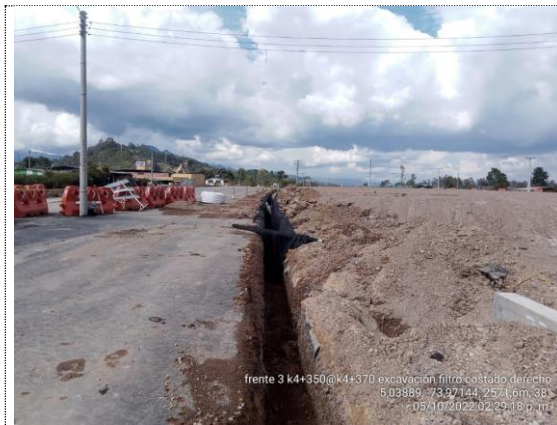
K4+350 – K4+370 excavación e instalación de filtro francés costado derecho (05/10/22)
