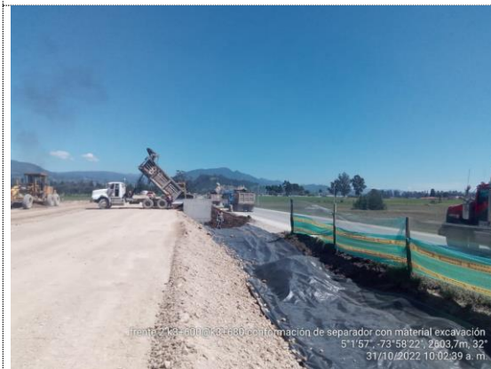
K3+600 – K3+680 conformación de separador con material de excavación (31/10/22)
