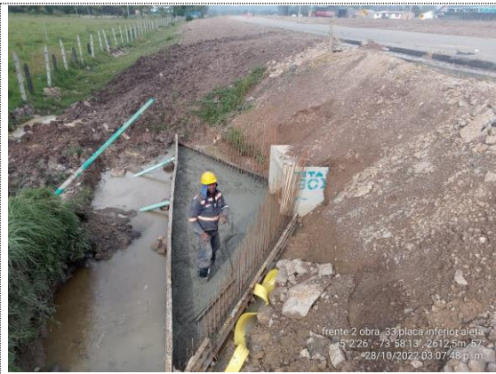
Obra No. 33 Box culvert 1x1 K4+564 fundida de placa inferior encole (28/10/22)
