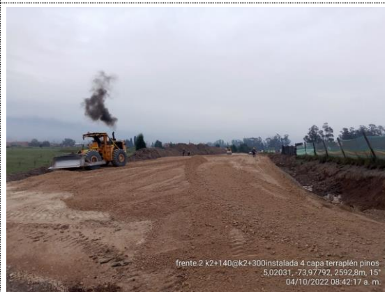
K2+140 – K2+300 instalación 4ta capa de terraplén (04/10/22)
