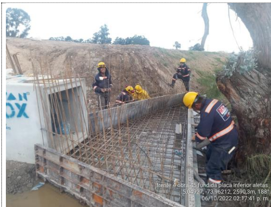
Obra No. 45 Box culvert 1X1 K5+894 fundida de placa inferior encofe (06/10/22)
