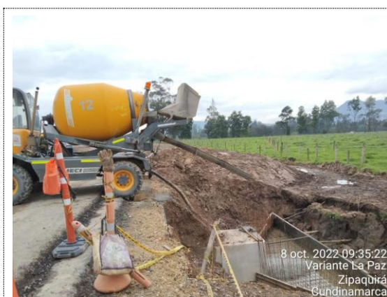
Obra No. 32 Box culvert 1x1 K4+354 fundida de placa inferior encole (08/10/22)
