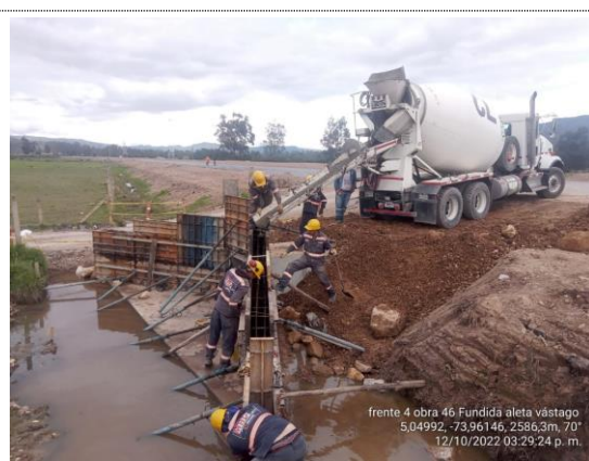
Obra No. 46 Box culvert 1X1 K6+020 fundida de aleta de encole (12/10/22)
