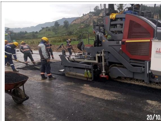
K5+470 – K5+640 instalación de BTA carril izquierdo (20/10/22)
