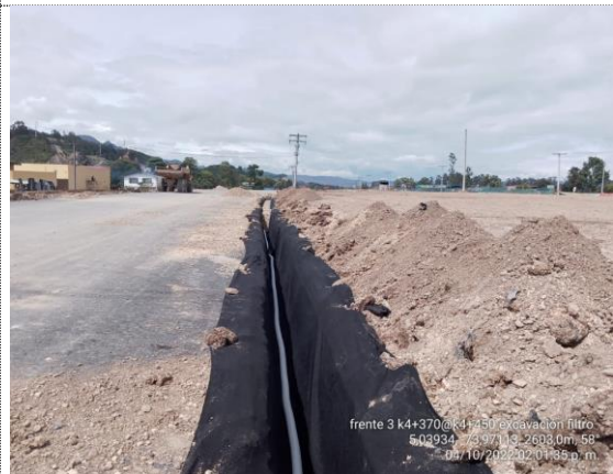
K4+370 – K4+450 excavación e instalación de filtro francés costado derecho (04/10/22)
