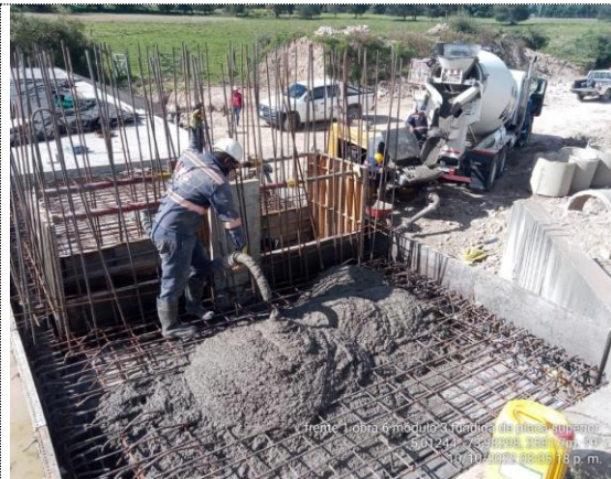
Obra No. 6 Pasaganado 3X3 K1+069 fundida de placa superior módulo 3 (10/10/22)
