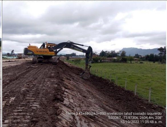
K3+680 - K3+800 NIVELACIÓN DE TALUD COSTADO IZQUIERDO
