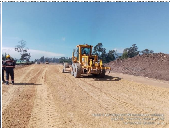
K2+180 - K2+250 INSTALACIÓN DE GEOTEXTIL Y SUBBASE GRANULAR
