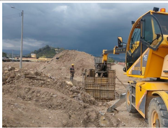
Obra No. 32 Box culvert 1x1 K4+354 fundida de caja intermedia (05/10/22)
