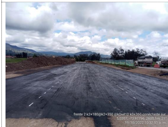
Conectante sur K0+350 – K0+410 instalación de emulsión asfáltica - imprimación (19/10/22)
