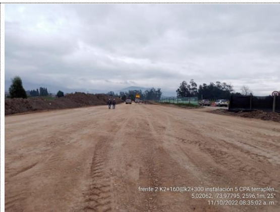
K2+160 – K2+300 instalación 5ta capa de terraplén (11/10/22)
