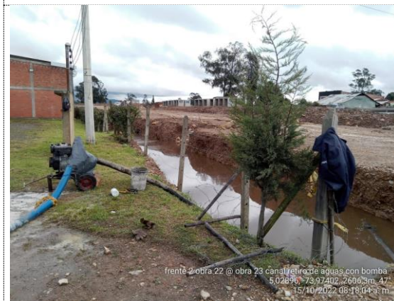
Conectante norte K0+050 – K0+130 retiro de aguas empozadas en canal longitudinal obra No 23 (15/10/22)
