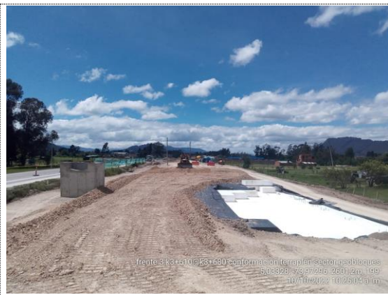
K3+610 – K3+680 instalación de terraplén en sector geobloques (10/10/22)
