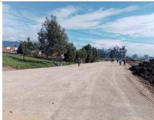
Conectante sur K0+230 – K0+330 nivelación de subbase granular (24/10/22)
