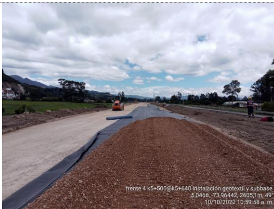
K5+500 – K5+640 instalación de geotextil y subbase granular (10/10/22)
