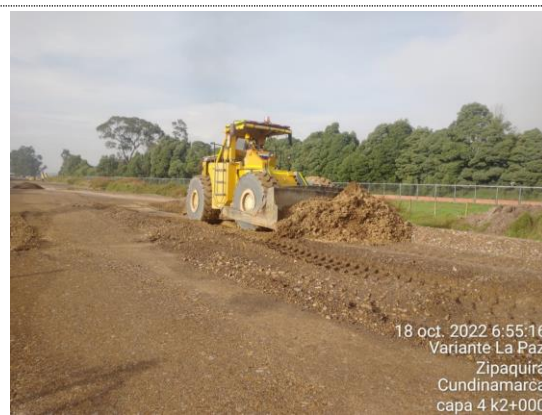
K1+900 – K2+000 instalación de 4ta capa de terraplén (18/10/22)
