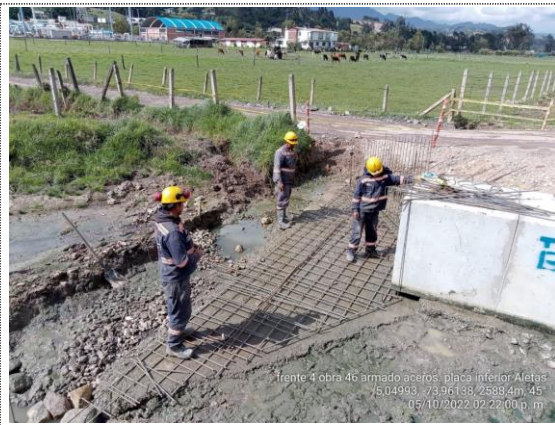
Obra No. 46 Box culvert 1X1 K6+020 armado de acero placa inferior encole (05/10/22)
