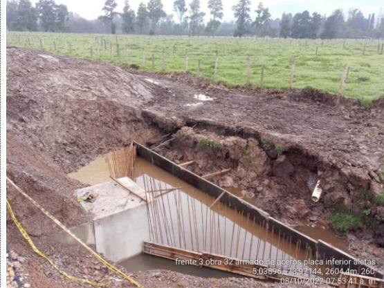
Obra No. 32 Box culvert 1x1 K4+354 armado de acero placa inferior encofe (08/10/22)
