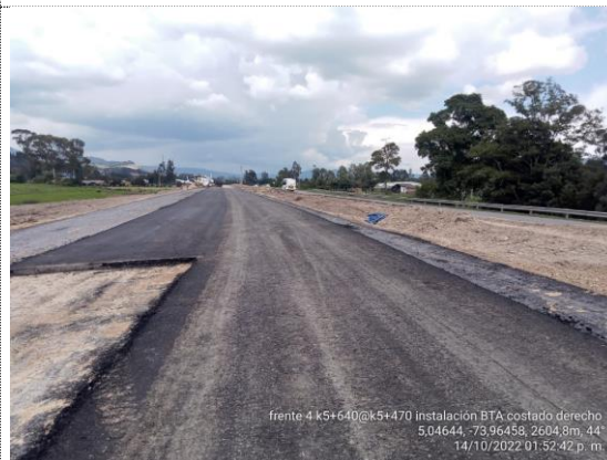
K5+470 – K5+640 instalación de BTA carril derecho (14/10/22)
