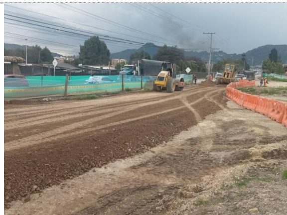
Adecuación del terreno para desvío provisional (25/10/22)
