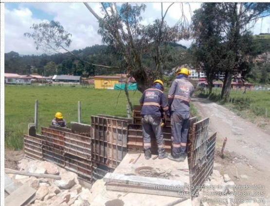
Obra No. 45 Box culvert 1X1 K5+894 armado de acero y encofrado aletas de encofe (14/10/22)
