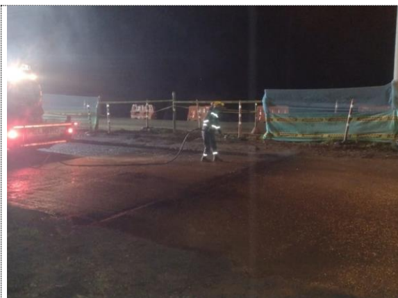
Instalación de emulsión asfáltica (25/10/22)
