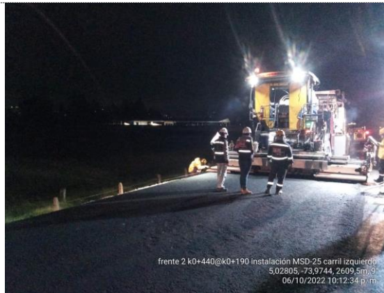
Conectante norte K0+210 – K0+440 instalación MSC-25 carril izquierdo, espesor e=11cm (06/10/22)
