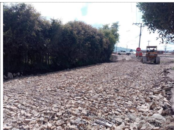
Conformación de vía (22/10/22)
