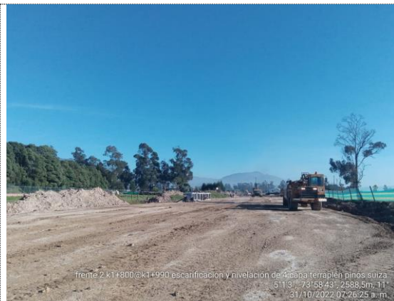
K1+800 – K2+000 nivelación 4ta capa de terraplén (31/10/22)
