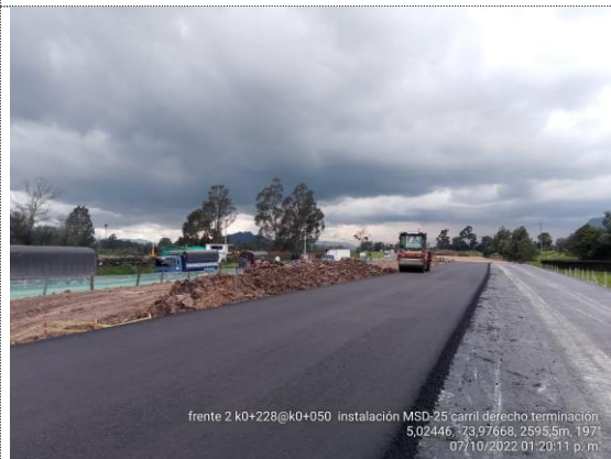
Conectante sur K0+050 – K0+228 instalación MSC-25 carril derecho, espesor e=11cm (07/10/22)
