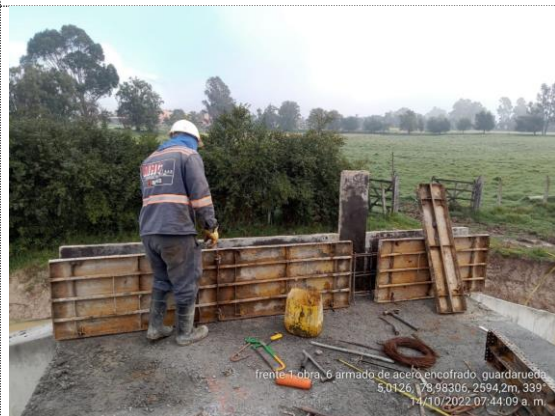
Obra No. 6 Pasaganado 3X3 K1+069 armado de acero y encofrado guardarrueda (14/10/22)
