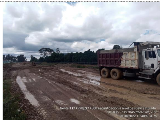
K1+800 – K2+000 escarificación de terraplén por suelo saturado (18/10/22)
