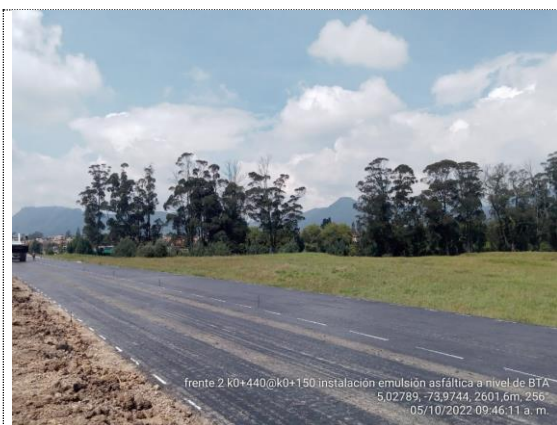
Conectante norte K0+150 – K0+440 instalación de riego de liga (05/10/22)
