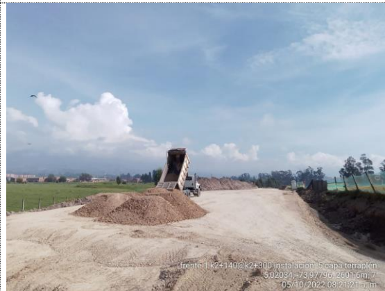
K2+140 – K2+300 instalación 5ta capa de terraplén (05/10/22)
