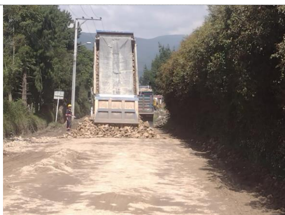
Instalación y compactación de material reciclado (25/10/22)
