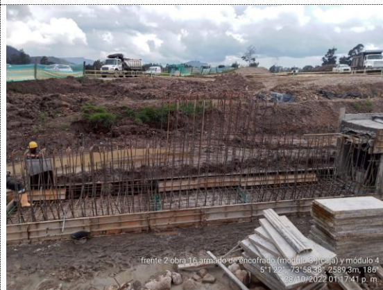
Obra No 16 Box culvert 1.5X1.5 K2+410 armado de acero y encofrado placa inferior módulos 3 y 4 (28/10/22)
