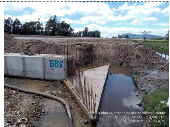
Obra No. 46 Box culvert 1X1 K6+020 armado de acero aletas de encole (10/10/22)
