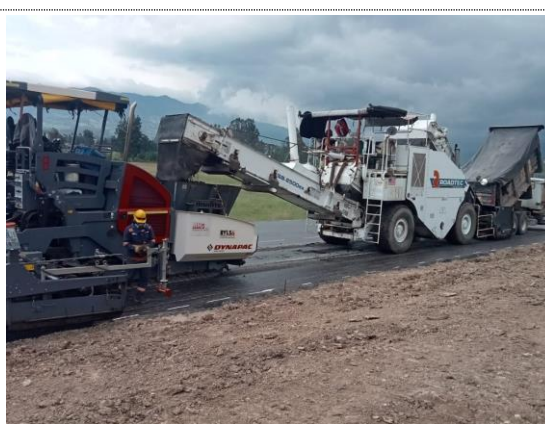
Conectante norte K0+140 – K0+340 instalación de MSC-25 carril derecho, espesor e=1cm (05/10/22)
