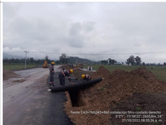
K3+760 – K3+820 excavación e instalación de filtro francés costado derecho (27/10/22)
