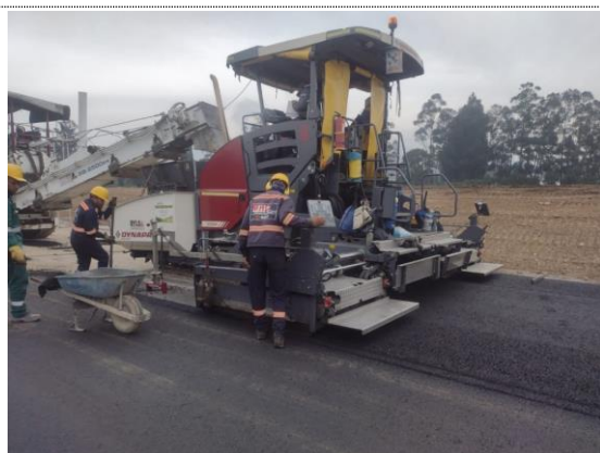
K5+230 – K5+380 instalación de 2da capa de MSC-25 carril derecho, espesor e=5cm (13/10/22)
