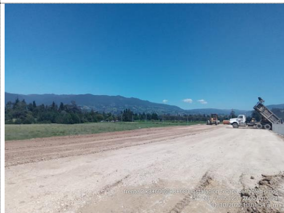
K3+600 – K3+680 instalación 5ta capa de terraplén (31/10/22)
