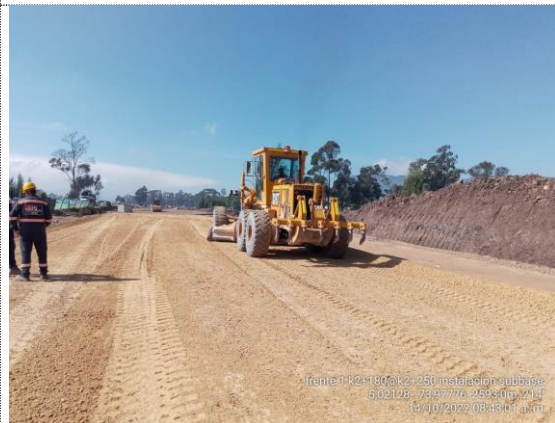
K2+180 – K2+550 instalación de geotextil y subbase granular (14/10/22)
