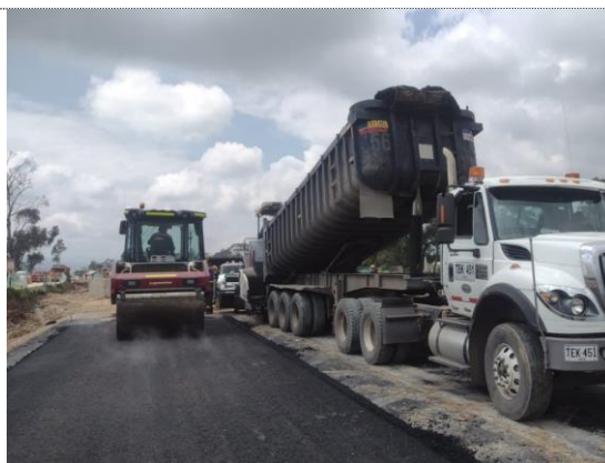
Conectante sur K0+380 – K0+410 instalación de BTA carril central e izquierdo (21/10/22)
