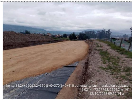
Conectante sur K0+380 – K0+410 instalación de geotextil y subbase granular (12/10/22)
