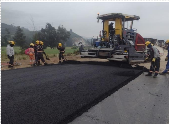
K5+230 - K5+380 INSTALACIÓN DE 2DA CAPA DE MSC-25, ESPESOR E=5CM
