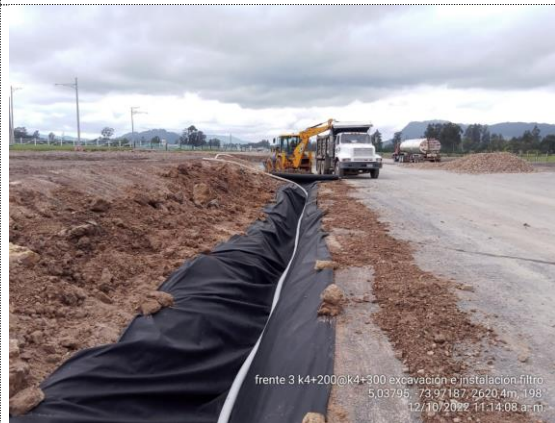
K4+200 – K4+280 excavación e instalación de filtro francés costado derecho (12/10/22)
