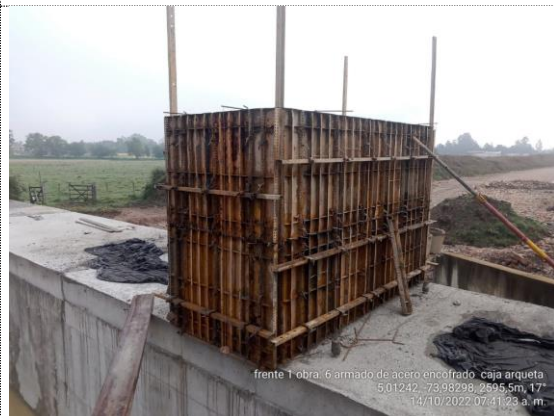
Obra No. 6 Pasaganado 3X3 K1+069 armado de acero y encofrado caja de ventilación (14/10/22)
