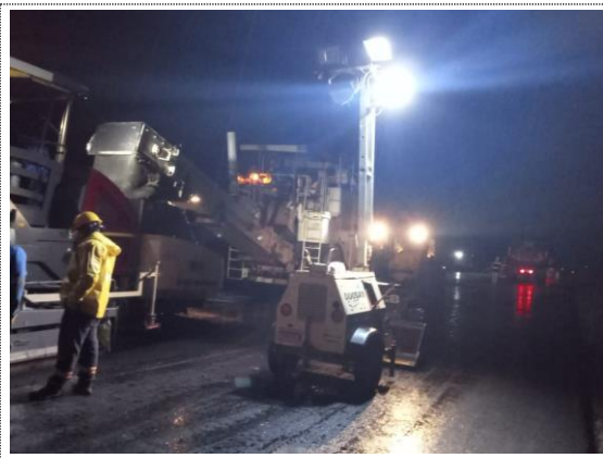
Conectante norte K0+210 – K0+440 instalación MSC-25 carril izquierdo, espesor e=11cm (06/10/22)
