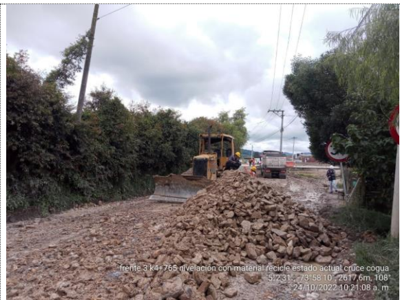
Nivelación de la vía con material reciclado (24/10/22)
