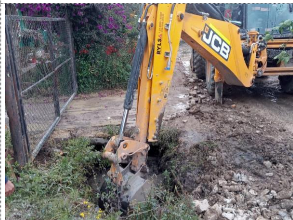
Limpeza de cuneta frente a predio (24/10/22)
