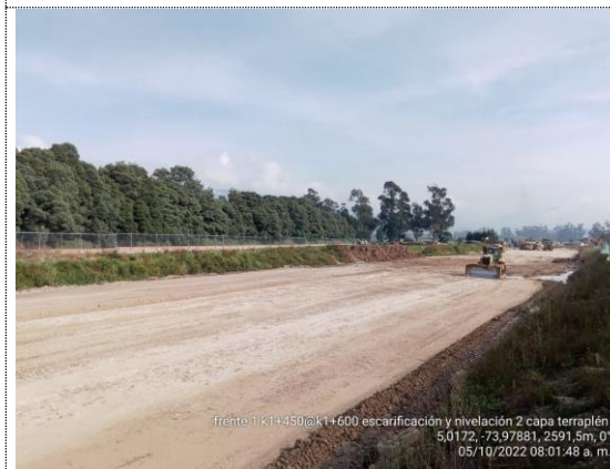
K1+450 – K1+600 escarificación y nivelación 2da capa de terraplén (05/10/22)
