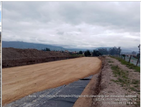
K2+260 - K2+350 INSTALACIÓN DE GEOTEXTIL Y SUBBASE GRANULAR
