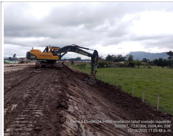
K3+680 – K3+800 nivelación de talud costado izquierdo (12/10/22)
