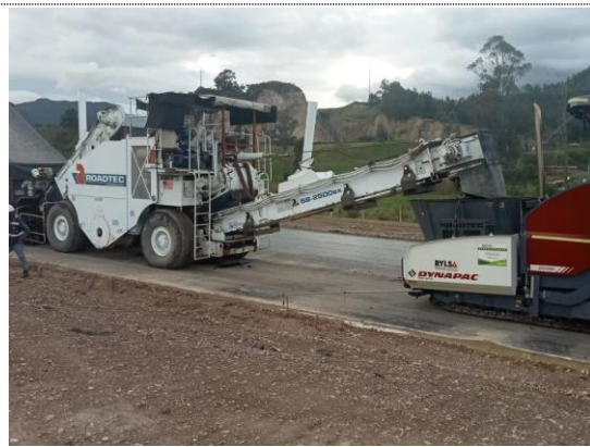
K5+650 – K5+705 instalación MSC-25 carril izquierdo, espesor e=11cm (24/10/22)
