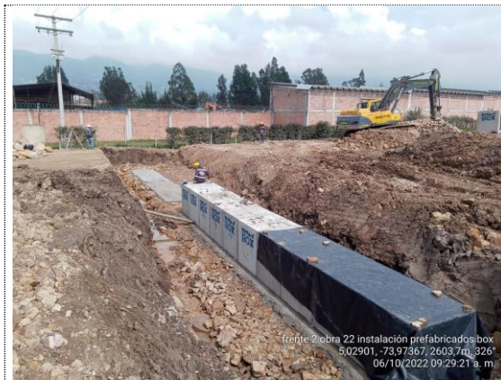
Obra No. 22 Box culvert 1x1 K3+220 excavación e instalación de pedraplén (04/10/22)
