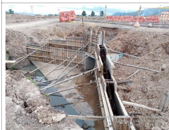
Obra No. 32 Box culvert 1x1 K4+354 armado de acero y encofrado de aletas de encole (12/10/22)
