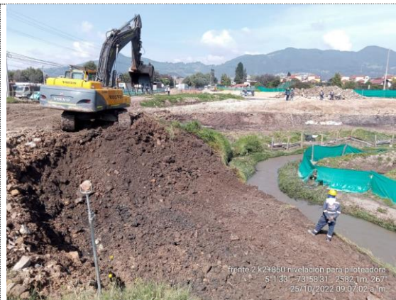
Glorieta Ave Colombiana nivelación de terreno para ubicación de piloteadora río Susagua (22/10/22)
