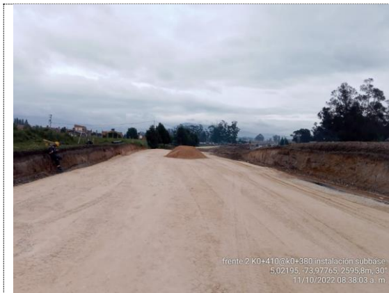
Conectante sur K0+380 – K0+410 instalación de geotextil y subbase granular (11/10/22)
