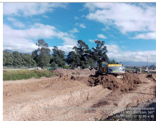
K1+800 – K1+900 escarificación 2da capa de terraplén por suelo saturado (10/10/22)
