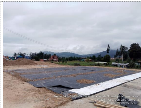
K3+624 – K3+632 instalación 3er capa de geobloques (última) (01/10/22)
