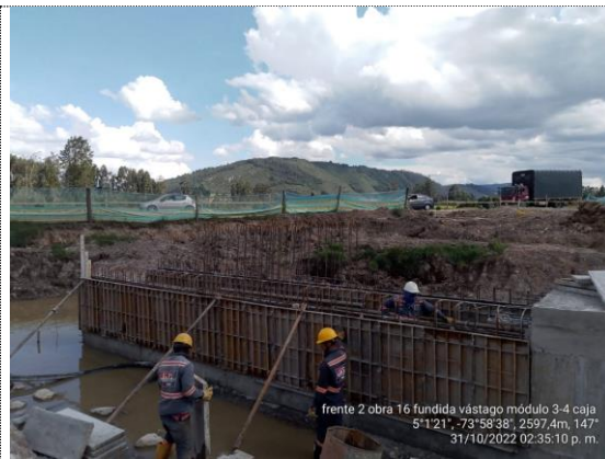
Obra No 16 Box culvert 1.5X1.5 K2+410 armado de acero y encofrado muros módulos 3 y 4 (31/10/22)
