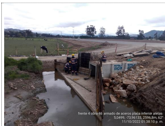
Obra No. 46 Box culvert 1X1 K6+020 armado de acero aletas de encole (11/10/22)
