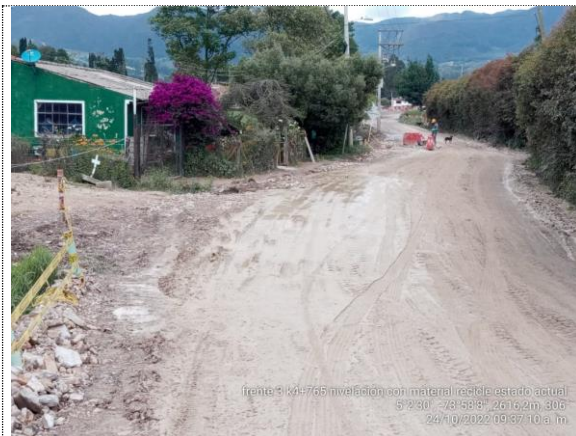
Nivelación de la vía con material reciclado (24/10/22)
