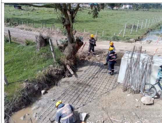
Obra No. 45 Box culvert 1X1 K5+894 armado de acero placa inferior encole (05/10/22)
