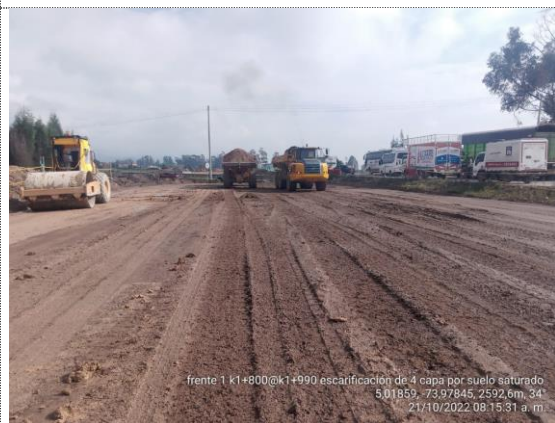
K1+800 – K2+000 escarificación 4ta capa de terraplén por suelo saturado (21/10/22)
