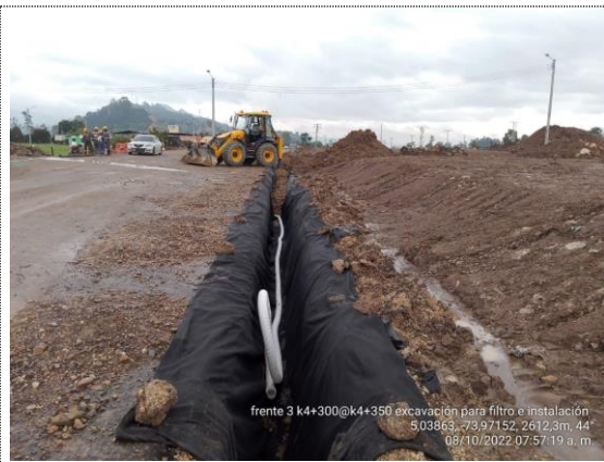
K4+300 – K4+350 excavación e instalación de filtro francés costado derecho (08/10/22)
