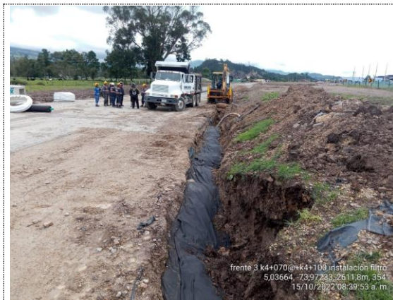
K4+070 – K4+100 excavación e instalación de filtro francés costado derecho (15/10/22)
