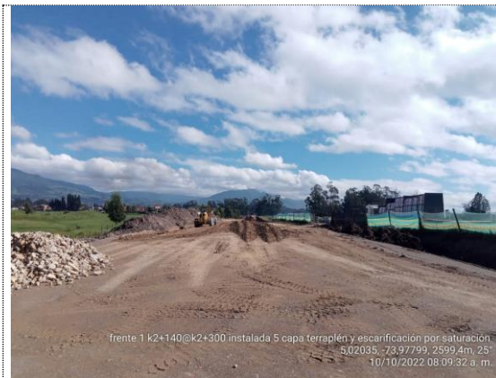
K2+140 – K2+300 escarificación 5ta capa de terraplén por saturación (10/10/22)
