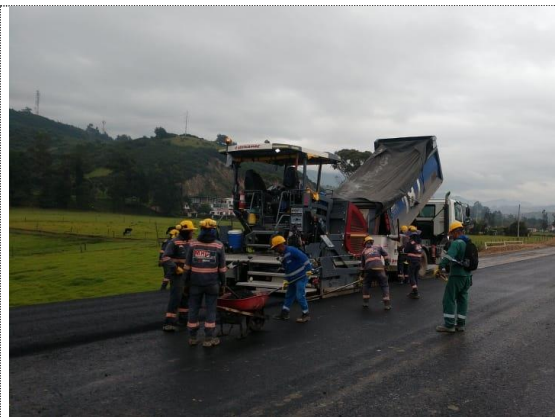
K5+470 – K5+640 instalación de BTA carril izquierdo (20/10/22)
