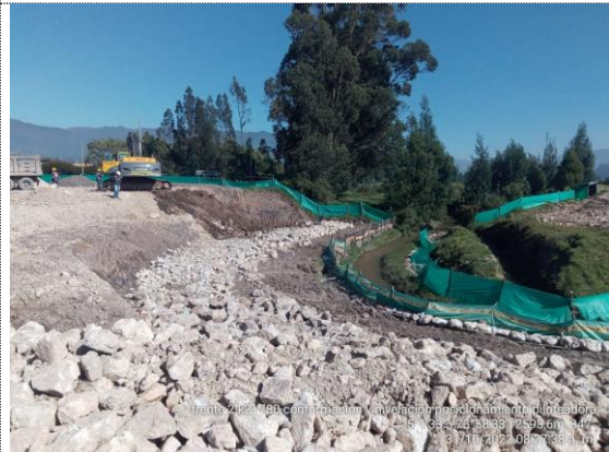
Glorieta Ave Colombiana conformación y nivelación de terreno para instalación piloteadora (31/10/22)
