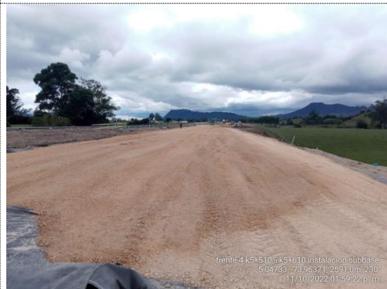
K5+500 – K5+610 instalación de geotextil y subbase granular (11/10/22)
