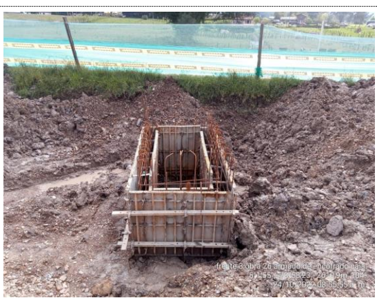
Obra No. 26 Box culvert 1x1 K3+568 armado de acero y encofrado caja arqueta, segunda sección (24/10/22)
