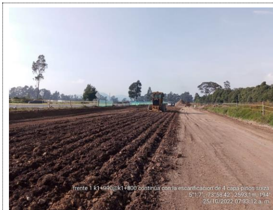
K1+800 – K2+000 escarificación 4ta capa de terraplén por suelo saturado (25/10/22)
