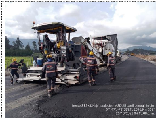
K3+324 – K3+490 instalación de MSC-25 carril central, espesor e=11cm (26/10/22)
