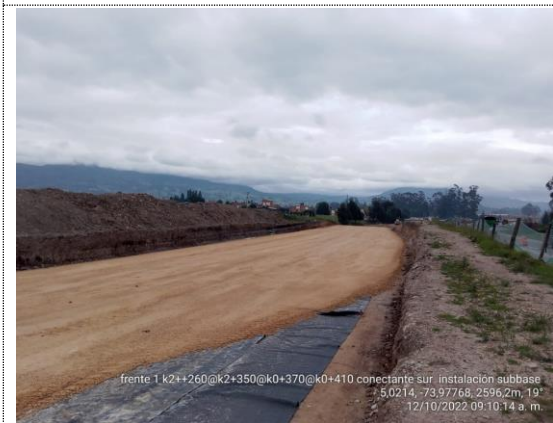
K2+260 – K2+350 instalación de geotextil y subbase granular (12/10/22)
