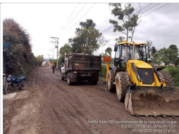
Conformación de vía (21/10/22)
