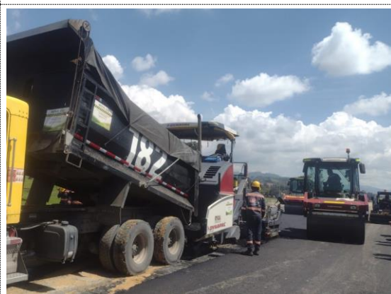
K5+470 – K5+640 instalación de BTA carril derecho (14/10/22)
