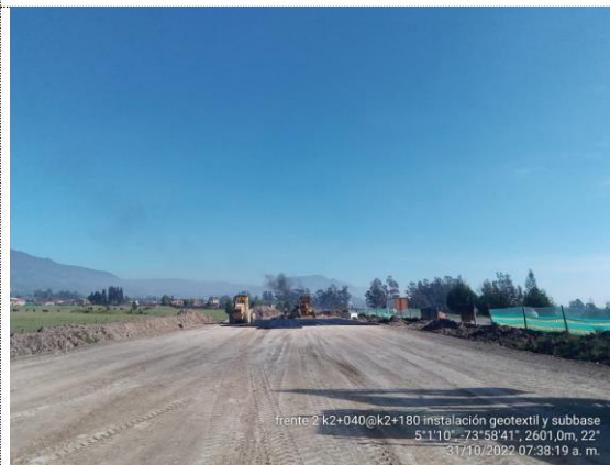
K2+040 – K2+180 continúa instalación de geotextil y subbase granular (31/10/22)
