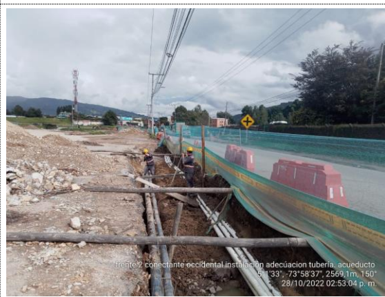
Conectante occidental instalación y adecuación tubería de acueducto (28/10/22)
