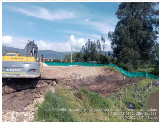
Glorieta Ave Colombiana excavación y nivelación de terreno para ubicación de piloteadora río Susagua (22/10/22)
