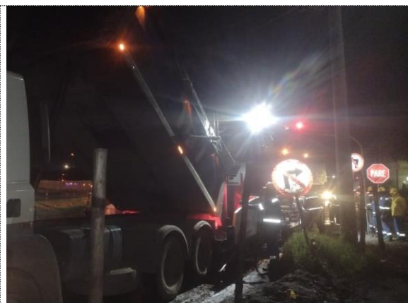
Instalación y compactación de BTA (25/10/22)
