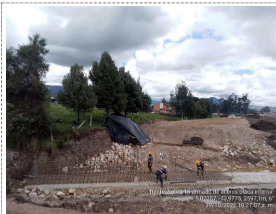
Obra No 16 Box culvert 1.5X1.5 K2+410 armado de acero placa inferior módulos 1 y 2 (19/10/22)
