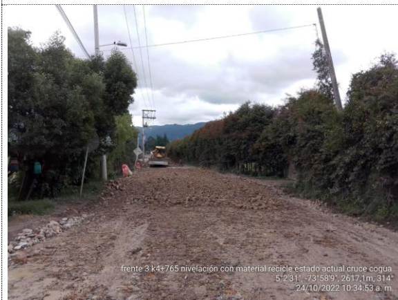
Nivelación de la vía con material reciclado (24/10/22)
