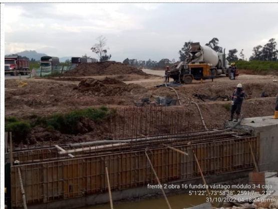
Obra No 16 Box culvert 1.5X1.5 K2+410 fundida muros módulos 3 y 4 (31/10/22)
