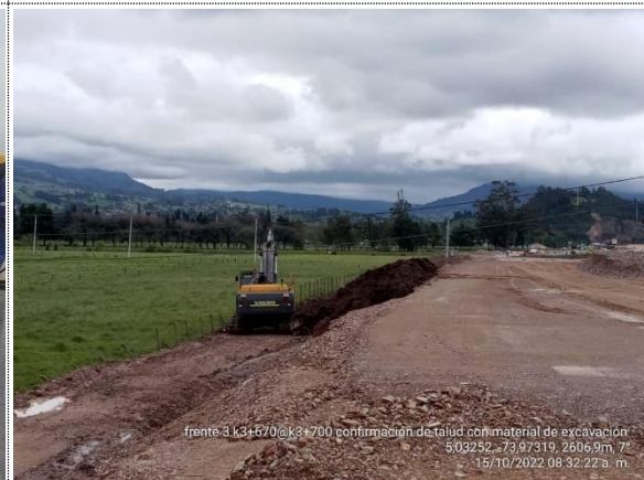
K3+670 - K3+700 CONFORMACIÓN DE TALUD CON MATERIAL DE EXCAVACIÓN
