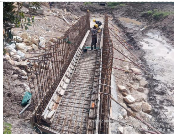
Obra No 16 Box culvert 1.5X1.5 K2+410 armado de acero placa inferior módulos 1 y 2 (21/10/22)
