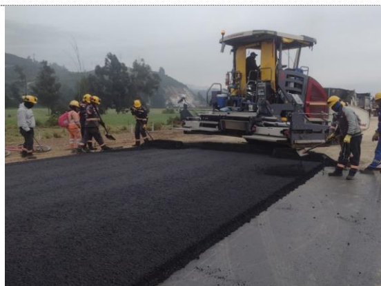
K5+230 – K5+380 instalación de 2da capa de MSC-25 carril izquierdo, espesor e=5cm (13/10/22)
