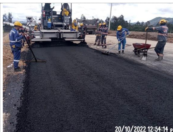
K2+200 – K2+350 instalación y compactación de BTA carril derecho (20/10/22)
