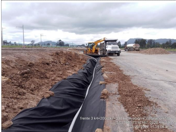
K4+200 - K4+280 EXCAVACIÓN E INSTALACIÓN DE FILTRO FRANCÉS
