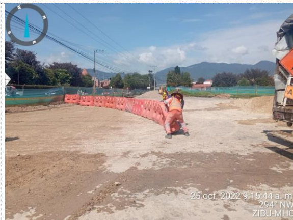
Cerramiento para desvío provisional en cruce Ave Colombiana (25/10/22)
