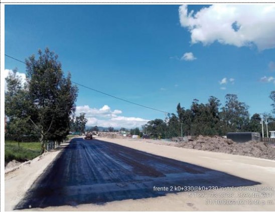
Conectante sur K0+230 – K0+330 instalación de emulsión asfáltica - imprimación (31/10/22)
