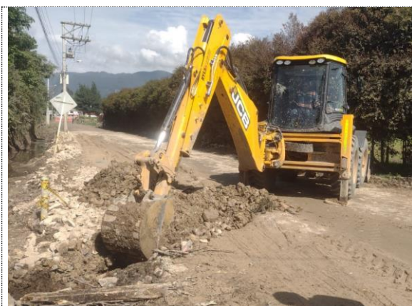
Excavación para instalación de tubería de 18" (25/10/22)
