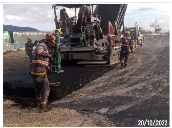
Conectante sur K0+380 – K0+410 instalación de BTA carril derecho (20/10/22)
