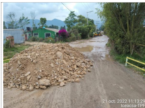
Instalación de material en vía (21/10/22)
