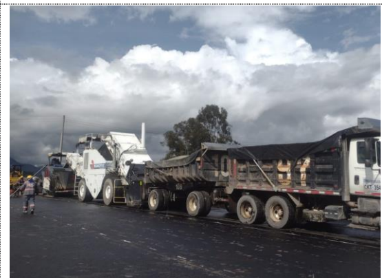
K3+322 – K3+490 instalación de MSC-25 carril derecho, espesor e=11cm (26/10/22)
