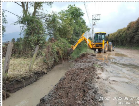
Limpieza de cuneta (21/10/22)
