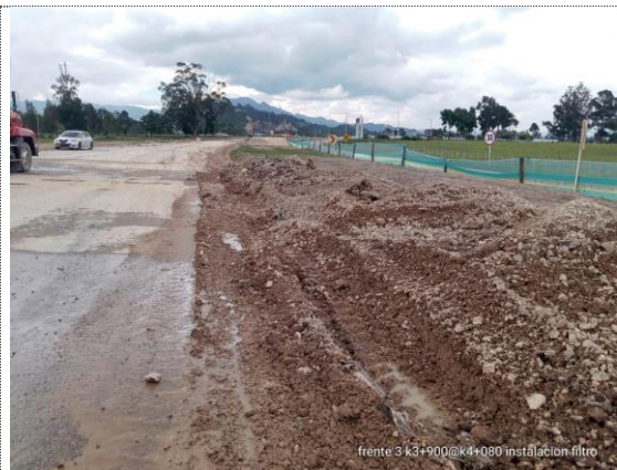
K3+900 - K4+070 excavación e instalación de filtro francés costado derecho (21/10/22)
