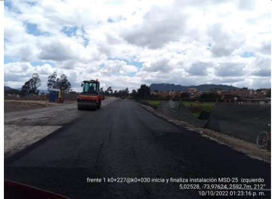
Conectante sur K0+030 – K0+228 instalación MSC-25 carril izquierdo, espesor e=11cm (10/10/22)
