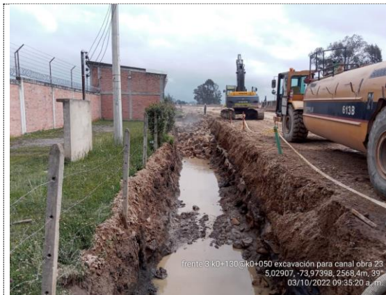
Conectante norte K0+050 – K0+130 excavación para canal longitudinal obra No 23 (03/10/22)
