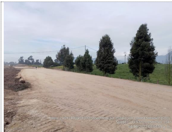
Conectante sur K0+240 – K0+330 instalación corona de terraplén (04/10/22)
