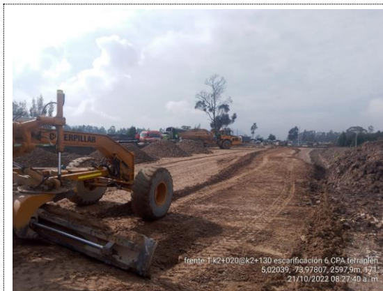
K2+020 – K2+130 escarificación de 6ta capa de terraplén por suelo saturado (21/10/22)
