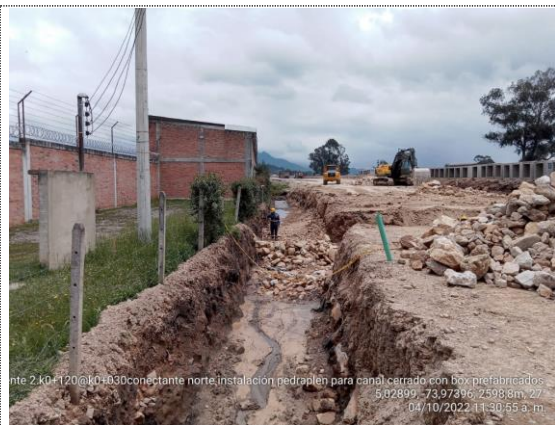
Conectante norte K0+050 – K0+130 instalación de pedraplén para canal cerrado (04/10/22)
