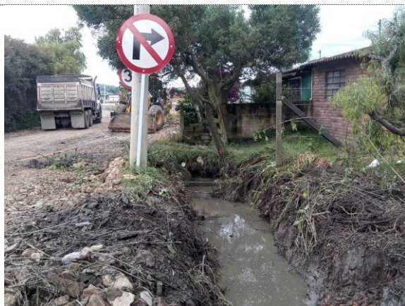
Limpeza de cuneta frente a predio (24/10/22)
