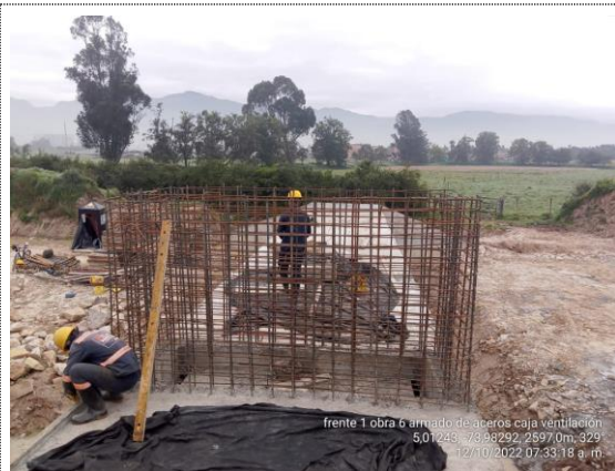
Obra No. 6 Pasaganado 3X3 K1+069 armado de acero caja de ventilación (12/10/22)
