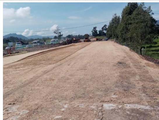
Conectante sur K0+230 – K0+330 instalación de subbase granular (22/10/22)
