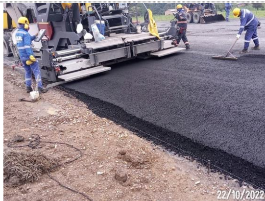
Retorno K5+300, K0+210 – K5+095 instalación 2da capa de MSC-25, espesor e=5cm (22/10/22)
