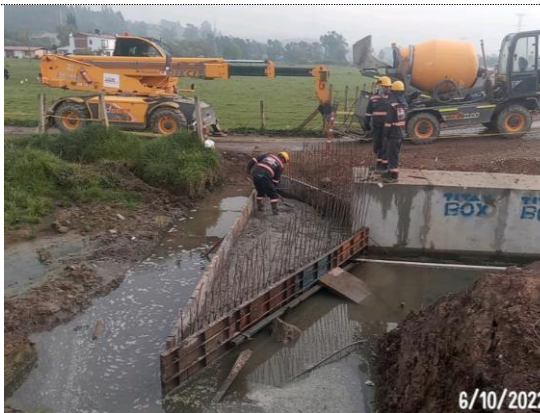
Obra No. 46 Box culvert 1X1 K6+020 fundida de placa inferior encole (06/10/22)
