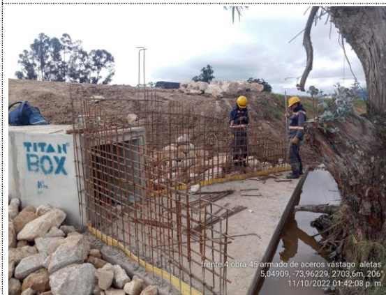
Obra No. 45 Box culvert 1X1 K5+894 armado de acero aletas de encofe (11/10/22)
