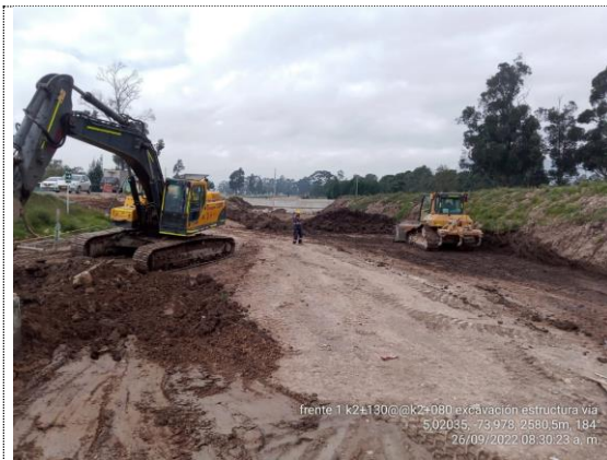
K2+080 – K2+100 excavación para estructura de vía (26/09/22)
