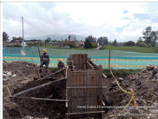
Obra No. 25 Box culvert 1x1 K3+476 armado de acero y encofrado caja arqueta (23/09/22)
