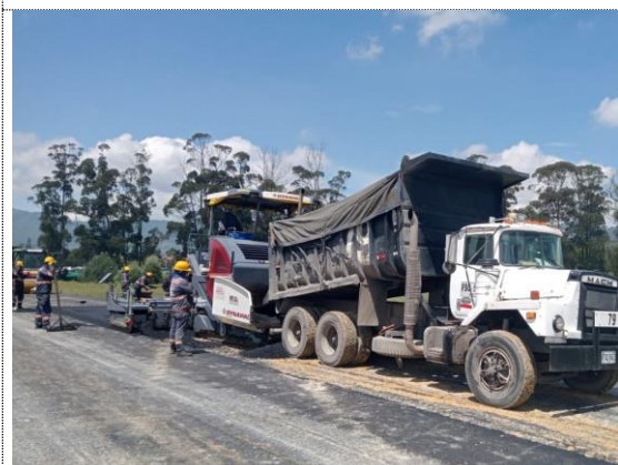
Conectante norte K0+140 – K0+280 instalación de BTA carril izquierdo (13/09/22)
