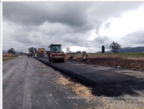
Conectante norte K0+200 – K0+340 instalación de BTA (09/09/22)
