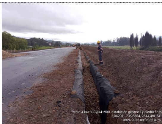
K4+800 – K4+900 instalación de filtro francés costado derecho (10/09/22)
