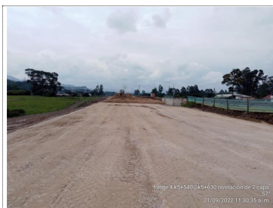
K5+540 – K5+630 nivelación 2da capa de terraplén (21/09/22)
