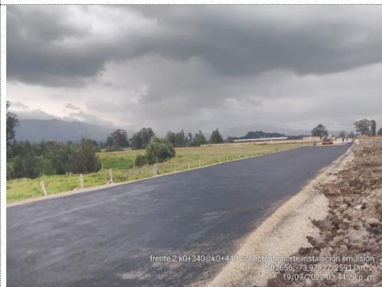
Conectante norte K0+340 – K0+440 instalación de emulsión asfáltica – imprimación (19/09/22)
