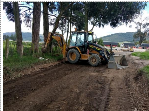
Escarificación, nivelación e instalación de material de fresado (14/09/22)
