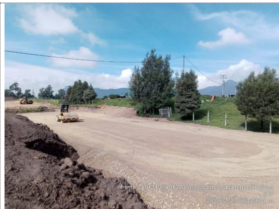
Conectante sur K0+270 – K0+340 instalación 3er capa de terraplén (20/09/22)
