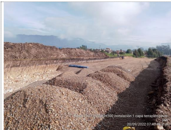
K2+280 – K2+300 instalación 1er capa de terraplén (20/09/22)
