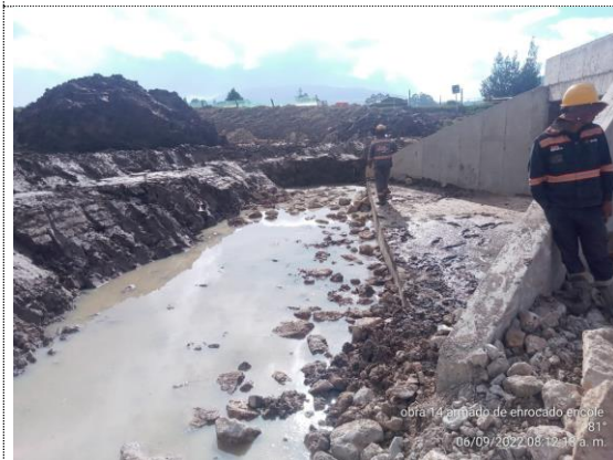
Obra No. 14 Box culvert 2X2 K2+014 adecuación de terreno para fundir el enrocado en encole (06/09/22)
