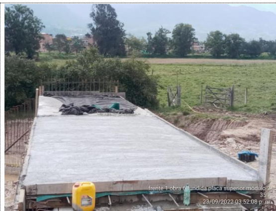
Obra No. 6 Pasaganado 3X3 K1+069 fundida de placa superior módulo 2 (23/09/22)
