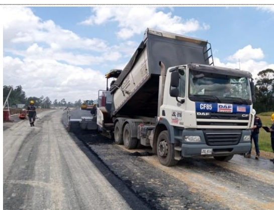
Conectante norte K0+140 – K0+280 instalación de BTA carril izquierdo (13/09/22)
