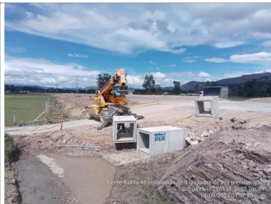
Obra No. 46 Box culvert 1X1 K6+020 prolongación de box culvert (14/09/22)
