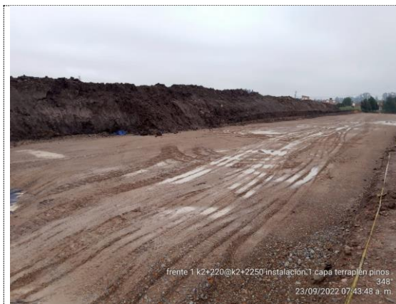
K2+220 – K2+250 instalación 1er capa de terraplén (23/09/22)
