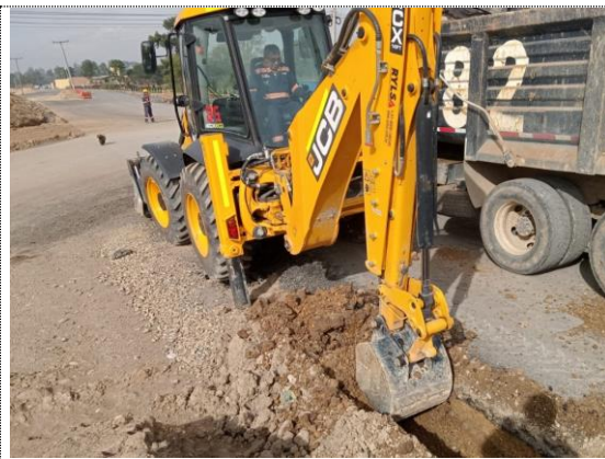
K4+750 – K4+820 excavación para filtro francés costado derecho (19/09/22)
