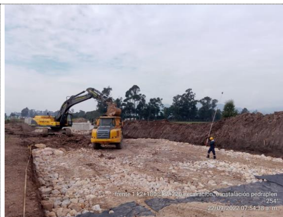
K2+180 – K2+220 excavación e instalación de pedraplén (22/09/22)
