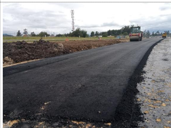
Conectante norte K0+200 – K0+340 instalación de BTA (09/09/22)
