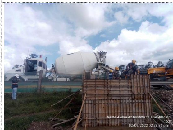
Obra No. 42 Pasa ganado 3x3 K5+595 fundida de caja de ventilación (02/09/22)
