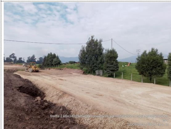
Conectante sur K0+280 – K0+340 instalación de 5ta. capa de terraplén (22/09/22)
