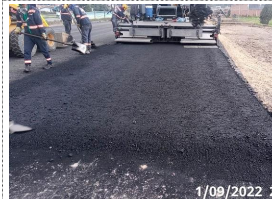
K3+310 – K3+360 instalación y compactación de BTA (01/09/22)
