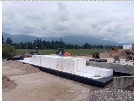
K3+630 – K3+627 instalación 1er capa de geobloques (22/09/22)
