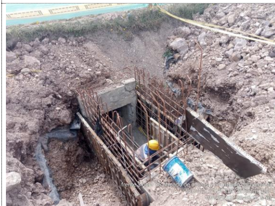
Obra No. 25 Box culvert 1x1 K3+476 armado de acero y encofrado caja arqueta (19/09/22)
