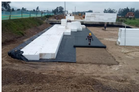
K3+645 – K3+670 inicia instalación 1er capa de geobloques (24/09/22)
