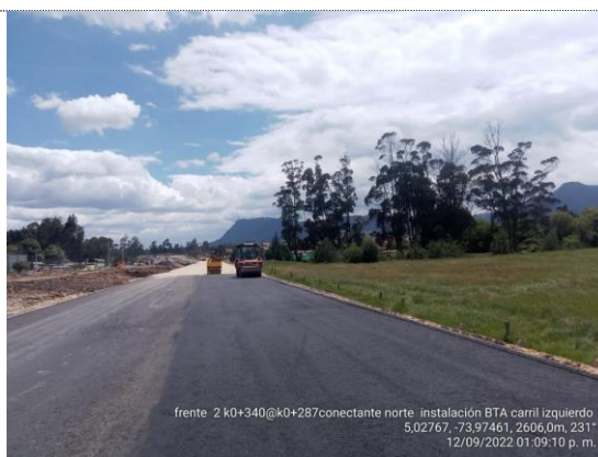
Conectante norte K0+140 – K0+340 instalación de BTA (12/09/22)
