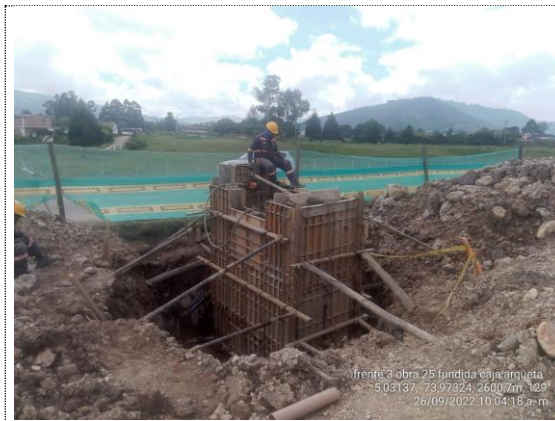
Obra No. 25 Box culvert 1x1 K3+476 fundida de caja arqueta (26/09/22)
