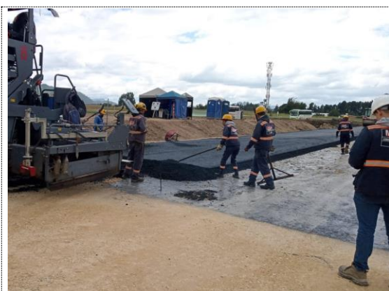
Conectante norte K0+140 – K0+340 instalación de BTA (12/09/22)
