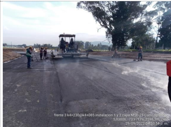
K4+080 – K4+230 instalación de MSC-25, espesor e=11cm (29/09/22)
