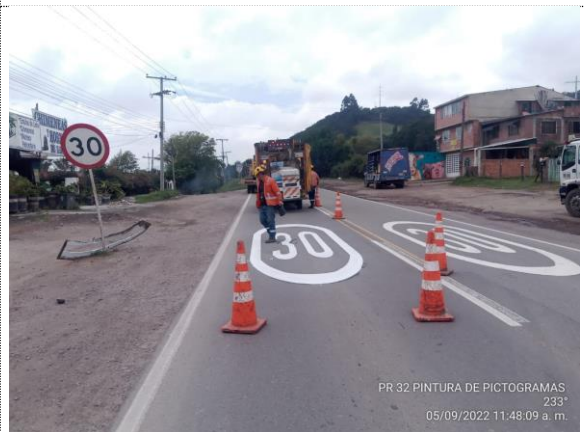
PR28+0200 – PR28+0400 demarcación pictogramas de velocidad máxima permitida (05/09/22)
