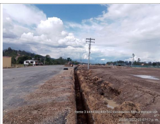
K4+450 – K4+560 excavación e instalación de filtro francés costado derecho (23/09/22)
