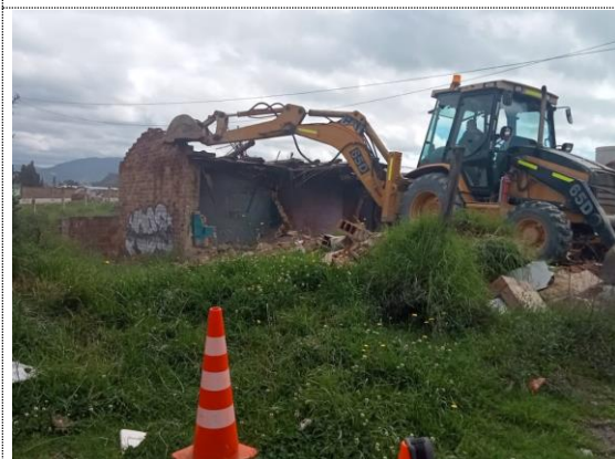
Conectante oriental demolición de viviendas para construcción de glorieta (03/09/22)
