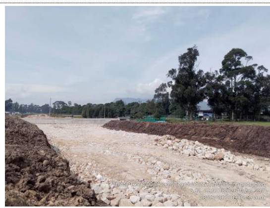
K2+016 – K2+070 instalación de pedraplén (28/09/22)
