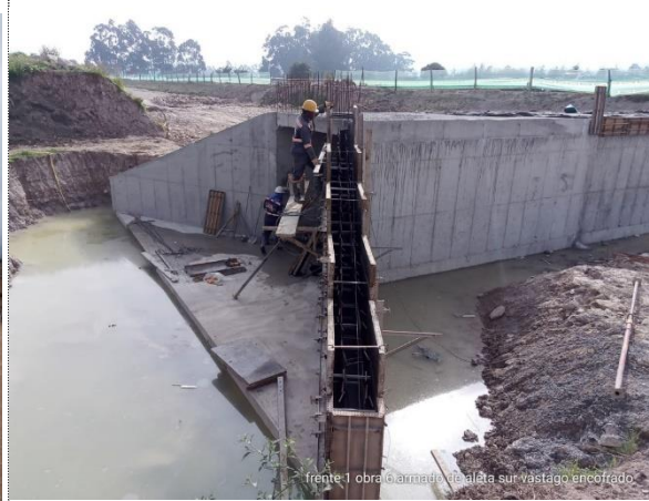
OBRA NO 6 ARMADO DE ACERO ENCOFRADO Y FUNDIDA DE ALETA SUR DE ENCOLE
