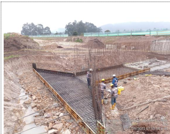
Obra No. 6 Pasaganado 3X3 K1+069 armado de acero y encofrado placa inferior de encofrado y módulo 1 (01/09/22)
