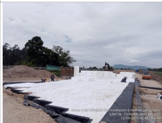
K5+550 – K5+588 instalación 6ta capa de geobloques (última) (12/09/22)
