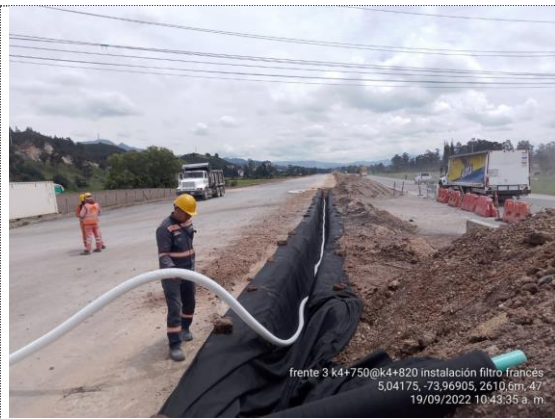
K4+750 – K4+820 instalación de filtro francés costado derecho (19/09/22)
