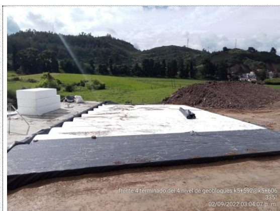
K5+600 – K5+620 finaliza instalación de 4ª. capa de geobloques (02/09/22)
