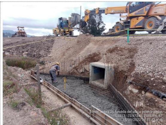
Obra No. 25 Box culvert 1x1 K3+476 fundida de placa inferior de encofe (15/09/22)
