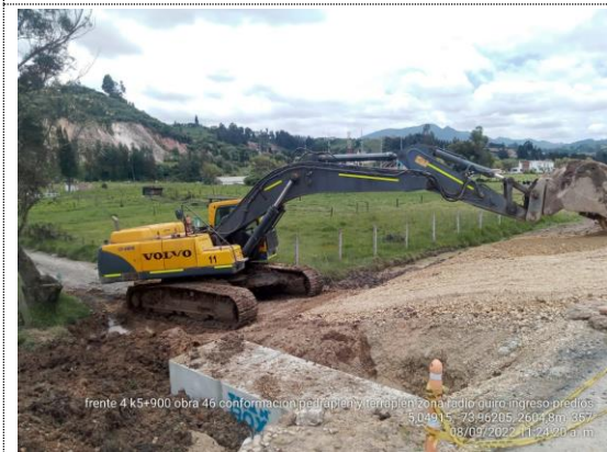
Obra No. 45 Box culvert 1X1 K5+894 prolongación de box y adecuación de ingreso a predios (08/09/22)
