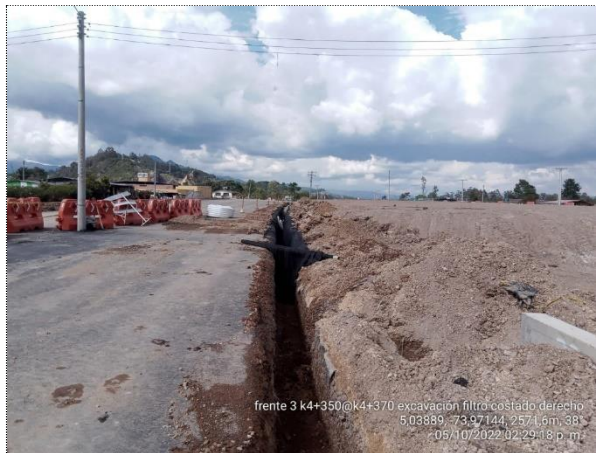
K4+350 - K4+370 EXCAVACIÓN E INSTALACIÓN DE FILTRO FRANCÉS COSTADO DERECHO
