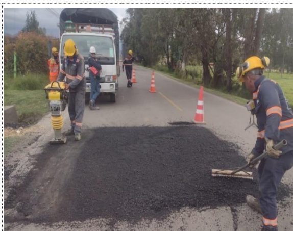
JORNADA TAPAHUECOS RUTA 45 A 05, UBATÉ - CHIQUINQUIRÁ ENTRE PR1+0250 Y PR2+0750; PR8+0600 Y PR9+0300
