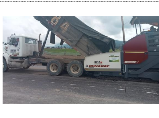
K3+830 – K3+968 instalación y compactación MSC-25 e=11cm (24/09/22)
