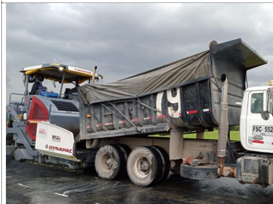
K3+730 – K3+968 instalación y compactación MSC-25 e=11cm (22/09/22)
