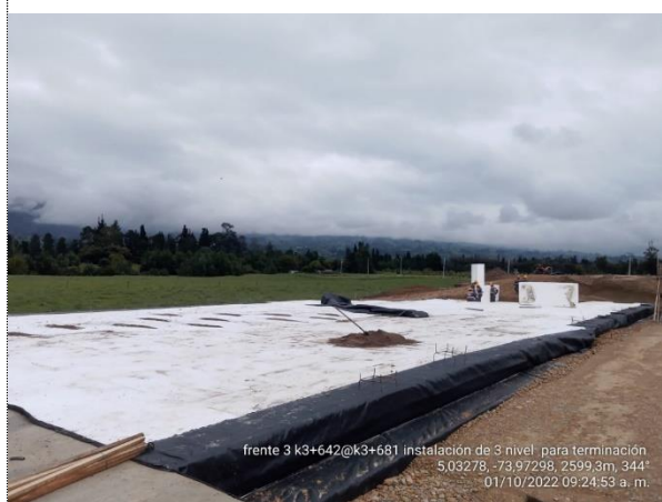
K3+642 - K3+681 INSTALACIÓN 3ER CAPA DE GEOBLOQUES (ÚLTIMA)
