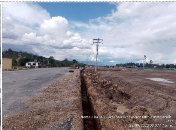
K4+450 - K4+600 EXCAVACIÓN E INSTALACIÓN DE FILTRO FRANCÉS COSTADO DERECHO
