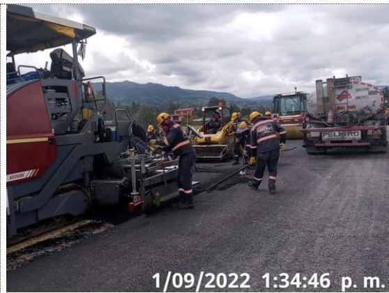
K3+310 – K3+360 instalación y compactación de BTA (01/09/22)
