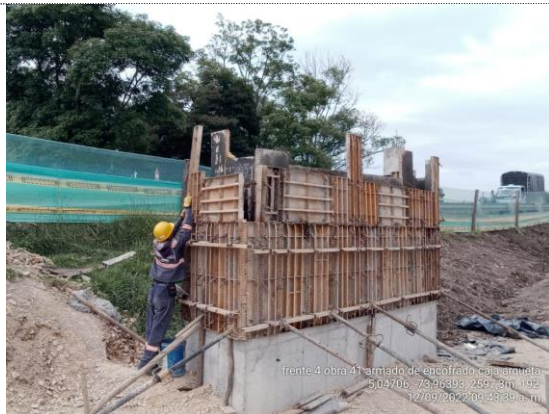
Obra No. 41 Box culvert 4x4 K5+577 armado de acero y encofrado caja arqueta (12/09/22)
