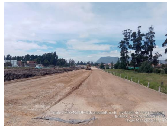
Conectante norte K0+340 – K0+440 nivelación corona de terraplén (15/09/22)
