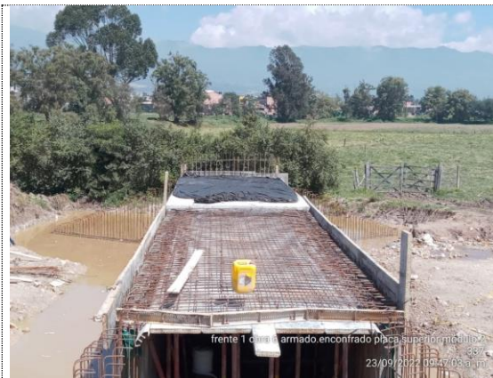
Obra No. 6 Pasaganado 3X3 K1+069 armado de acero y encofrado placa superior módulo 2 (23/09/22)
