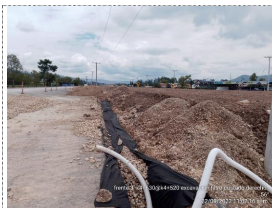
K4+520 – K4+630 instalación de filtro francés costado derecho (22/09/22)
