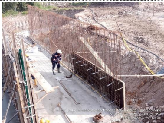
Obra No. 6 Pasaganado 3X3 K1+069 armado de acero y encofrado vástago norte módulo 2 (08/09/22)
