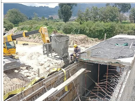
Obra No. 6 Pasaganado 3X3 K1+069 fundida vástago sur módulo 3 (29/09/22)
