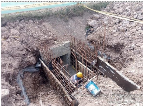
OBRA NO 25 ARMADO DE ACERO Y ENCOFRADO CAJA ARQUETA
