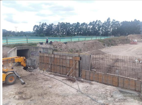
Obra No. 6 Pasaganado 3X3 K1+069 fundida de vástago norte módulo 2 (08/09/22)
