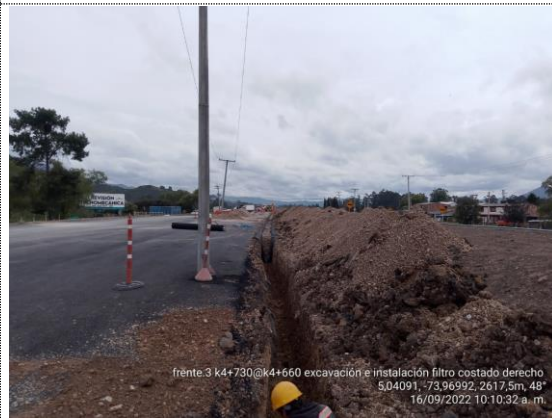
K4+660 – K4+730 excavación e instalación de filtro francés costado derecho (16/09/22)
