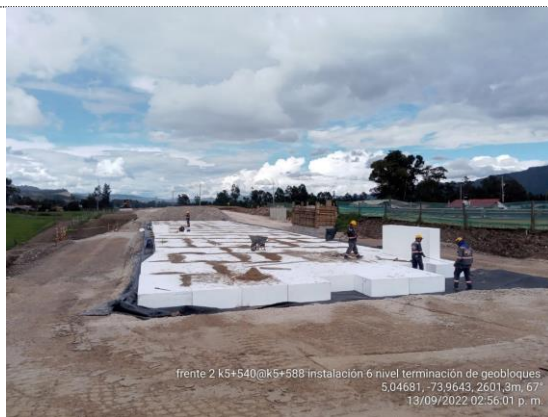
K5+550 – K5+588 instalación 6ta capa de geobloques (última) (13/09/22)
