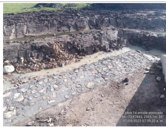
Obra No. 14 Box culvert 2X2 K2+014 fundida de enrocado en encole (07/09/22)
