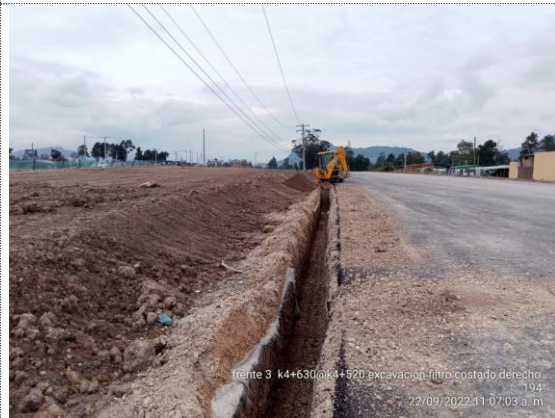
K4+520 – K4+630 excavación para filtro francés costado derecho (22/09/22)
