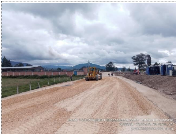
CONECTANTE NORTE K0+140 - K0+200 INSTALACIÓN DE SUBBASE GRANULAR
