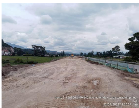
K5+500 – K5+640 nivelación 4ta capa de terraplén (22/09/22)
