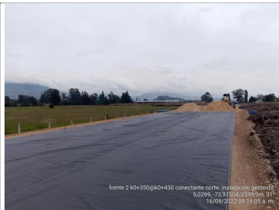
Conectante norte K0+340 – K0+440 instalación geotextil y subbase granular (16/09/22)
