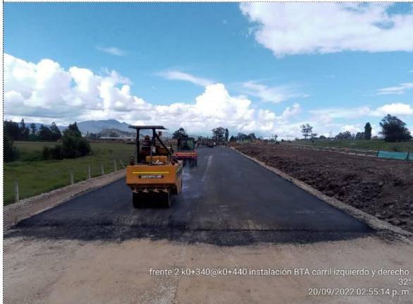
CONECTANTE NORTE K0+340 - K0+440 INSTALACIÓN DE BTA
