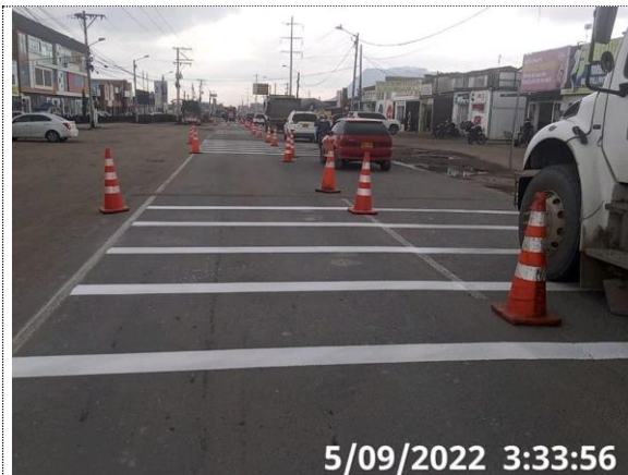
PR28+0200 – PR28+0400 demarcación de bandas alertadoras (05/09/22)
