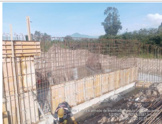
Obra No. 6 Pasaganado 3X3 K1+069 armado de acero y encofrado vástago norte módulo 1 (09/09/22)
