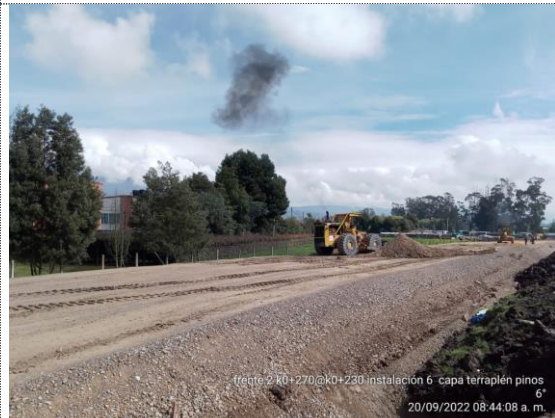
Conectante sur K0+230 – K0+270 instalación 6ta. capa de terraplén (20/09/22)
