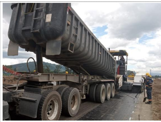
K3+730 – K3+968 instalación y compactación MSC-25 e=11cm (22/09/22)
