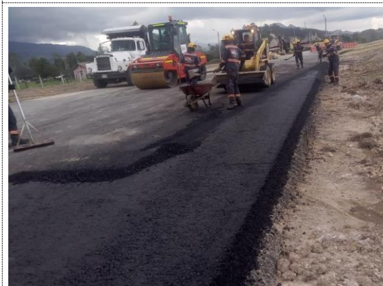
Retorno K4+200 instalación de MSC-25 en aguja, espesor e=11cm (29/09/22)
