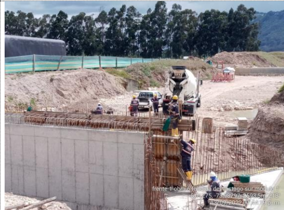
Obra No. 6 Pasaganado 3X3 K1+069 fundida de vástago sur módulo 1 (13/09/22)
