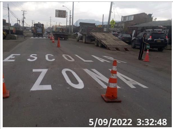
PR28+0200 – PR28+0400 demarcación de zona escolar (05/09/22)
