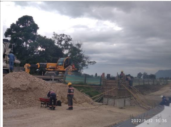
Obra No. 41 Box culvert 4x4 K5+577 fundida de caja arqueta (12/09/22)
