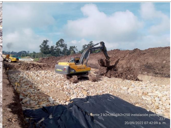
K2+240 - K2+260 INSTALACIÓN DE PEDRAPLÉN
