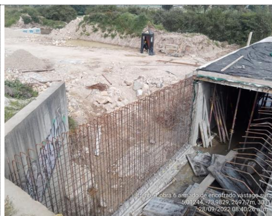
Obra No. 6 Pasaganado 3X3 K1+069 armado de acero vástago sur módulo 3 (28/09/22)
