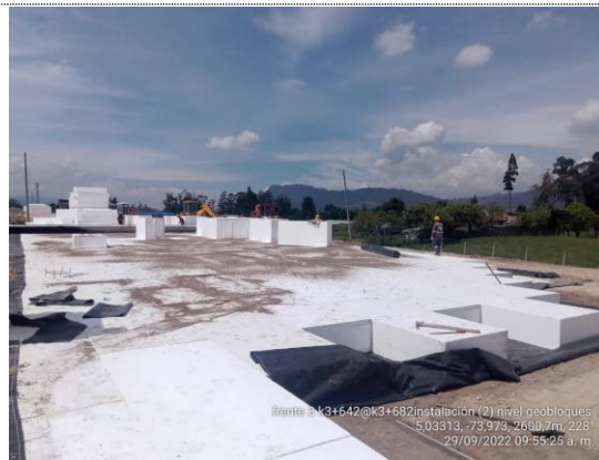
K3+342 – K3+682 continúa instalación de 2da capa de geobloques (29/09/22)
