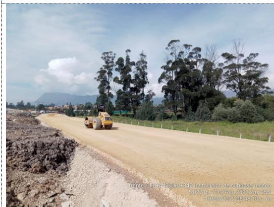
Conectante norte K0+340 – K0+440 instalación de subbase granular (19/09/22)
