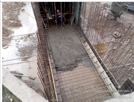
Obra No. 6 Pasaganado 3X3 K1+069 fundida placa inferior módulo 3 (23/09/22)
