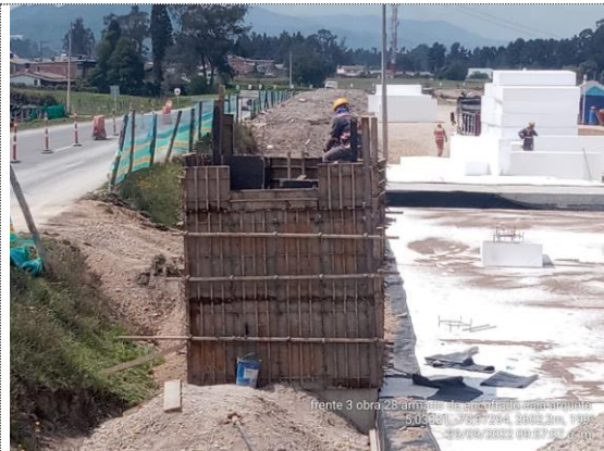
Obra No. 28 Box culvert 1x1 K3+675 armado de acero y encofrado caja arqueta (29/09/22)
