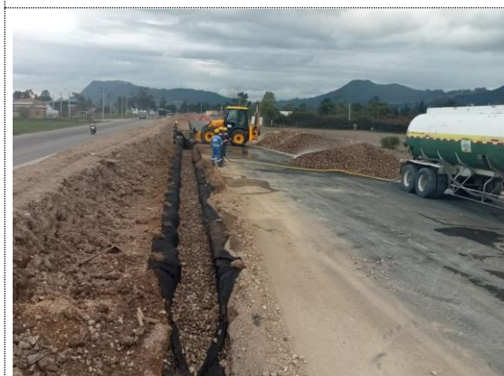
K4+980 – K5+050 instalación de filtro francés costado derecho (06/09/22)
