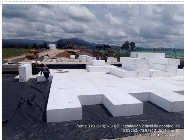
K3+618 - K3+630 INSTALACIÓN 2DA CAPA DE GEOBLOQUES
