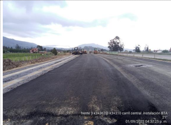
K3+310 – K3+360 instalación y compactación de BTA (01/09/22)
