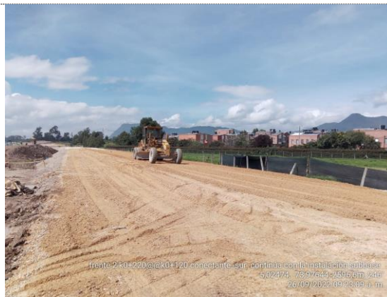
Conectante sur K0+120 – K0+220 continúa instalación de subbase granular (26/09/22)
