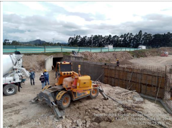
Obra No. 6 Pasaganado 3X3 K1+069 fundida de vástago norte módulo 1 (09/09/22)
