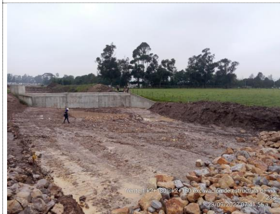
K2+150 – K2+180 excavación para estructura de vía (23/09/22)
