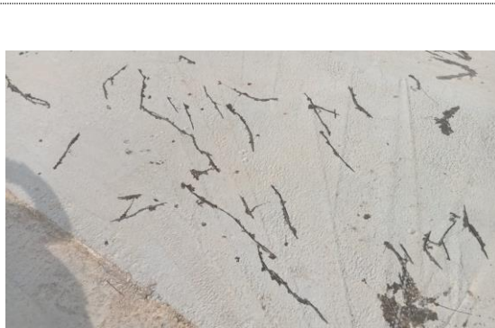
Obra No. 41 Box culvert 4x4 K5+577 sello de fisuras placa superior (05/09/22)
