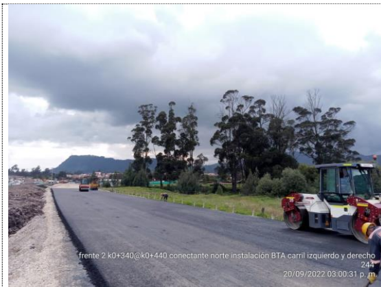
Conectante norte K0+340 – K0+440 instalación y compactación de BTA (20/09/22)
