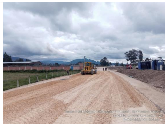
Conectante norte K0+140 – K0+200 instalación de subbase granular (07/09/22)
