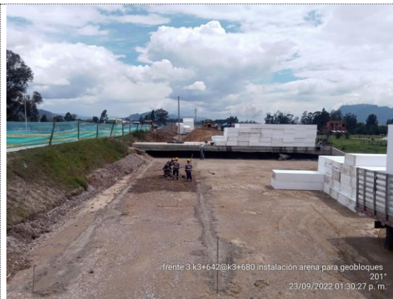
K3+642 – K3+680 instalación arena de nivelación para geobloques (23/09/22)
