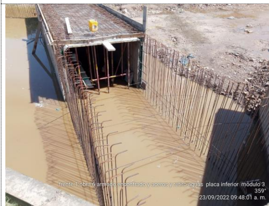
Obra No. 6 Pasaganado 3X3 K1+069 armado de acero y encofrado placa inferior módulo 3 (23/09/22)
