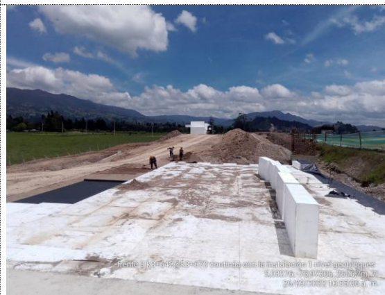
K3+645 – K3+670 continúa instalación 1er capa de geobloques (26/09/22)
