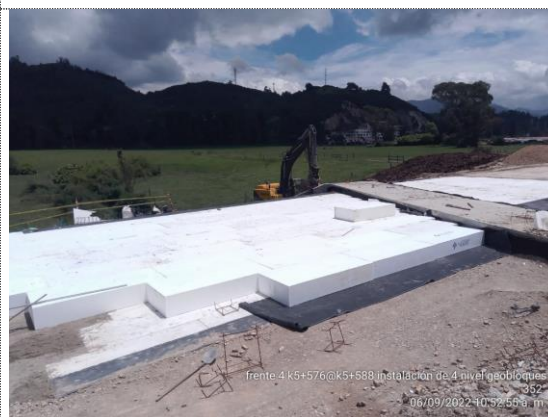
K5+580 – K5+595 inicia instalación de 4ta capa de geobloques (06/09/22)
