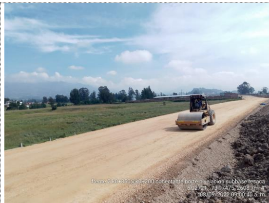
Conectante norte K0+140 – K0+340 nivelación de subbase granular (08/09/22)
