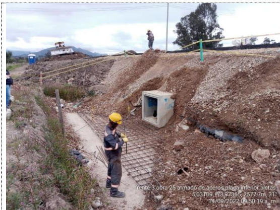
Obra No. 25 Box culvert 1x1 K3+476 armado de acero placa inferior de encofe (14/09/22)
