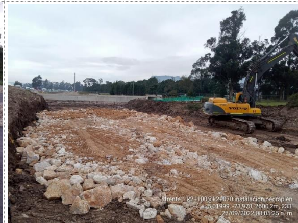
K2+070 - K2+100 INSTALACIÓN DE PEDRAPLÉN
