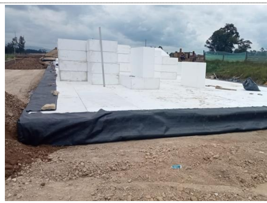
K5+550 – K5+575 termina instalación de 5ta capa de geobloques (09/09/22)
