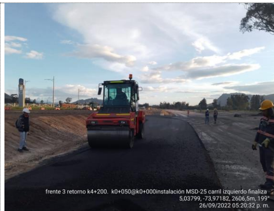
Retorno K4+200 K0+000 – K0+170 instalación de MSC-25 e=11cm (26/09/22)
