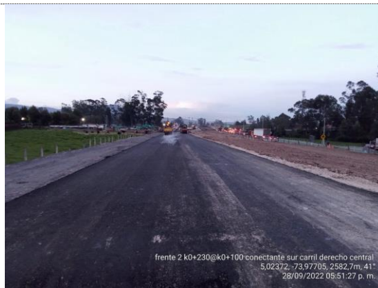
Conectante sur K0+120 – K0+220 instalación de BTA (28/09/22)
