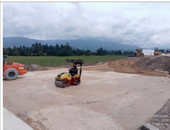
K3+642 – K3+670 nivelación de terraplén para instalación de geobloques (22/09/22)
