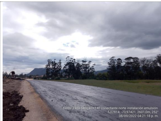
Conectante norte K0+140 – K0+340 instalación de emulsión asfáltica - imprimación (08/09/22)
