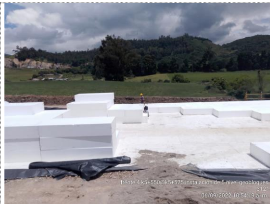
K5+550 – K5+575 instalación de 5ta capa de geobloques (06/09/22)
