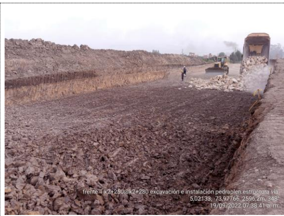
K2+250 – K2+280 excavación e instalación de pedraplén (19/09/22)
