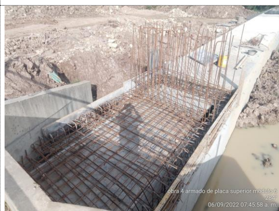
Obra No. 4 Box culvert 2X2 K0+956 armado de acero placa superior módulo 6 (06/09/22)
