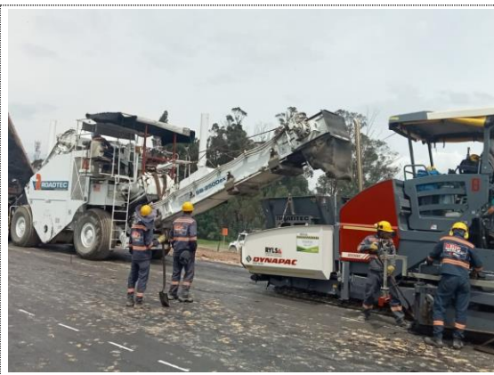
Conectante sur K0+120 – K0+220 instalación de BTA (28/09/22)
