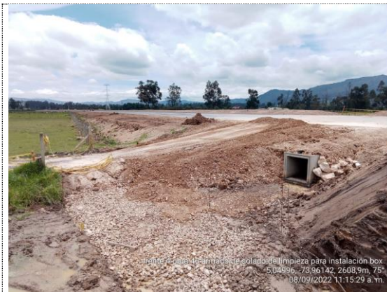
Obra No. 46 Box culvert 1X1 K6+020 adecuación de terreno para fundir solado en prolongación de box (08/09/22)
