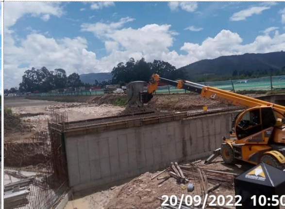
OBRA NO 6 FUNDIDA DE PLACA SUPERIOR MÓDULO 1
