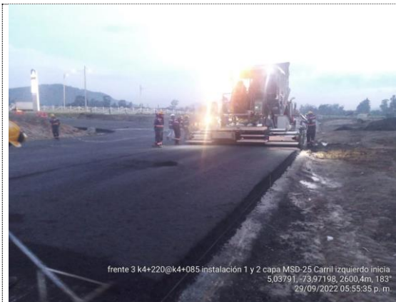
K4+080 – K4+230 instalación de MSC-25, espesor e=11cm (29/09/22)
