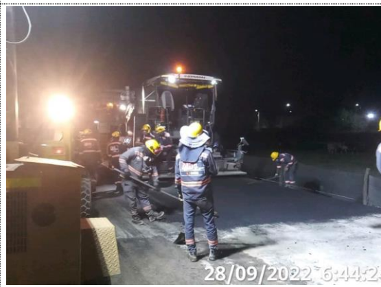
Conectante sur K0+120 – K0+220 instalación de BTA (28/09/22)
