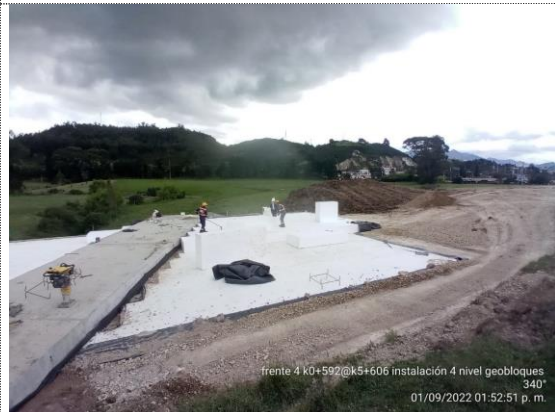
K5+600 – K5+620 inicia instalación de 4ª. capa de geobloques (01/09/22)
