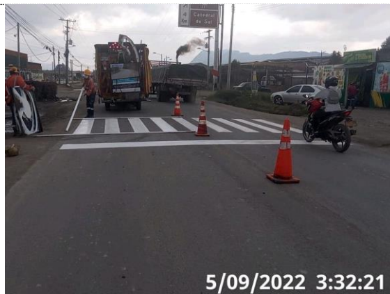
PR28+0200 – PR28+0400 demarcación de cruce peatonal (05/09/22)
