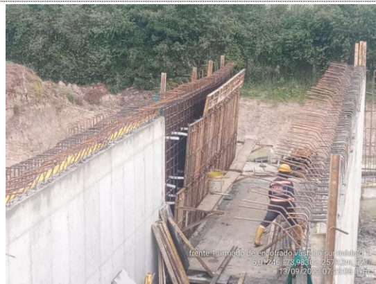
Obra No. 6 Pasaganado 3X3 K1+069 armado de acero y encofrado vástago sur módulo 1 (13/09/22)
