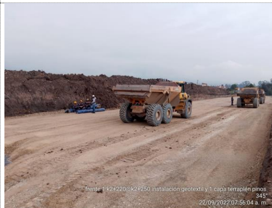
K2+220 – K2+250 instalación de geotextil y 1er capa de terraplén (22/09/22)
