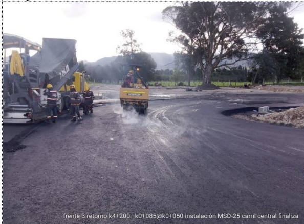
RETORNO K4+200 K0+050 - K0+170 INSTALACIÓN MSC-25 E=11CM
