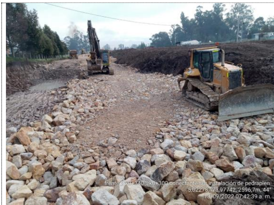
Conectante sur K0+300 – K0+340 instalación de pedraplén (13/09/22)
