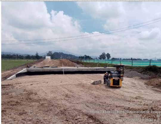
K3+610 – K3+630 nivelación 3er capa de terraplén (21/09/22)
