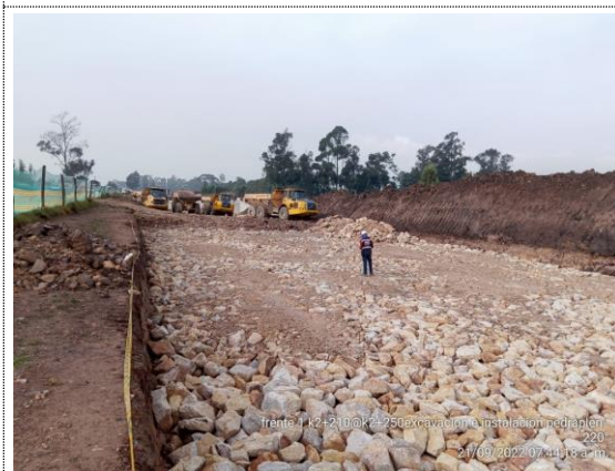
K2+210 – K2+250 excavación e instalación de pedraplén (21/09/22)
