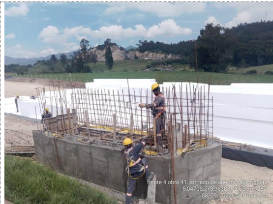
Obra No. 41 Box culvert 4x4 K5+577 armado de acero caja arqueta (08/09/22)
