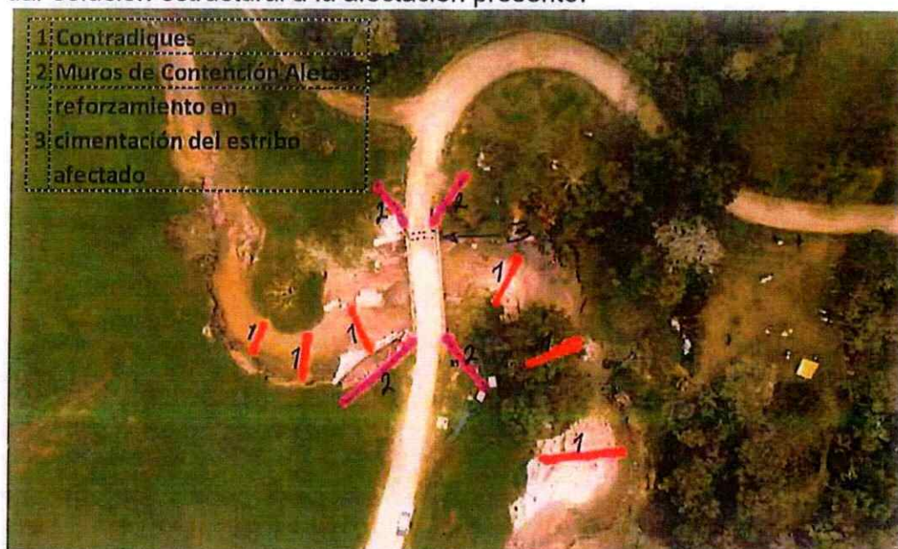
Ilustración 2. Obras visualizadas desde lo conceptual que deben construirse en Puente Espíritu Santo
