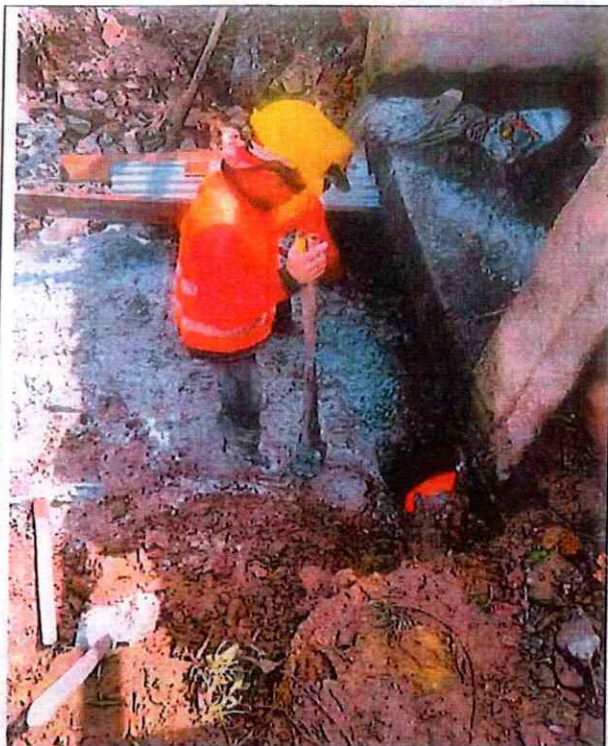
Reparación en la parte baja del boxculvert
