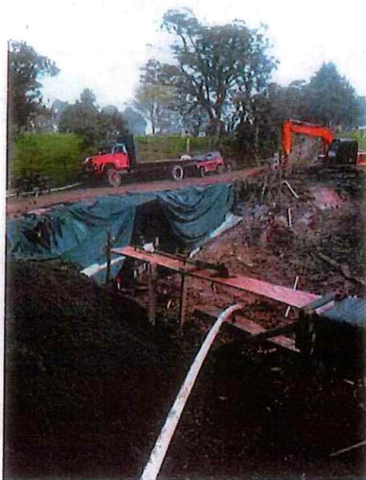
Trabajos de protección de taludes, control y manejo de aguas, construcción de cunetas, encoles del box coulvert. Sector La Lana.
