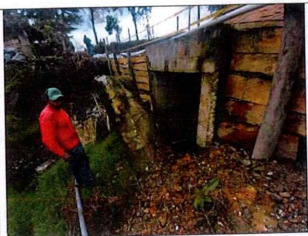
Punto critico boxculvert
