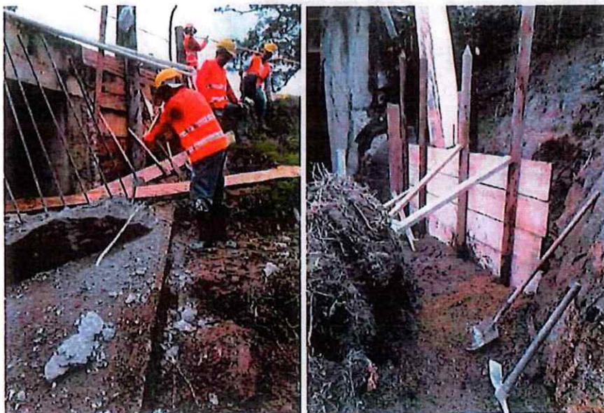
Construcción de trinchos y construcción de muros, Sector Agrícola
