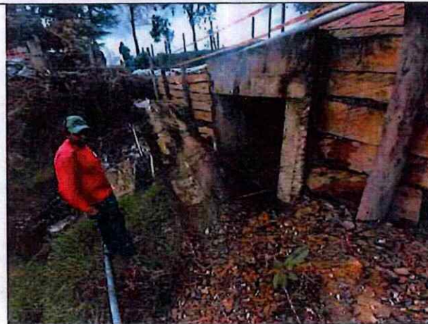
Punto critico boxculvert
