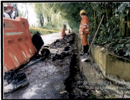
Limpieza para llenos de canal en km 1+822 del tramo 1
