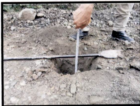
Apiques para evaluar espesores y tipo de materiales, tramo 2
