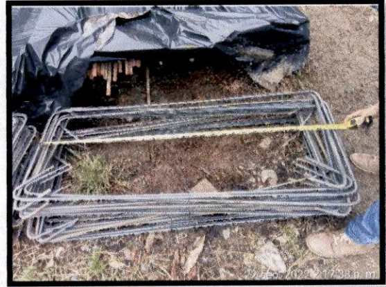
Actividades de corte y figuración de acero para vigas del puente sobre la quebrada La Guamo, K5+405 tramo 2
