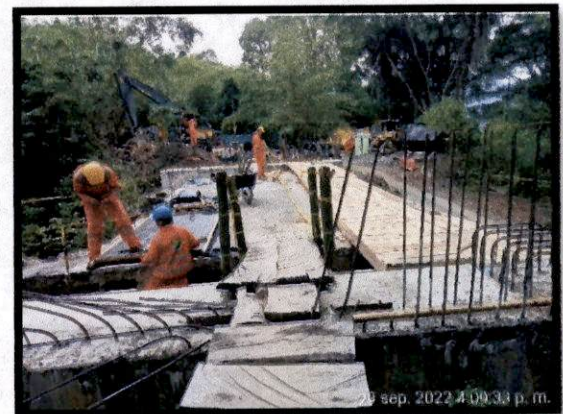
Armado de obra falsa para vigas del puente sobre la quebrada La Guamo, K5+405, tramo 2
