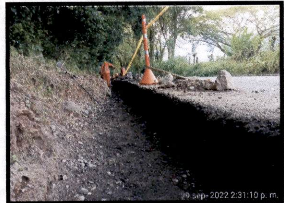
lleno con subbase en canal tramo 1 km 1+822
