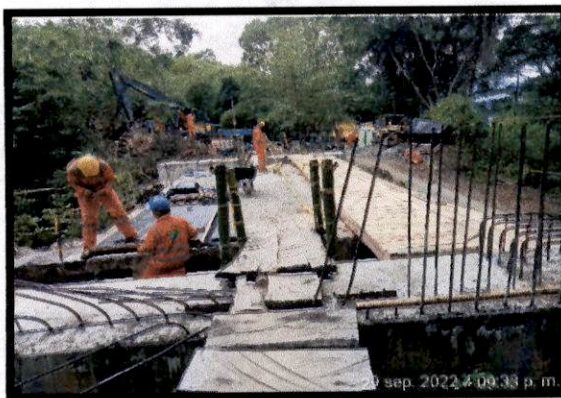
Obra falsa para vigas puente K5+405, tramo 2
