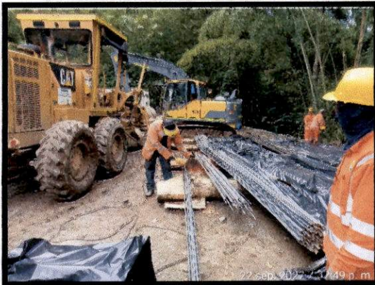
Actividades de corte y figuración de acero para vigas del puente sobre la quebrada La Guamo, K5+405 tramo 2
