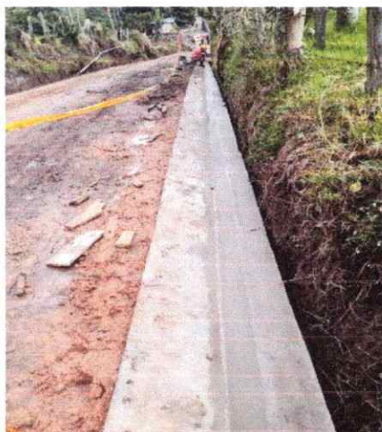
Foto 7: Vaciado y desencofrado de cunetas.
