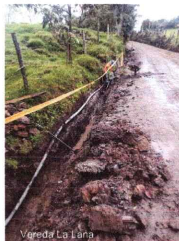
Foto 8: Excavación para la construcción del filtro.
