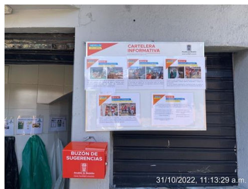
Imagen 1. Instalación de carteleras en el frente de obra, El Popular.
