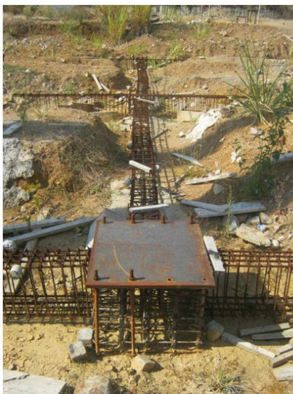
Fotografía 5. Arranques de columnas metálicas
