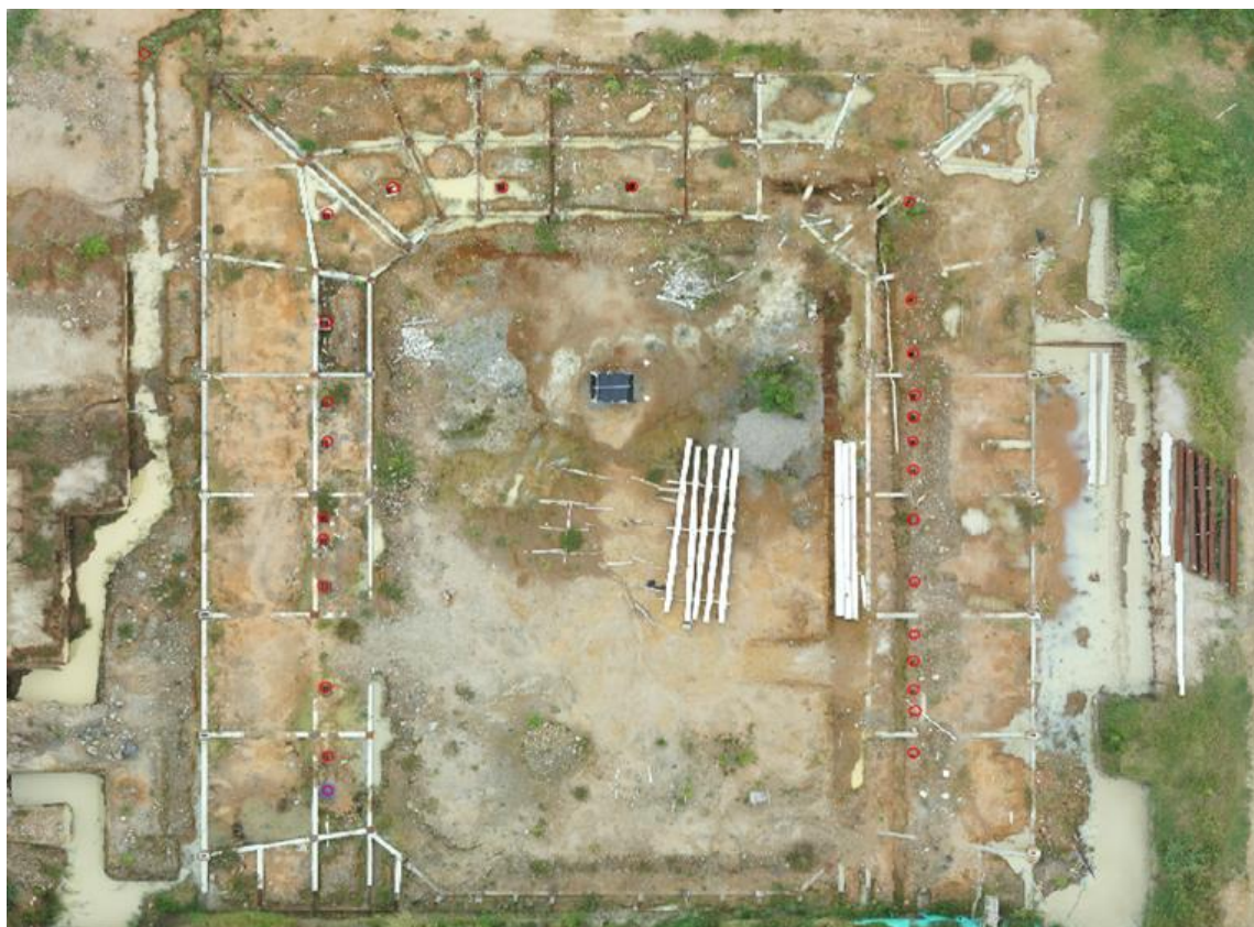
Figura 36. Vista en planta del coliseo mayor. En rojo, cajas de inspección de aguas residuales.
