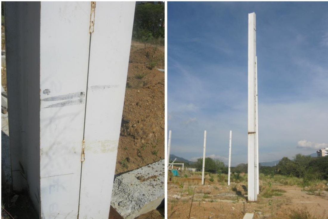
Fotografía 3. Configuración de columnas metálicas 2IPE600, cordón de soldadura discontinuo
