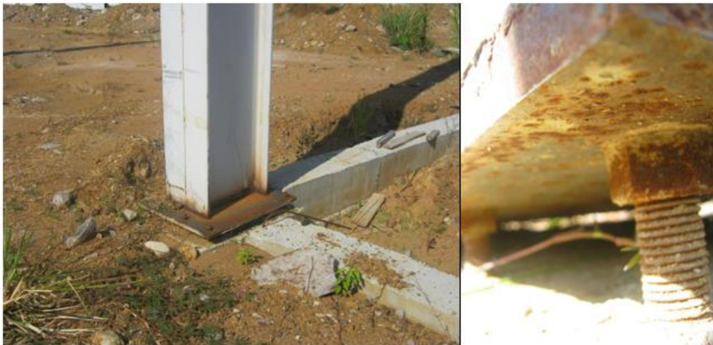
Fotografía 6. Columna-Placa Base
