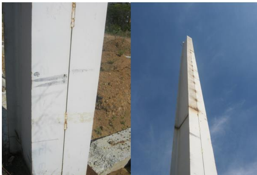
Fotografía 7. Conexión entre dos IPE600
