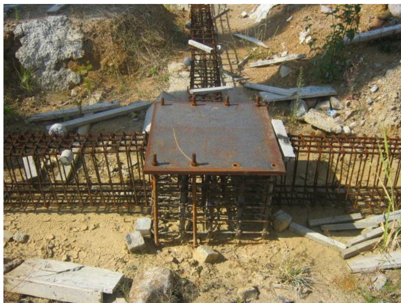
Fotografía 8. Placa Base sin Columna.
