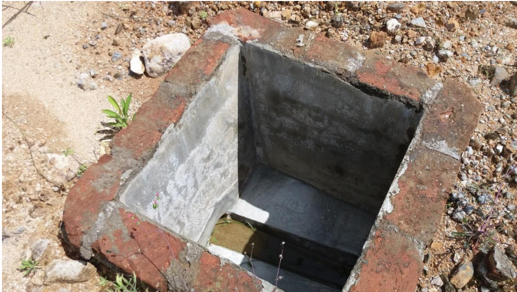
Fotografía 10. Caja de inspección construida al interior del coliseo mayor.
