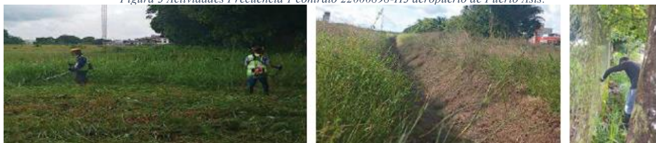
Figura 3 Actividades Frecuencia 1 contrato 22000898-H3 aeropuerto de Puerto Asís.
