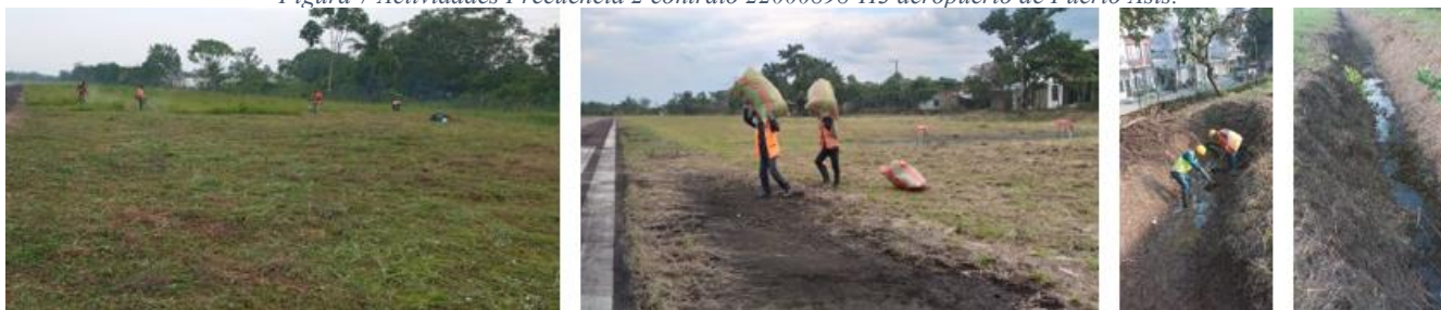
Figura 7 Actividades Frecuencia 2 contrato 22000898-H3 aeropuerto de Puerto Asís.
