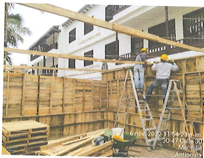
Ilustración 8: Construcción de campamento de obra
