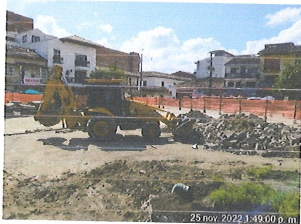
Ilustración 19: Demolición, acopio y cargue de materiales y escombros
