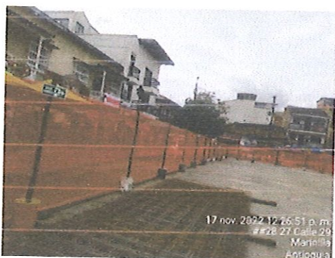
Fotografía 31. Señalización rutas de evacuación izquierda
