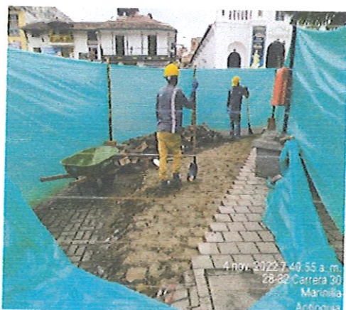
Fotografía 19. Remoción de adoquín
