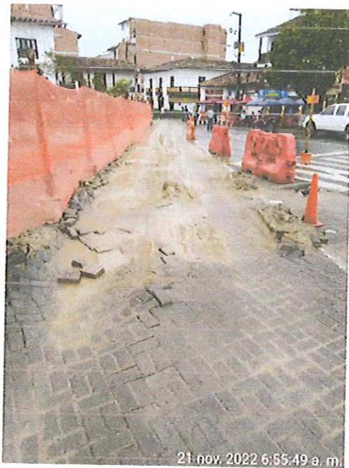
Ilustración 13: afectaciones del adoquín del paso vehicular
