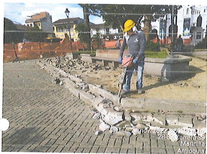
Ilustración 17: Demolición de Cordones y jardineras
