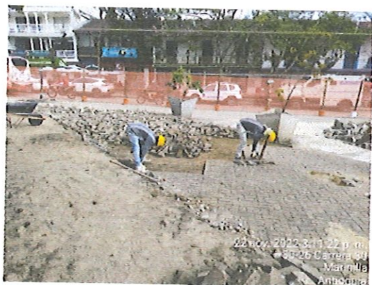
Ilustración 15: Remoción de adoquín
