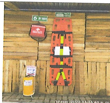
Fotografía 30. Equipos de emergencia y señalización
