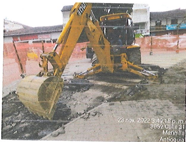
Ilustración 20: Demolición de carpeta asfáltica con compresor
