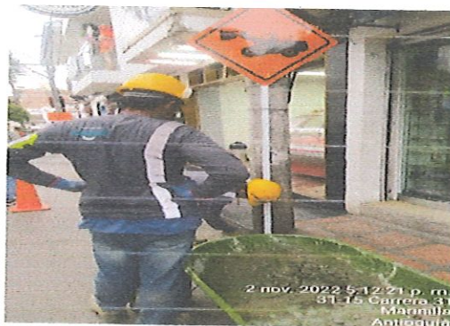
Fotografía 16. Señalización vertical de vía
