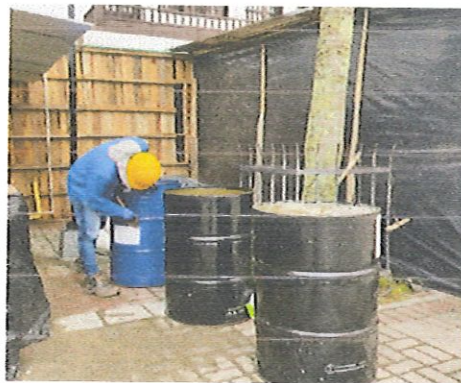
Fotografía 2. Construcción punto ecológico central
