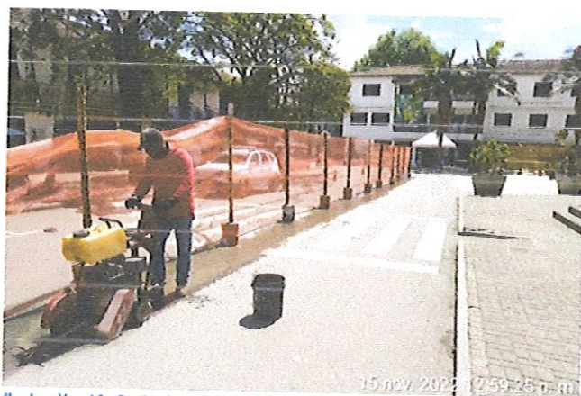
Ilustración 10: Corte de asfalto a 3"
