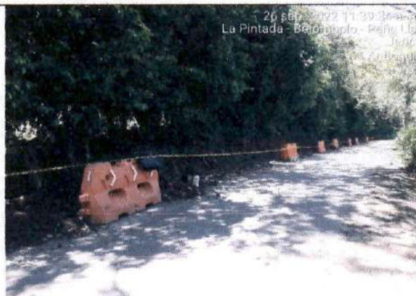
Ilustración 3. Disposición material proveniente de excavación km 1+900 al km 2+030 vía puente iglesias la Ye.
