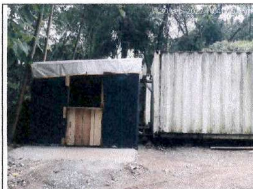
Ilustración 8. Construcción de acopio almacén de obra
